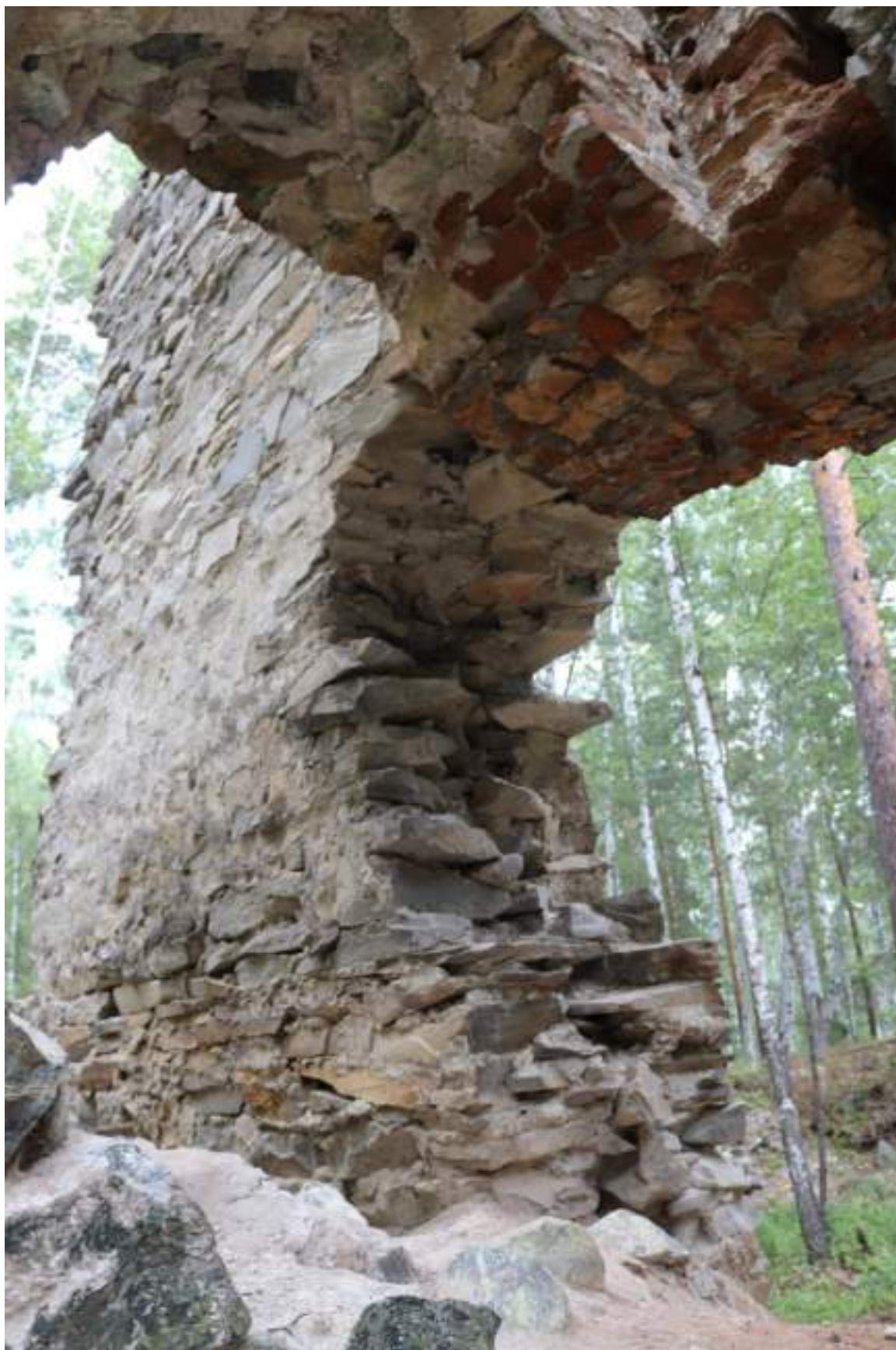
Графическое приложение №15 . ОКН «Французская горка. Французский замок – развалины (руины) бельгийской фактории XIX века». Руинизированное здание фабрики. Вид с юга.
