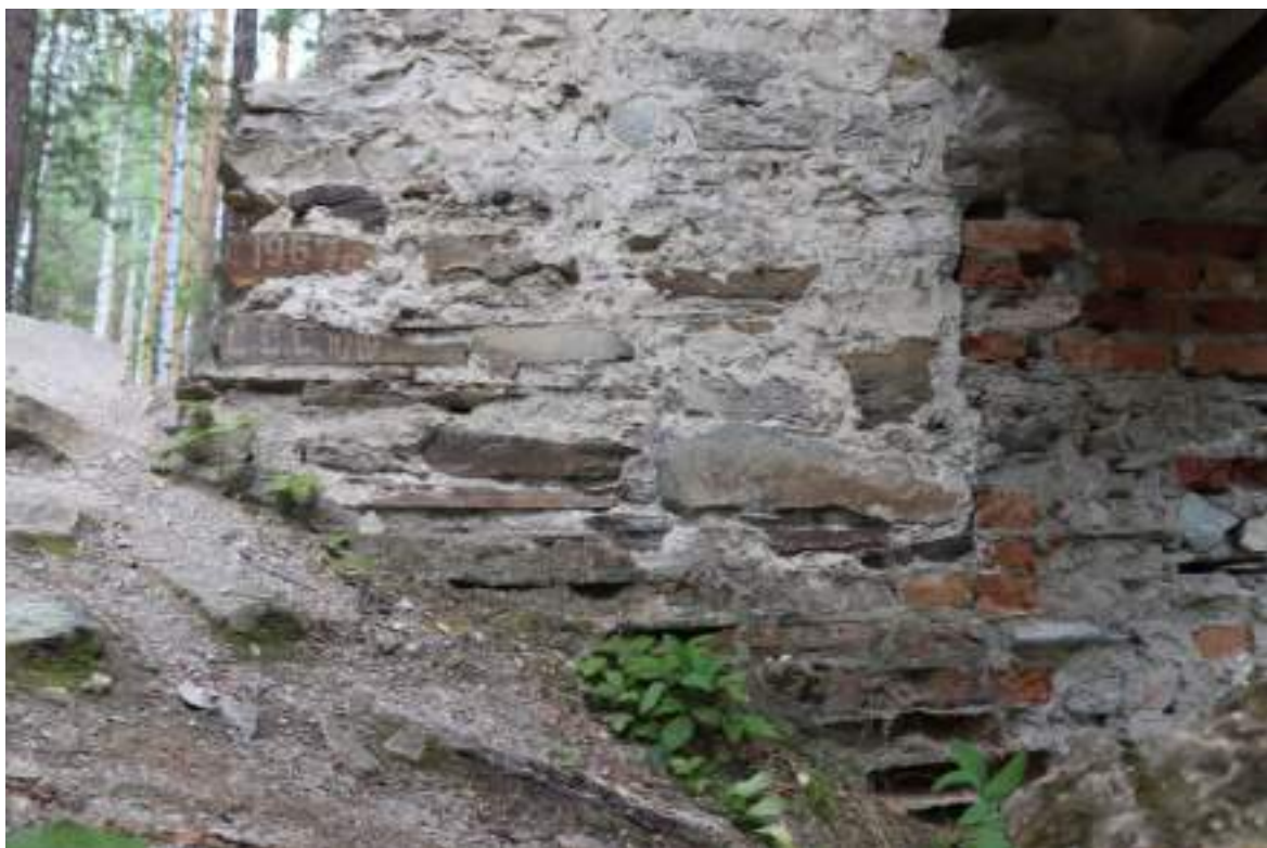
Графическое приложение №9 . ОКН«Французская горка. Французский замок – развалины (руины) бельгийской фактории XIX века». Руины здания фабрики. 1. Вид с востока. 2. Вид с запада.
