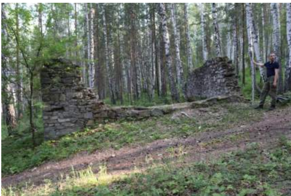
Графическое приложение №37 . ОКН «Французская горка. Французский замок – развалины (руины) бельгийской фактории XIX века». 1. Разрез №3. Вид с северо-востока 2. Объект №1. Вид с юга.
