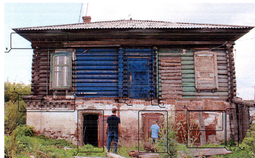
1. Арочный оконный проём с лучковой перемычкой цокольного этажа 2. Арочные дверные проёмы с лучковыми перемычками 3. Лучковые арочные оконные проёмы верхнего этажа 4. Приём расстелки оконных заполнений верхнего этажа 5. Кирпичное обрамление в виде архивольты на 1/3 высоты оконного проёма
