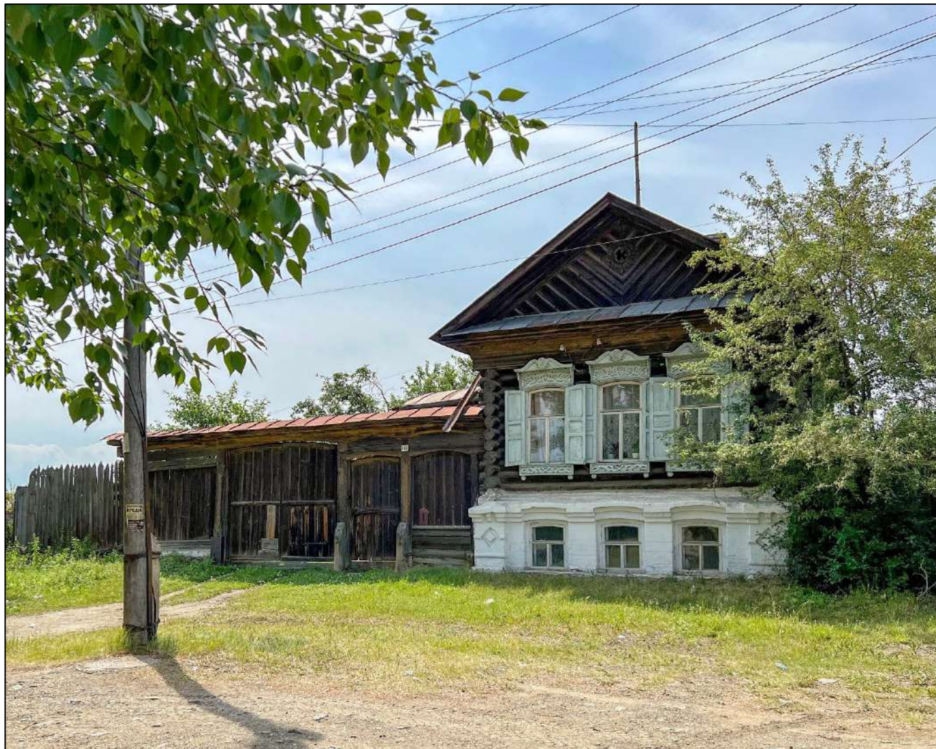
1. Общий вид на Объект.
