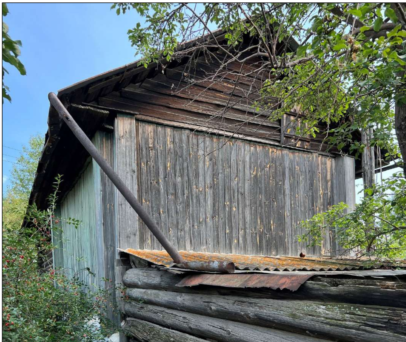
7. Общий вид на фасады Объекта.
