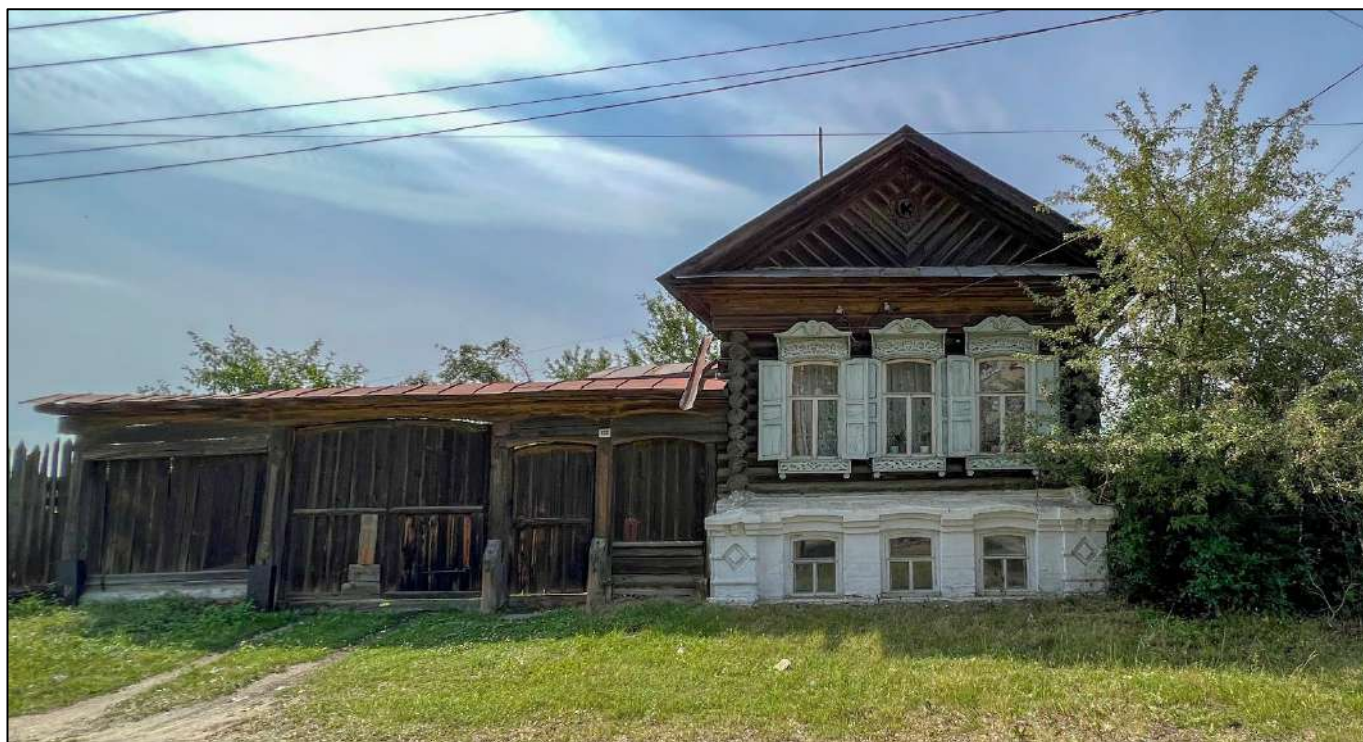
2. Общий вид на Объект.
