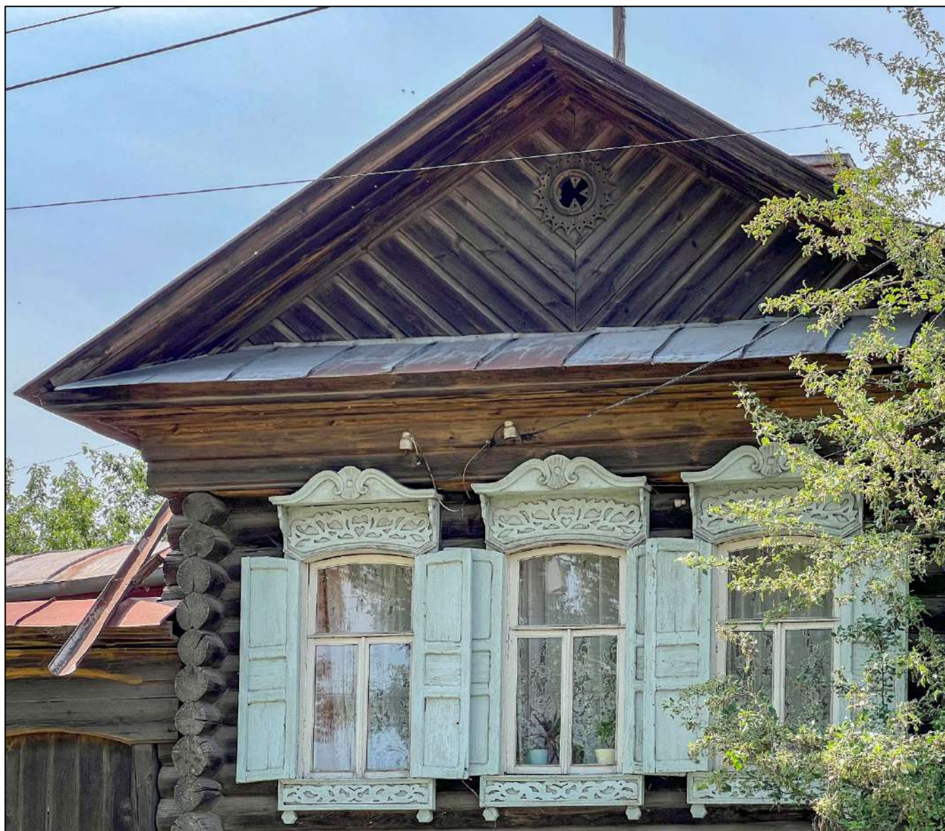
4. Фрагмент фасада Объекта.
