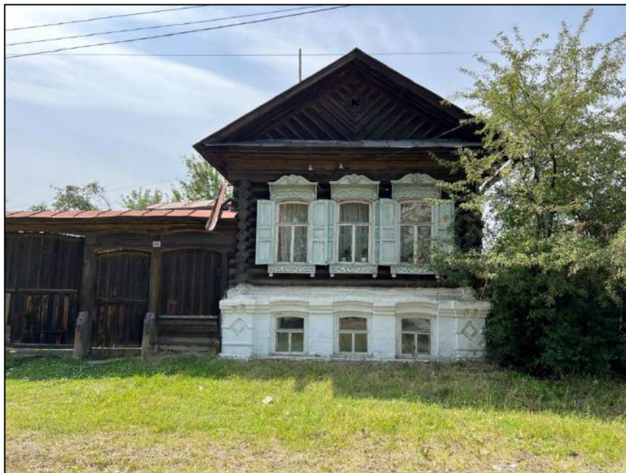
Выявленный объект культурного наследия «Дом жилой, одноэтажный, деревянный, на высоком каменном цоколе (с "низом")»
