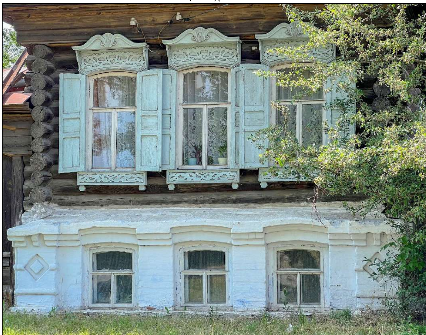
3. Фрагмент фасада Объекта.
