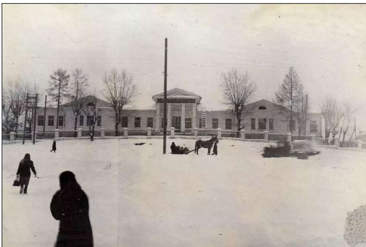
11. Здание хирургического отделения больницы. 1954 г.
