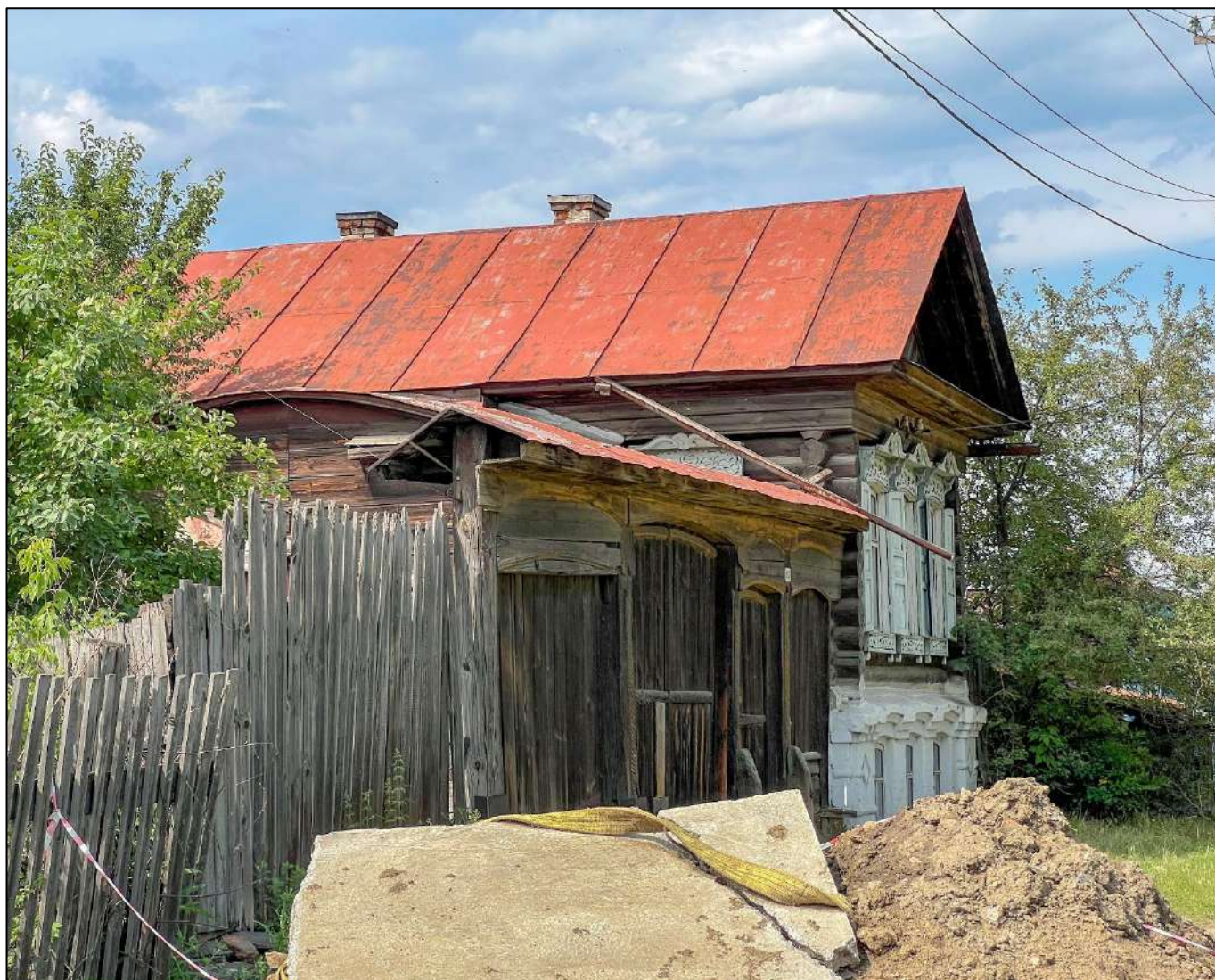
6. Общий вид на фасады Объекта.
