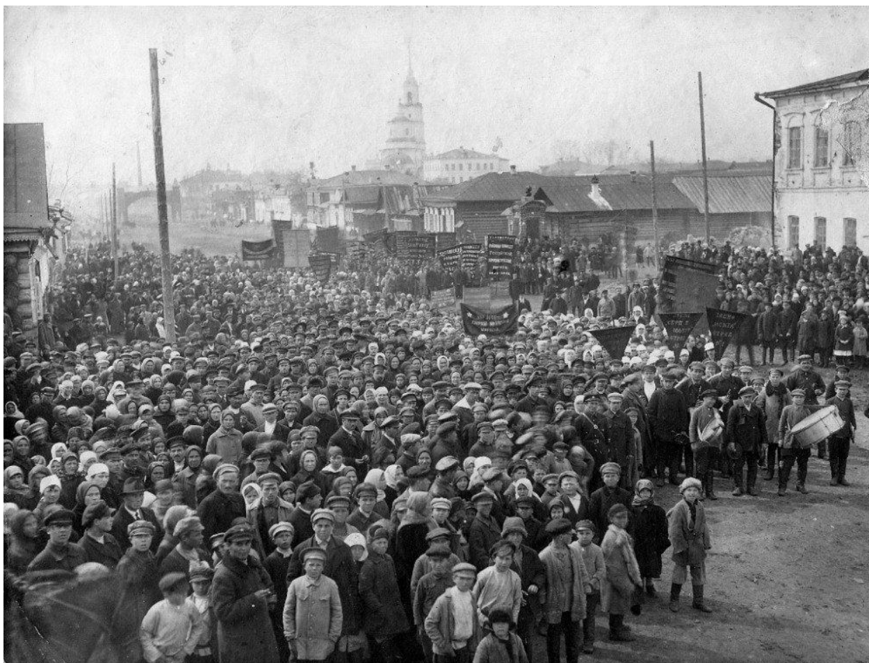
Рис. 16. Улица Большая (Базарная), совр. Советская на участке от ул. Волостной (совр. Революции) до предзаводской площади. Справа – двухэтажное каменное здание волостного правления. По правой (северной) стороне улицы расположены особняк и лавка купца С. Лежнева. Фото 1927 г. Источник: фонды Каслинского историко-краеведческого музея
