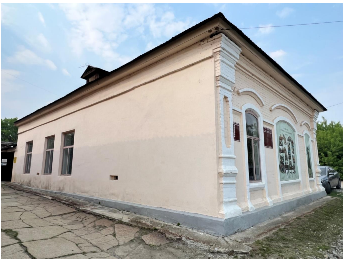
Рис. 3 а, б. Боковой, северный (вверху) и боковой, южный (внизу) фасады
