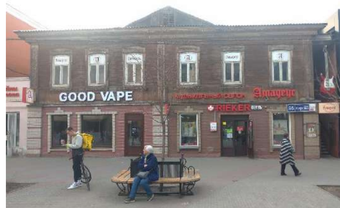
Восточный фасад здания
