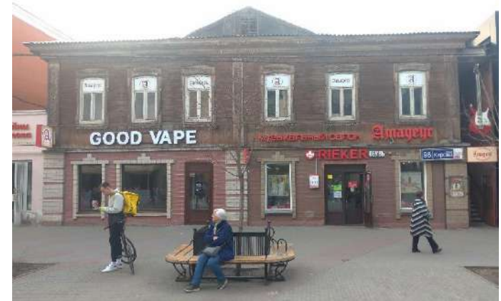
Восточный фасад здания
