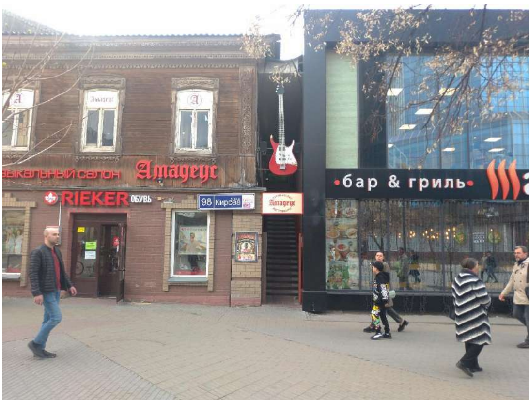
Фото 2. Фрагмент восточного фасада по состоянию на июнь 2022 года.
