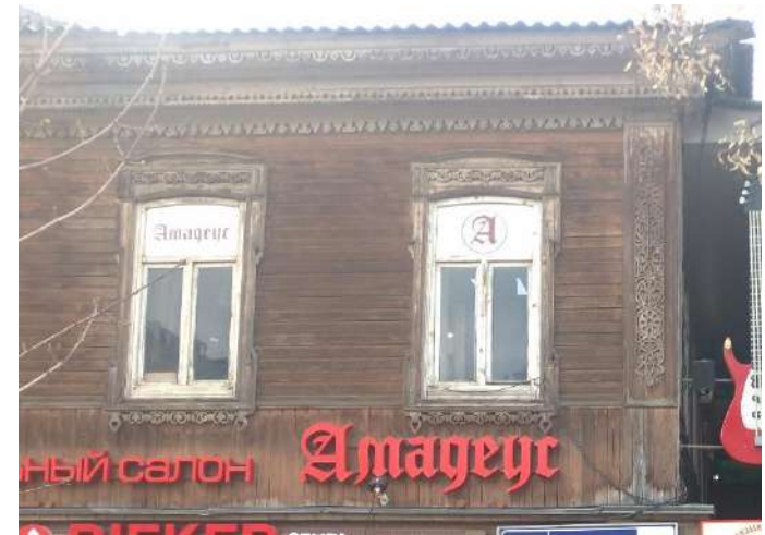
Фрагмент восточного фасада здания
