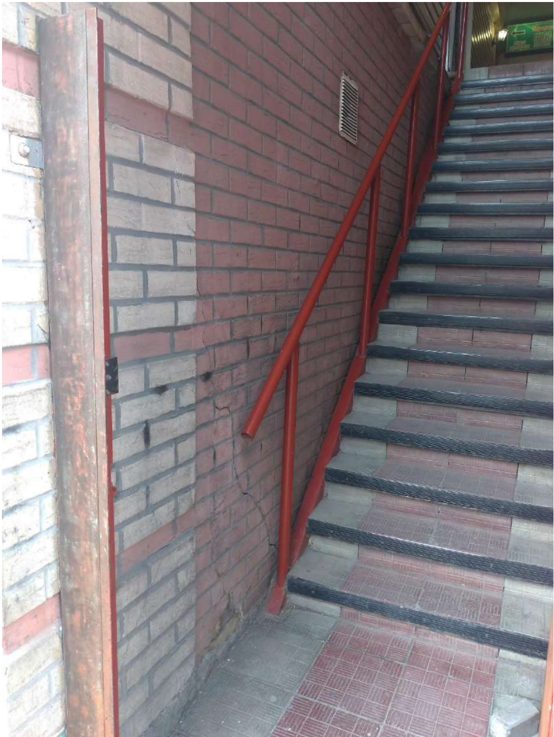
Фото 4. Фрагмент северного фасада по состоянию на июнь 2022 года.
