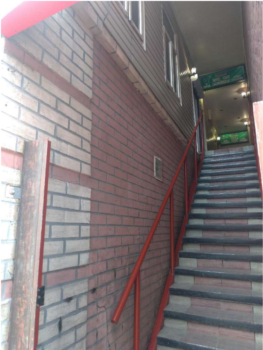
Фото 5. Фрагмент северного фасада по состоянию на июнь 2022 года.
