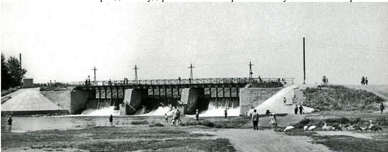
Плотина «Коммунар». 1974 г.
