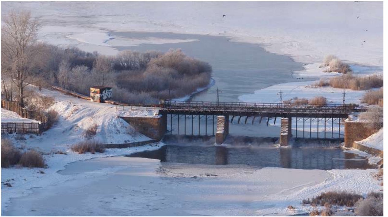
Общий вид плотины «Коммунар» с востока. Январь 2012 г.
