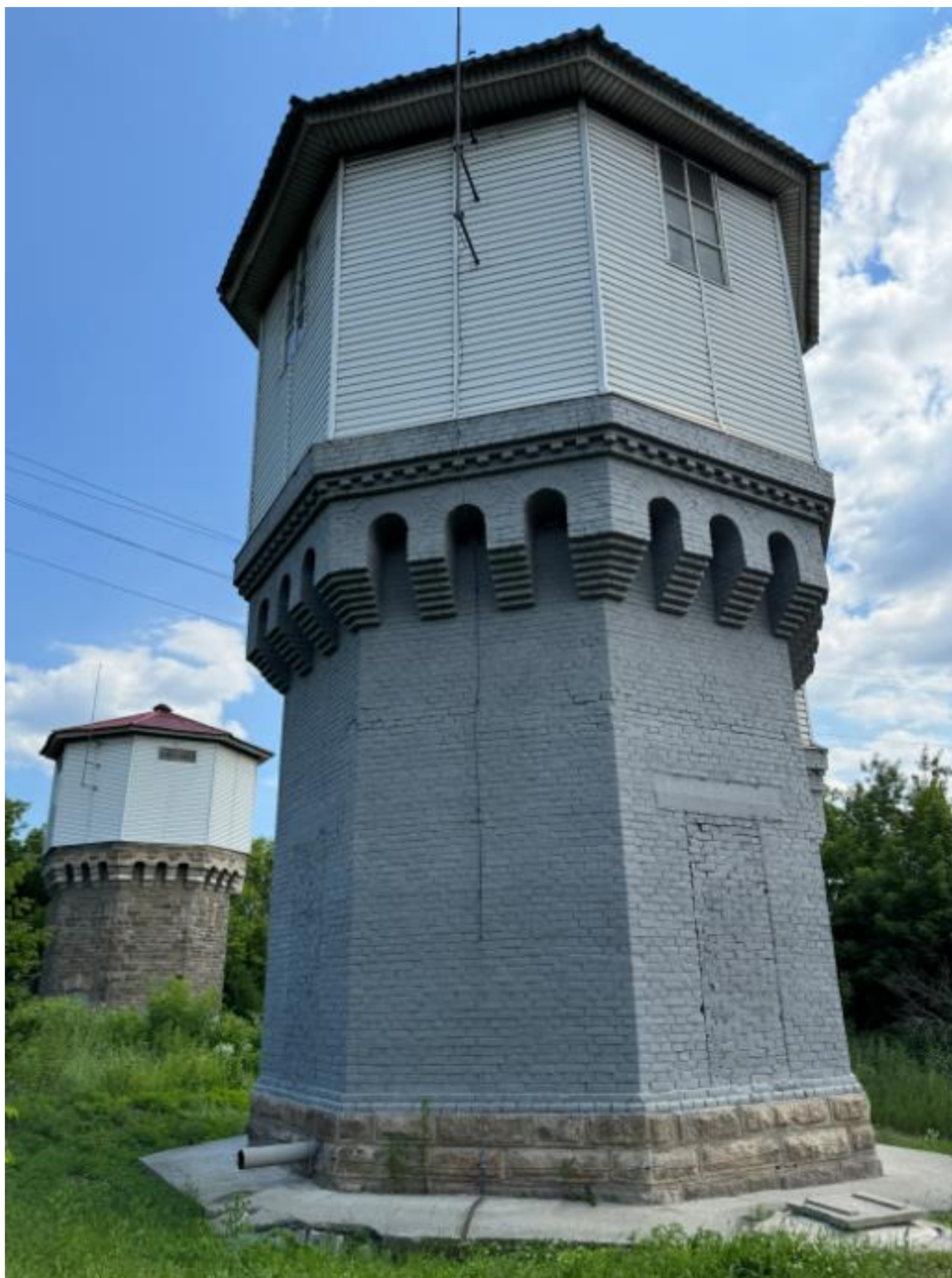
Фото 10. Вид на выявленный объект культурного наследия «Водонапорная башня-2», расположенный по адресу: Челябинская область, Миасский городской округ, г. Миасс, ж/д ст. Миасс-1.
