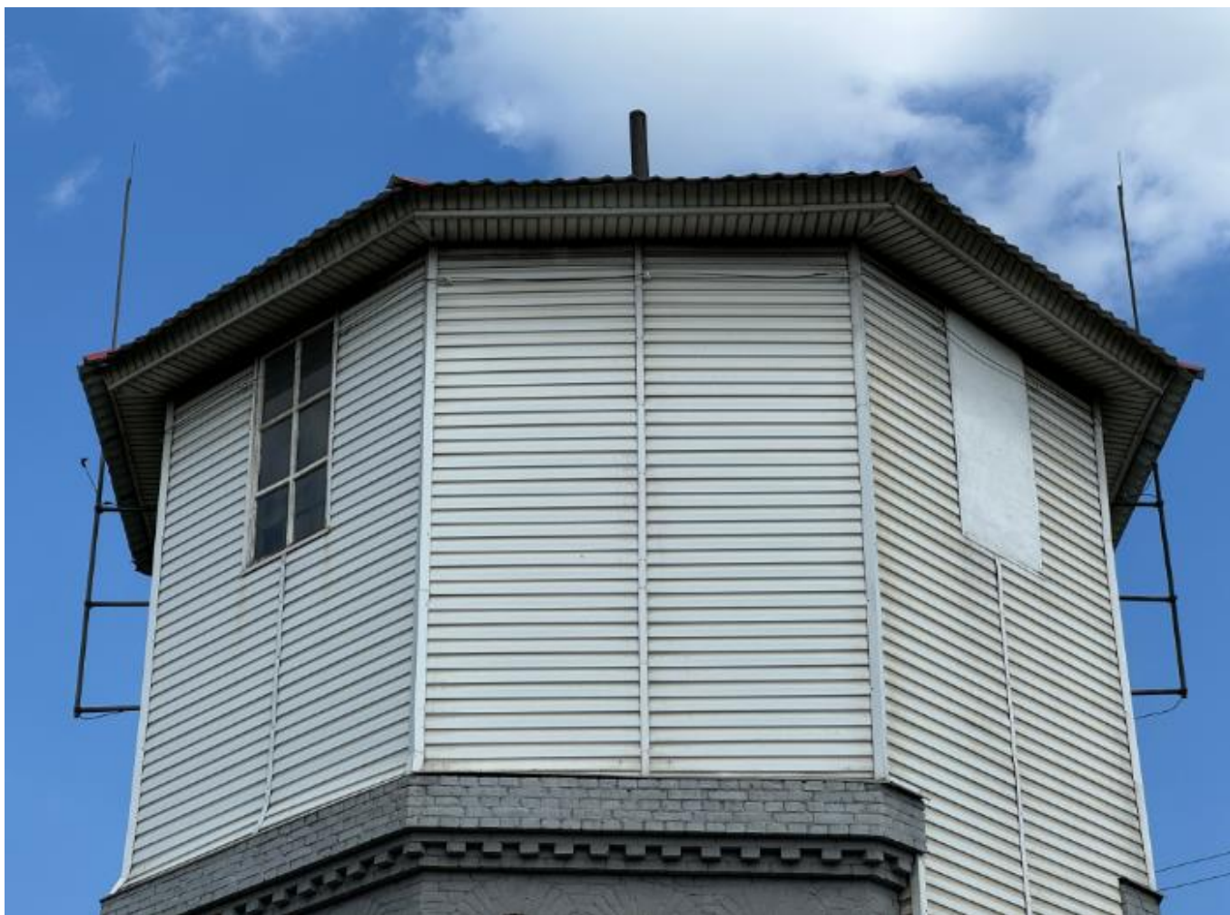
Фото 3. Вид на выявленный объект культурного наследия «Водонапорная башня-2», расположенный по адресу: Челябинская область, Миасский городской округ, г. Миасс, ж/д ст. Миасс-1.
