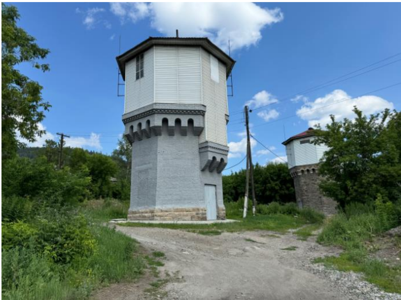
Фото 1. Вид на выявленный объект культурного наследия «Водонапорная башня-2», расположенный по адресу: Челябинская область, Миасский городской округ, г. Миасс, ж/д ст. Миасс-1.
