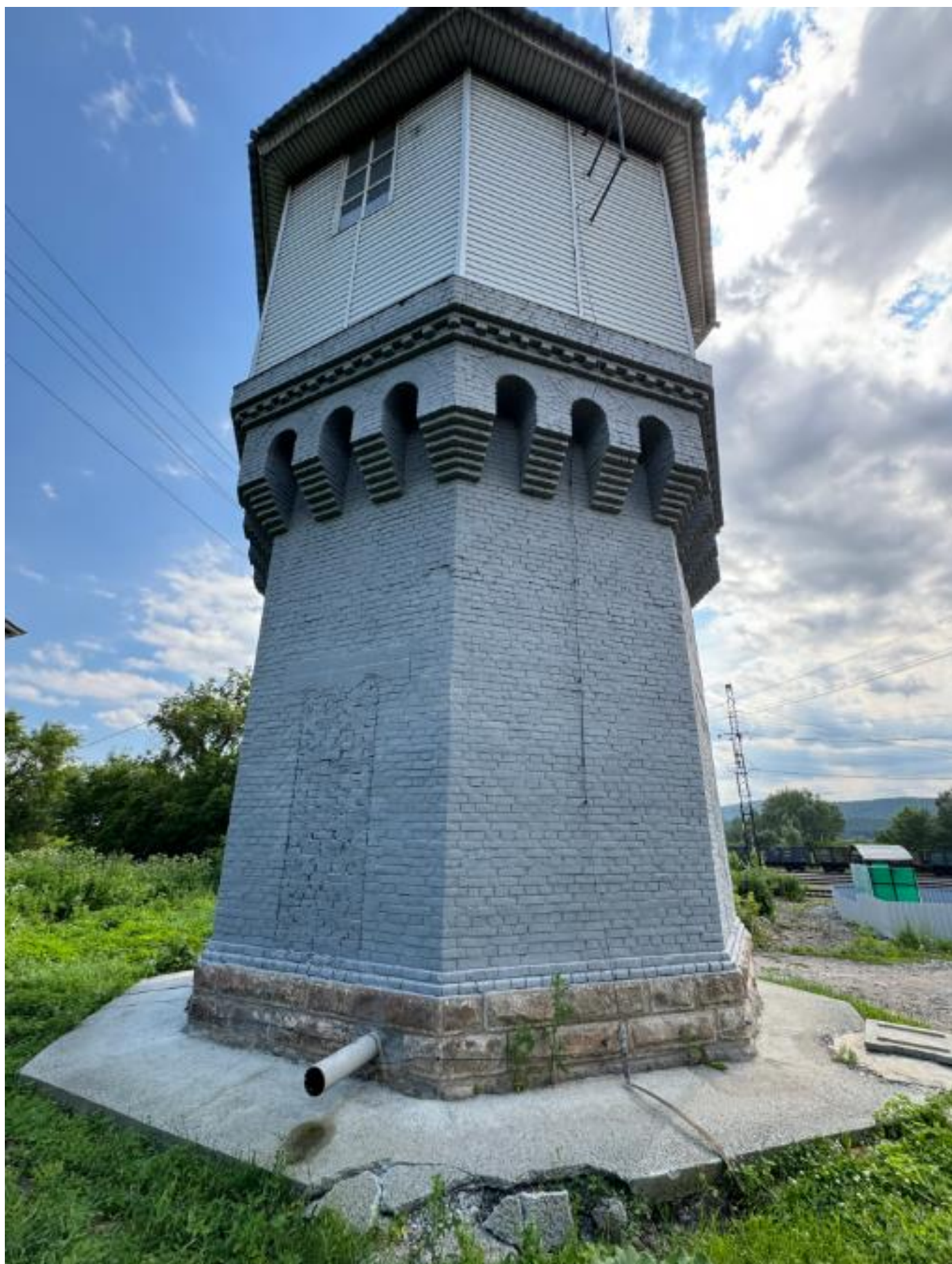
Фото 11. Вид на выявленный объект культурного наследия «Водонапорная башня-2», расположенный по адресу: Челябинская область, Миасский городской округ, г. Миасс, ж/д ст. Миасс-1.
