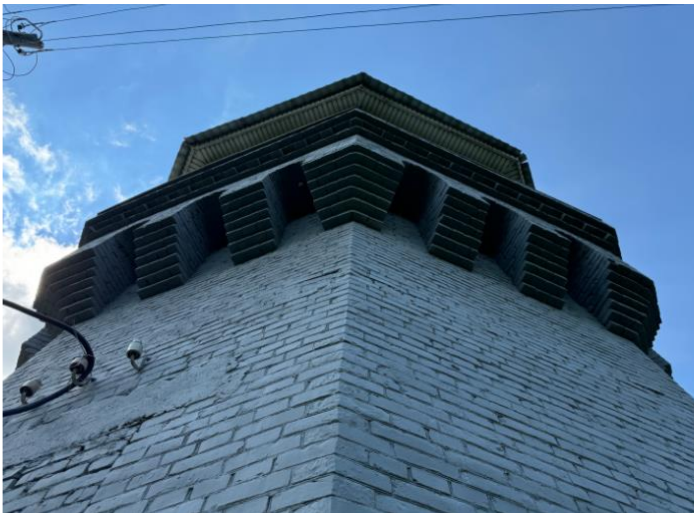
Фото 12. Вид на выявленный объект культурного наследия «Водонапорная башня-2», расположенный по адресу: Челябинская область, Миасский городской округ, г. Миасс, ж/д ст. Миасс-1.
