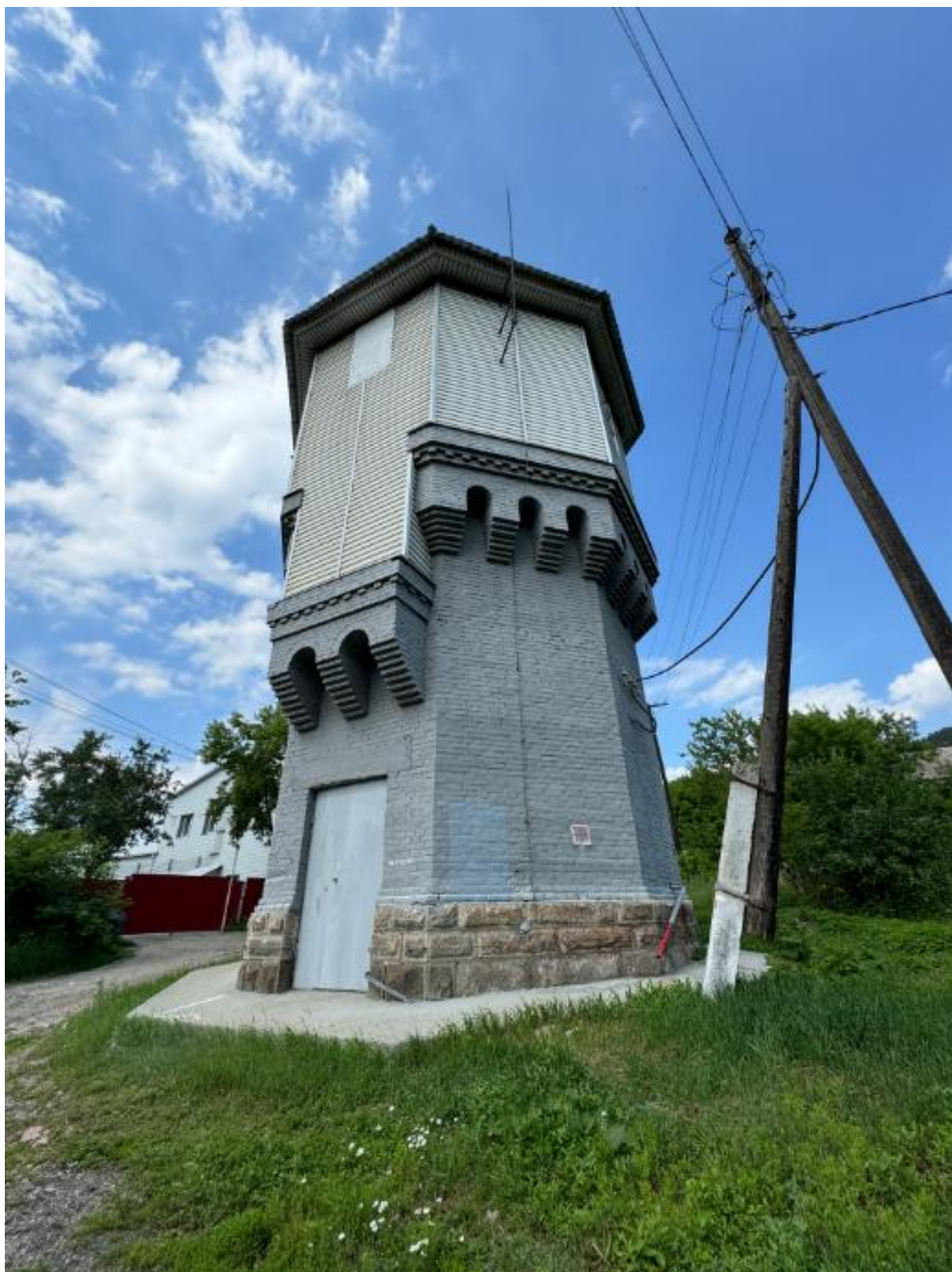
Фото 6. Вид на выявленный объект культурного наследия «Водонапорная башня-2», расположенный по адресу: Челябинская область, Миасский городской округ, г. Миасс, ж/д ст. Миасс-1.
