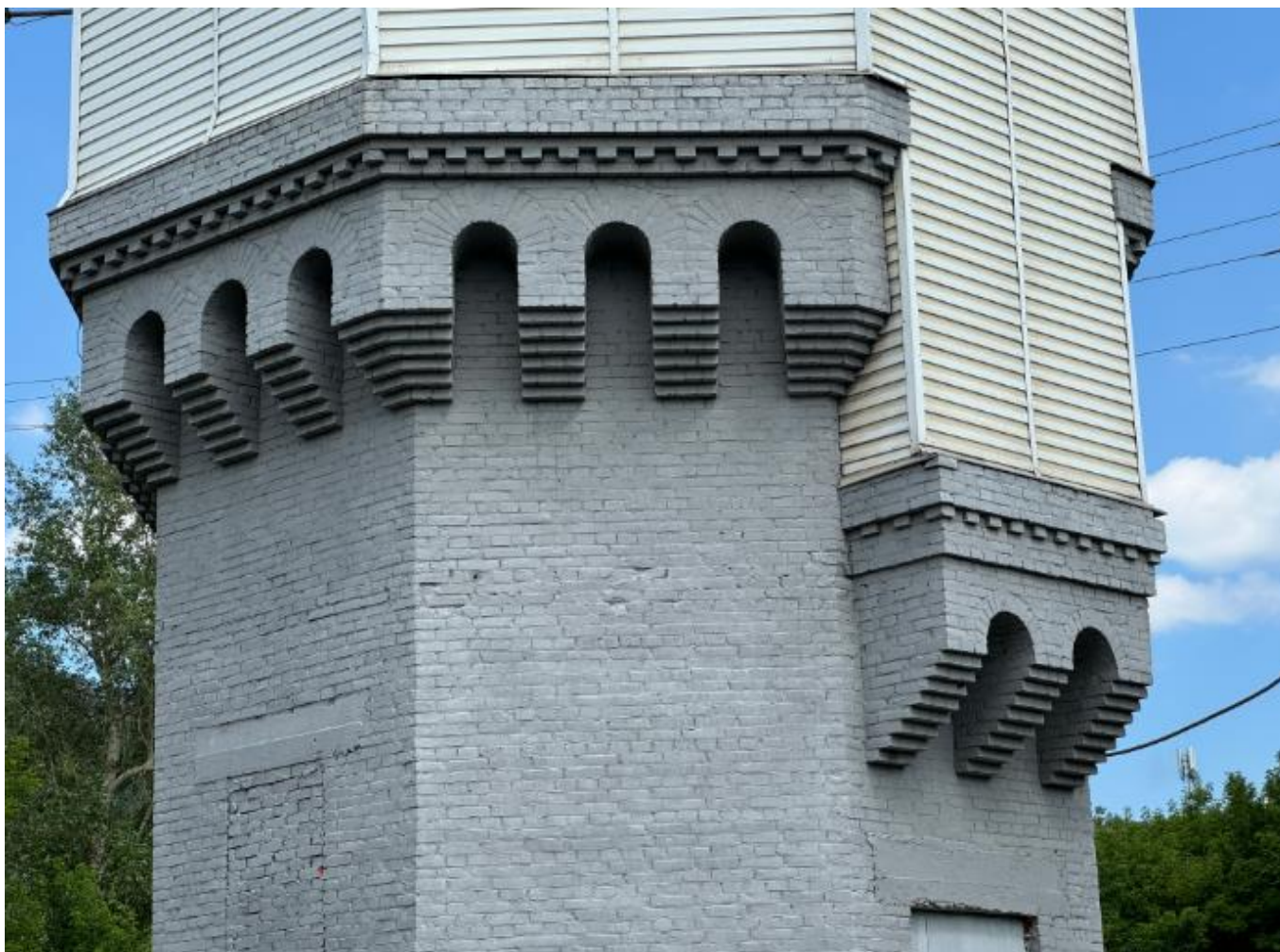
Фото 2. Вид на выявленный объект культурного наследия «Водонапорная башня-2», расположенный по адресу: Челябинская область, Миасский городской округ, г. Миасс, ж/д ст. Миасс-1.
