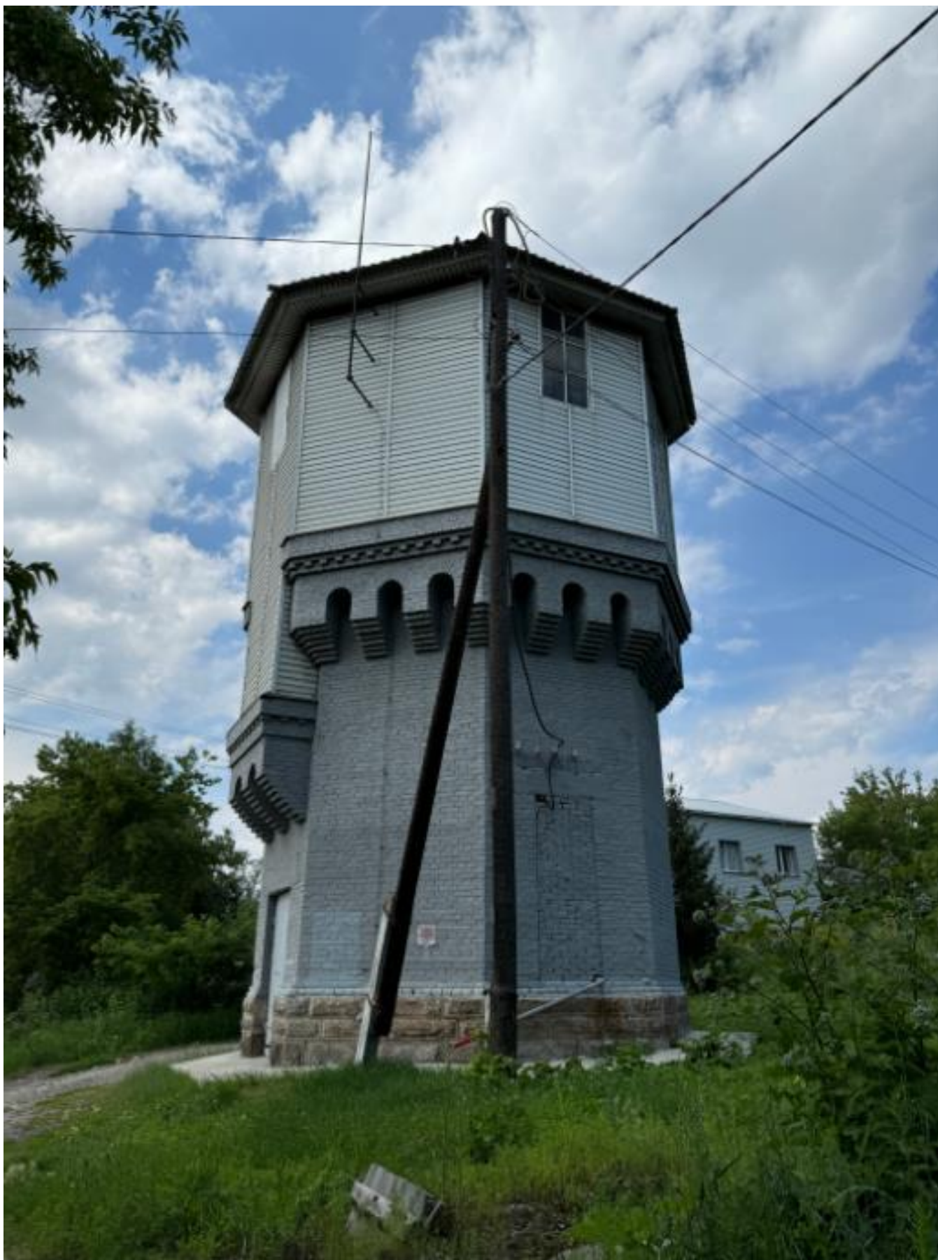
Фото 7. Вид на выявленный объект культурного наследия «Водонапорная башня-2», расположенный по адресу: Челябинская область, Миасский городской округ, г. Миасс, ж/д ст. Миасс-1.
