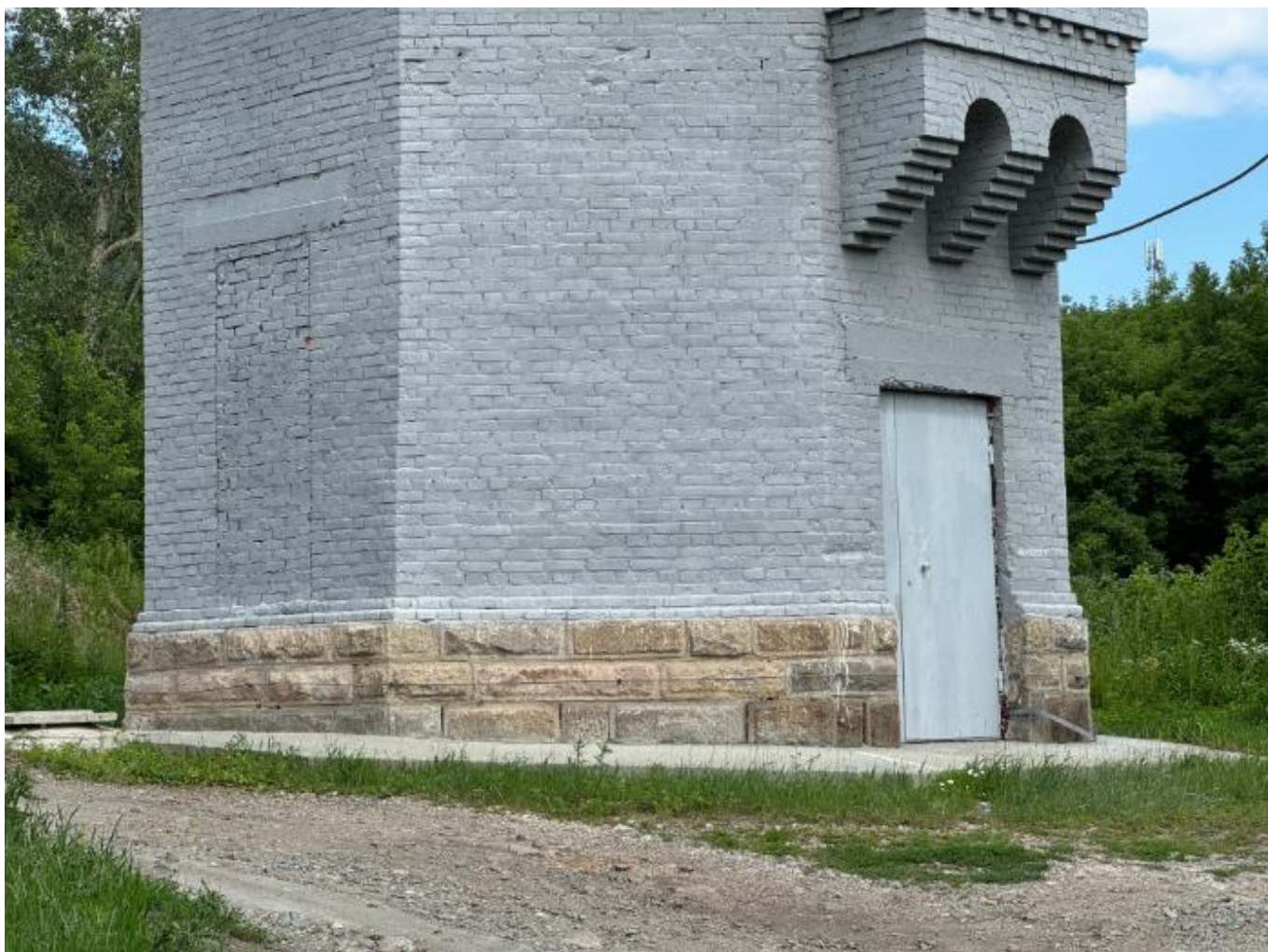
Фото 4. Вид на выявленный объект культурного наследия «Водонапорная башня-2», расположенный по адресу: Челябинская область, Миасский городской округ, г. Миасс, ж/д ст. Миасс-1.
