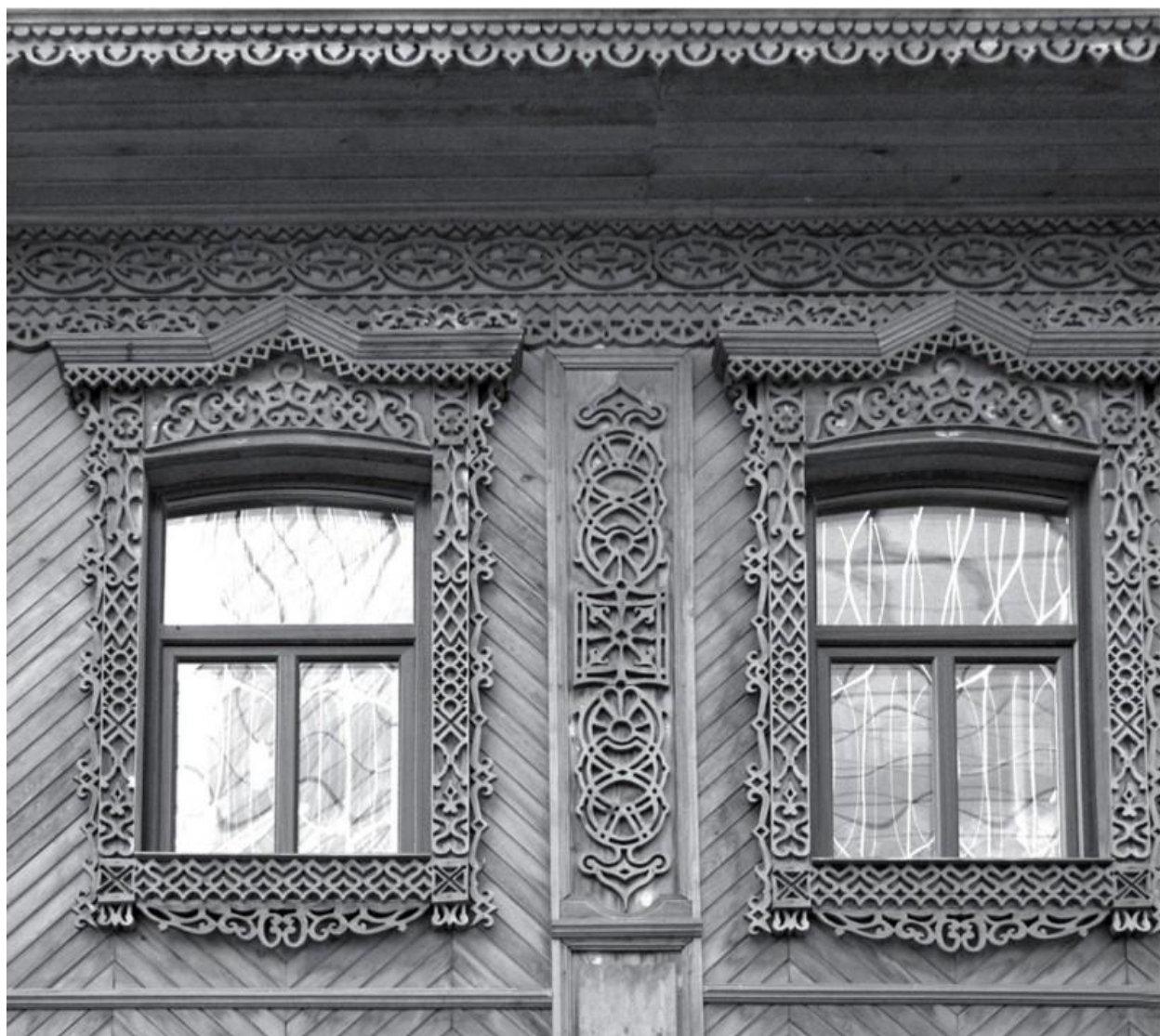
Приложение №11. Современное обрамление оконных проемов и деревянные декоративные элементы «Дома жилого». Фото 2013 года. Ю. Латышев.
