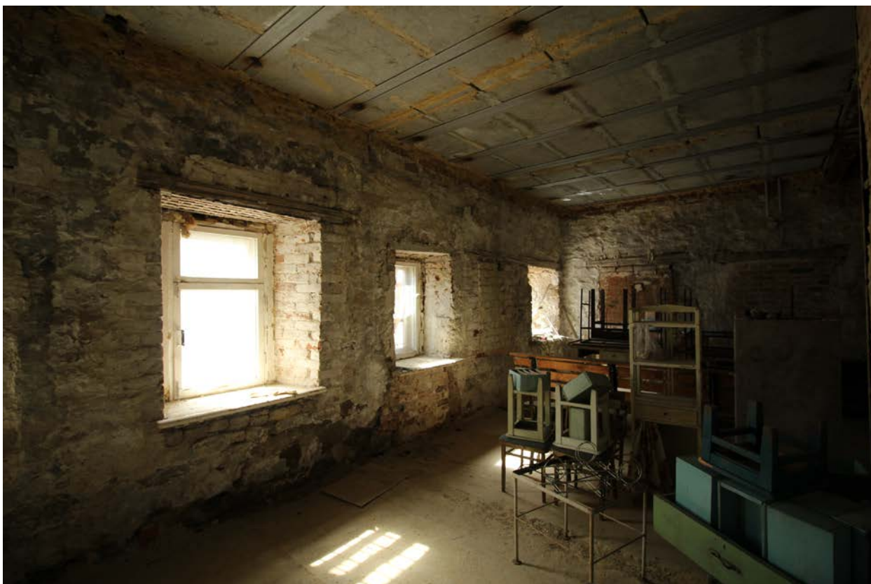
Фото 11. Объект культурного наследия. Внутренние помещения.
