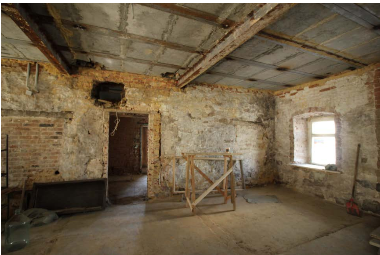
Фото 14. Объект культурного наследия. Внутренние помещения.
