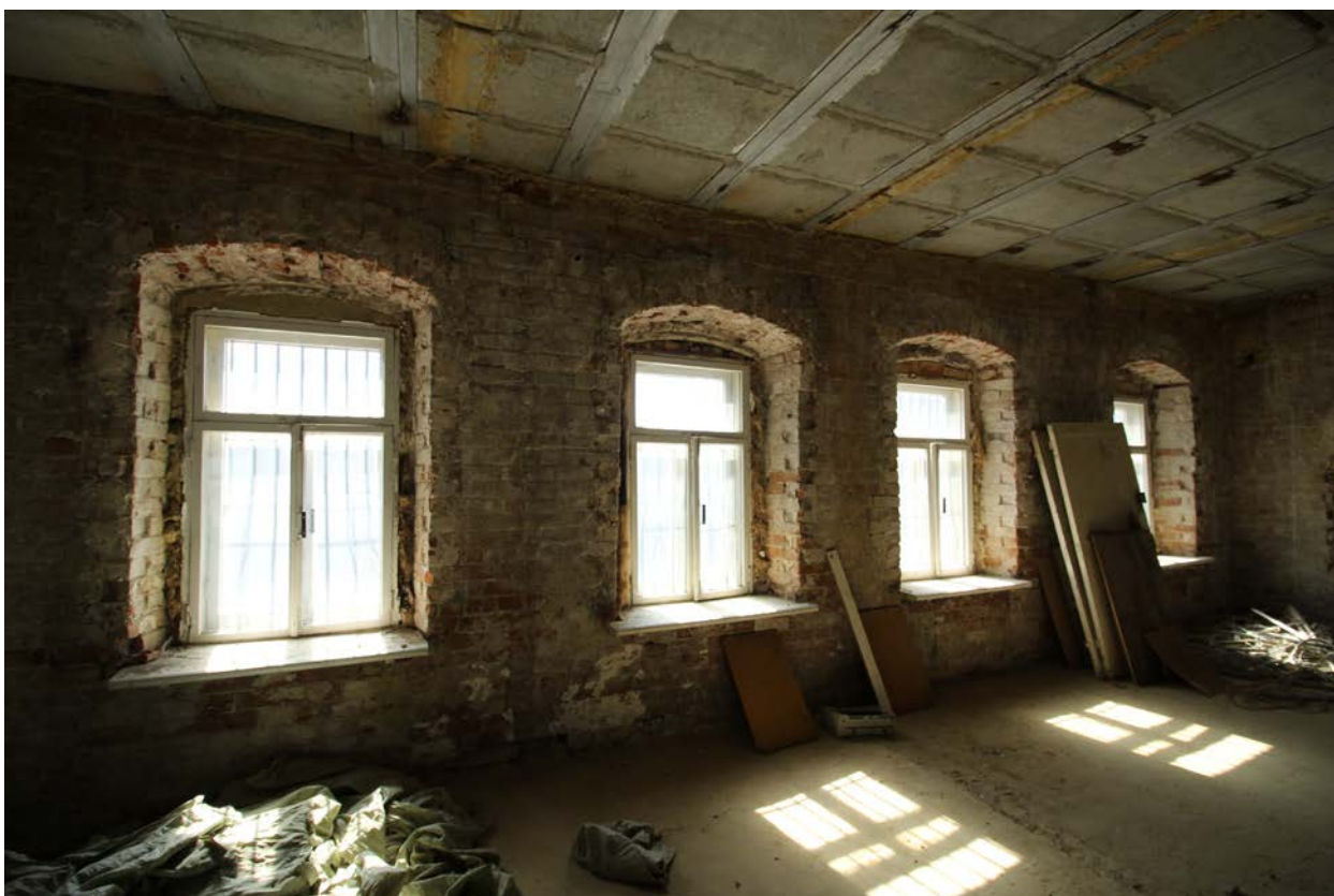
Фото 24. Объект культурного наследия. Внутренние помещения.
