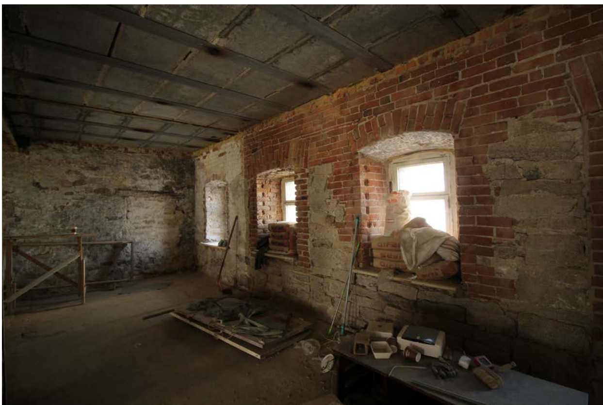
Фото 12. Объект культурного наследия. Внутренние помещения.
