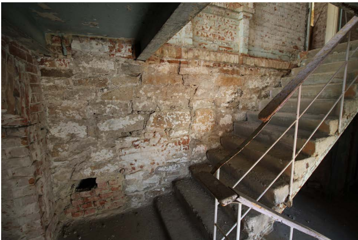
Фото 17. Объект культурного наследия. Внутренние помещения.
