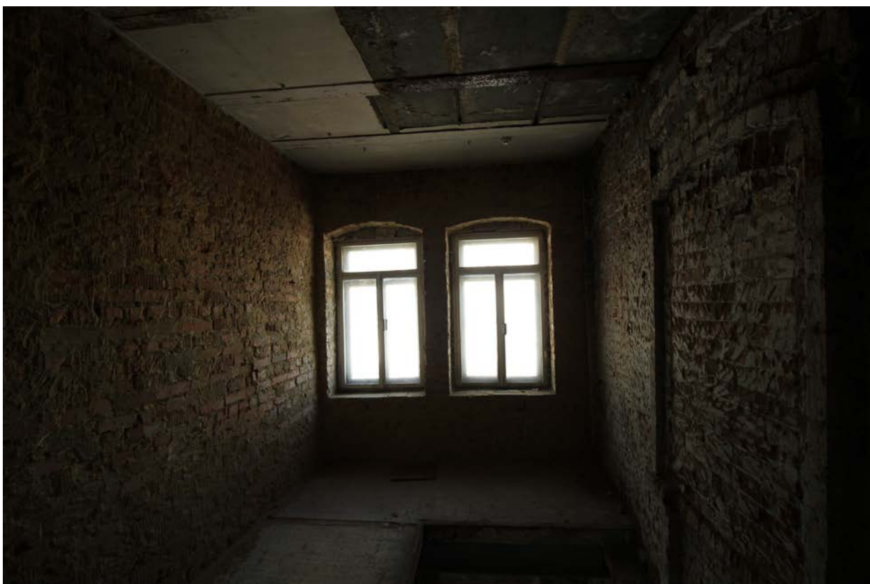
Фото 26. Объект культурного наследия. Внутренние помещения.
