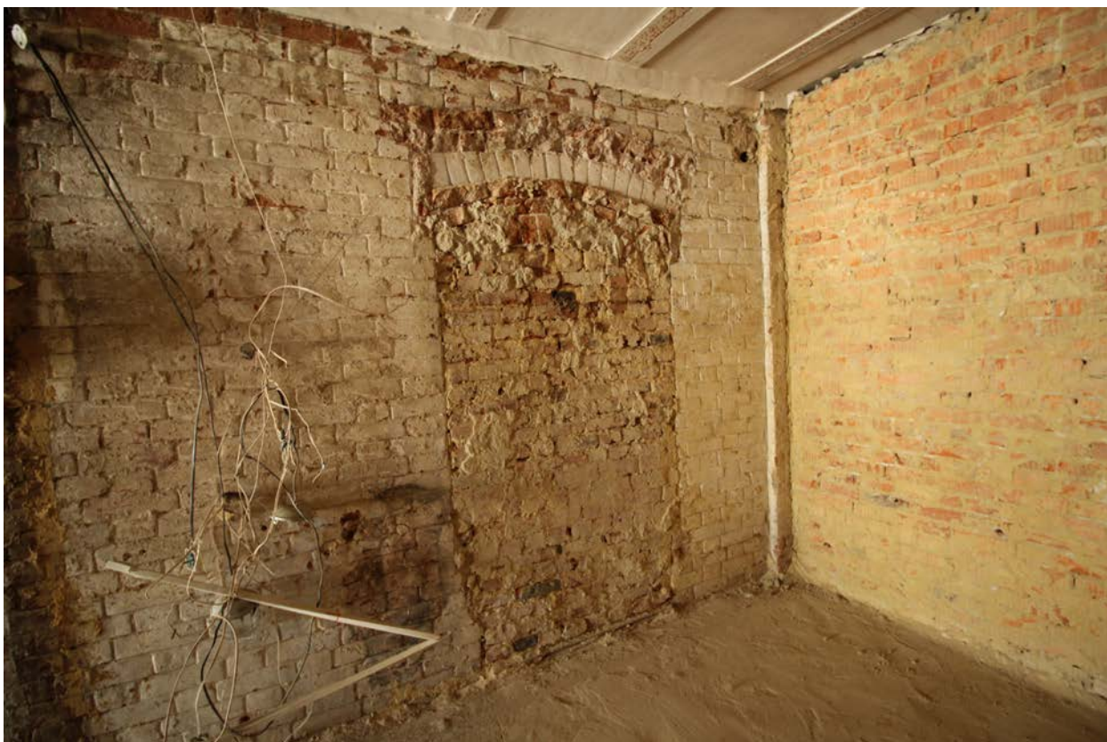
Фото 21. Объект культурного наследия. Внутренние помещения.
