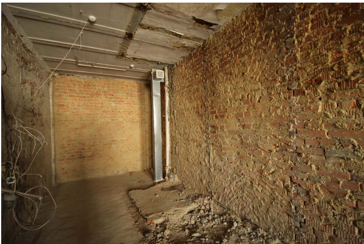
Фото 18. Объект культурного наследия. Внутренние помещения.
