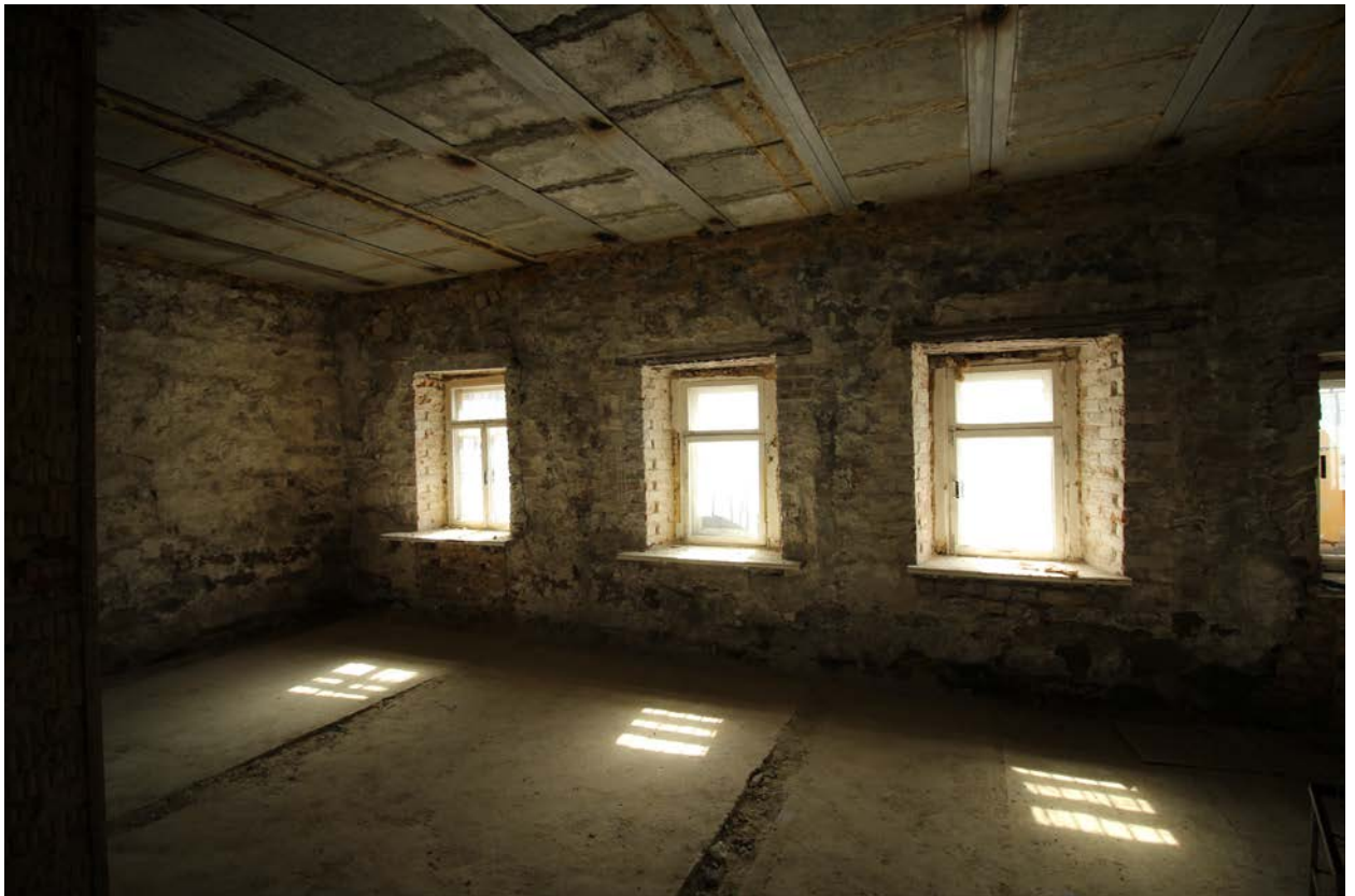
Фото 10. Объект культурного наследия. Внутренние помещения.
