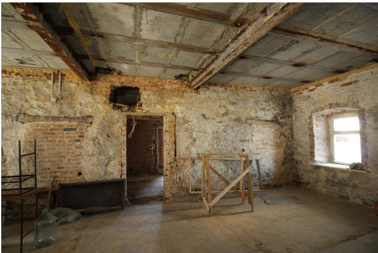
Фото 13. Объект культурного наследия. Внутренние помещения.
