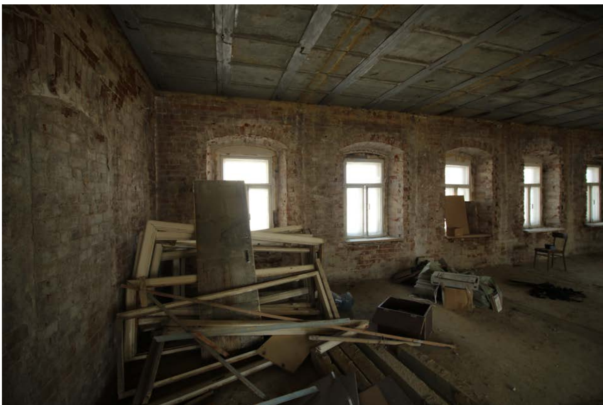
Фото 22. Объект культурного наследия. Внутренние помещения.
