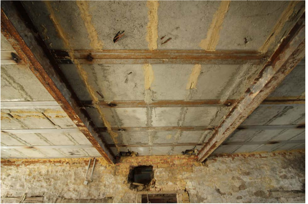
Фото 15. Объект культурного наследия. Внутренние помещения.
