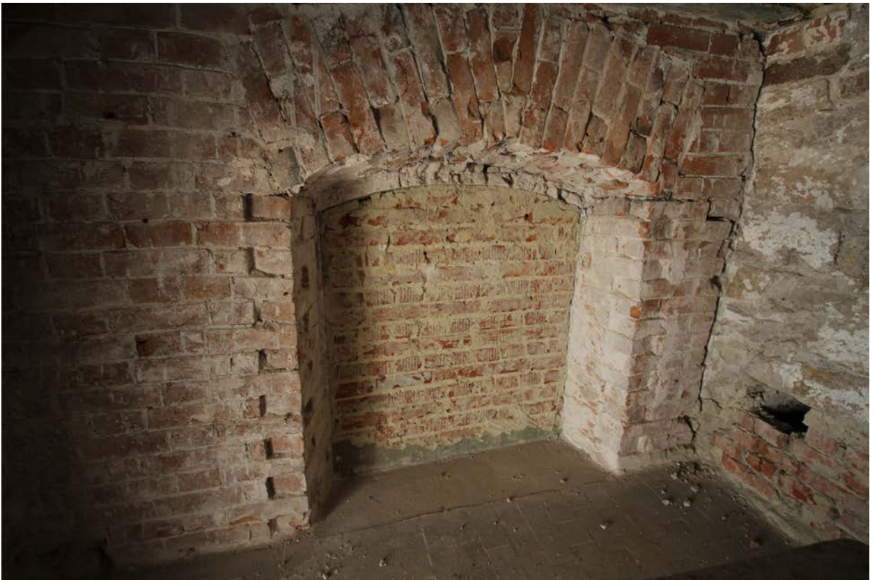
Фото 16. Объект культурного наследия. Внутренние помещения.
