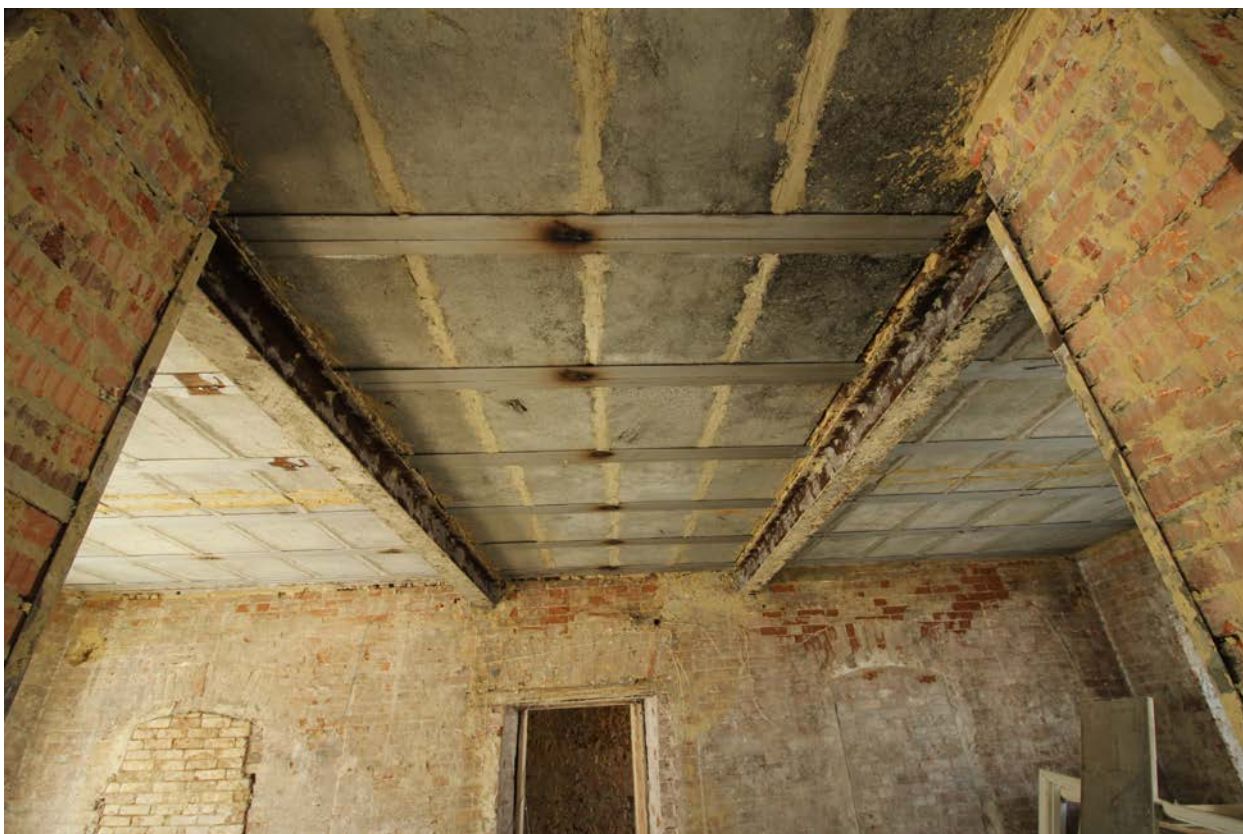
Фото 25. Объект культурного наследия. Внутренние помещения.
