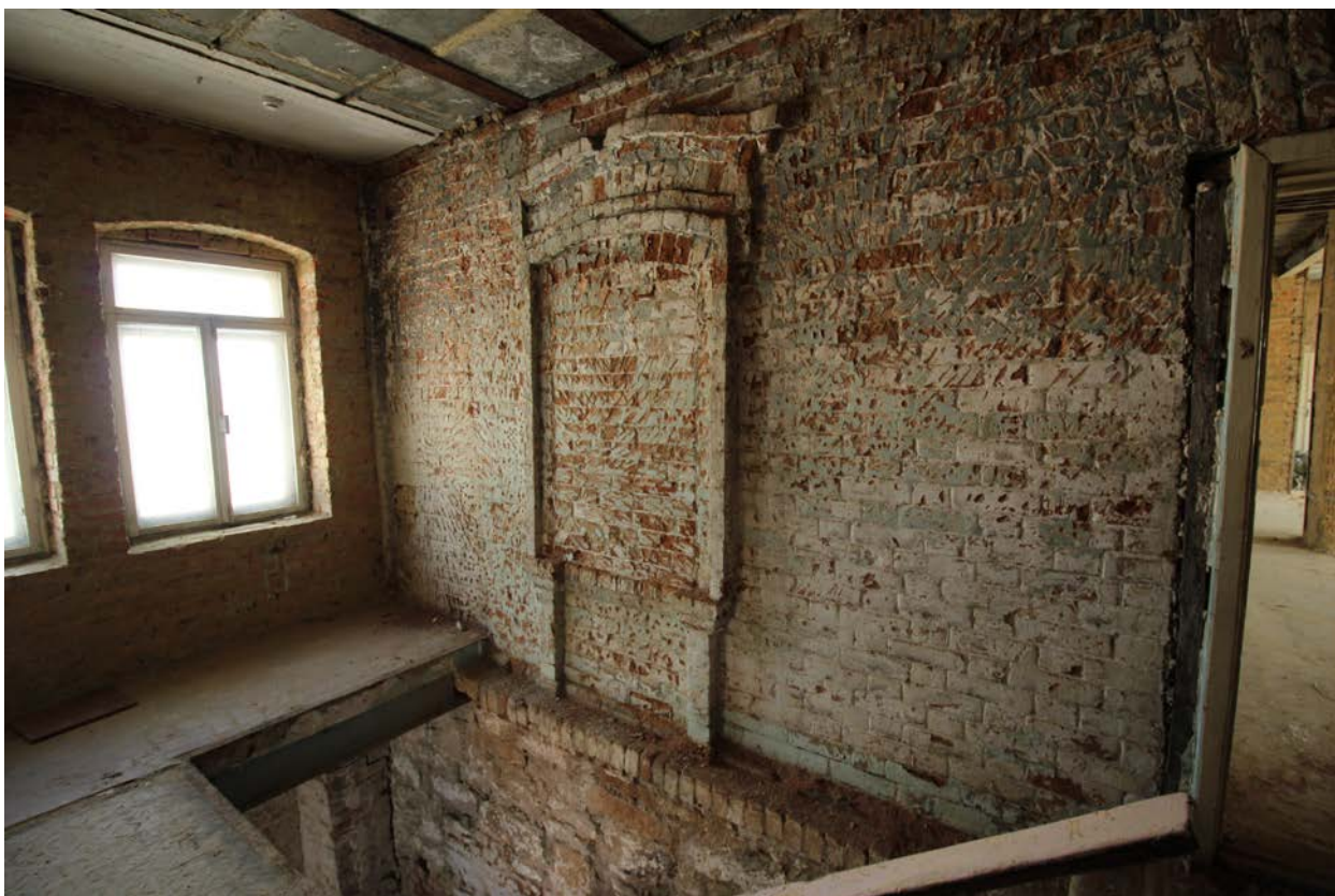
Фото 19. Объект культурного наследия. Внутренние помещения.
