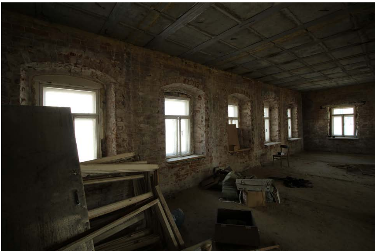
Фото 23. Объект культурного наследия. Внутренние помещения.
