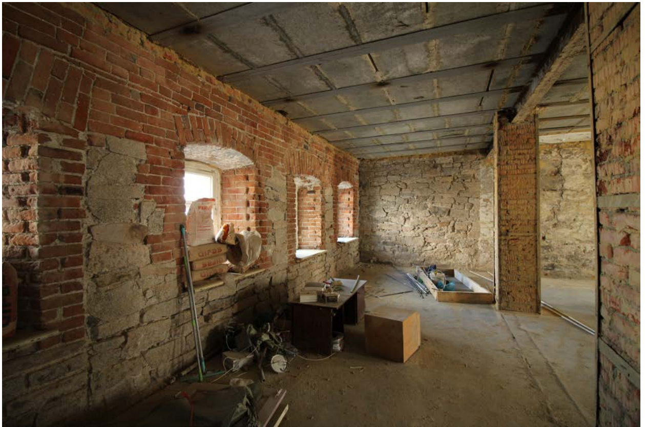
Фото 9. Объект культурного наследия. Внутренние помещения.
