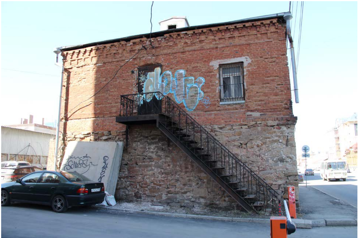
Фото 3. Объект культурного наследия. Пожарная лестница.
