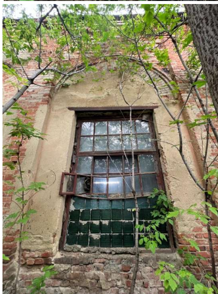
Рис. 6 а, б. Оконные проемы восточного фасада
