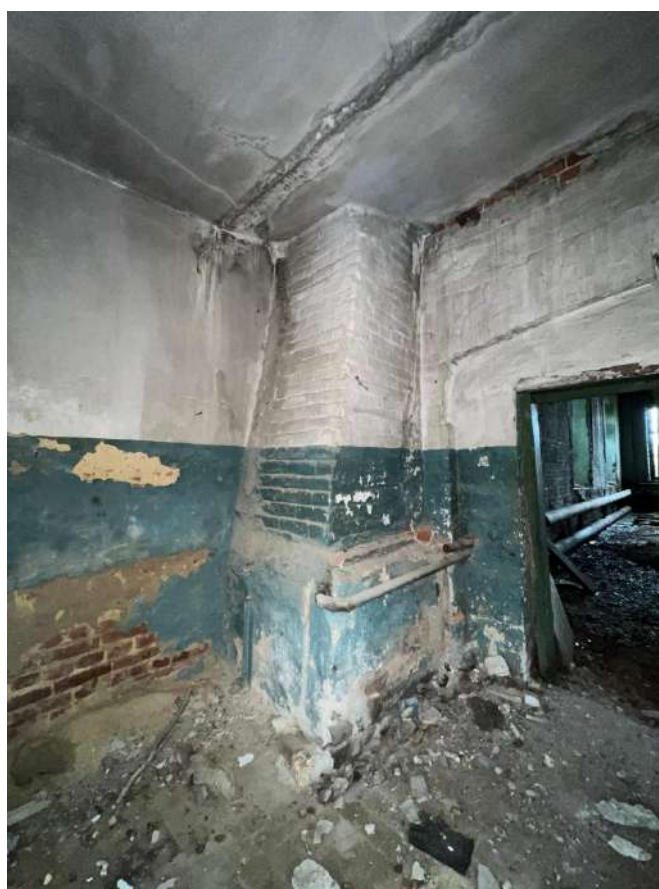
Рис. 22. Нижняя часть левого флангового контрфорса восточного фасада, скрытая в объеме пристроя со стороны восточного фасада
