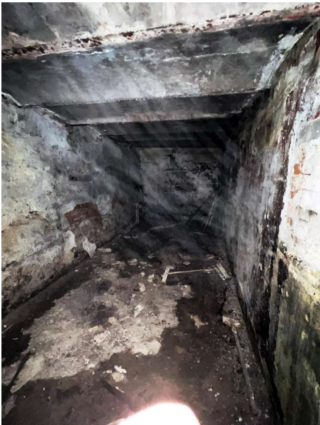
Рис. 24. Подвальное помещение (№ 2 технического плана). Кирпичные сводки по металлическим балкам
