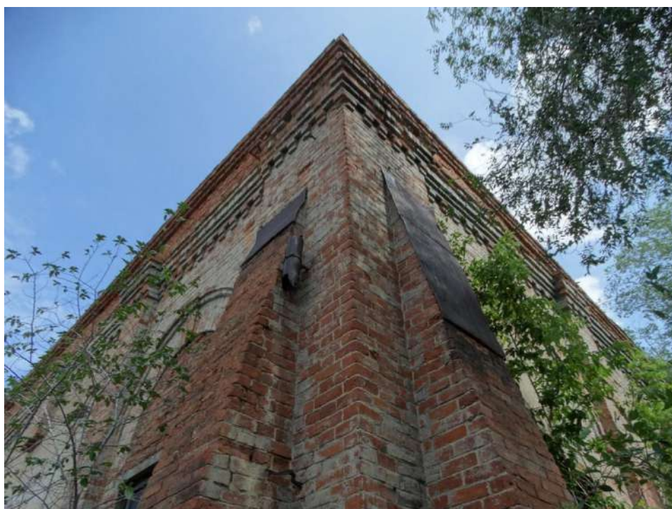
Рис. 12 а, б. Стык западного и южного фасадов. Угол и фланговые контрфорсы. Фото Ю.В. Латышева. 2020 г.
