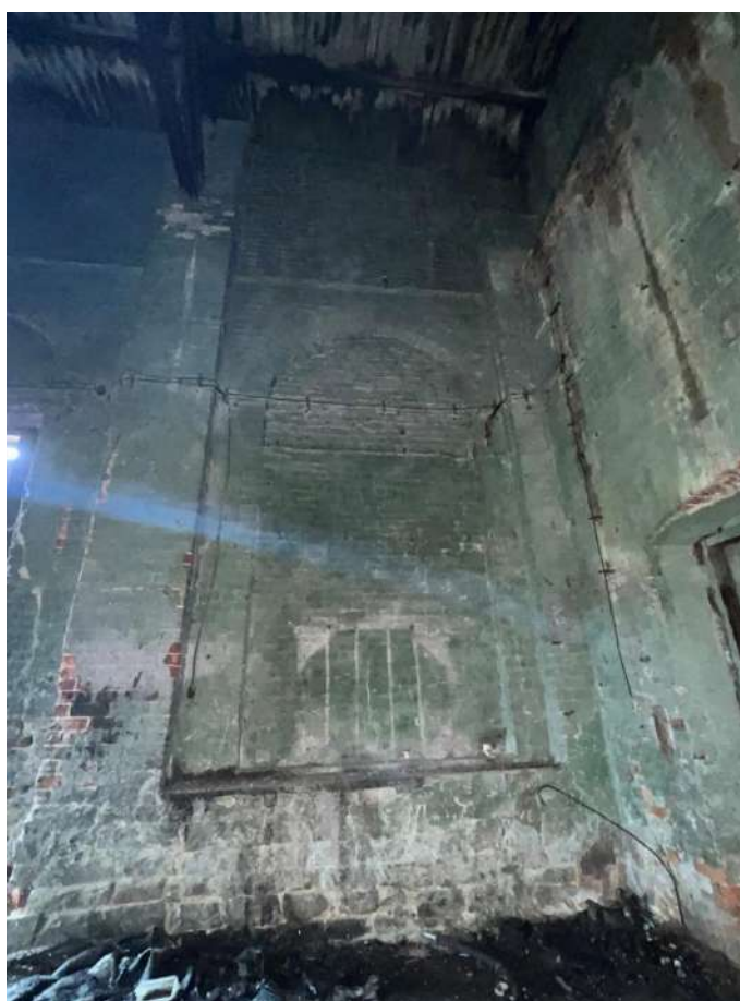
Рис. 19. Машинный зал электростанции. Западная стена. Заложенный правый оконный проем
