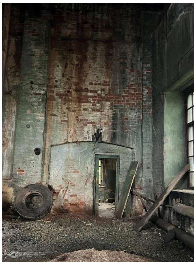
Рис. 15. Машинный зал электростанции. Частично заложенный исторический входной проем в восточной стене
