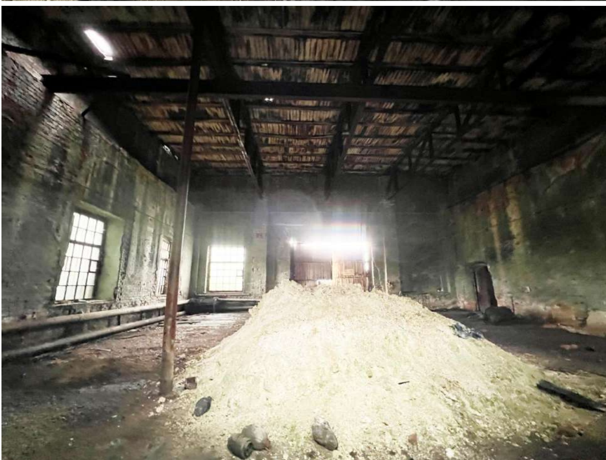
Рис. 20. Машинный зал электростанции. Металлические фермы перекрытия
