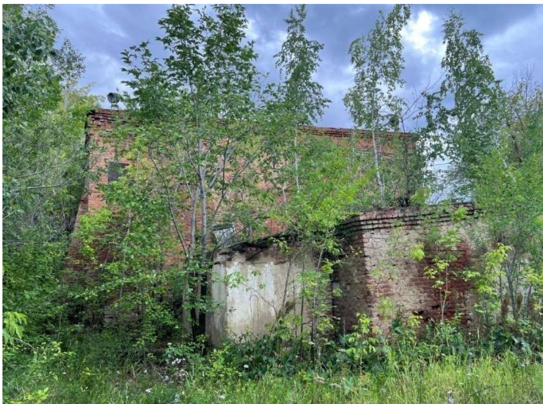
Рис. 3. Боковой, северный фасад
