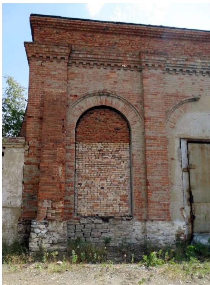
Рис. 10 а, б. Главный, западный фасад здания. Фото Ю.В. Латышева. 2020 г.
