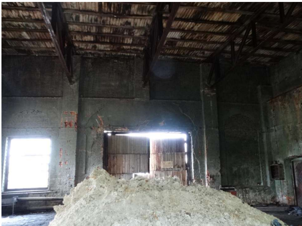
Рис. 13. Пространство машинного зала. Фото Ю.В. Латышева. 2020 г.
