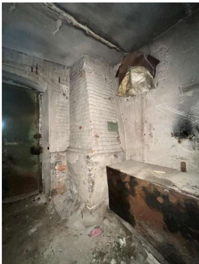
Рис. 21. Нижняя часть правого флангового контрфорса северного фасада, скрытая в объеме пристроя со стороны северного фасада
