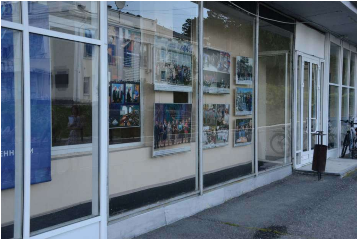
Рис. 16. Главный (северо-западный) фасад. Витрина бывшего магазина «Гастроном». Фрагмент сохранившейся расстекловки
