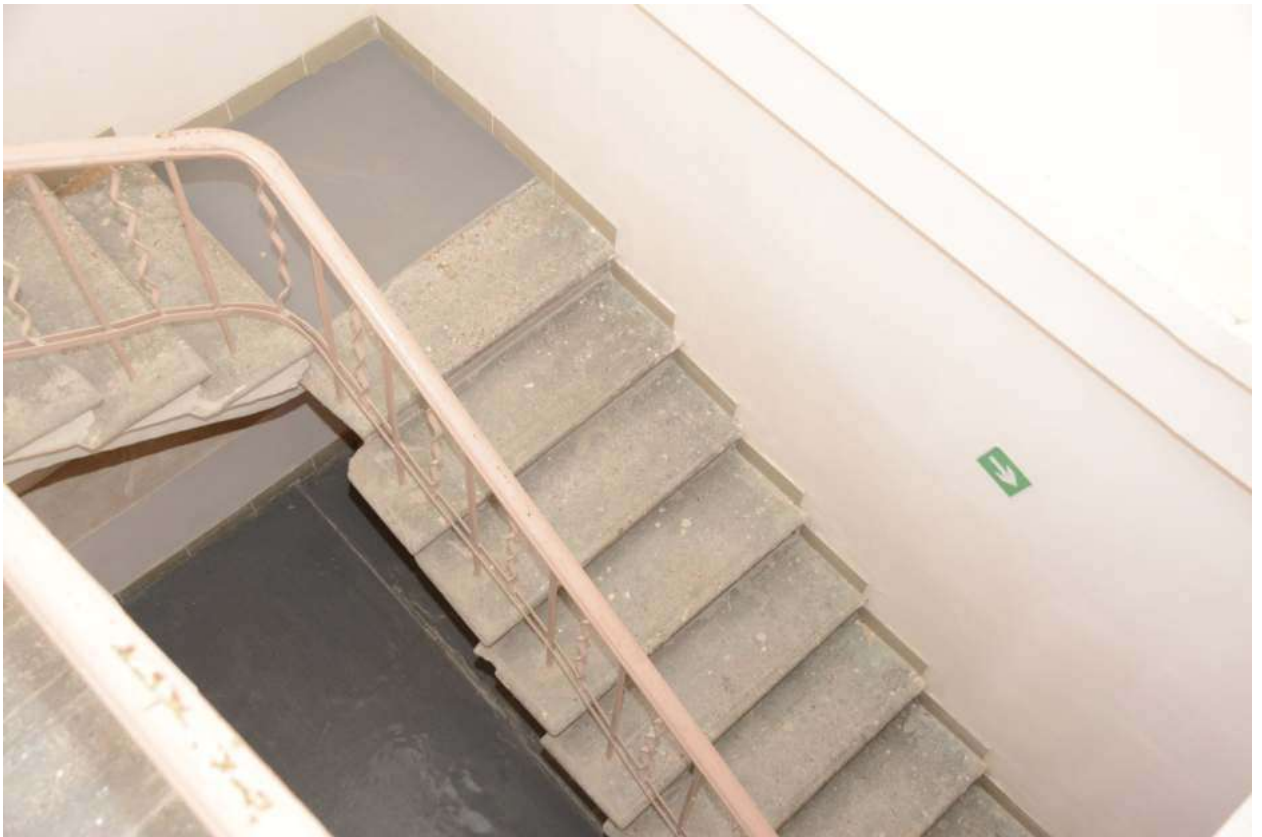
Рис. 29. Лестница в подвал
