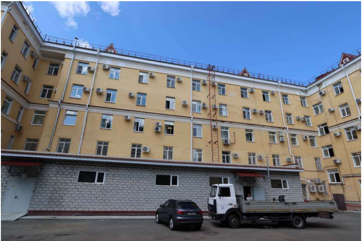
Рис. 7. Дворовый (юго-восточный) фасад западного крыла здания. Вид юга.
