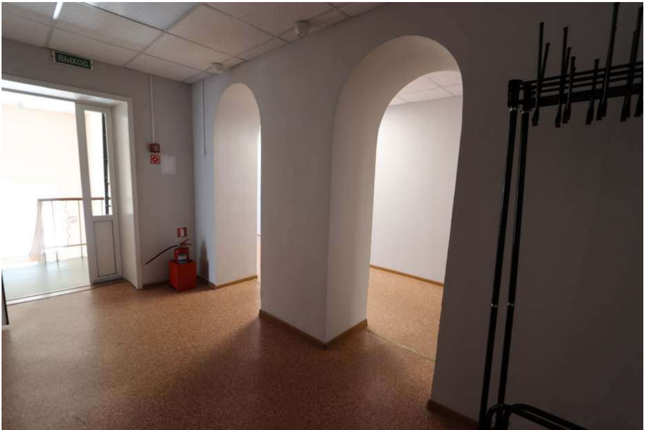
Рис. 68. 5 этаж, коридор восточного крыла, двойная арка входа в тамбур перед лестницей
