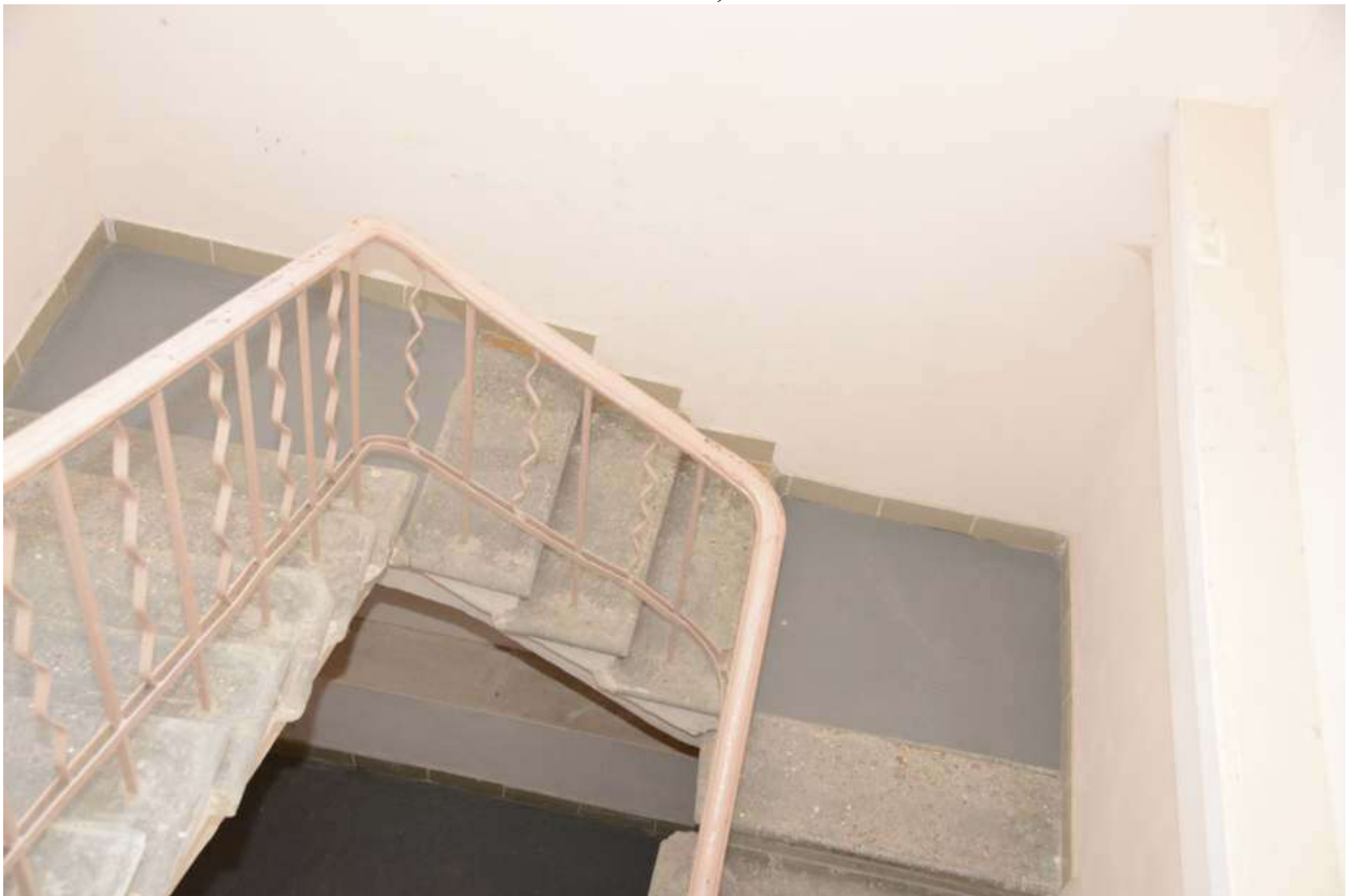
Рис. 28. Лестница в подвал
