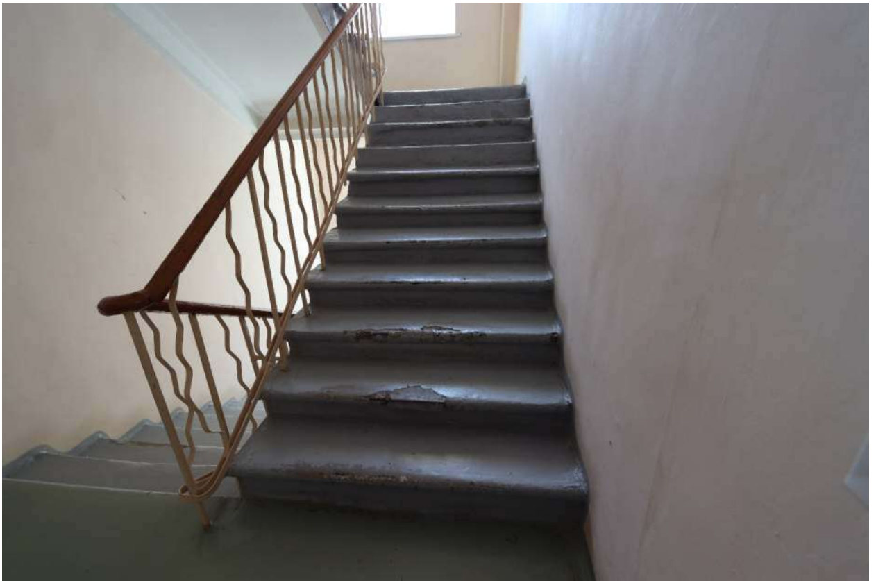
Рис. 70. Запасная лестница восточного крыла
