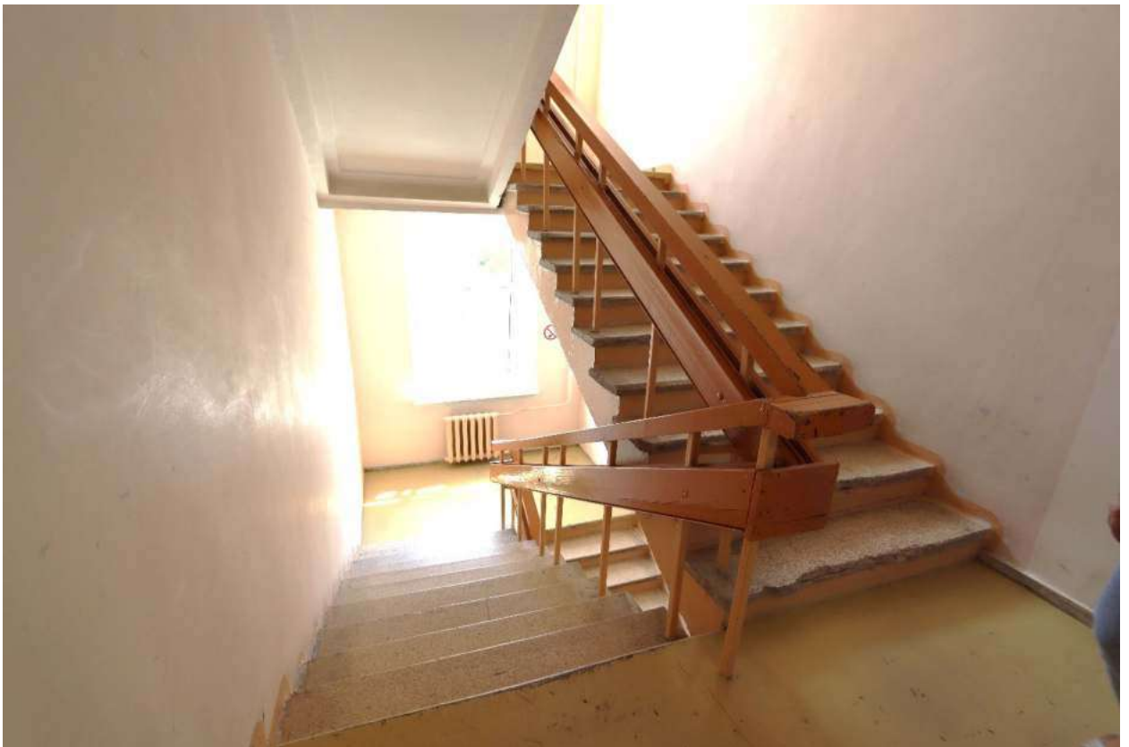
Рис. 52. 3 этаж, запасная лестница западного крыла
