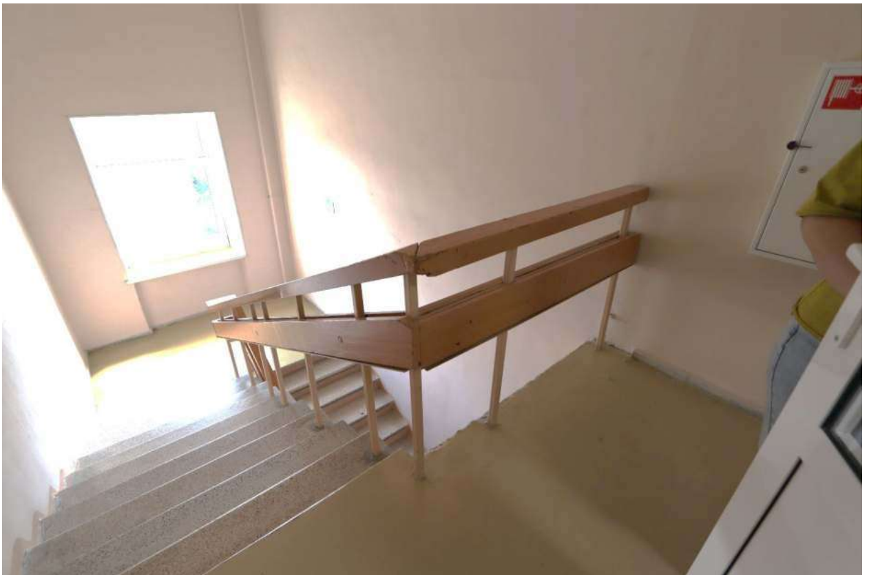
Рис. 81. Запасная лестница западного крыла
