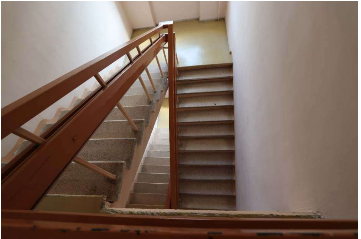
Рис. 80. Запасная лестница западного крыла
