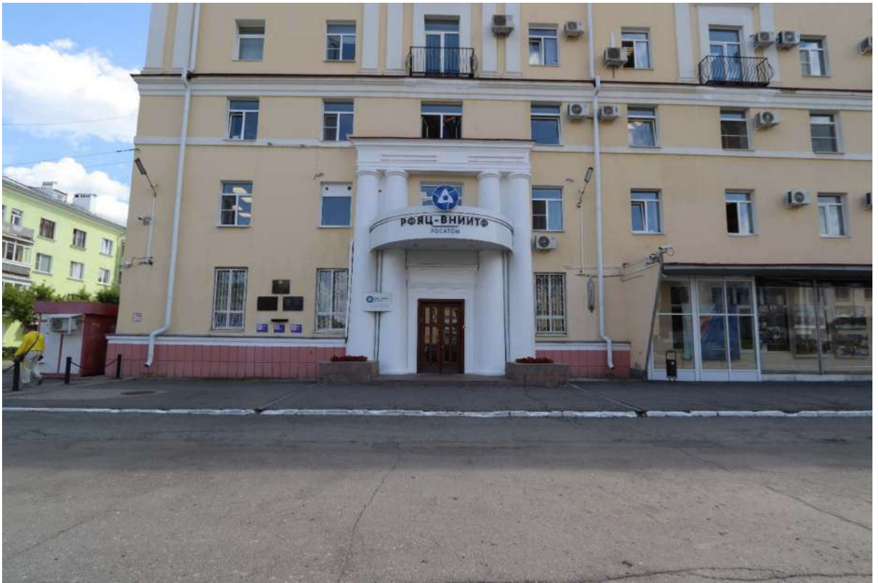
Рис. 10. Главный (северо-западный) фасад. Входная группа.
