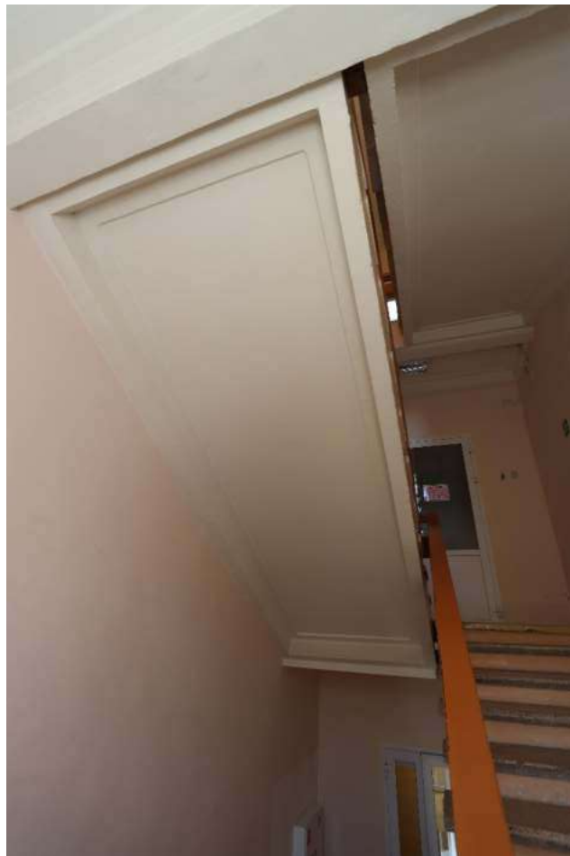
Рис. 54. 3 этаж, запасная лестница западного крыла
