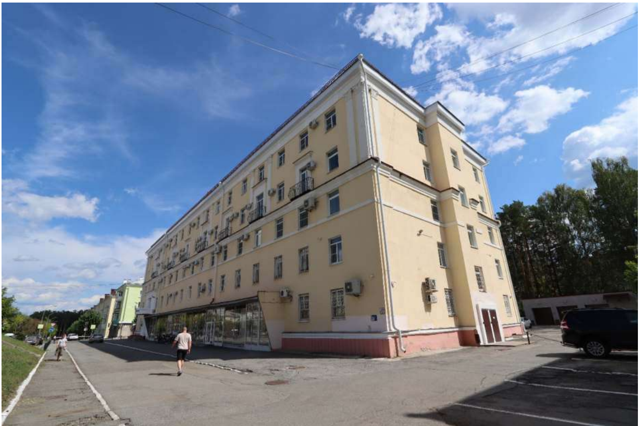
Рис. 4. Главный (северо-восточный) и боковой (юго-западный) фасады.
