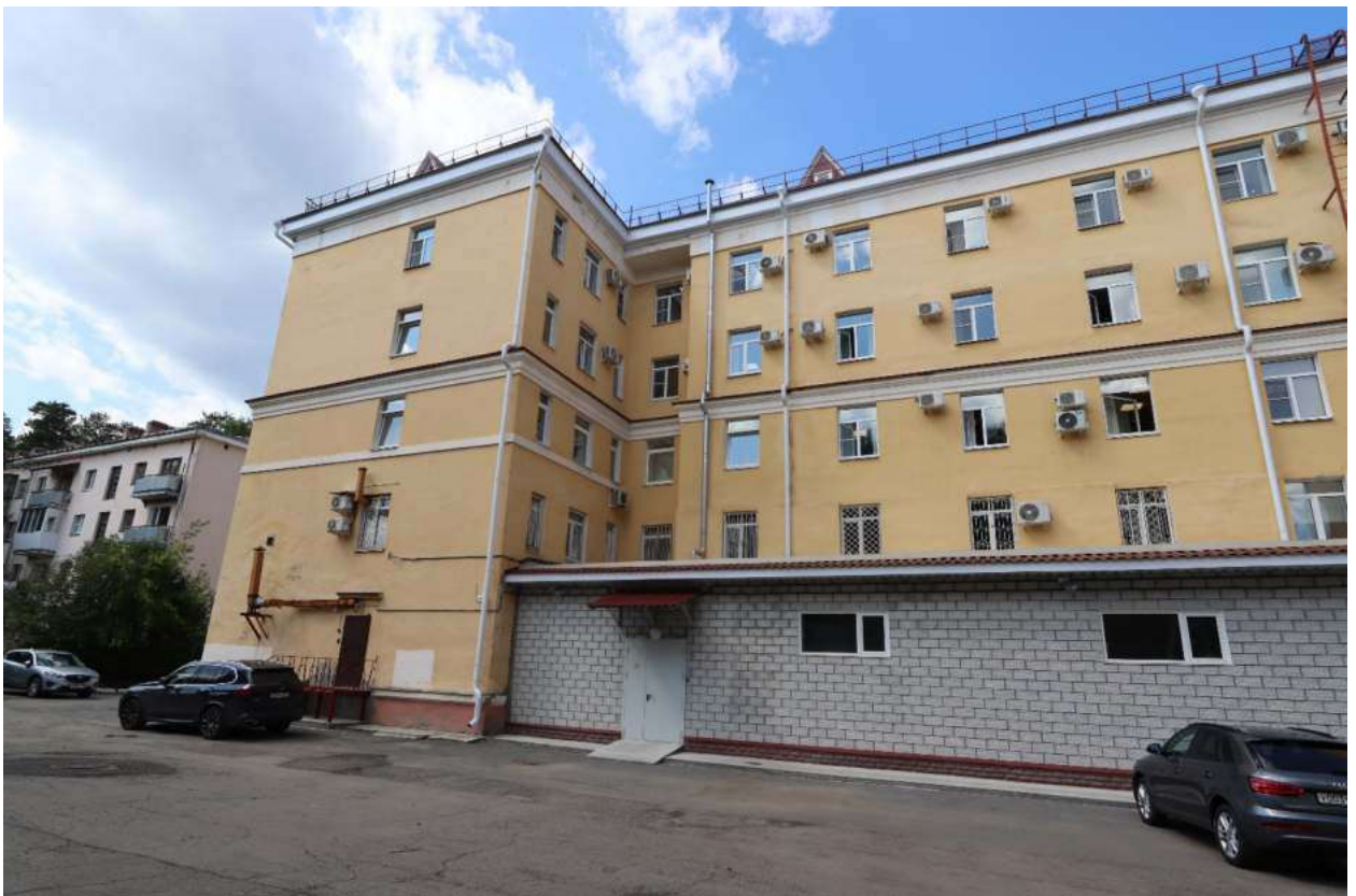
Рис. 6. Торцевой и боковой (северо-восточный) фасады дворового ризалита и дворовый (юго-восточный) фасад западного крыла здания. Вид юга.
