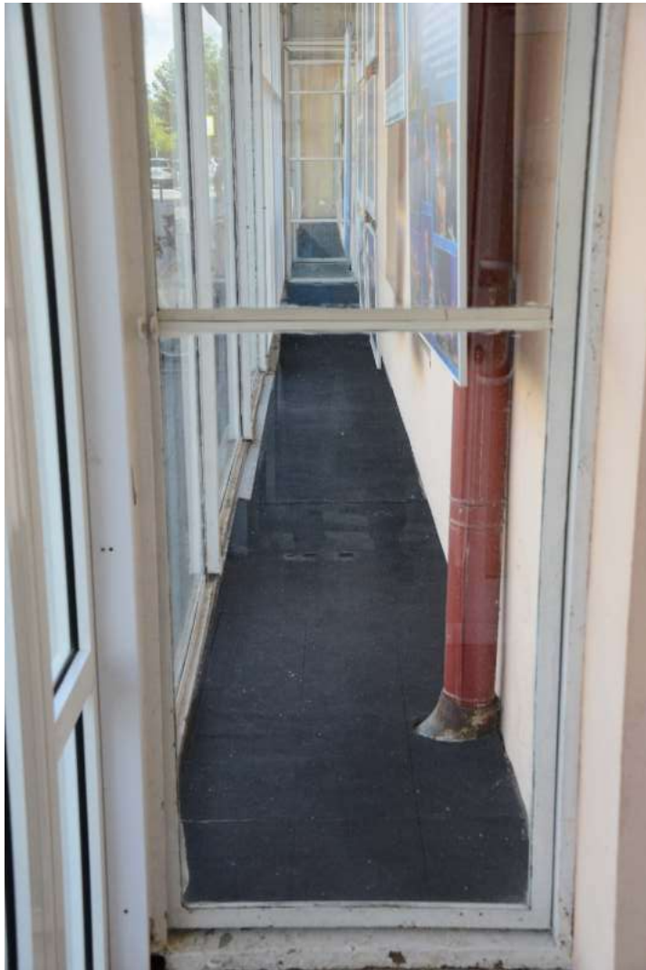
Рис. 17. Главный (северо-западный) фасад. Витрина бывшего магазина «Гастроном». Вид с юго-запада
