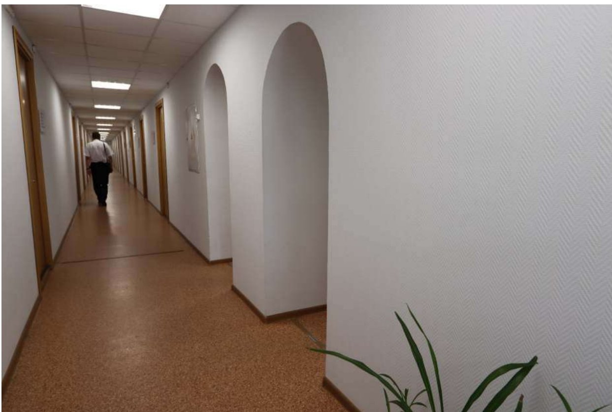
Рис. 67. 4 этаж, коридор восточного крыла, двойная арка входа в тамбур перед лестницей
