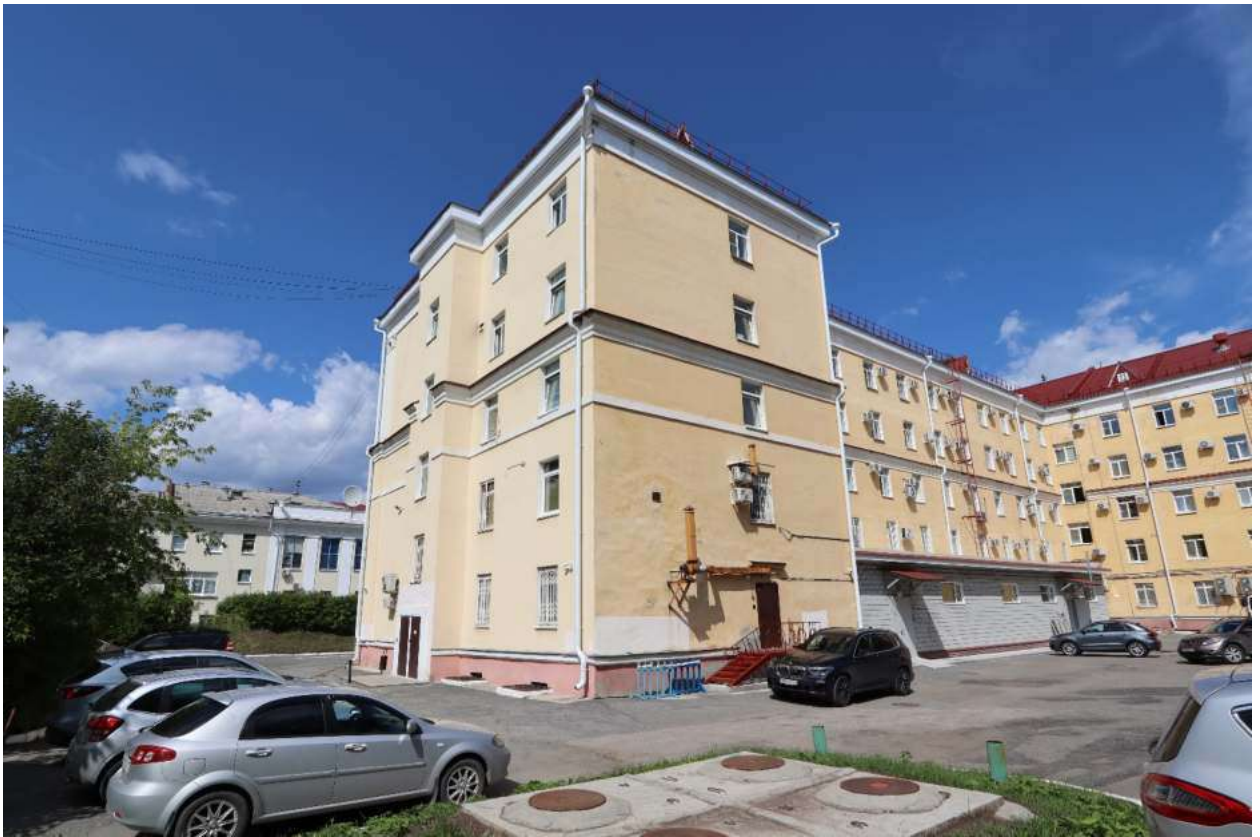
Рис. 5. Торцевой и боковой фасады дворового ризалита и дворовый (юго-востонный) фасад западного крыла здания. Вид юга.
