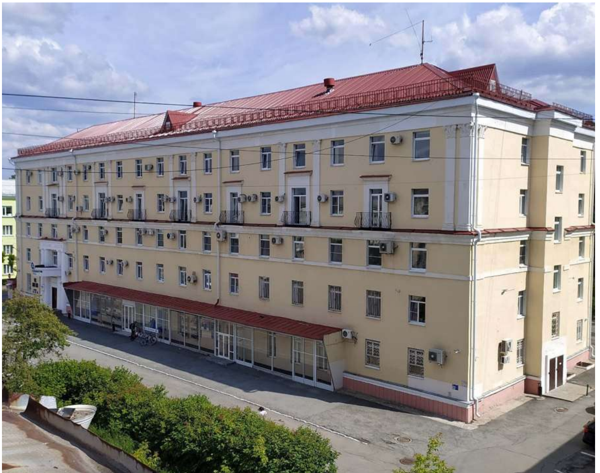
Рис. 2. Главный (северо-западный) фасад.
