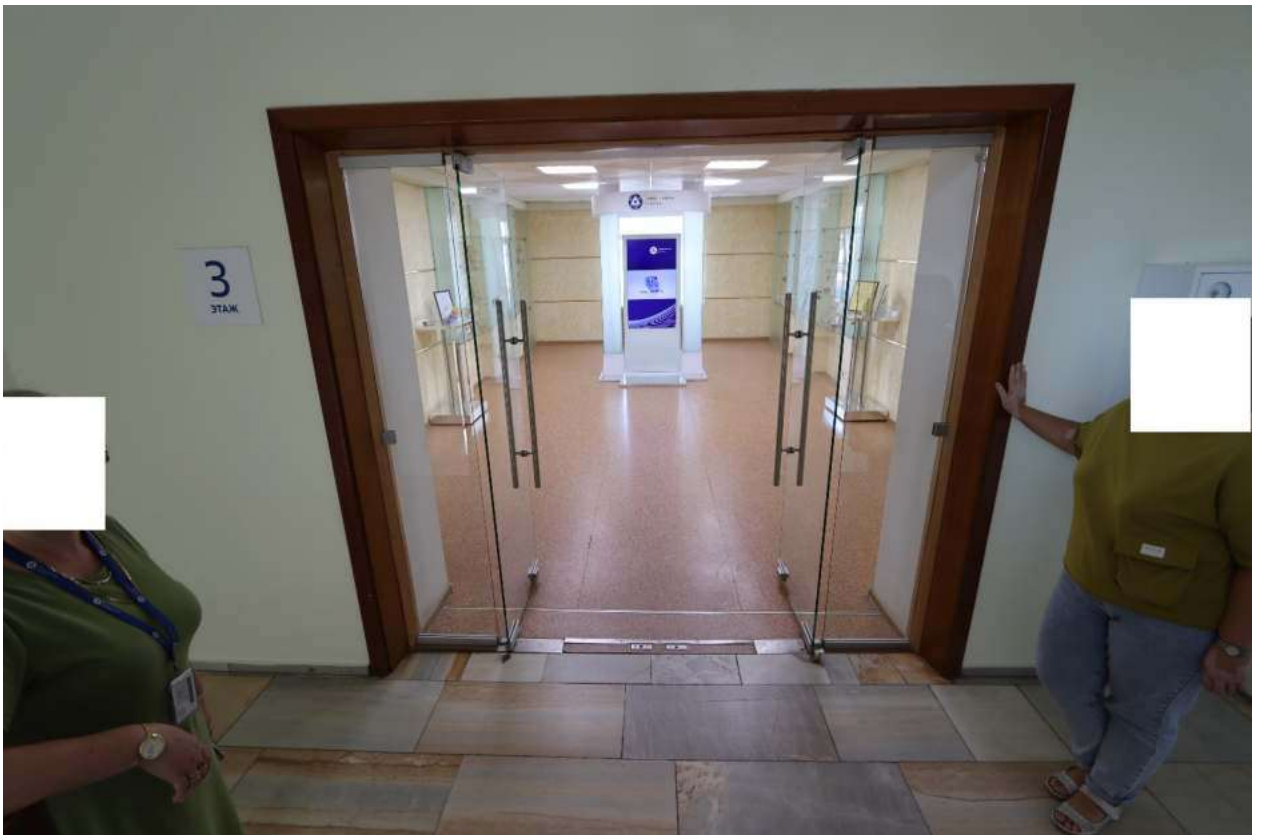
Рис. 43. 3 этаж, лестничная площадка главной лестницы, вход в фойе
