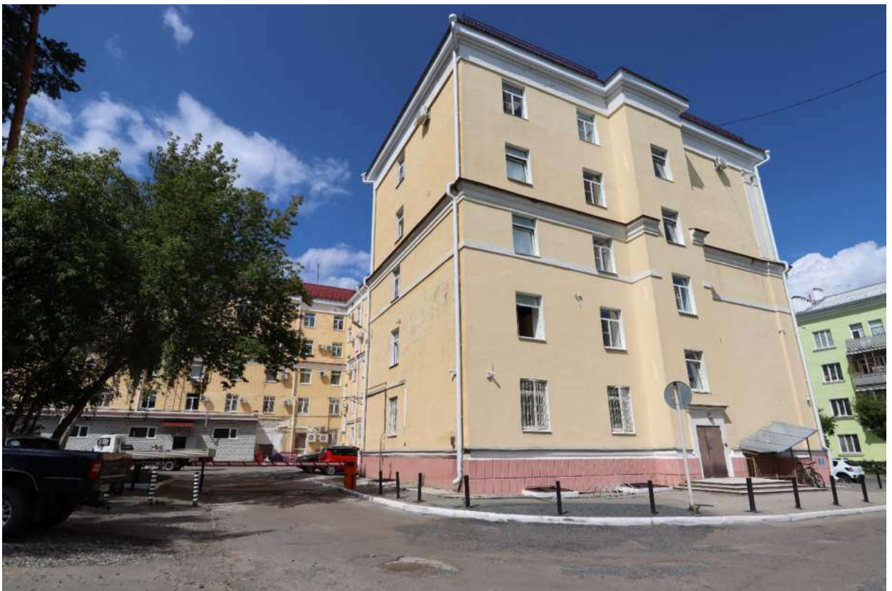
Рис. 10. Торцевой и боковой (юго-восточный) фасады дворового ризалита восточного крыла здания. Вид юга.
