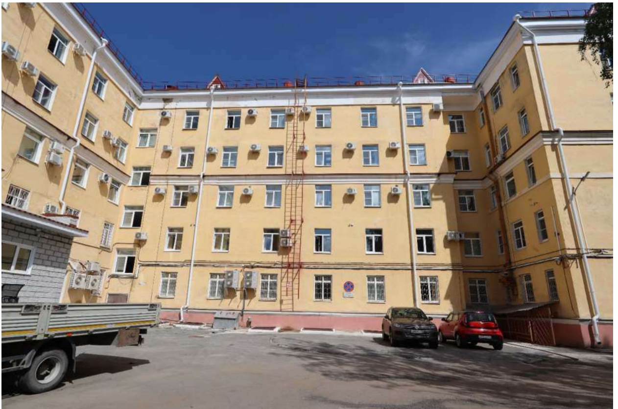
Рис. 8. Дворовый (юго-западный) фасад восточного крыла здания. Вид юго-запада.
