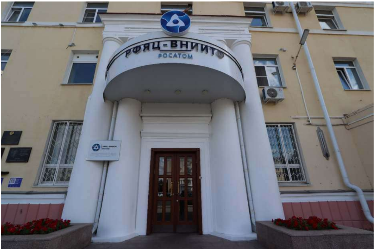
Рис. 11. Главный (северо-западный) фасад. Входная группа.
