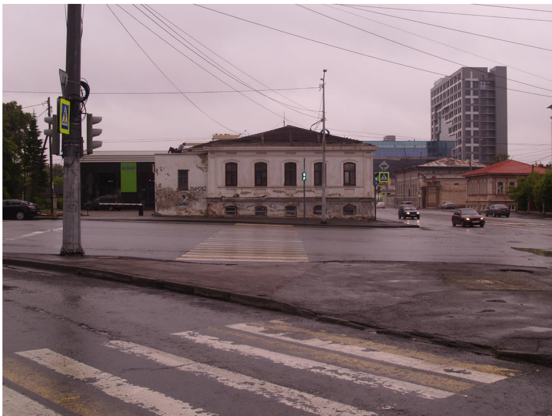
Фото 23. Градостроительная ситуация на территории исследования.
