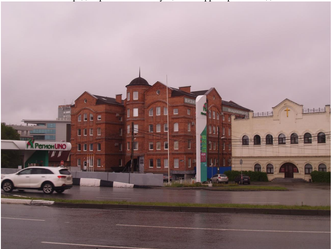
Фото 20. Градостроительная ситуация на территории исследования.
