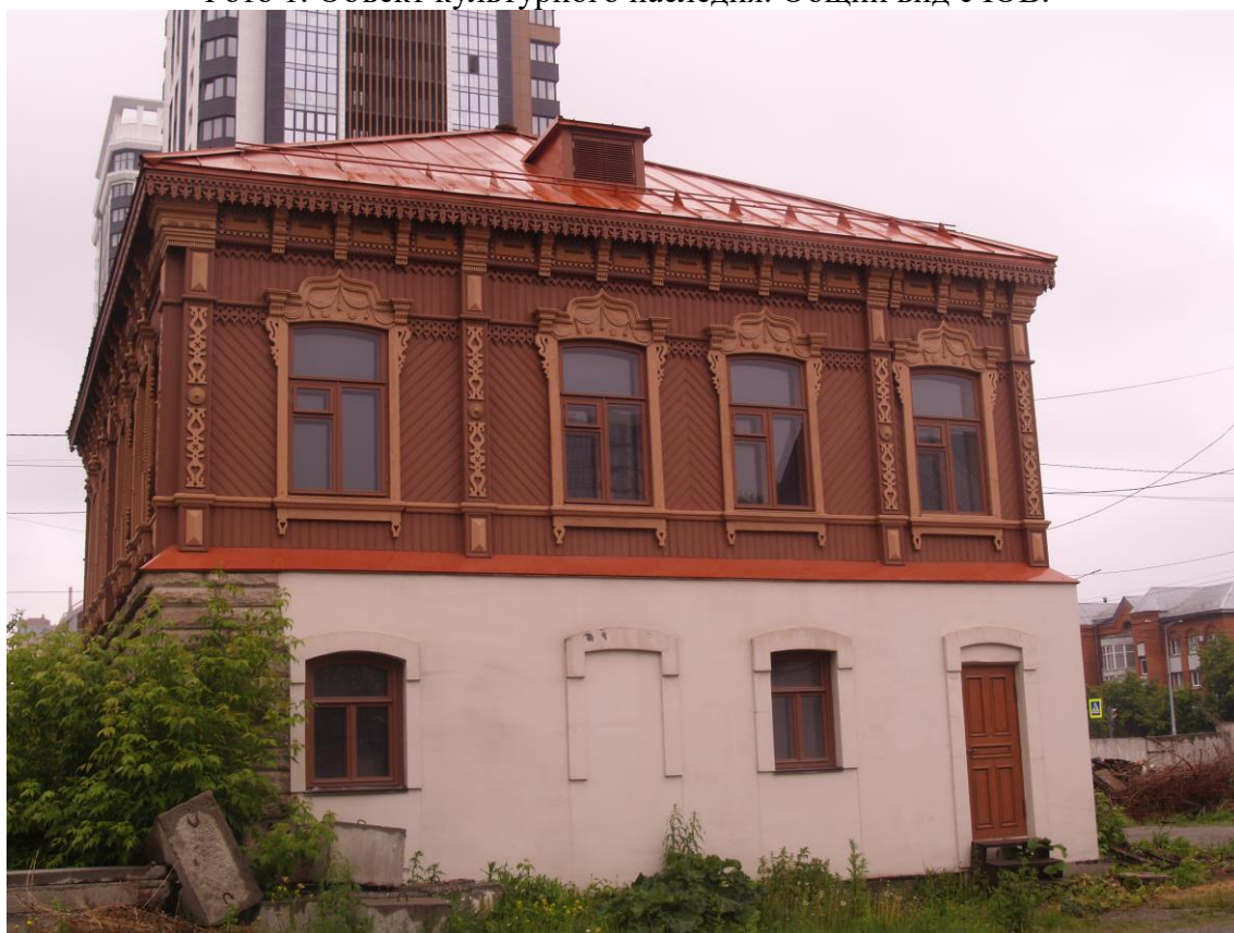
Фото 2. Объект культурного наследия. Общий вид с С.
