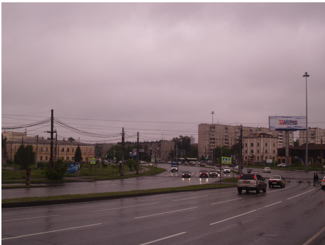
Фото 21. Градостроительная ситуация на территории исследования.
