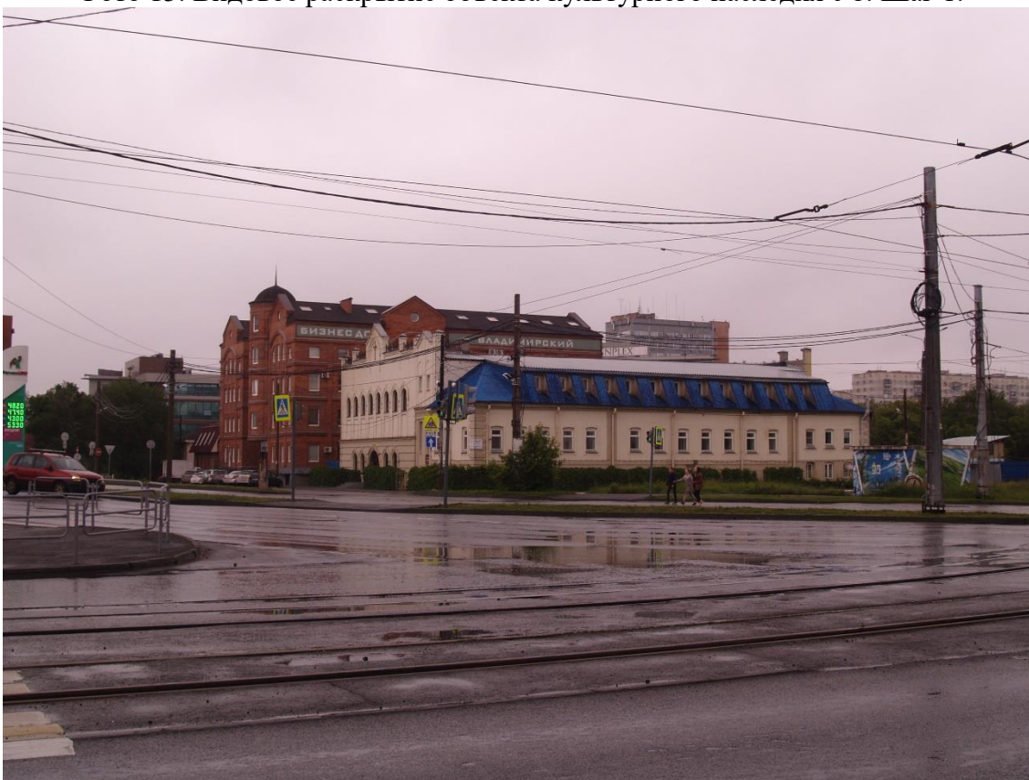
Фото 16. Градостроительная ситуация на территории исследования.
