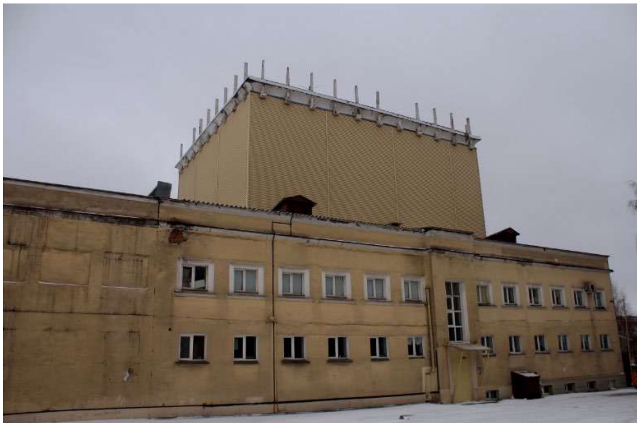
Фото 39. Выявленный объект культурного наследия «Дворец культуры и техники» по адресу: Челябинская область, г. Магнитогорск, ул. Пушкина, 19. Общий вид выявленного объекта культурного наследия.
