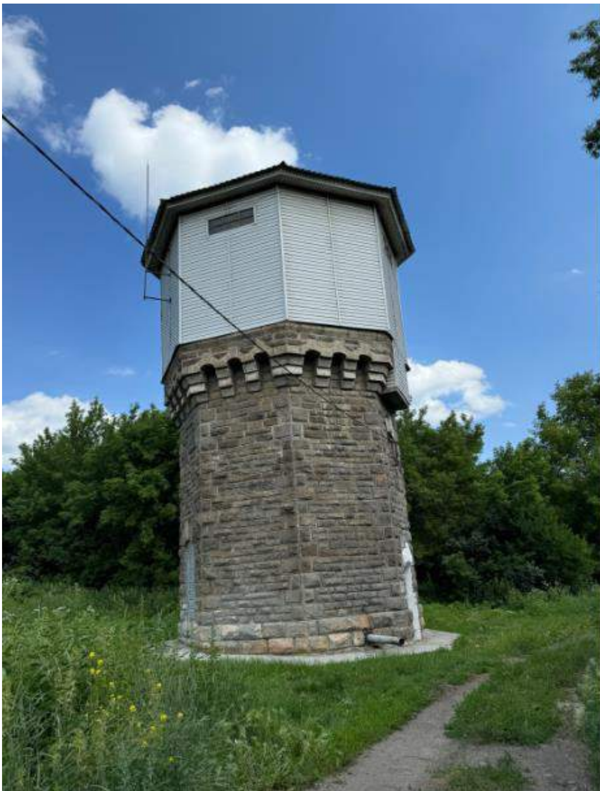
Фото 2. Вид на выявленный объект культурного наследия «Водонапорная башня-1», расположенный по адресу: Челябинская область, Миасский городской округ, г. Миасс, ж/д ст. Миасс-1.
