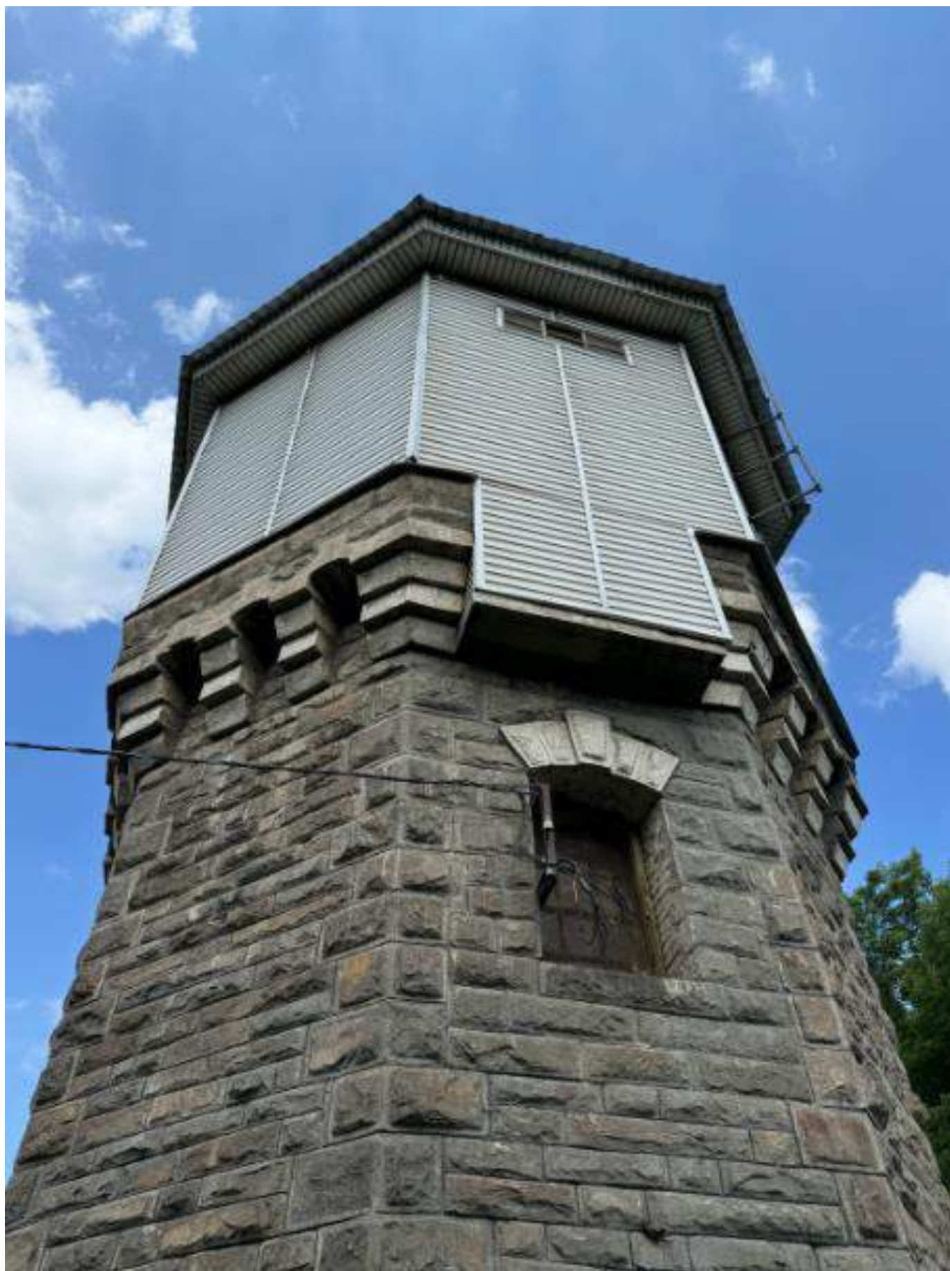
Фото 6. Вид на выявленный объект культурного наследия «Водонапорная башня-1», расположенный по адресу: Челябинская область, Миасский городской округ, г. Миасс, ж/д ст. Миасс-1.
