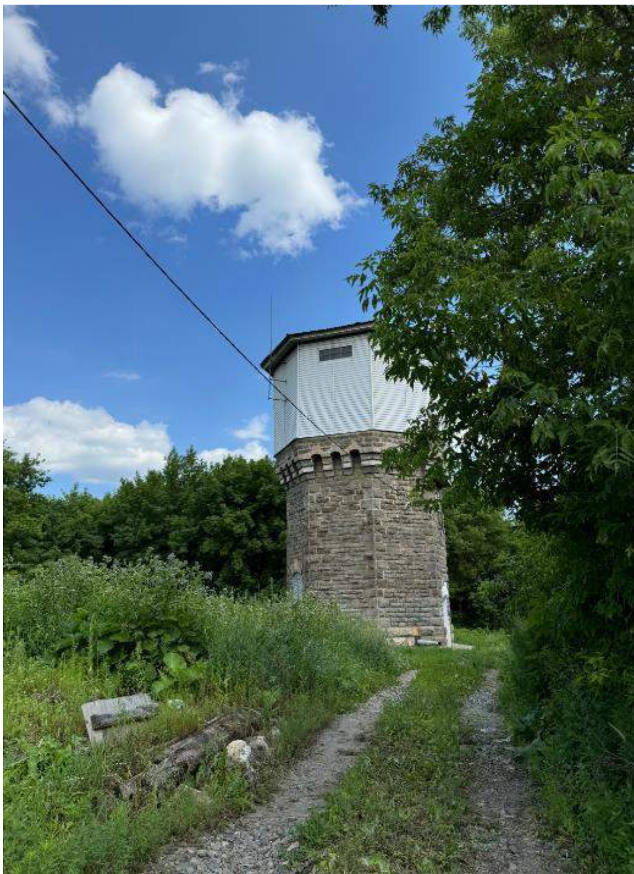
Фото 1. Вид на выявленный объект культурного наследия «Водонапорная башня-1», расположенный по адресу: Челябинская область, Миасский городской округ, г. Миасс, ж/д ст. Миасс-1.
