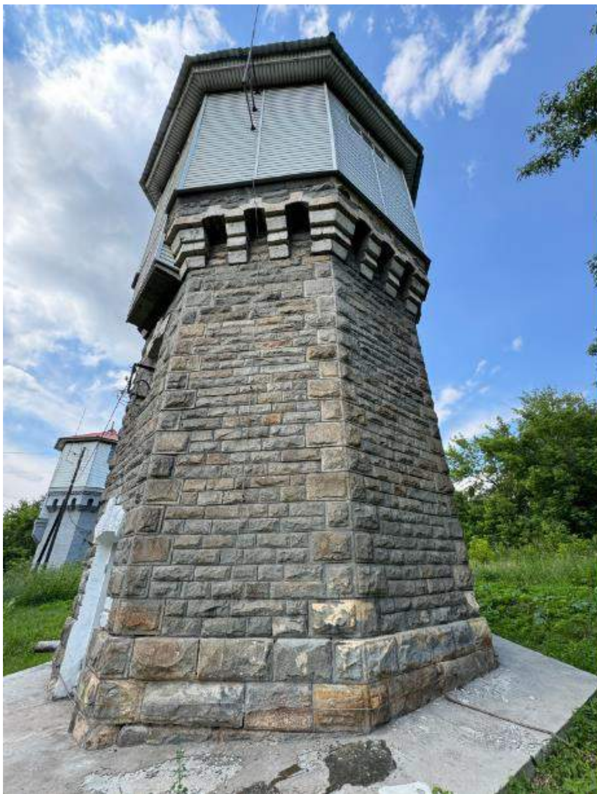
Фото 14. Вид на выявленный объект культурного наследия «Водонапорная башня-1», расположенный по адресу: Челябинская область, Миасский городской округ, г. Миасс, ж/д ст. Миасс-1.
