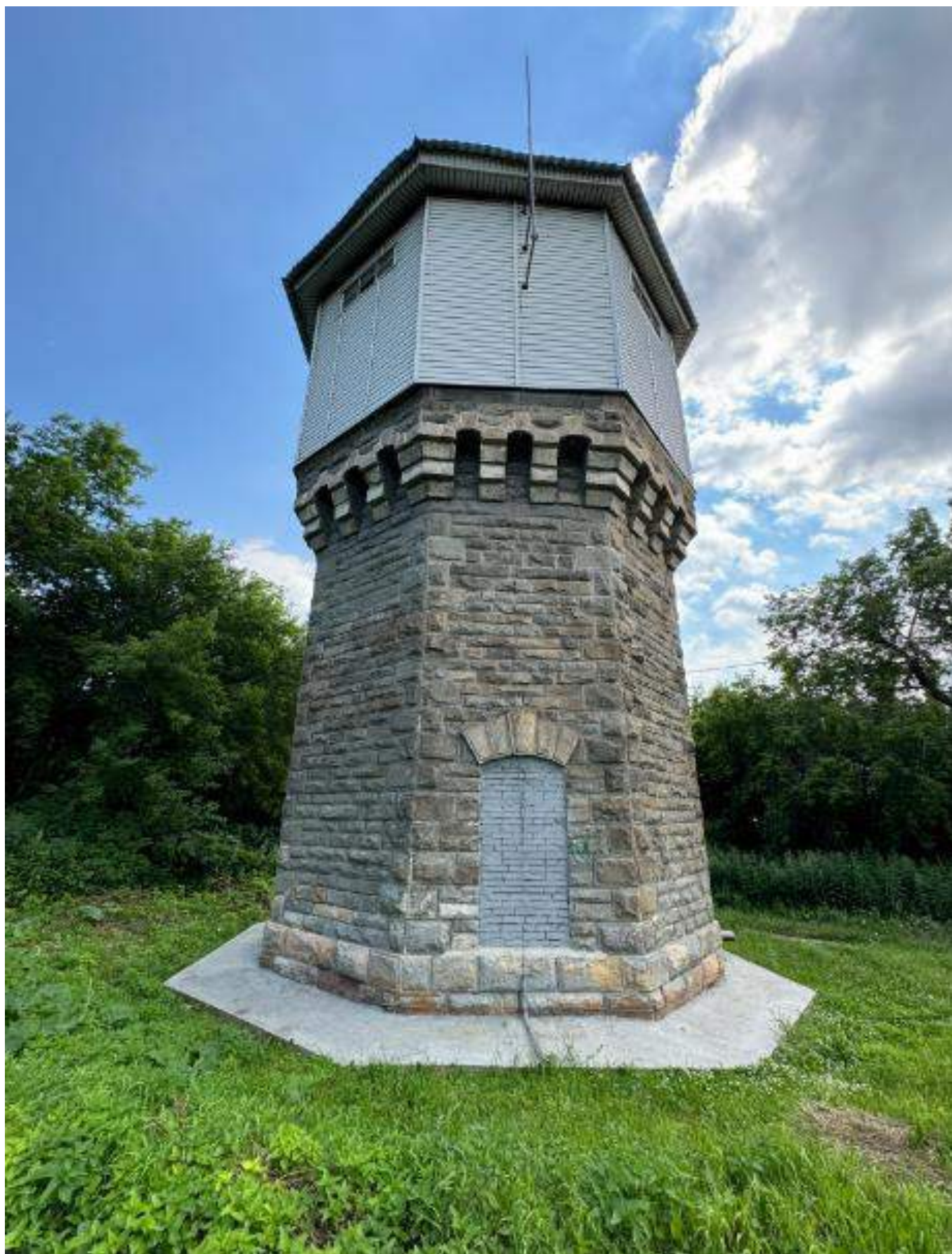
Фото 13. Вид на выявленный объект культурного наследия «Водонапорная башня-1», расположенный по адресу: Челябинская область, Миасский городской округ, г. Миасс, ж/д ст. Миасс-1.
