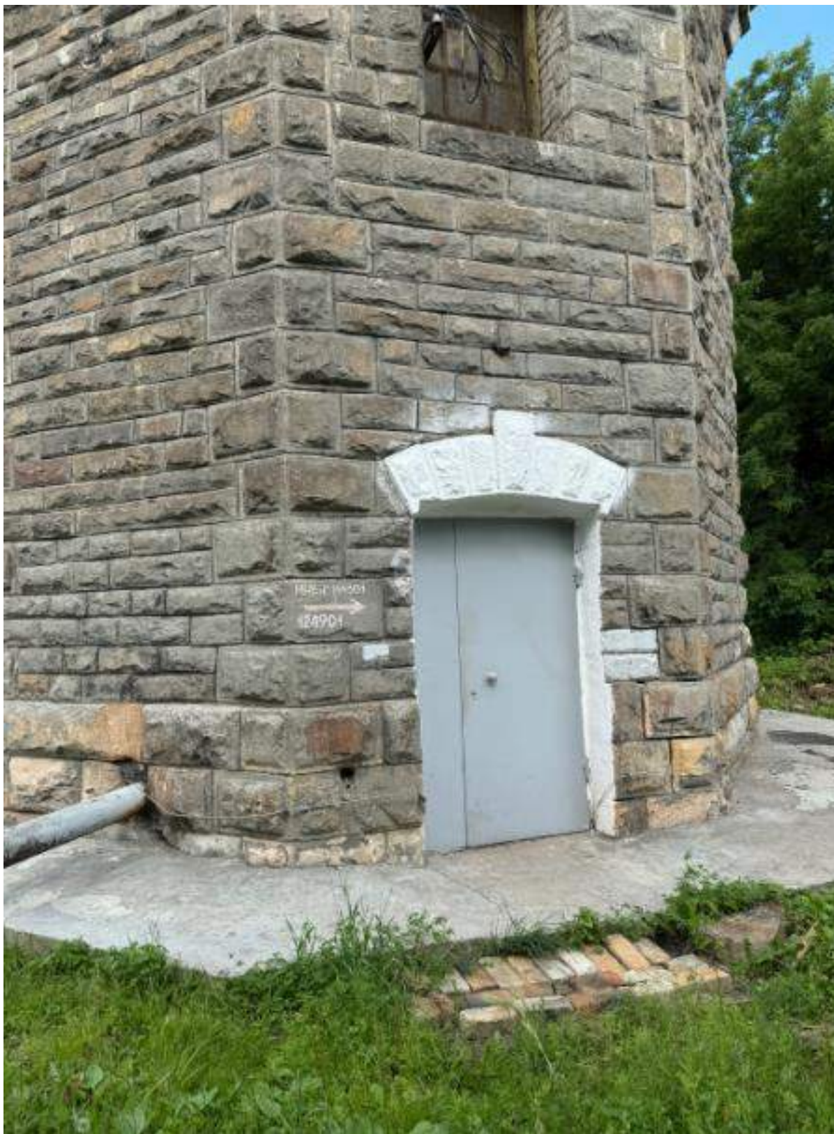
Фото 5. Вид на выявленный объект культурного наследия «Водонапорная башня-1», расположенный по адресу: Челябинская область, Миасский городской округ, г. Миасс, ж/д ст. Миасс-1.
