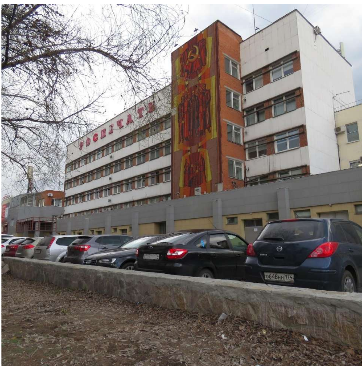
Рис. 1. Общий вид здания со стороны главного, южного фасада с
