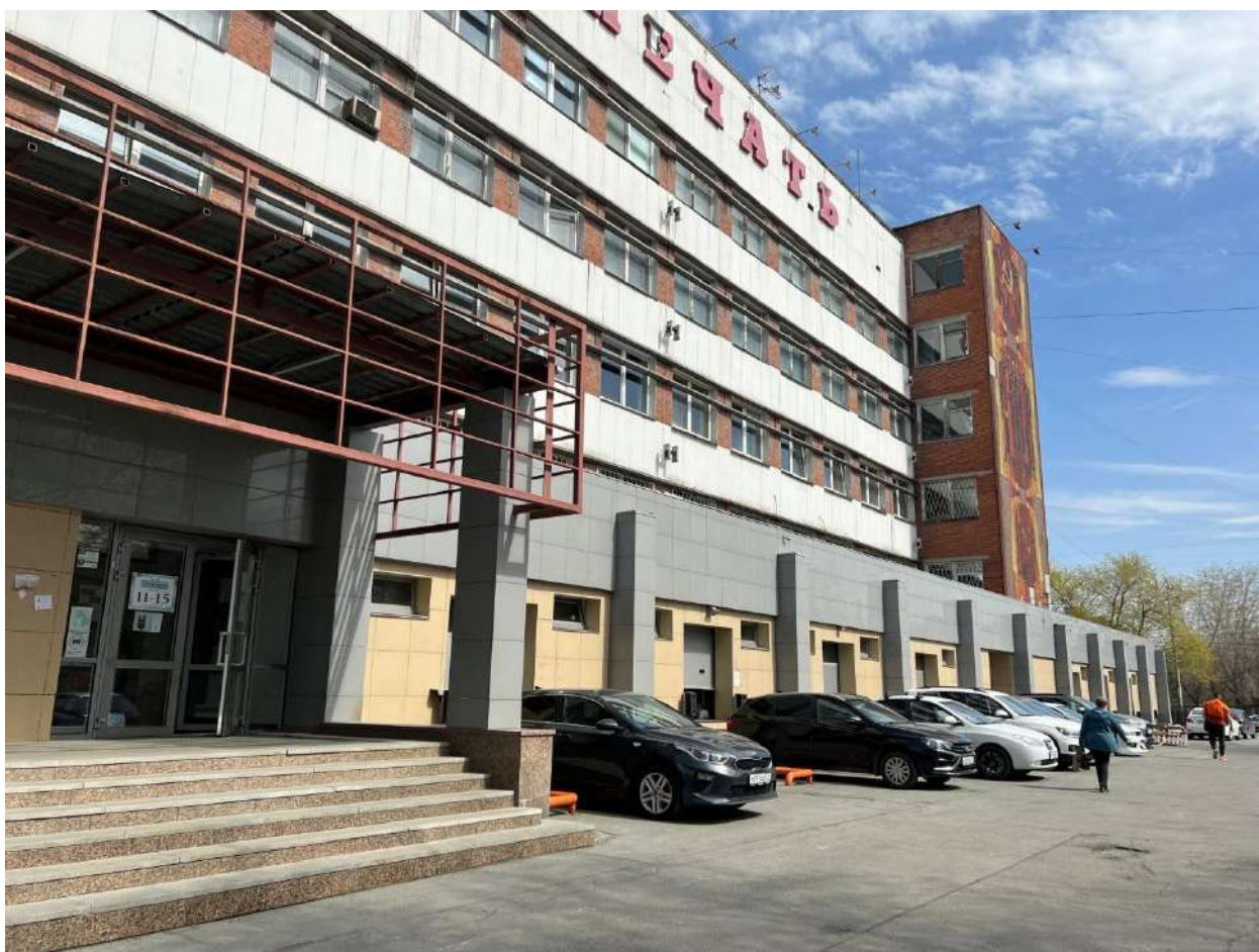
Рис. 2. Общий вид здания со стороны главного, южного фасада с лестничным объемом и мозаикой. Вид с юго-запада.
