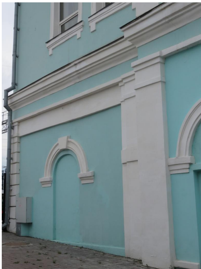
Рис. 13 а, б. Фрагмент северного фасада
