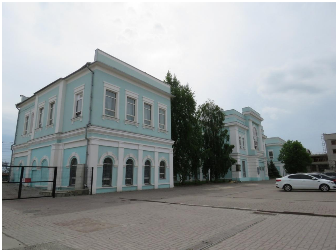
Рис. 1. Главный, западный фасад. Вид с северо-запада
