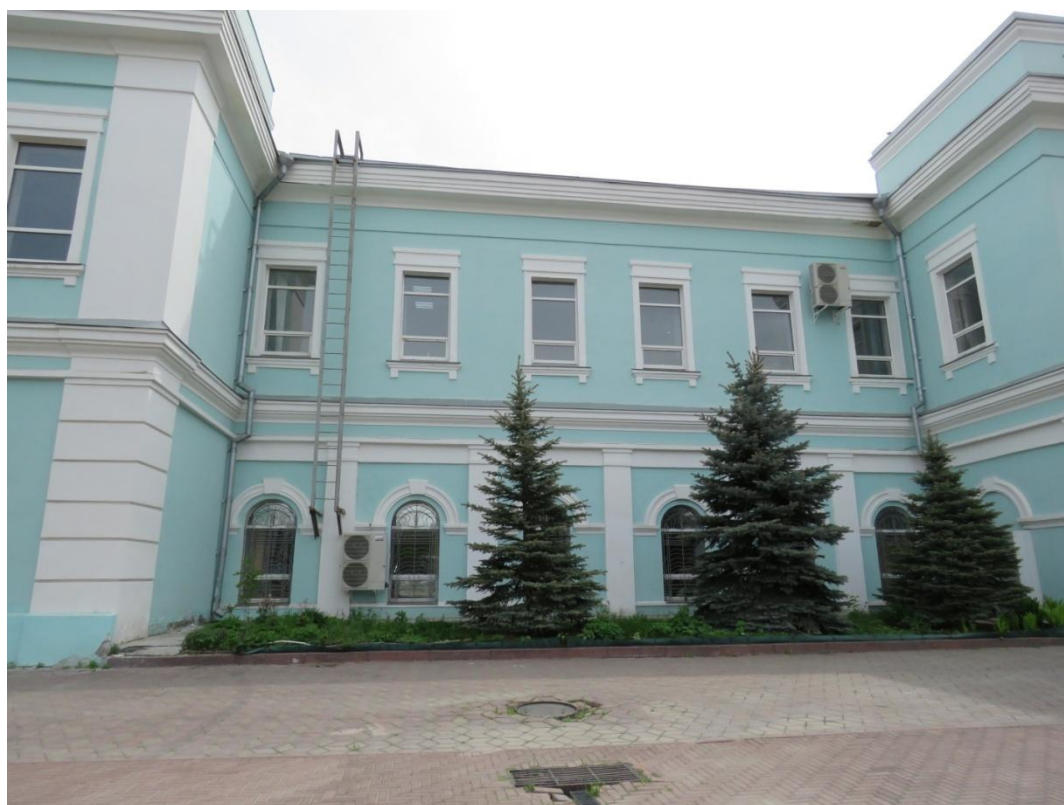
Рис. 4 а, б. Фрагменты западного фасада.
