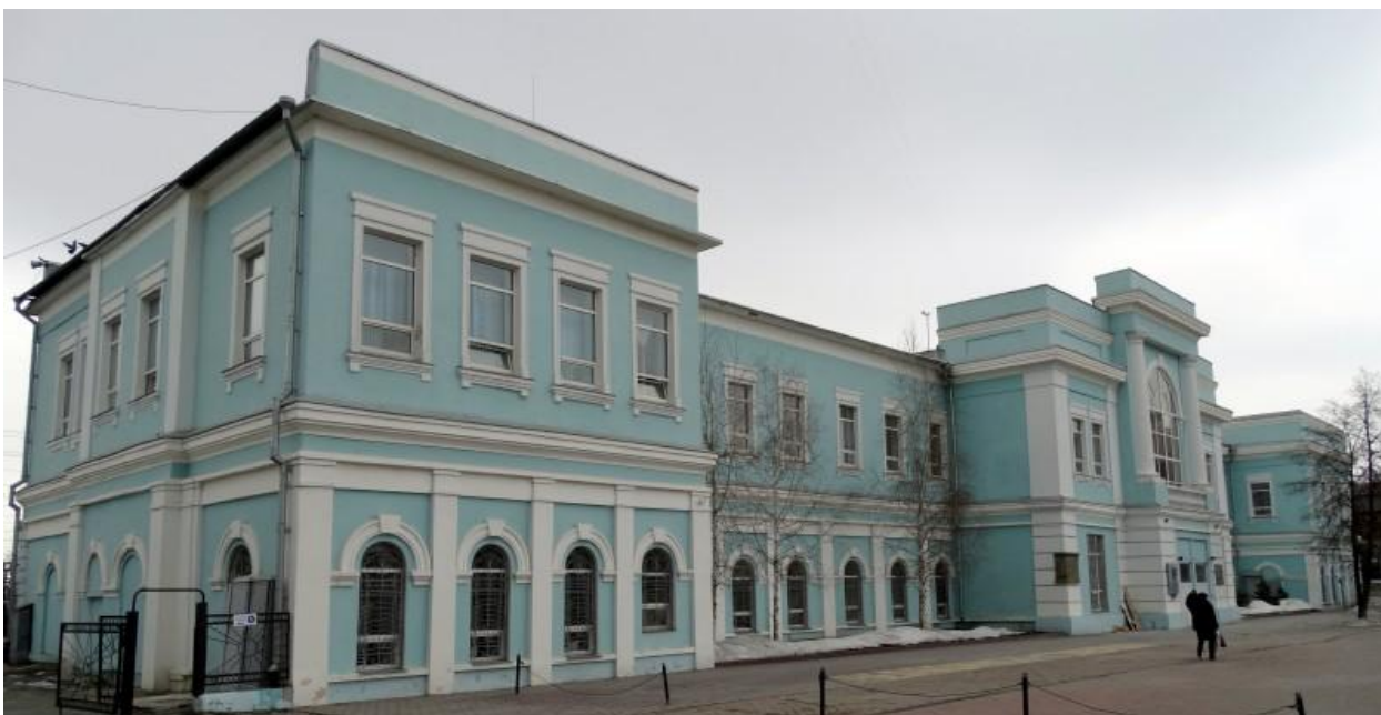
Рис. 48. Здание старого вокзала станции Челябинск. Восточный фасад. Фото Ю.В. Латышева. 2014 г. Источник: https://arhistrzh.livejournal.com/183739.html
