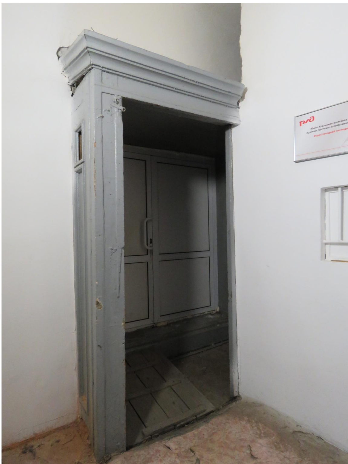
Рис. 18. Фрагмент исторического входного тамбура со стороны восточного фасада.
