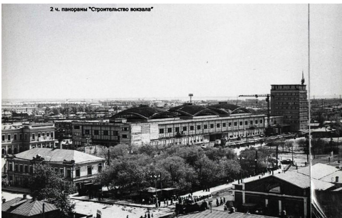
Рис. 45. Строительство нового здания вокзала. Фото 1962 г. Источник: фонды Центра историко-культурного наследия Челябинска (ЦИКНЧ)
