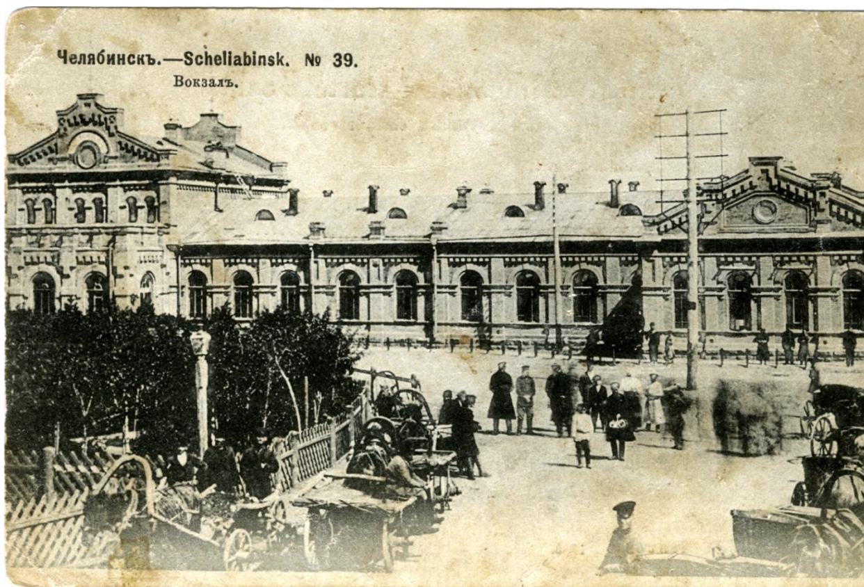
Рис. 28. Вид вокзала станции Челябинск. Фрагмент западного фасада. Открытка 1918 г. Источник: фонды Центра историко-культурного наследия Челябинска (ЦИКНЧ)
