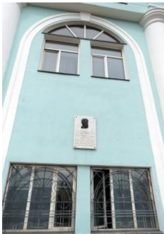
Рис. 9. Фрагмент восточного фасада. Решение оконных проемов первого и второго этажей ризалита центрального поперечного объема
