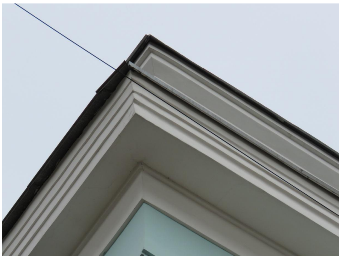
Рис. 14. Междуэтажный (вверху) и венчающий (внизу) карнизы
