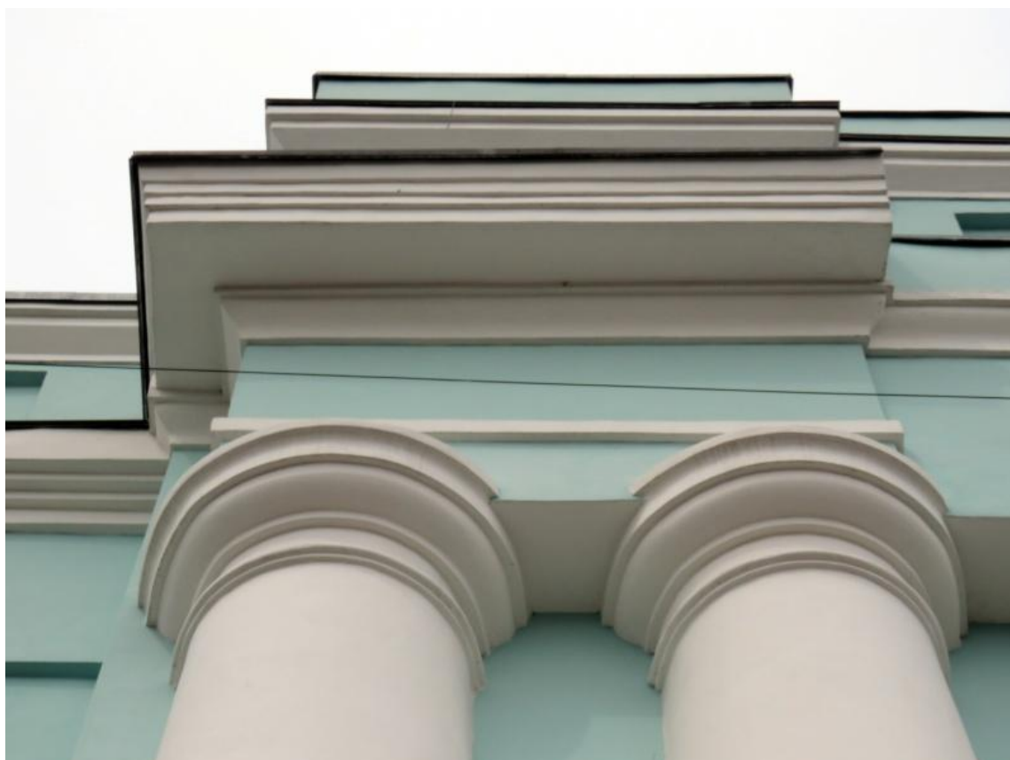
Рис. 10 а. Фрагмент восточного фасада. Решение полуколонн и карнизов ризалита центрального поперечного объема
