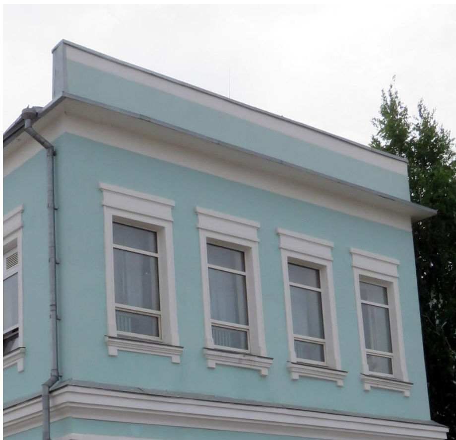
Рис. 16. Аттиковая стенка северного поперечного корпуса (исторический аттик утрачен)
