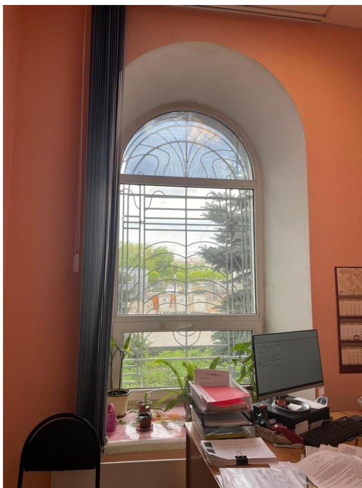
Рис. 20. Оконный проем первого этажа
