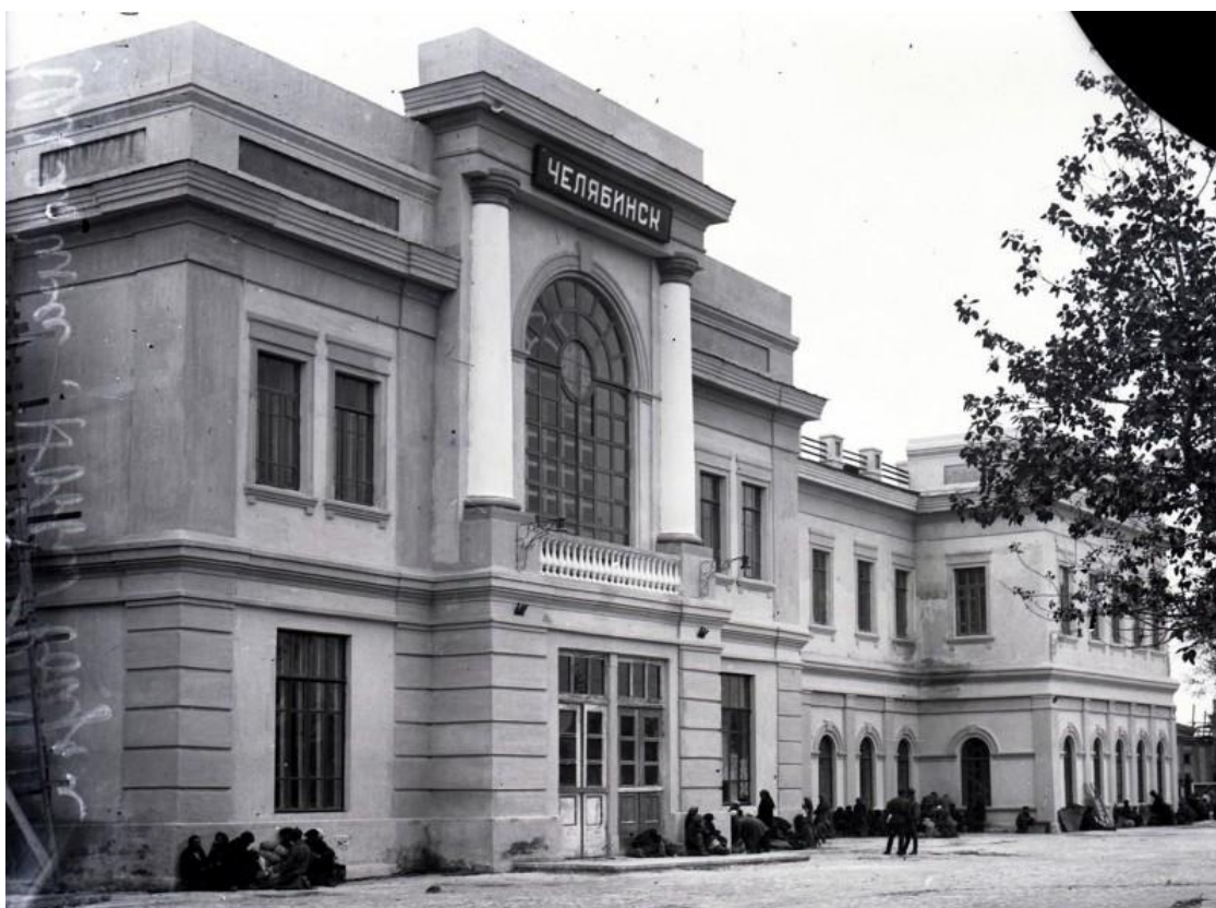
Рис. 41. Здание вокзала станции Челябинск. Фрагмент западного фасада. Источник: фонды Государственного исторического музея Южного Урала
