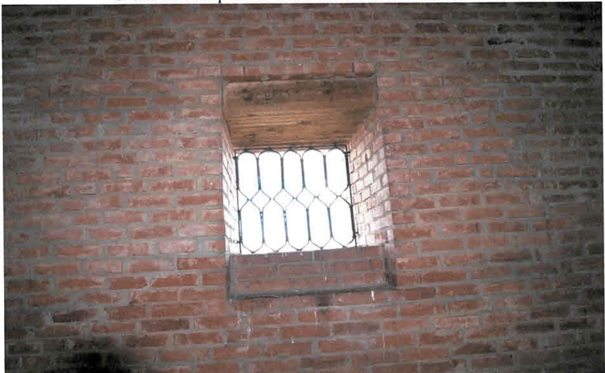
Фото 14. Вид на оконный проем с ажурной металлической решеткой
