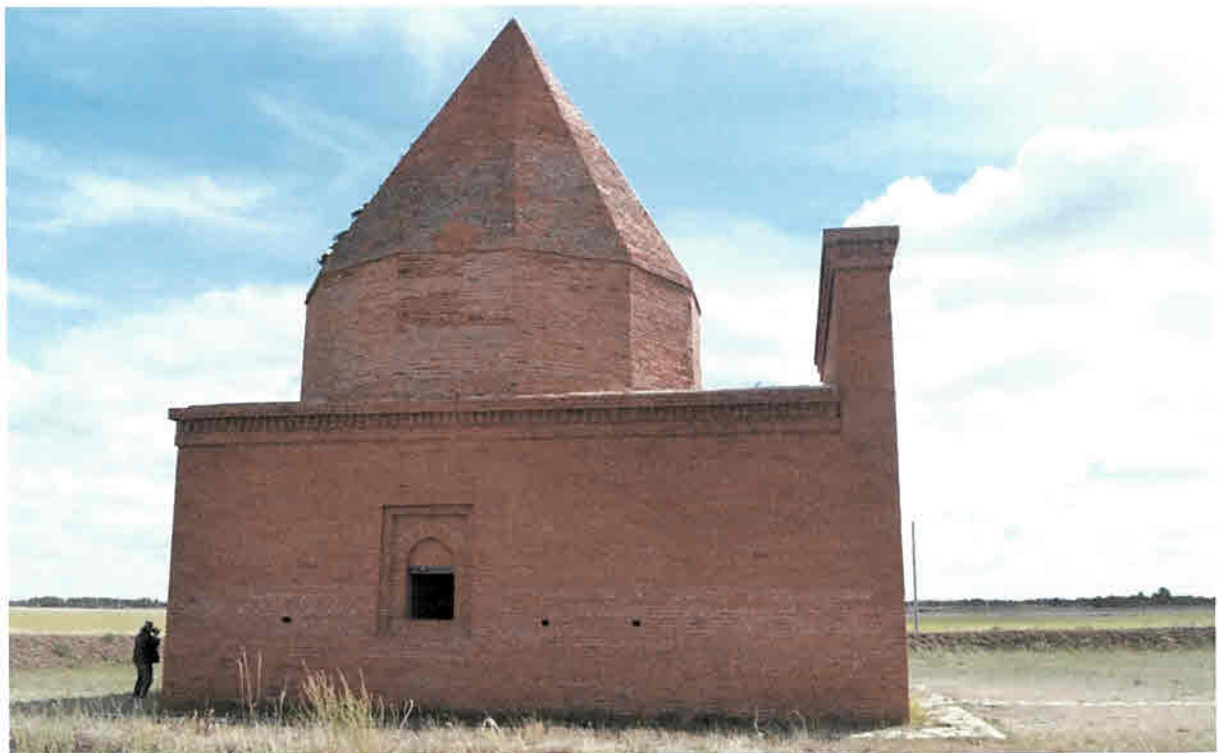
Фото 4. Западный фасад сооружения
