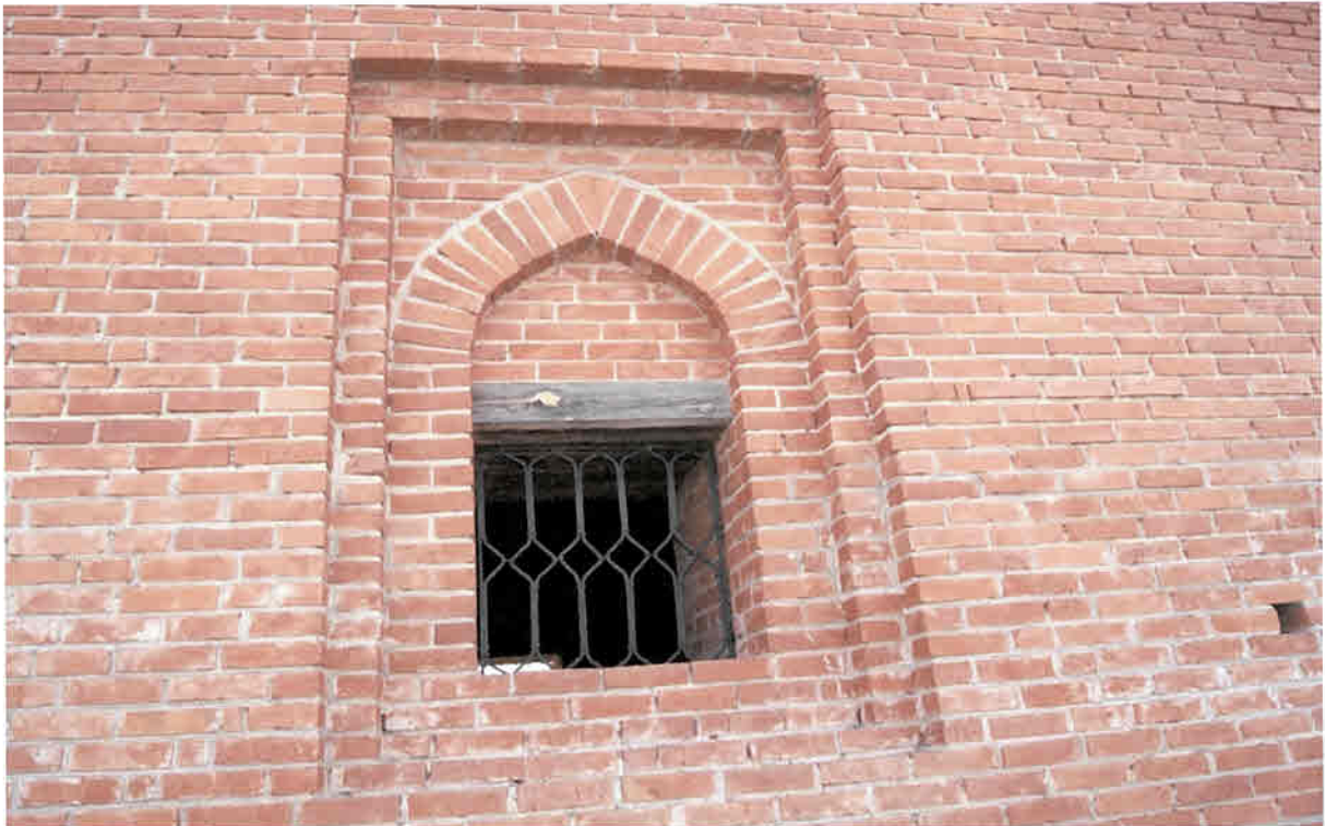
Фото 9. Вид на оконный проем с ажурной металлической решеткой на восточном фасаде сооружения
