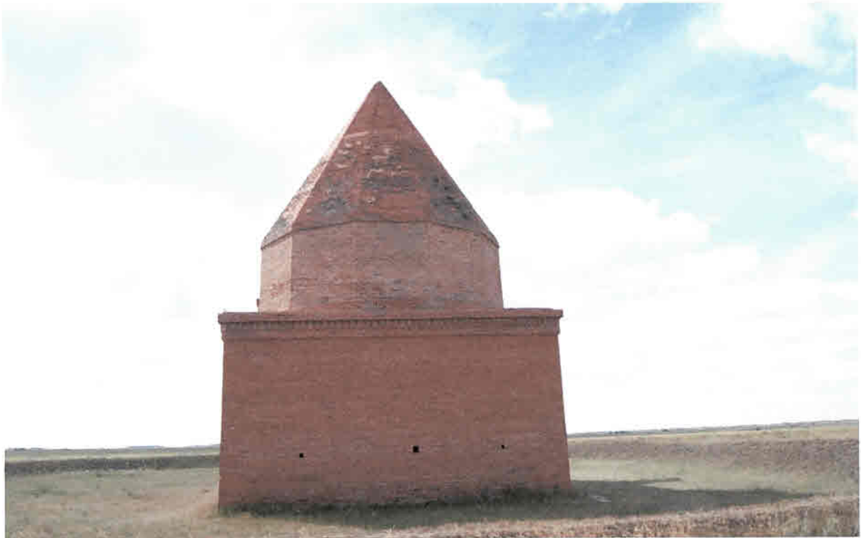
Фото 3. Северный фасад сооружения
