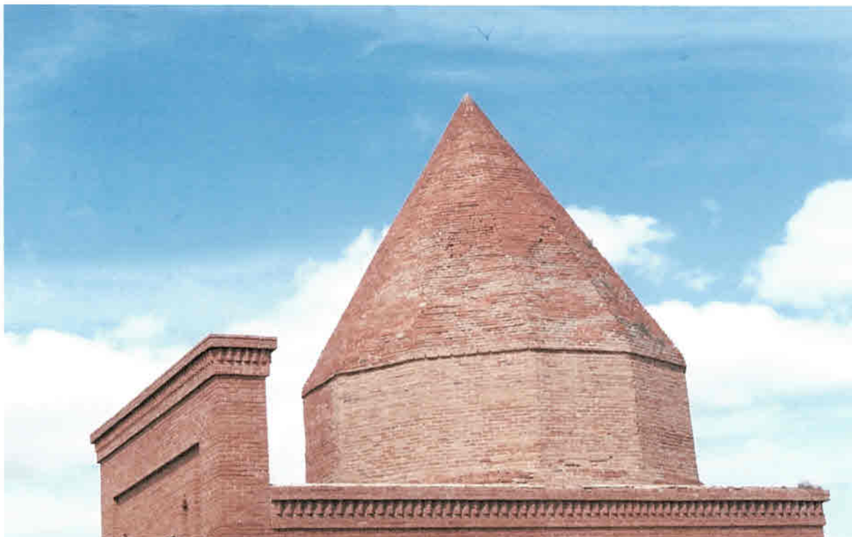
Фото 5. Вид на 12-гранный купол на 12-гранном барабане с восточной стороны
