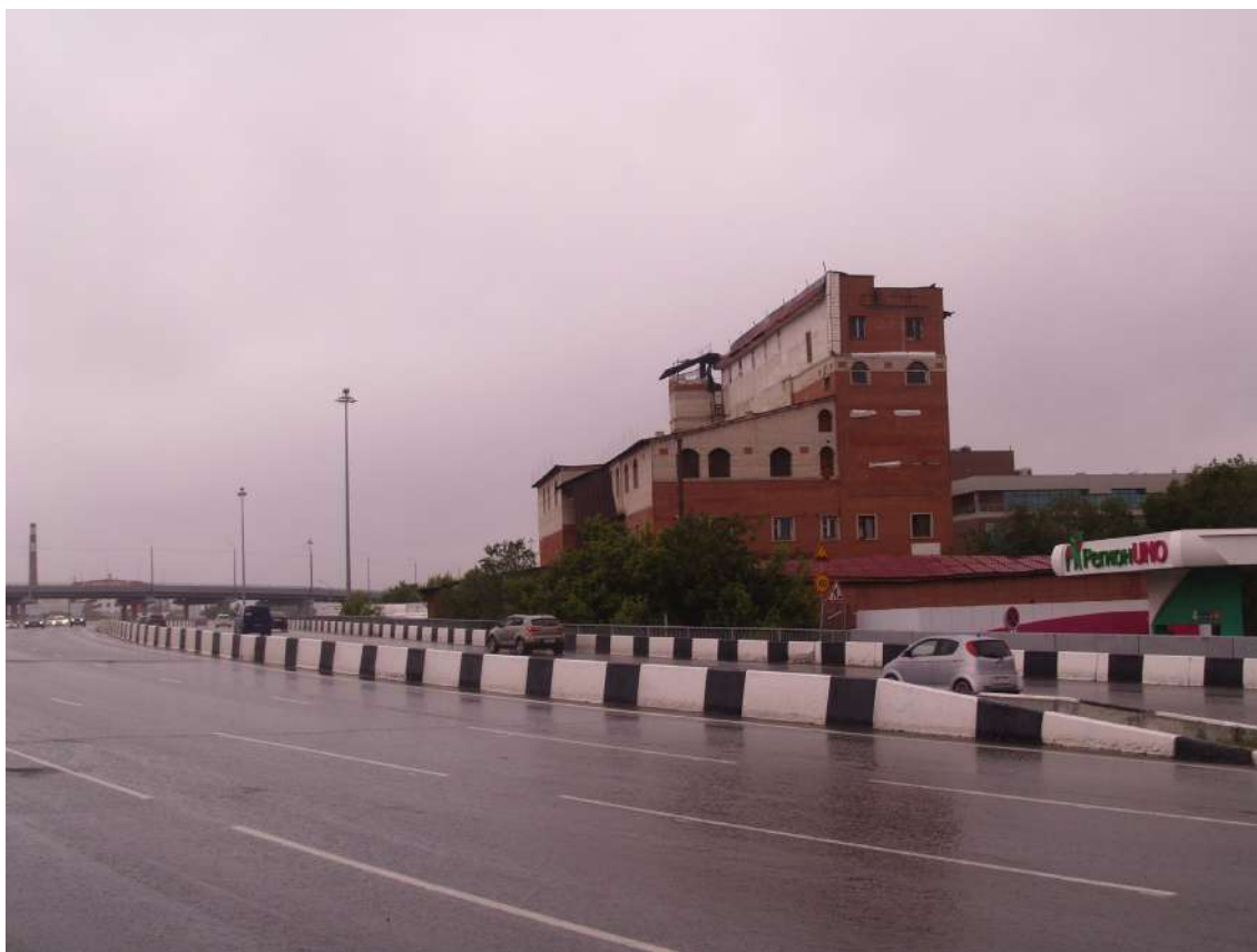
Фото 22. Градостроительная ситуация на территории исследования.
