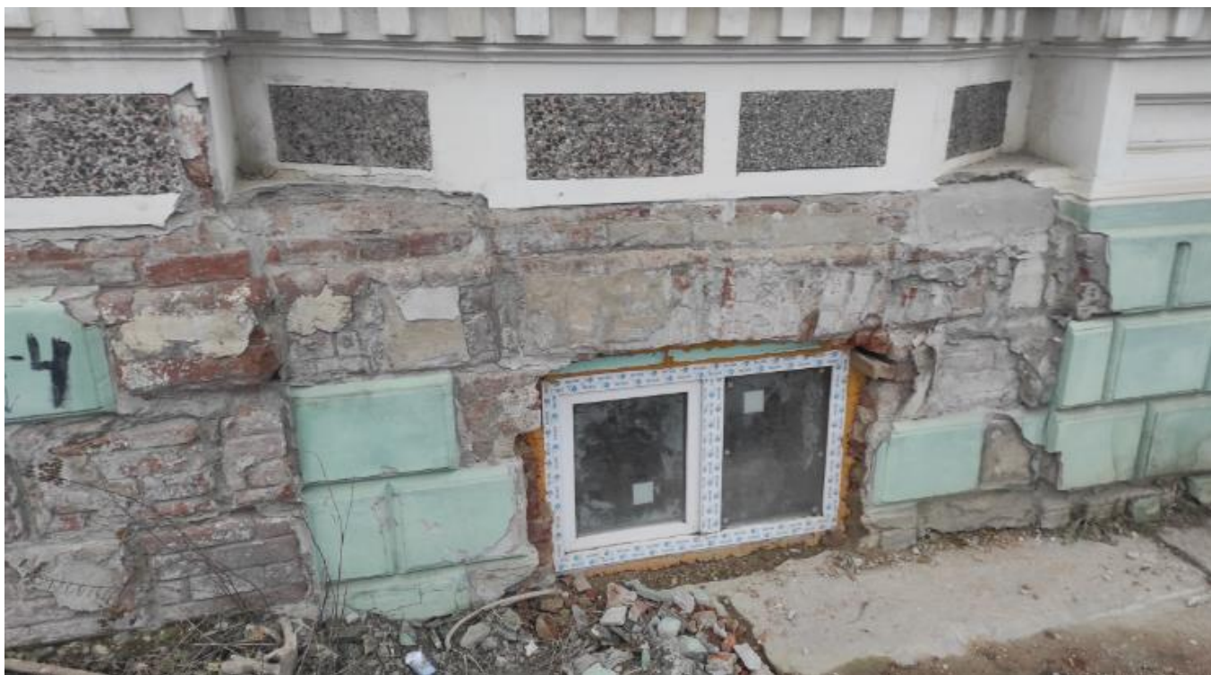
Фото 12. Вид на выявленный объект культурного наследия «Комплекс зданий Кузнецова-Бакакина», расположенный по адресу: Челябинская область, Миасский городской округ, г. Миасс, ул. Ленина, 12.
