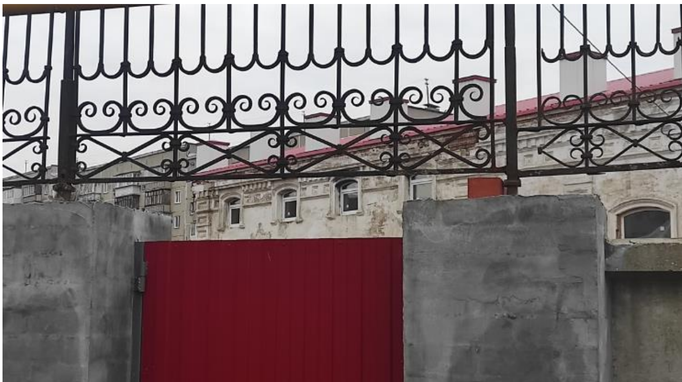
Фото 14. Вид на выявленный объект культурного наследия «Комплекс зданий Кузнецова-Бакакина», расположенный по адресу: Челябинская область, Миасский городской округ, г. Миасс, ул. Ленина, 12.
