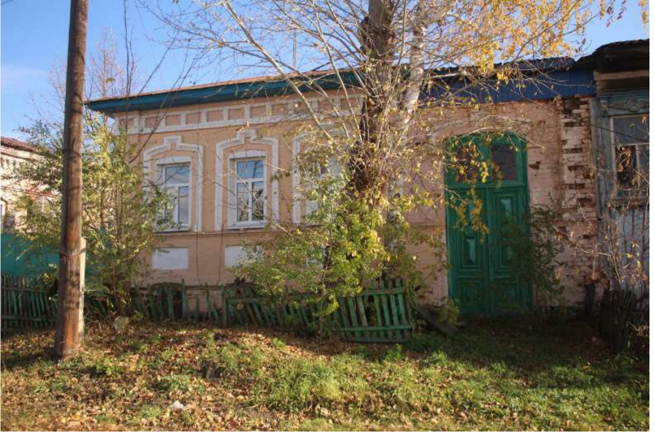
Фото 5. Выявленный объект культурного наследия «Дом Мансурова» по адресу: Челябинская обл., г. Верхнеуральск, ул. Мира, 50. Северный фасад выявленного объекта культурного наследия.
