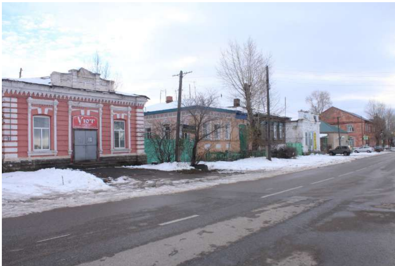
Фото 8. Выявленный объект культурного наследия «Дом Мансурова» по адресу: Челябинская обл., г. Верхнеуральск, ул. Мира, 50. Общий вид выявленного объекта культурного наследия.
