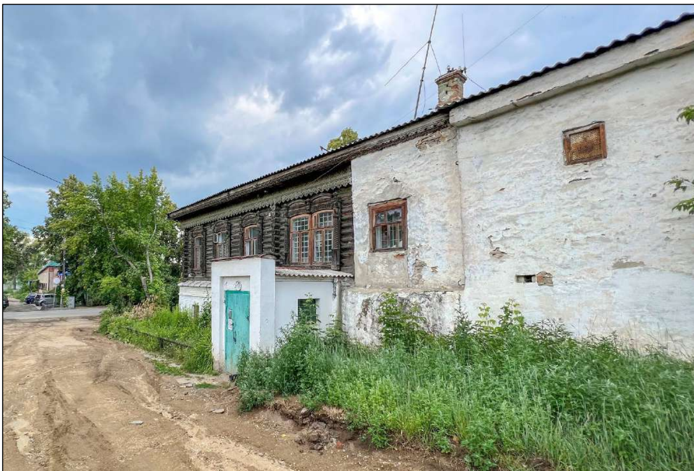
10. Фрагмент фасада Объекта.
