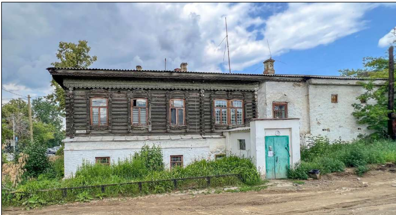
9. Общий вид фасада Объекта.
