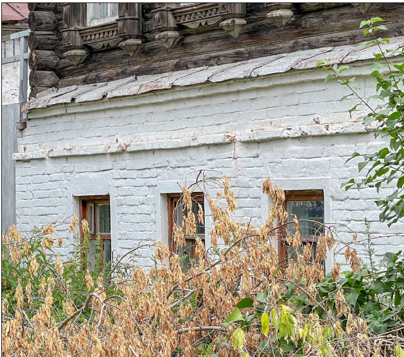
4. Фрагменты декоративного убранства фасада Объекта.
