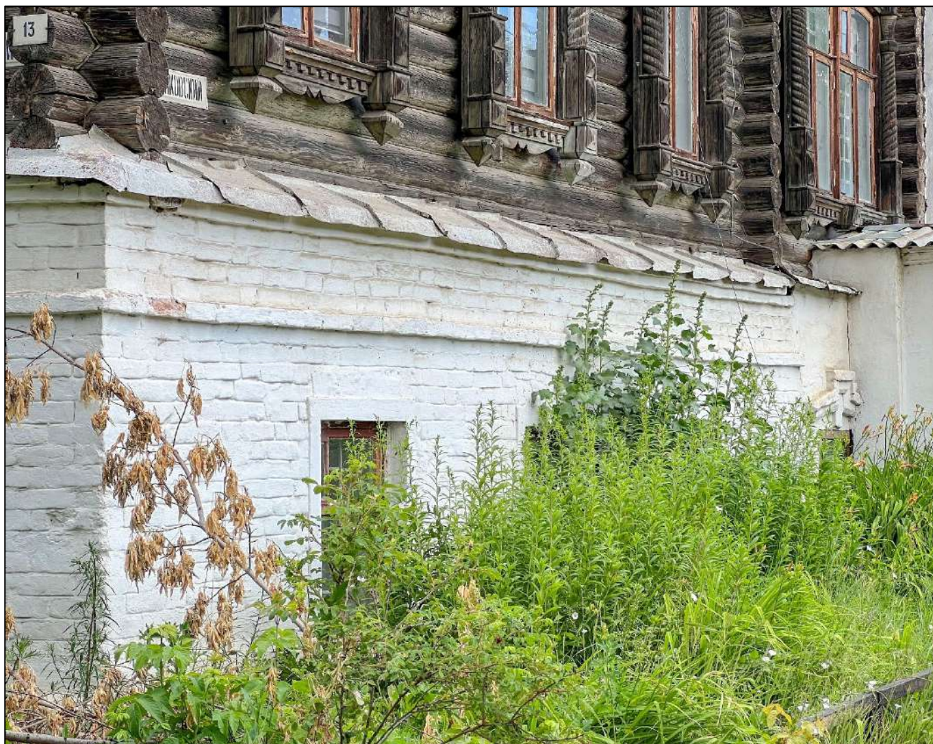
5. Фрагменты декоративного убранства фасада Объекта.
