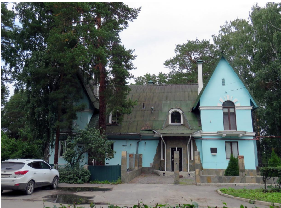
Рис. 1. Главный, юго-западный фасад
