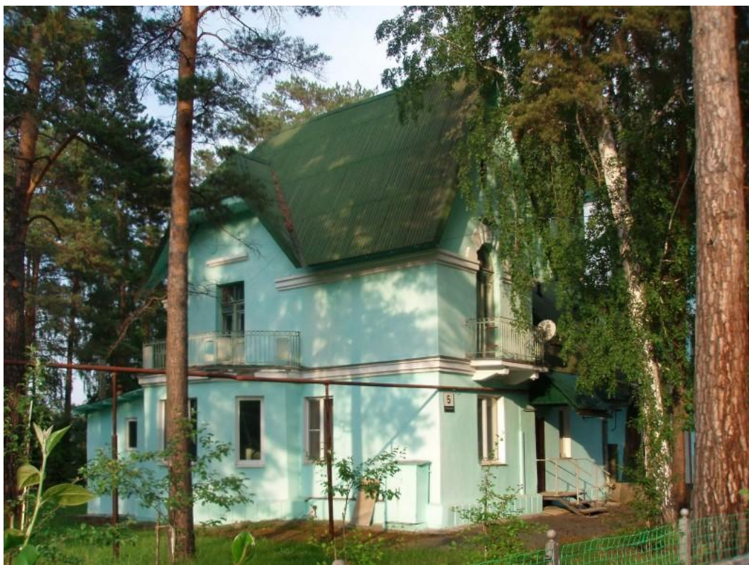
Рис. 6. Боковой, северо-западный фасад
