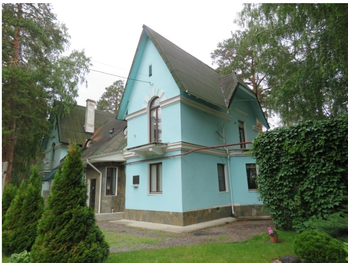
Рис. 2. Главный, юго-западный, фасад. Вид с юга.
