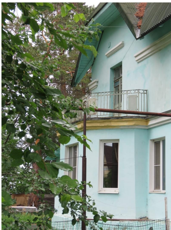
Рис. 7. Фрагмент бокового, северо-западного фасада.
