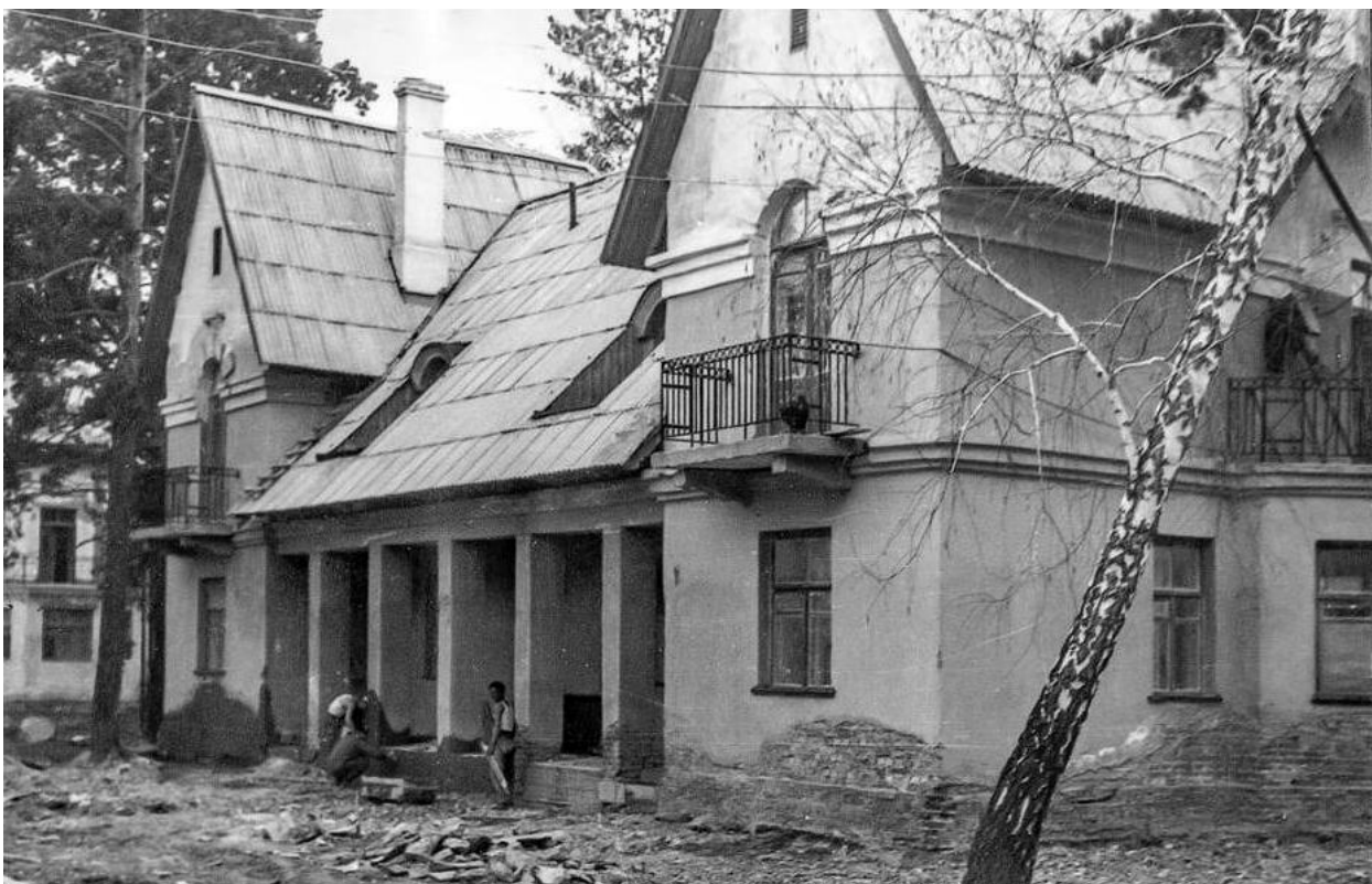
Рис. 19. Строительство коттеджей на ул. Гречишникова в Снежинске. 1963. Источник: Фотоальбом (№ 2) о строительстве города. 1959 – 1967.
