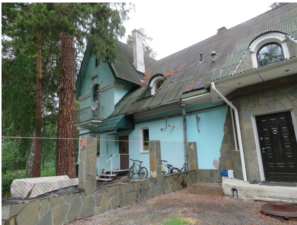
Рис. 4. Главный, юго-западный, фасад. Фрагмент
