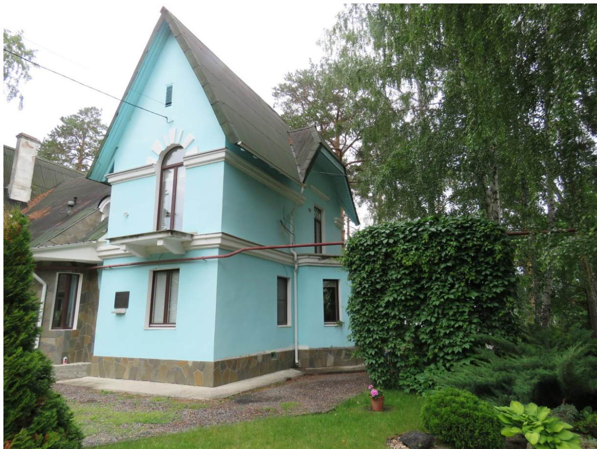
Рис. 8. Боковой, юго-восточный фасад
