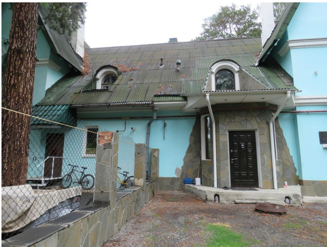
Рис. 3. Главный, юго-западный, фасад. Фрагмент
