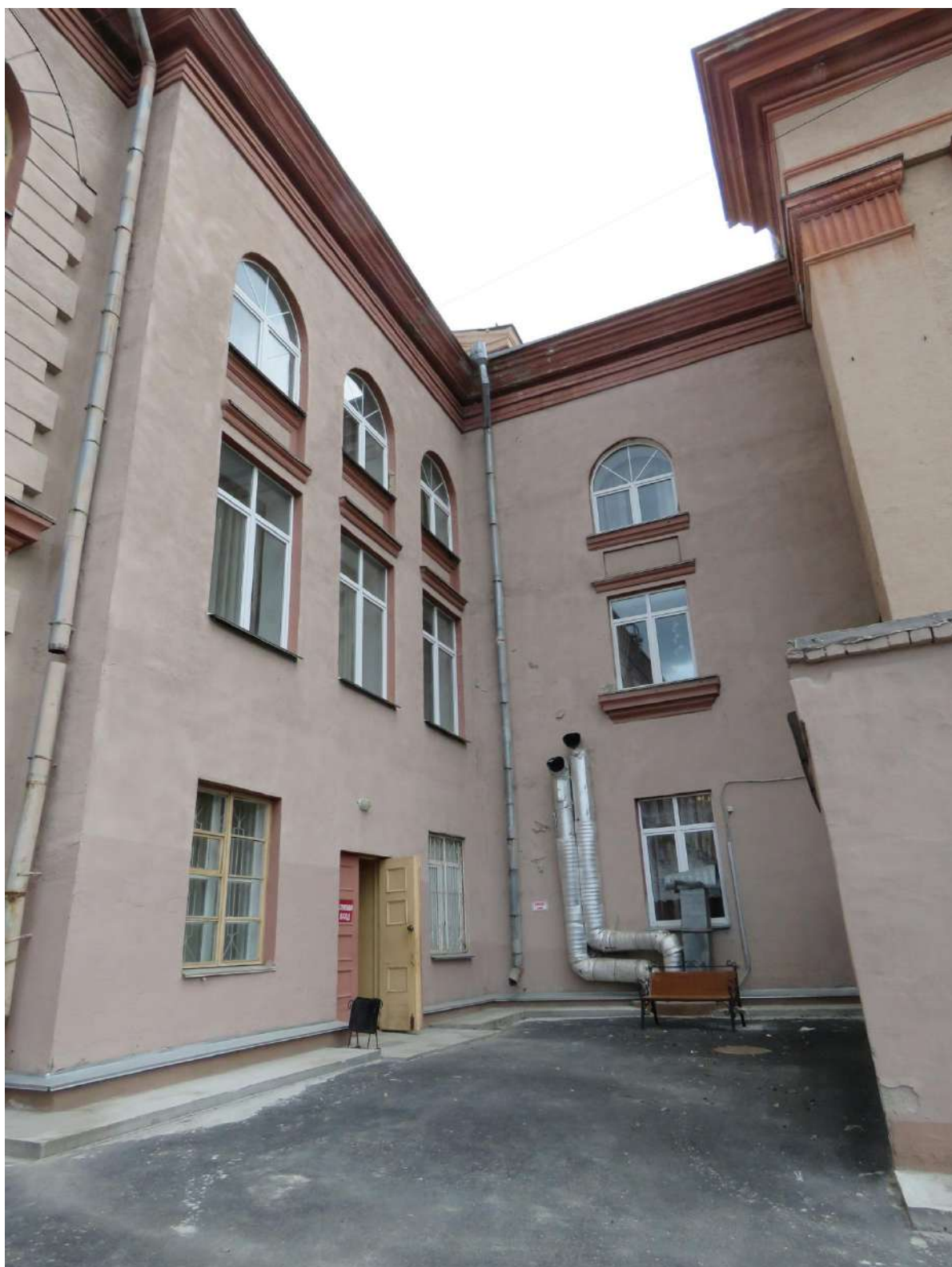
Рис. 28. Боковой, северный фасад основного корпуса (западный объем) и дворовый, восточный фасад объема перехода от основного корпуса к северному боковому крылу
