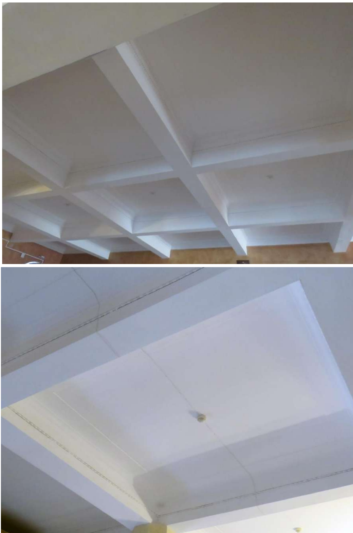
Рис. 35 а, б. Входной вестибюль главного входа. Кессонированный потолок
