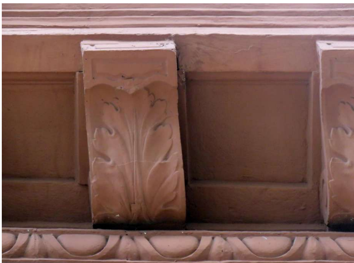
Рис. 3. Портик главного фасада. Фрагмент карниза фронтона
