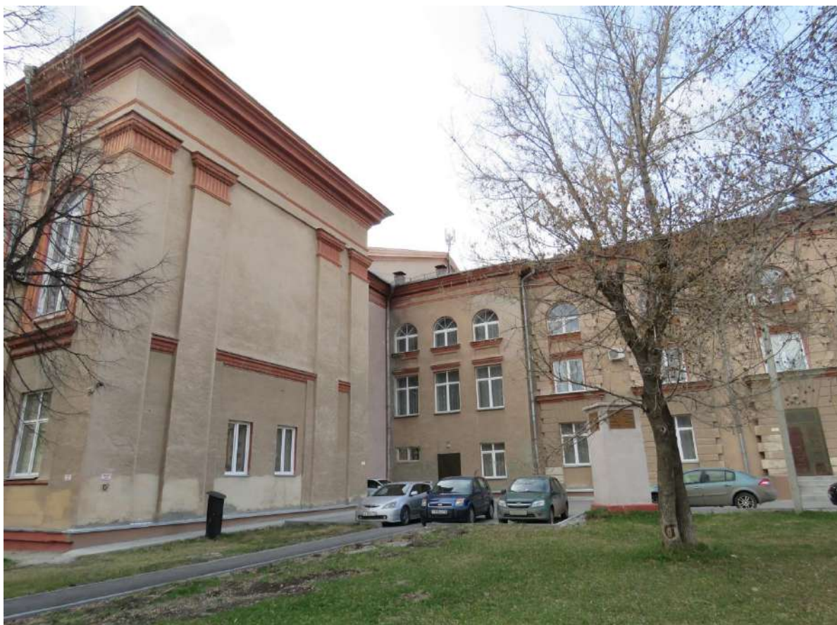
Рис. 15 а. Дворовый (восточный) фасад южного крыла
