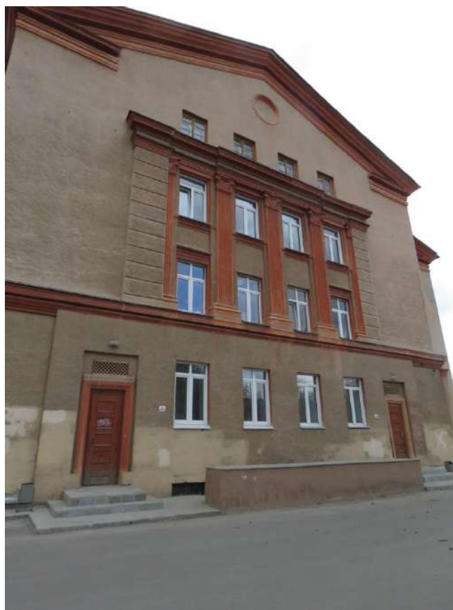
Рис. 22 а. Дворовый, восточный фасад восточного объема основного корпуса.
