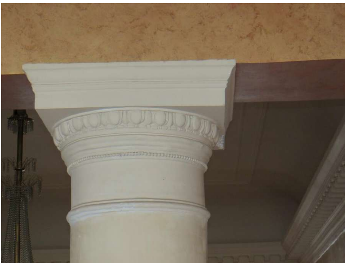
Рис. 41 а, б. Фрагменты северной парадной лестницы из фойе первого этажа в фойе второго этажа
