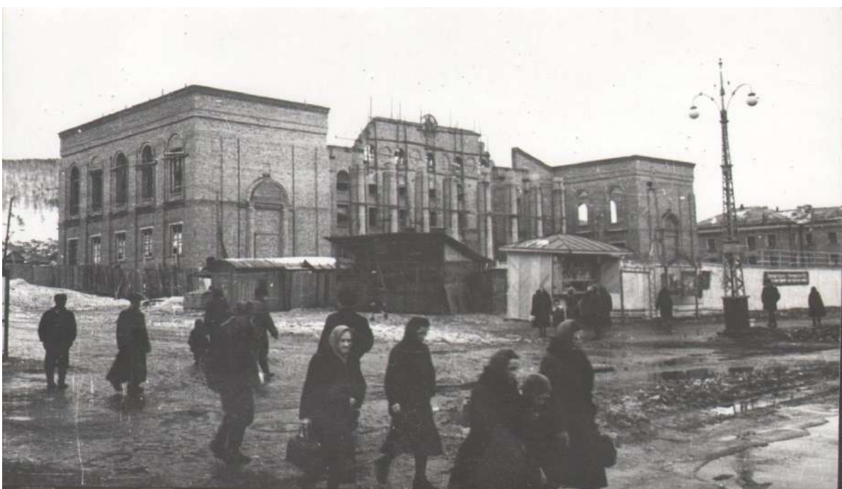
Рис. 16. Строительство Дворца культуры автомобилестроителей. Фото 1959 г. Архив Музея истории ОАО «Автомобильный завод «Урал»
