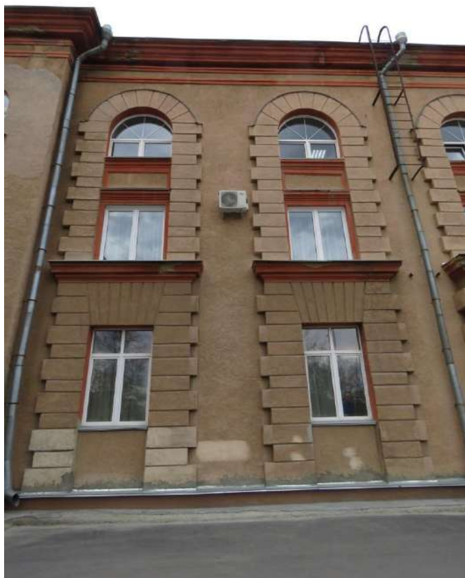
Рис. 19а. Боковой, южный фасад основного корпуса. Оформление оконных проемов
