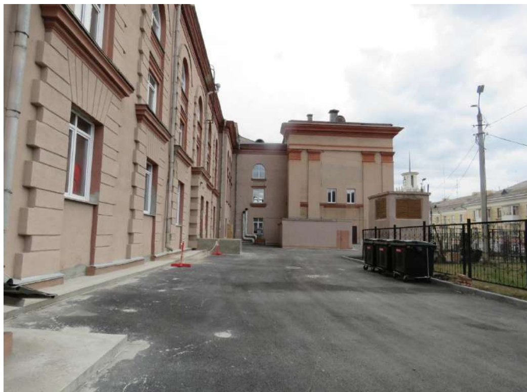
Рис. 29. Боковой, северный фасад основного корпуса и дворовые (восточные) фасады объема перехода от основного корпуса к северному боковому крылу и северного бокового крыла
