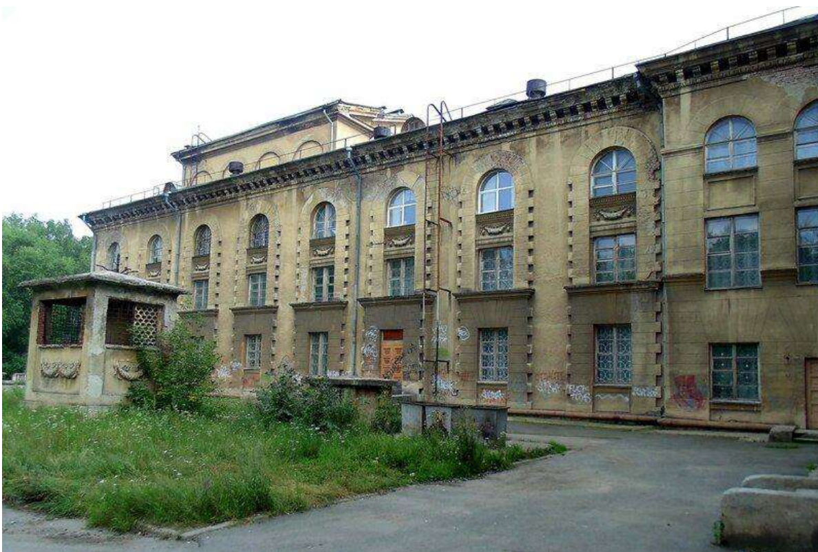
Рис. 21 а, б. Дворец культуры ОАО Челябинского металлургического комбината. 1957
