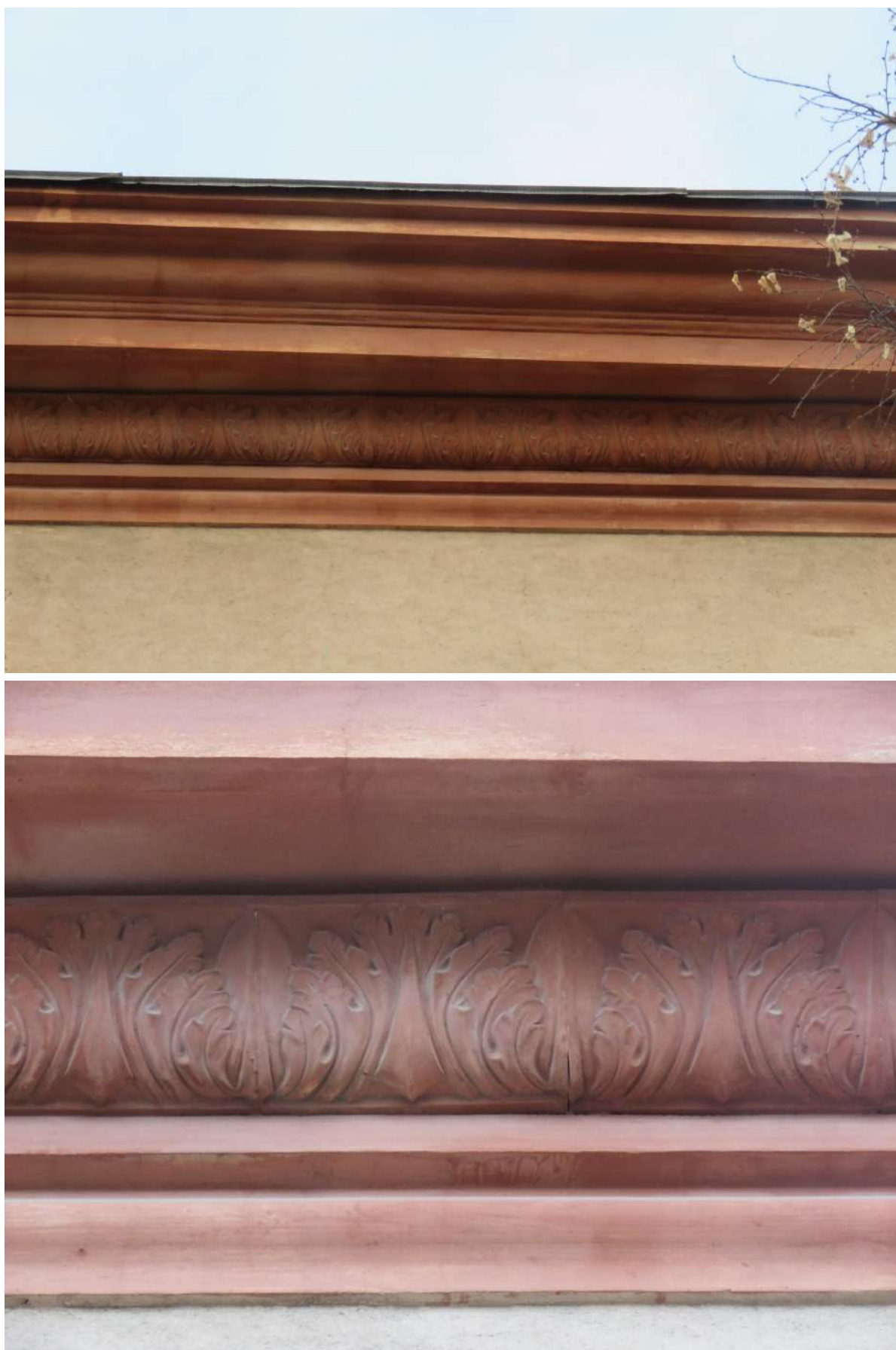
Рис. 20 а, б. Боковой, южный фасад основного корпуса. Оформление карниза
