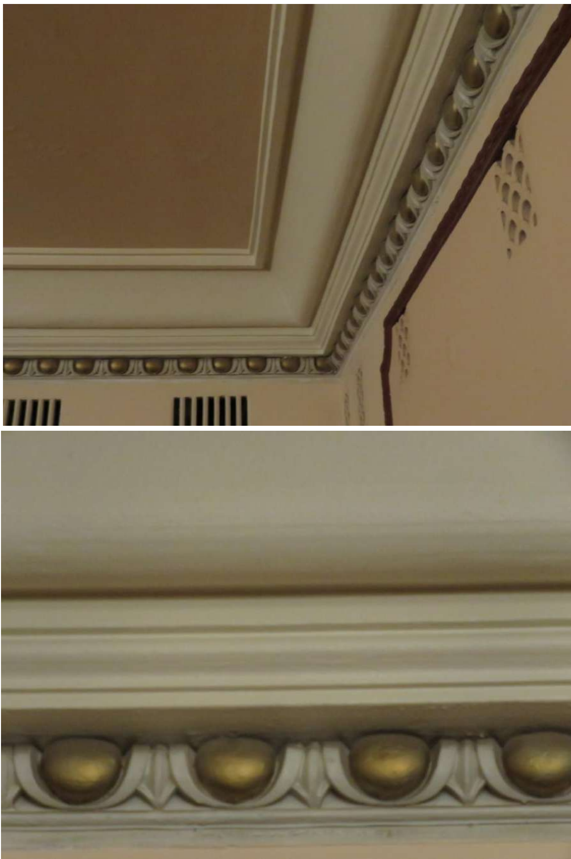
Рис. 58 а, б. Оформление карниза стен зрительного зала
