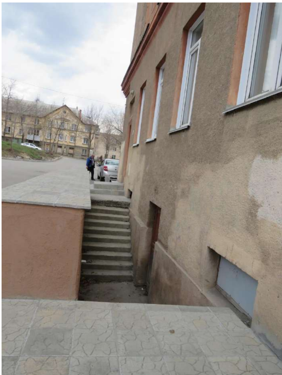
Рис. 24. Дворовый, восточный фасад. Спуск и вход в подвальный этаж
