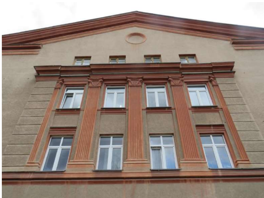
Рис. 22 б. Дворовый, восточный фасад восточного объема основного корпуса. Решение центральной части
