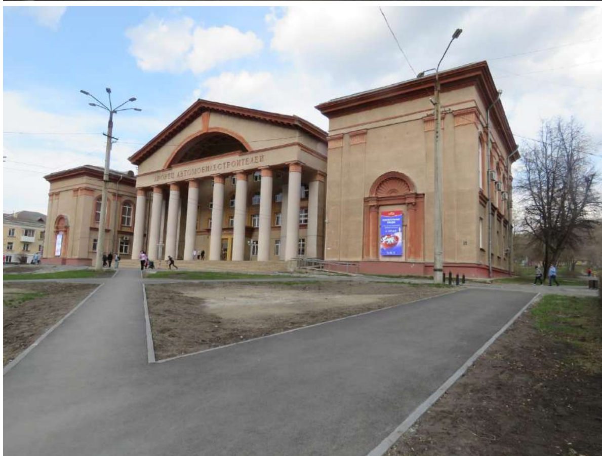
Рис. 1 а, б. Главный фасад. Вид с северо-запада (вверху) и юго-запада (внизу)
