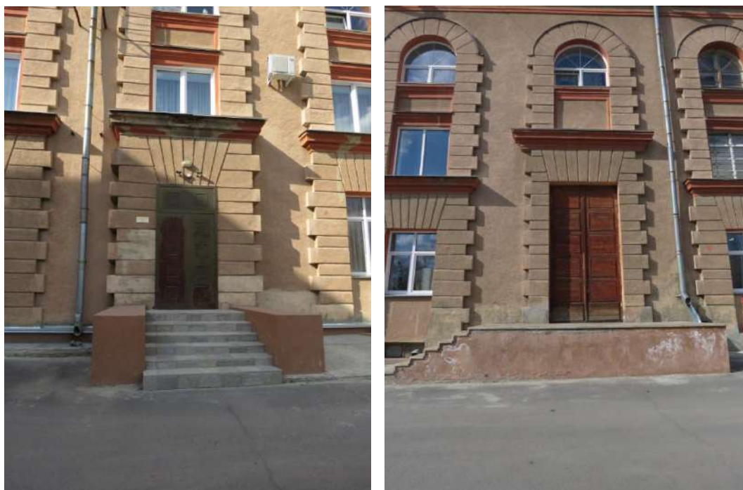
Рис. 19 б, в. Боковой, южный фасад основного корпуса. Оформление проема запасного выхода из южного кулуара (слева) и служебного выхода сцены, в т.ч. для погрузки/разгрузки декораций (справа)
