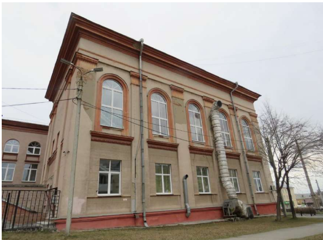
Рис. 31. Боковой, северный фасад северного крыла
