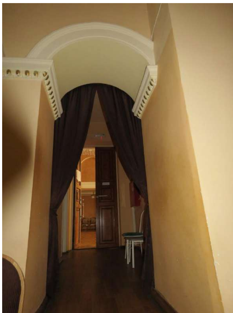
Рис. 49 а, б. Вход в амфитеатр зрительного зала из фойе второго этажа и аркада центральной ложи
