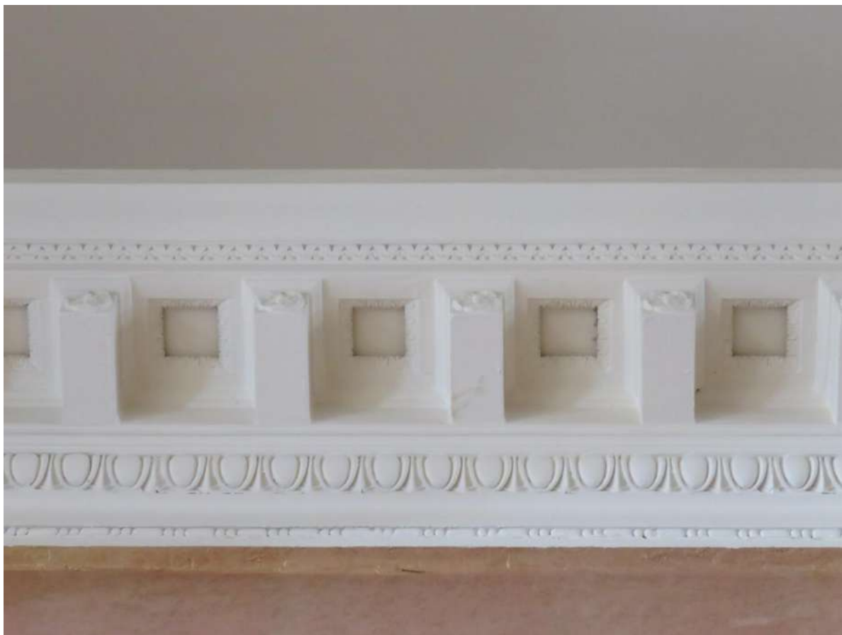
Рис. 44 а, б. Фойе второго этажа. Капитель пилястры. Карниз пяты свода
