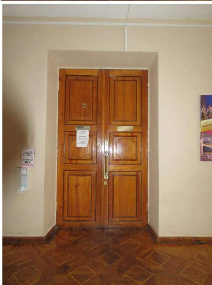
Рис. 62 а, б. Входы в зрительный зал из боковых кулуаров первого этажа
