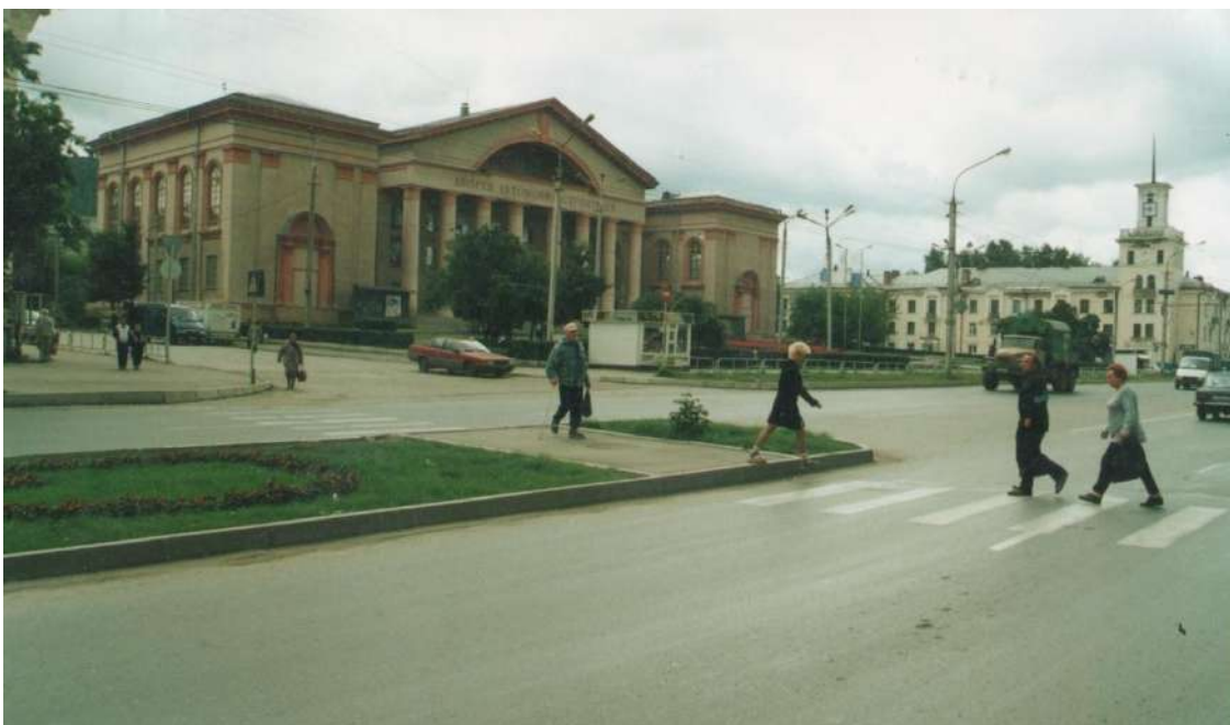
Рис. 19. Дворец культуры автомобилестроителей. Фото 1986 г.
