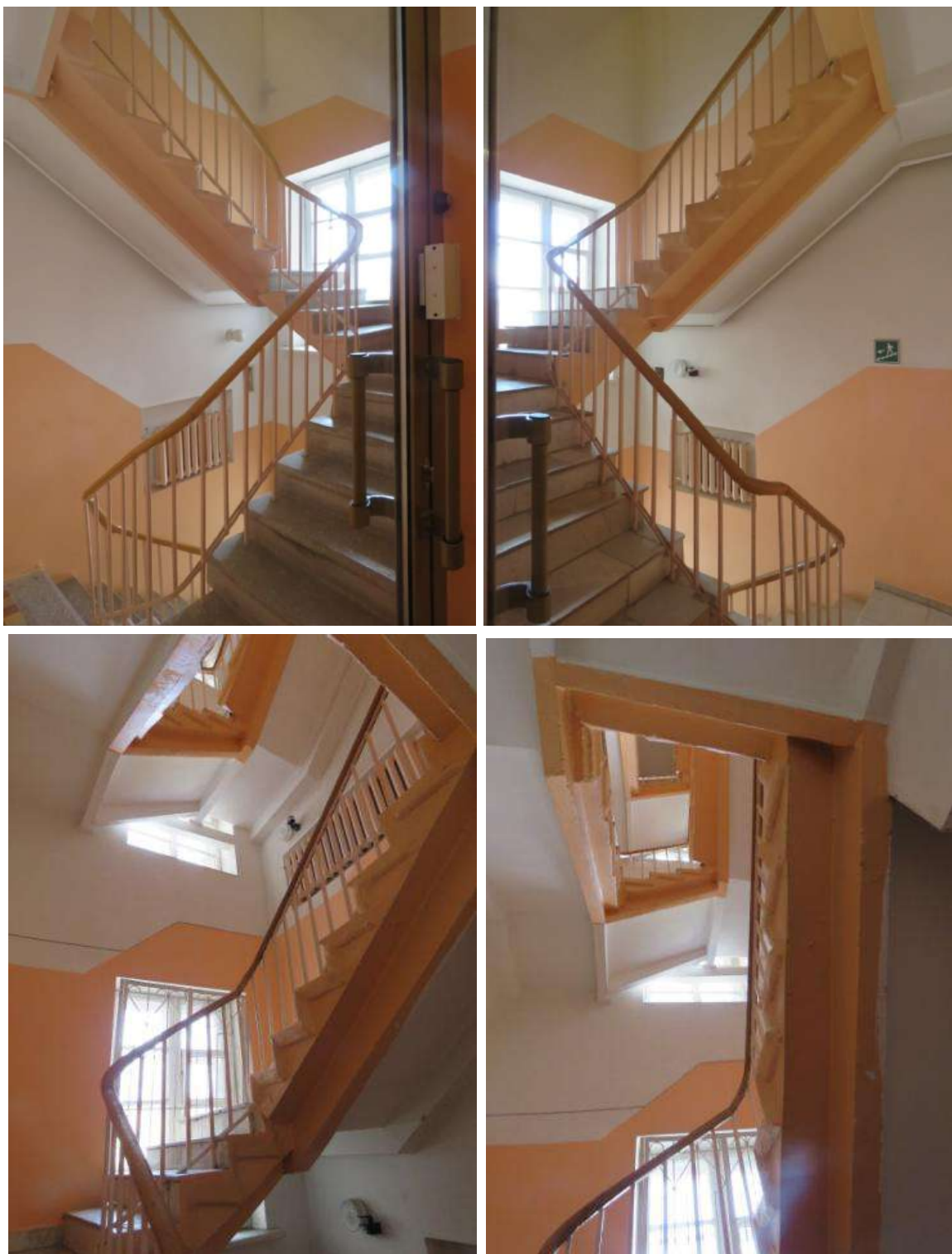
Рис. 80. Парные торцевые лестницы (восточного объема основного корпуса)
