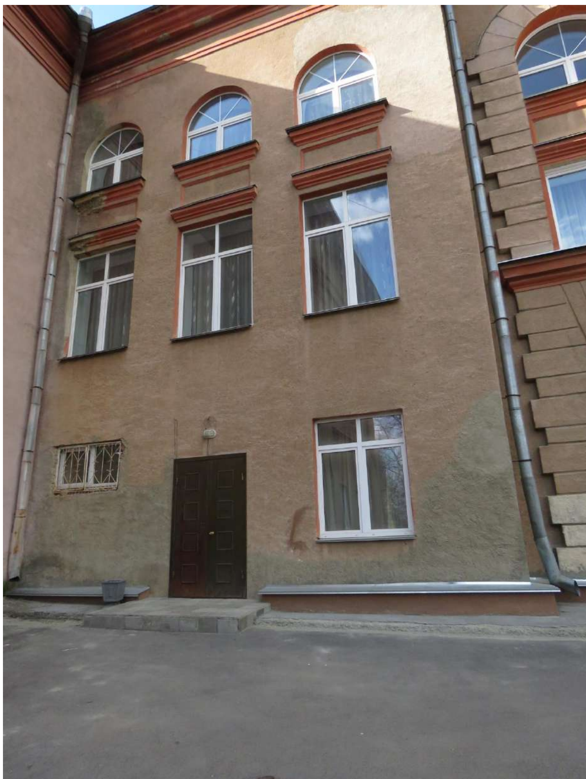
Рис. 17. Боковой, южный фасад основного корпуса. Фрагмент. Западный объем.
