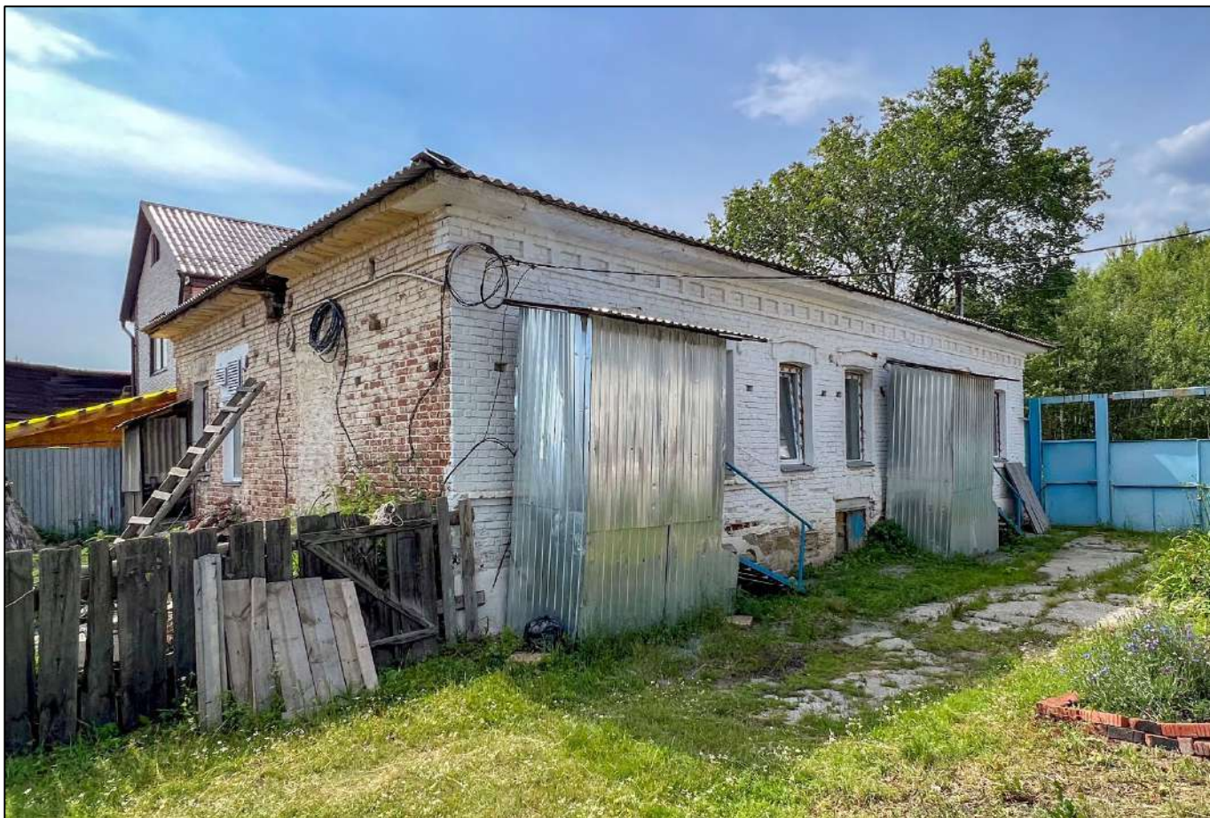
5. Общий вид на фасады Объекта.
