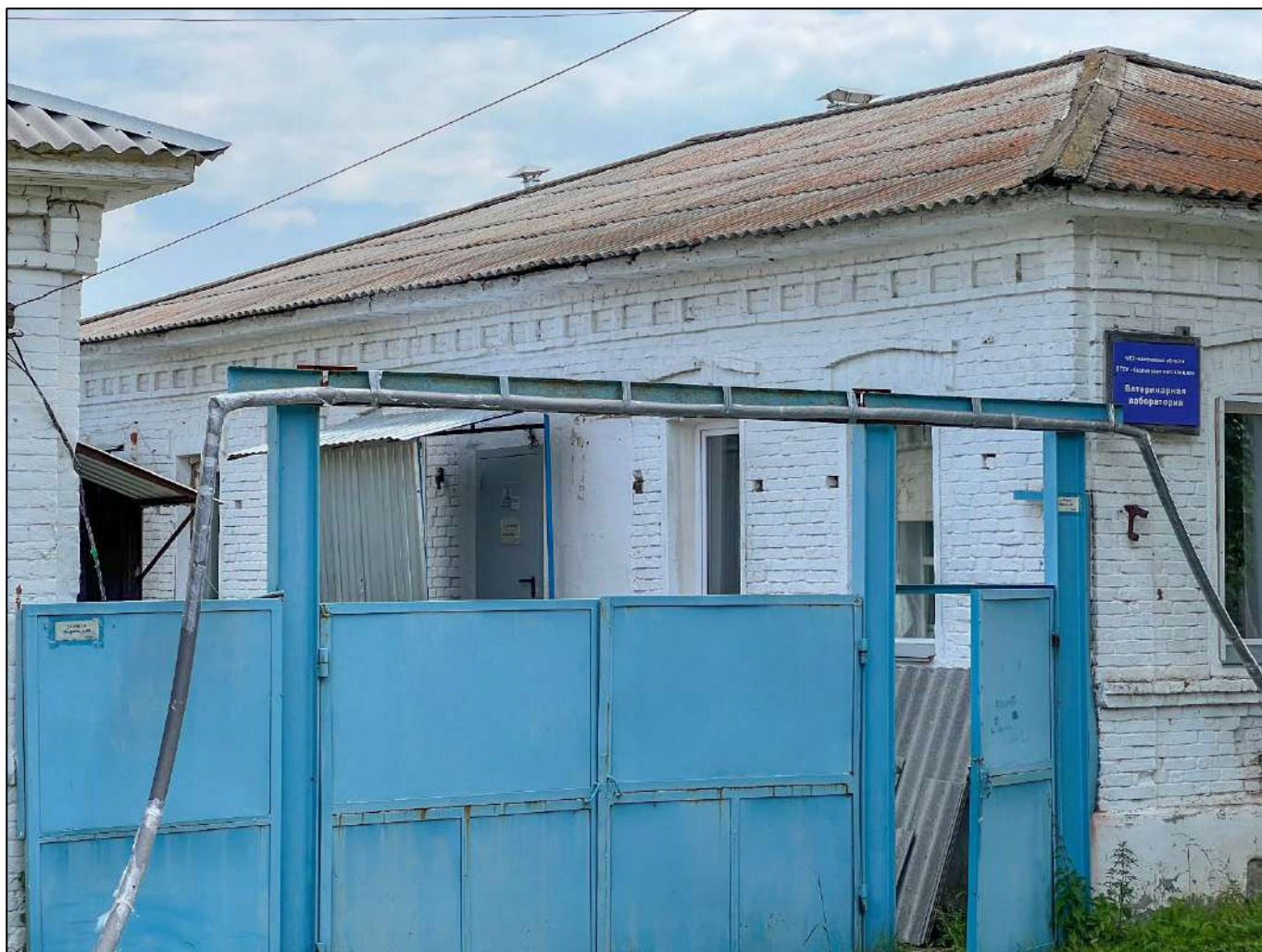
3. Фрагмент фасадов Объекта.
