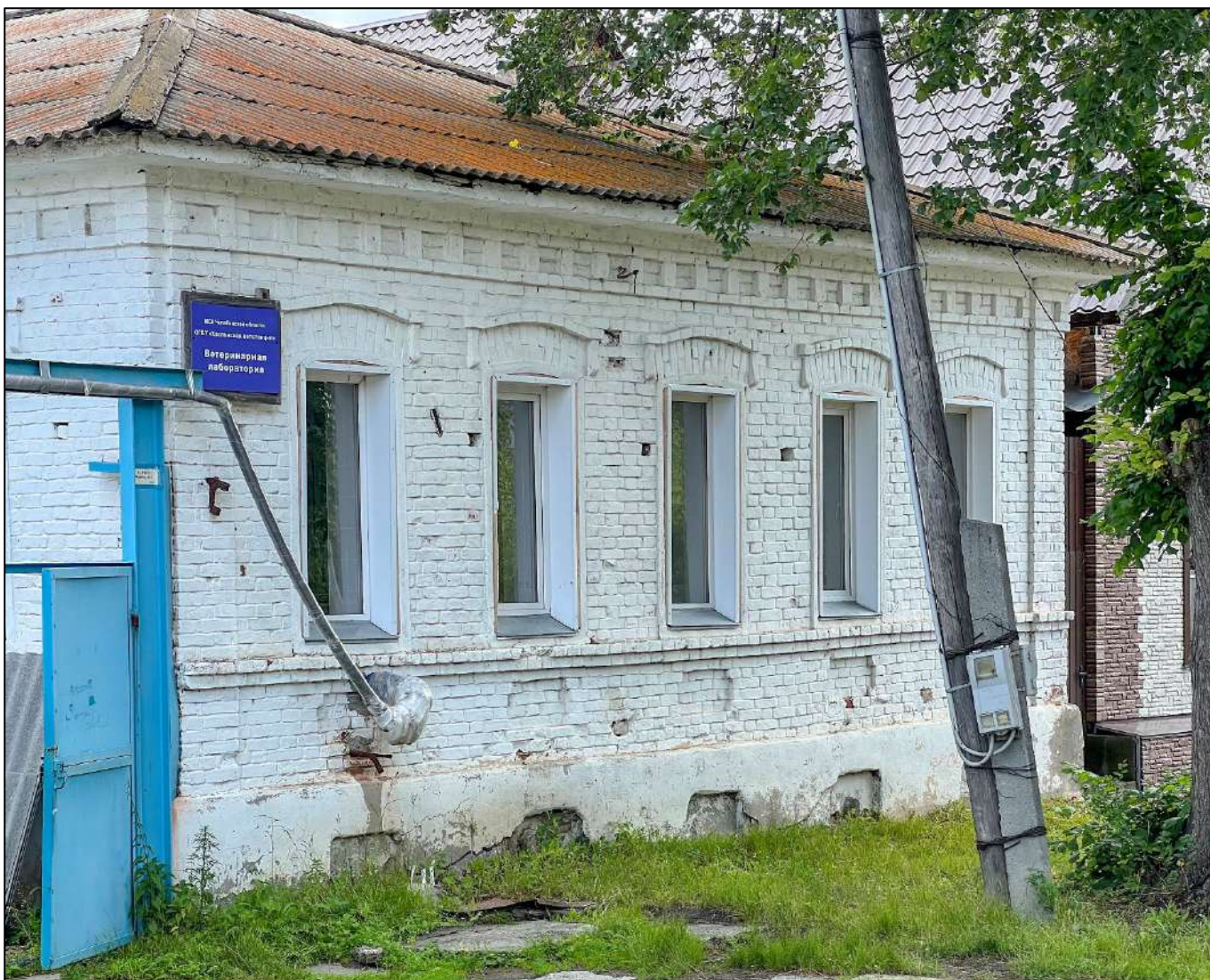
4. Общий вид на фасад Объекта.
