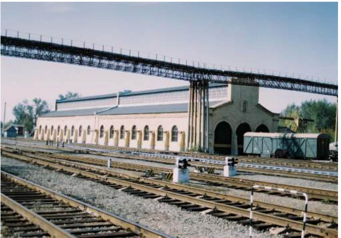
Рис.6. Историческая фотография объекта, 2007 г.
