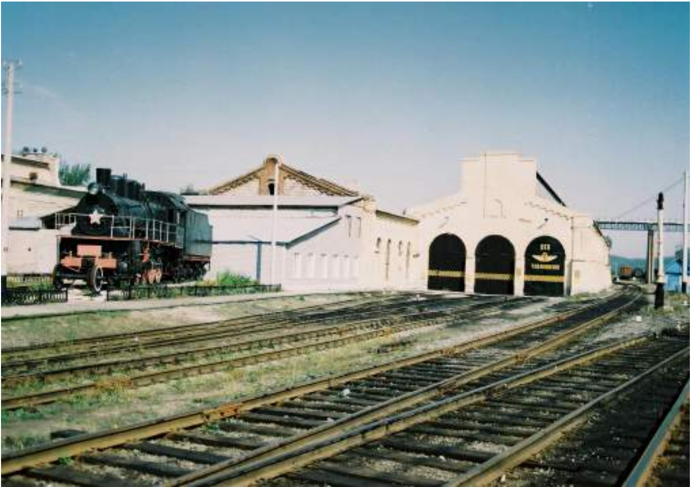
Рис.5. Историческая фотография объекта, 2007 г.
