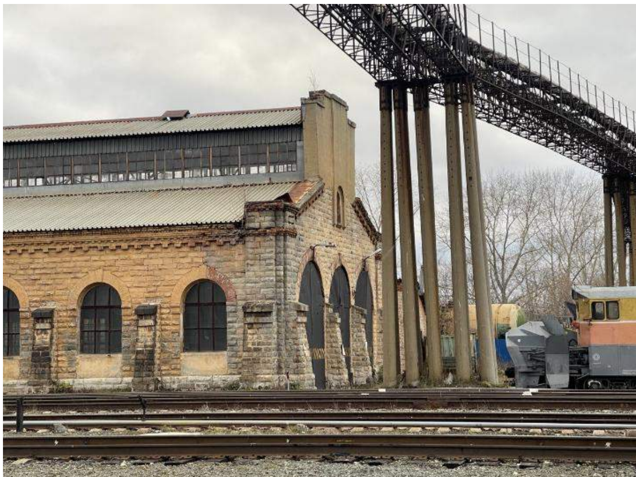
Фото 11. Выявленный объект культурного наследия «Здание паровозного депо» по адресу: Челябинская обл., г. Верхний Уфалей, 107 км. Фрагмент северного фасада выявленного объекта культурного наследия.
