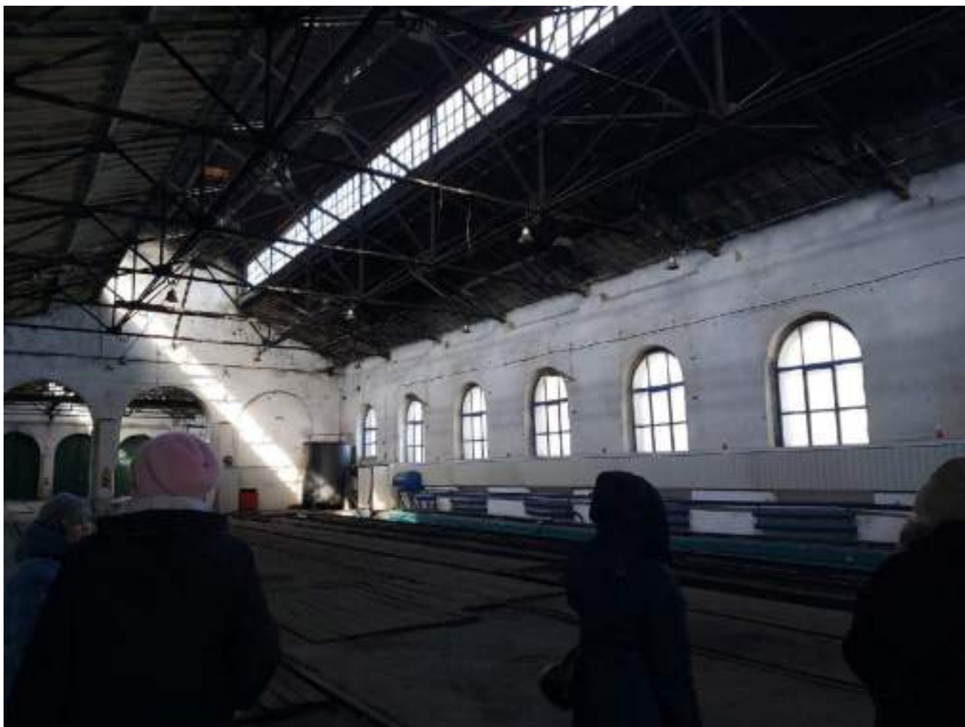
Фото 12. Выявленный объект культурного наследия «Здание паровозного депо» по адресу: Челябинская обл., г. Верхний Уфалей, 107 км. Фрагмент северного фасада выявленного объекта культурного наследия.
