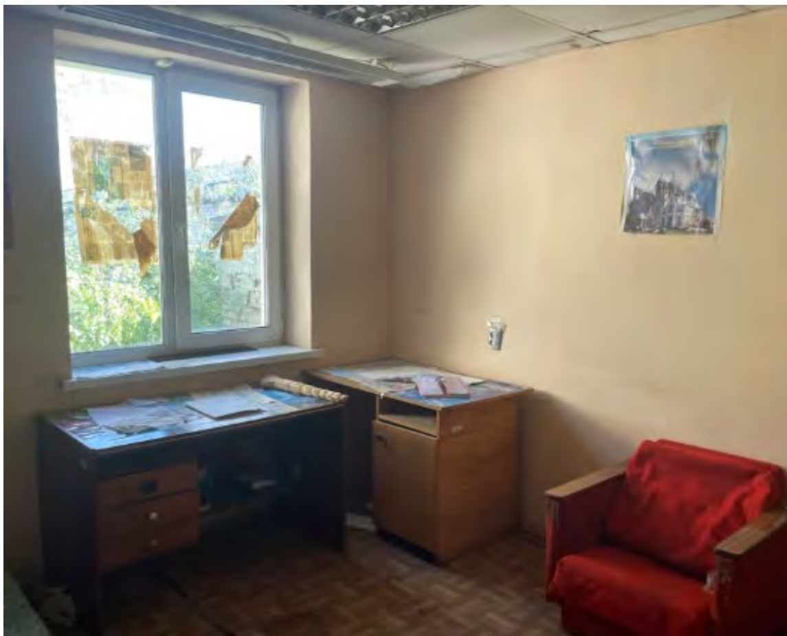
Фото 22. Выявленный объект культурного наследия «Дом купца А.Н. Якушева» по адресу: Челябинская обл., г. Верхний Уфалей, Каслинская ул., 1. Интерьер выявленного объекта культурного наследия. Помещение 2.
