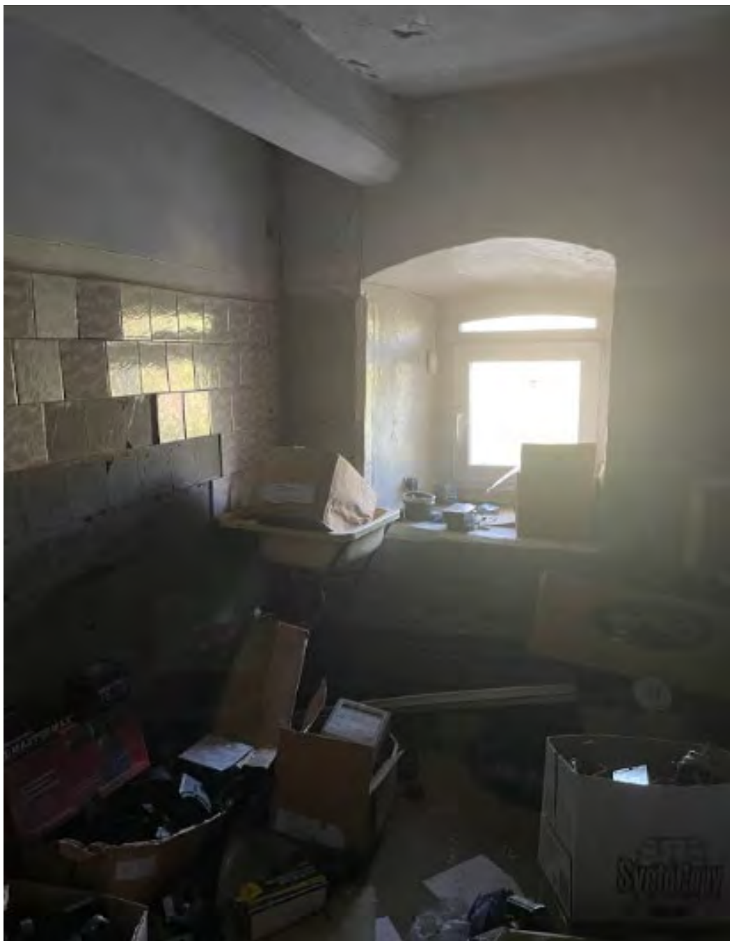
Фото 45. Выявленный объект культурного наследия «Дом купца А.Н. Якушева» по адресу: Челябинская обл., г. Верхний Уфалей, Каслинская ул., 1. Интерьер выявленного объекта культурного наследия. Помещение 8. Цокольный этаж.
