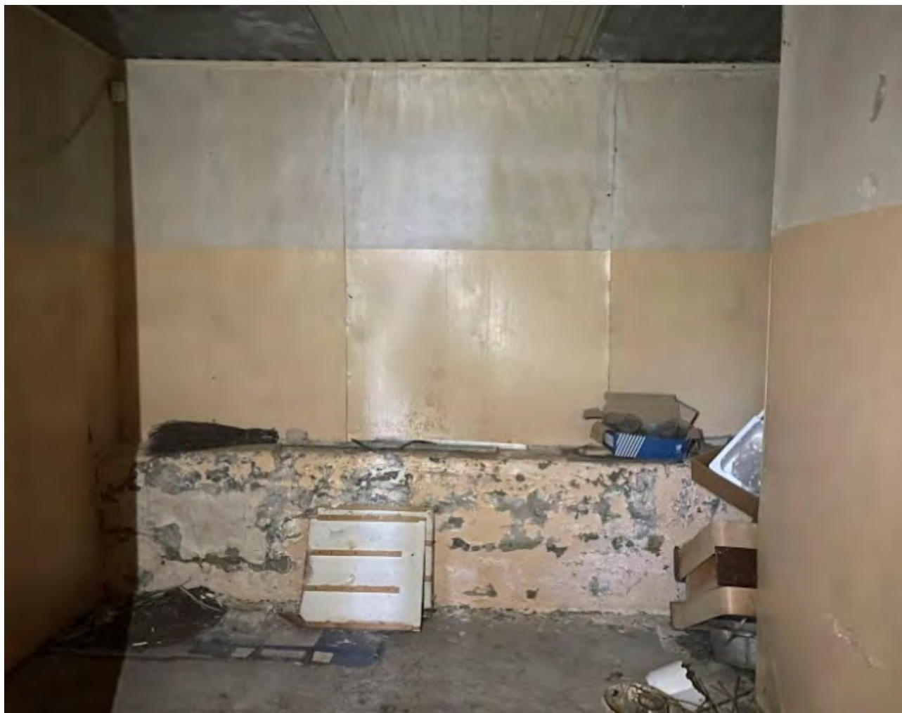
Фото 42. Выявленный объект культурного наследия «Дом купца А.Н. Якушева» по адресу: Челябинская обл., г. Верхний Уфалей, Каслинская ул., 1. Интерьер выявленного объекта культурного наследия. Помещение 8. Цокольный этаж.
