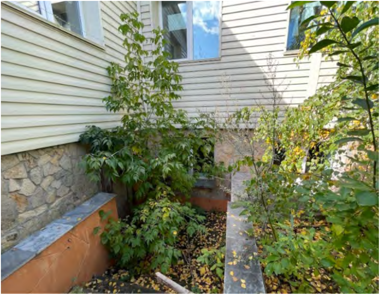
Фото 6. Выявленный объект культурного наследия «Дом купца А.Н. Якушева» по адресу: Челябинская обл., г. Верхний Уфалей, Каслинская ул., 1. Фрагмент южного фасада выявленного объекта культурного наследия.
