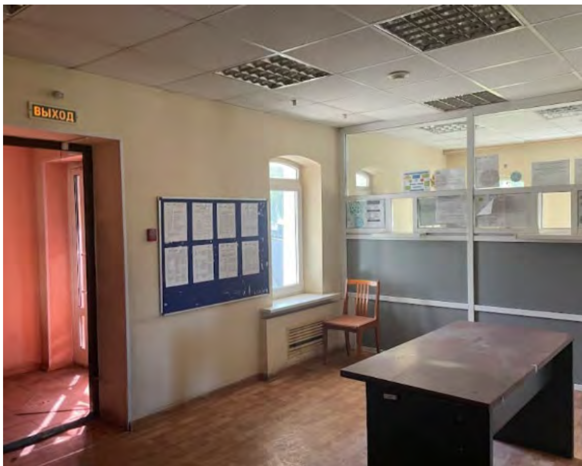
Фото 20. Выявленный объект культурного наследия «Дом купца А.Н. Якушева» по адресу: Челябинская обл., г. Верхний Уфалей, Каслинская ул., 1. Интерьер выявленного объекта культурного наследия. Помещение 1.
