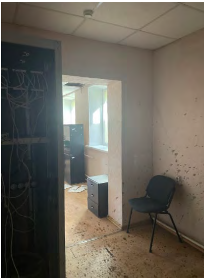
Фото 39. Выявленный объект культурного наследия «Дом купца А.Н. Якушева» по адресу: Челябинская обл., г. Верхний Уфалей, Каслинская ул., 1. Интерьер выявленного объекта культурного наследия. Помещение 7.
