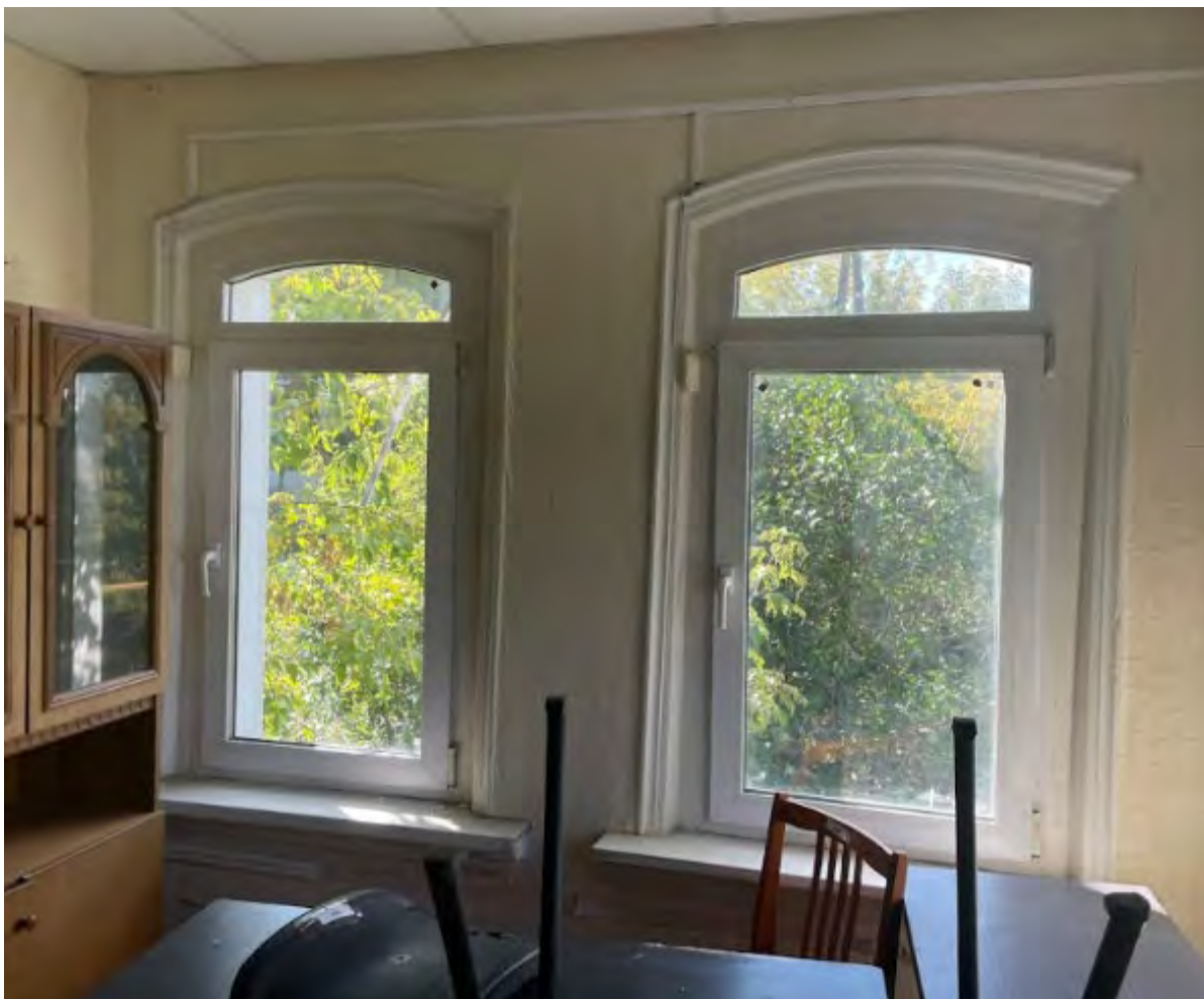
Фото 35. Выявленный объект культурного наследия «Дом купца А.Н. Якушева» по адресу: Челябинская обл., г. Верхний Уфалей, Каслинская ул., 1. Интерьер выявленного объекта культурного наследия. Помещение 4.
