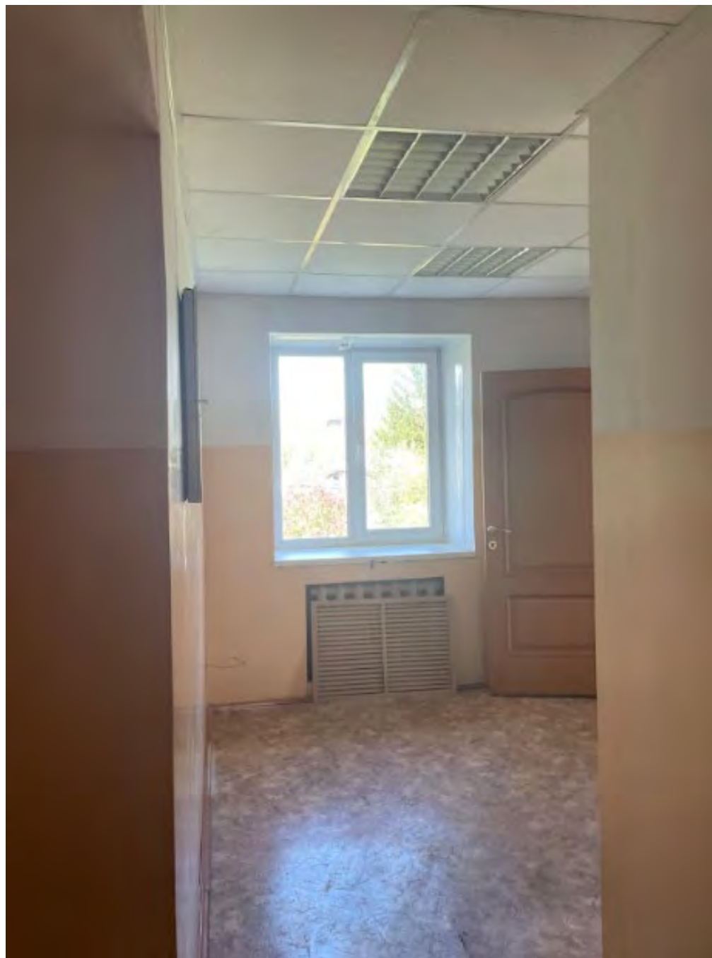
Фото 36. Выявленный объект культурного наследия «Дом купца А.Н. Якушева» по адресу: Челябинская обл., г. Верхний Уфалей, Каслинская ул., 1. Интерьер выявленного объекта культурного наследия. Помещение 5.
