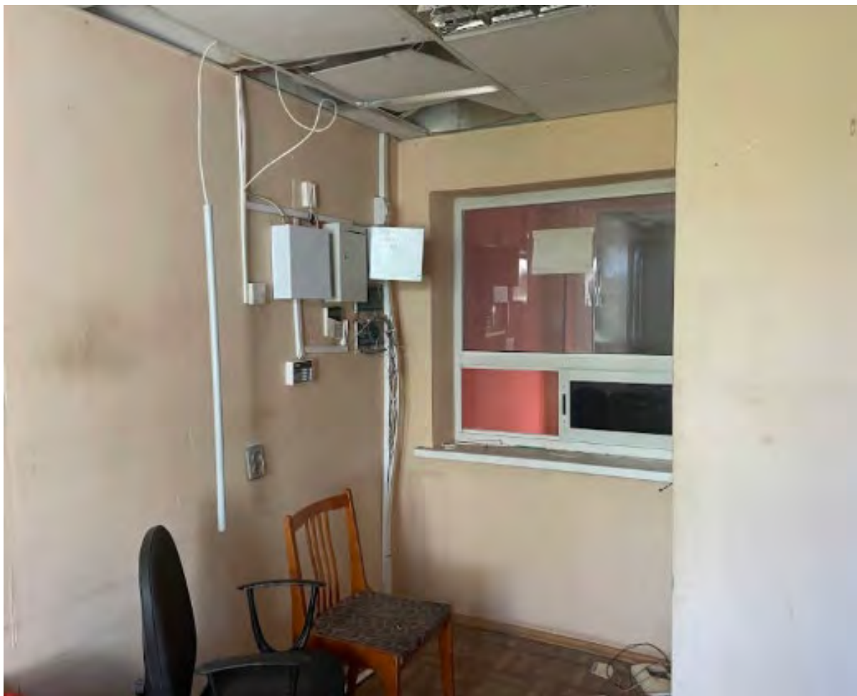
Фото 23. Выявленный объект культурного наследия «Дом купца А.Н. Якушева» по адресу: Челябинская обл., г. Верхний Уфалей, Каслинская ул., 1. Интерьер выявленного объекта культурного наследия. Помещение 2.
