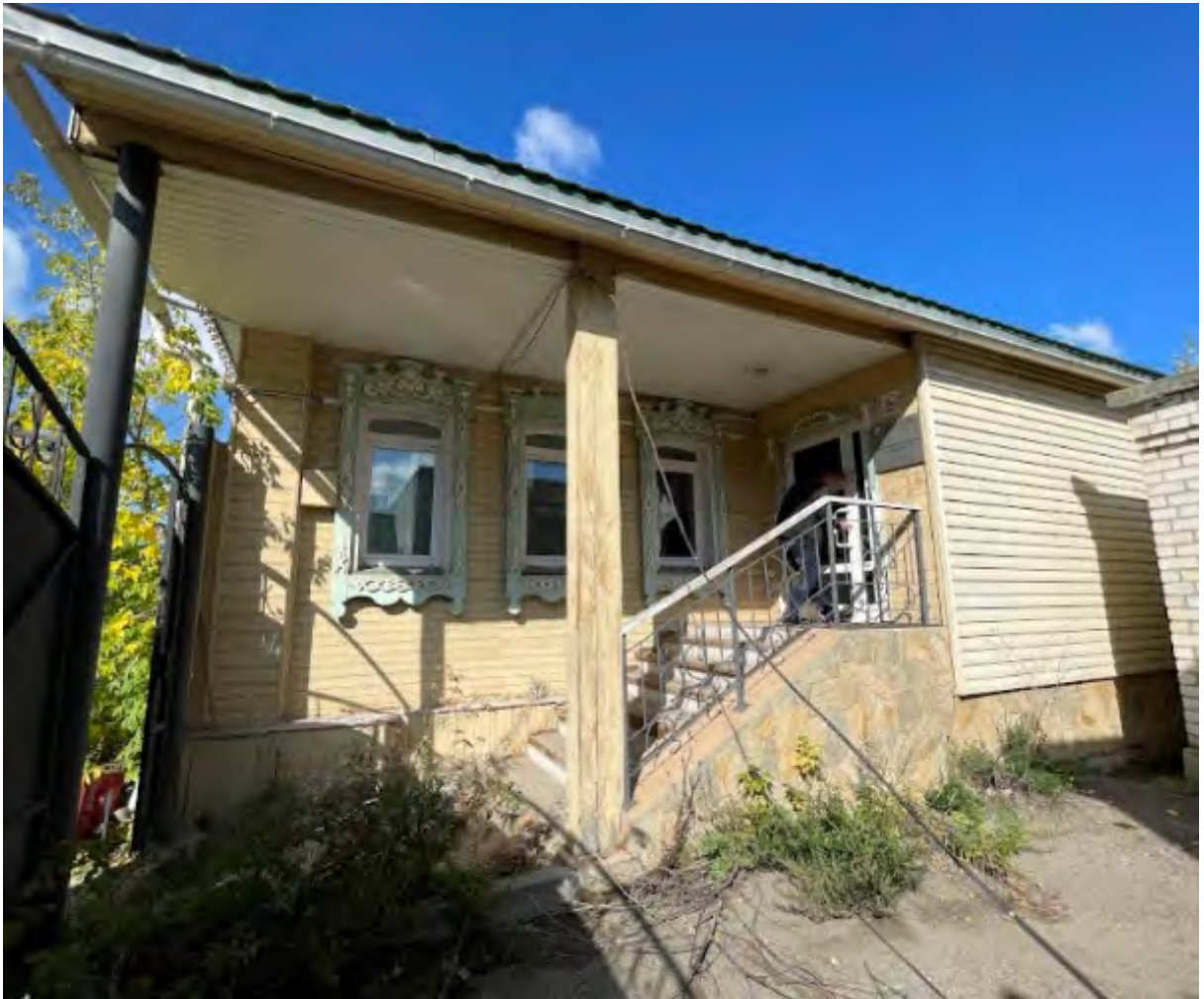
Фото 5. Выявленный объект культурного наследия «Дом купца А.Н. Якушева» по адресу: Челябинская обл., г. Верхний Уфалей, Каслинская ул., 1. Фрагмент южного фасада выявленного объекта культурного наследия.
