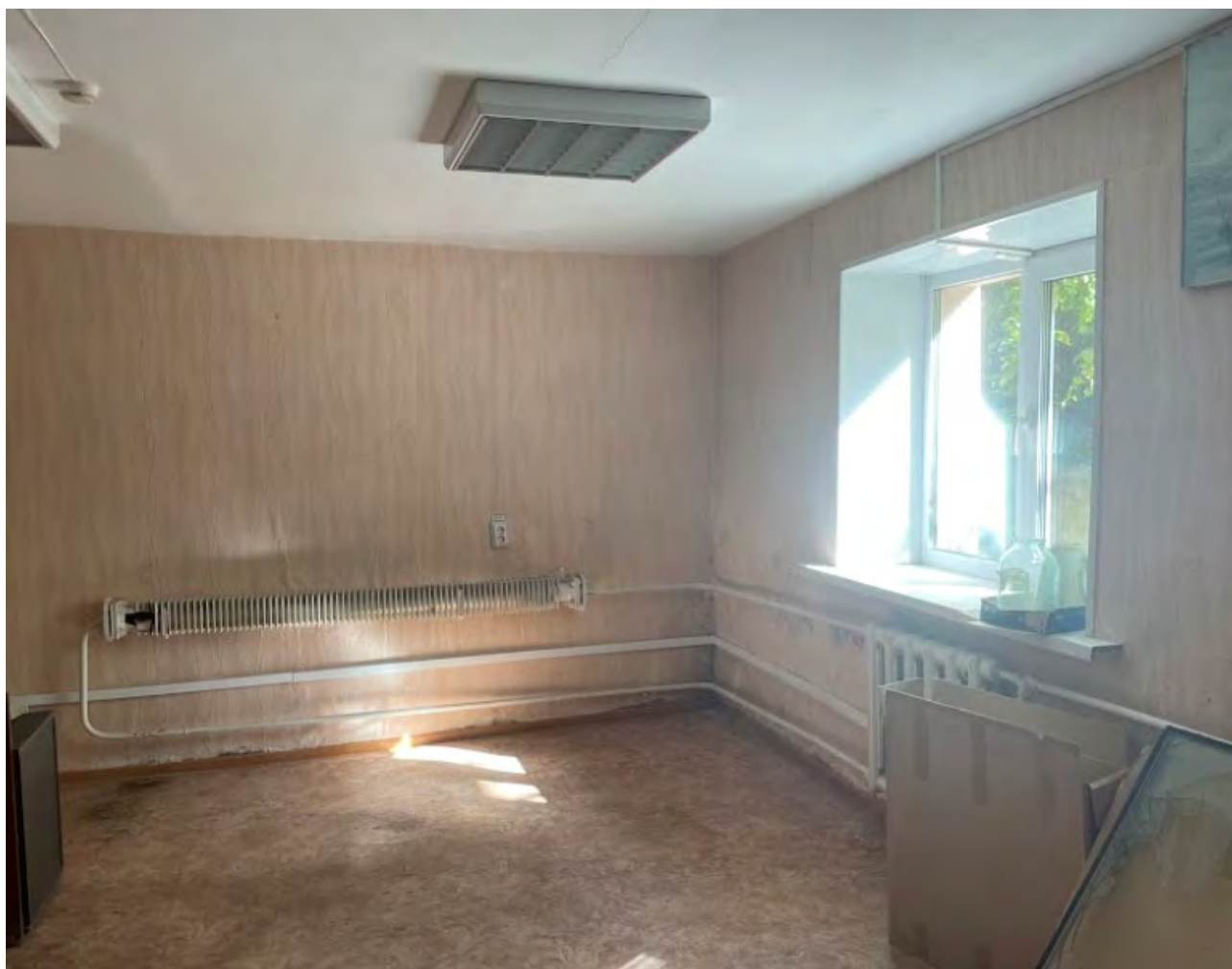
Фото 41. Выявленный объект культурного наследия «Дом купца А.Н. Якушева» по адресу: Челябинская обл., г. Верхний Уфалей, Каслинская ул., 1. Интерьер выявленного объекта культурного наследия. Помещение 8. Цокольный этаж.
