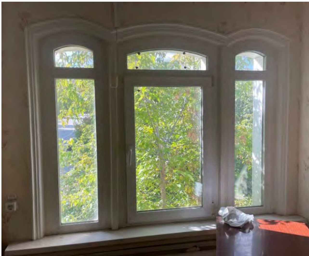
Фото 29. Выявленный объект культурного наследия «Дом купца А.Н. Якушева» по адресу: Челябинская обл., г. Верхний Уфалей, Каслинская ул., 1. Интерьер выявленного объекта культурного наследия. Помещение 3.
