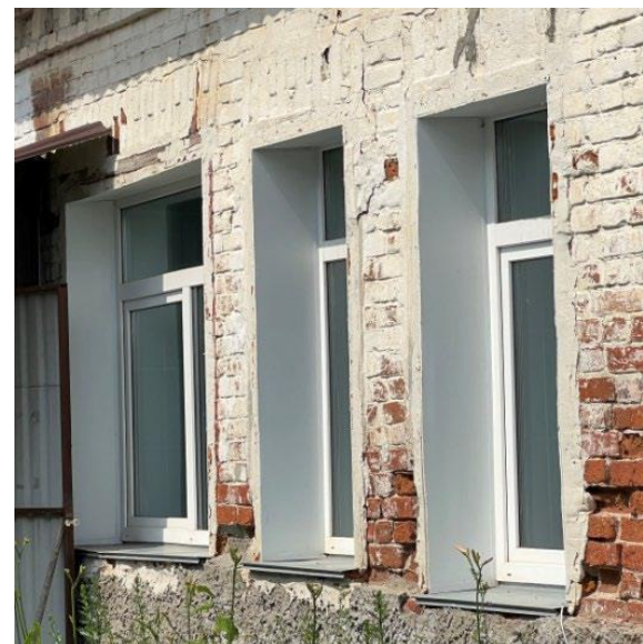
Оформление оконных проемов юго-западного фасада
