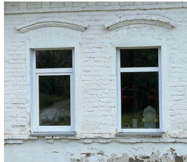
Оформление оконных проемов северо-западного фасада
