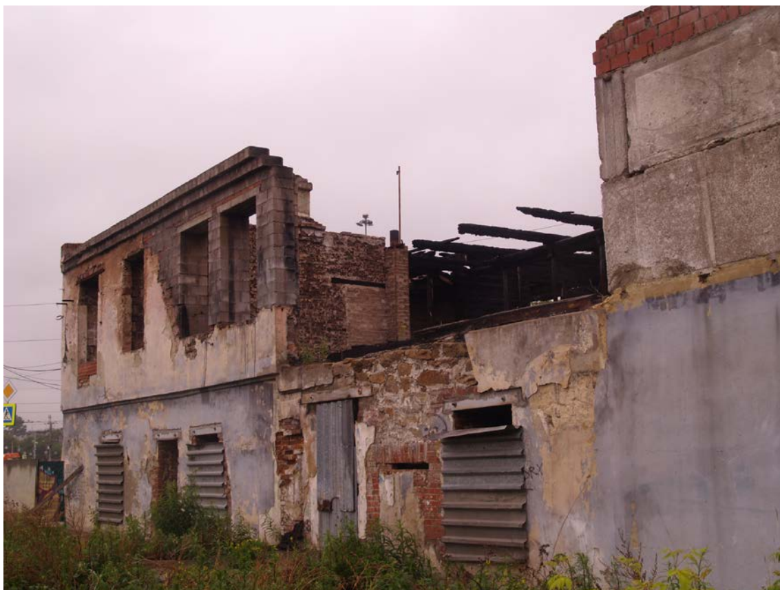
Фото 4. Объект культурного наследия. Общий вид с СЗ.
