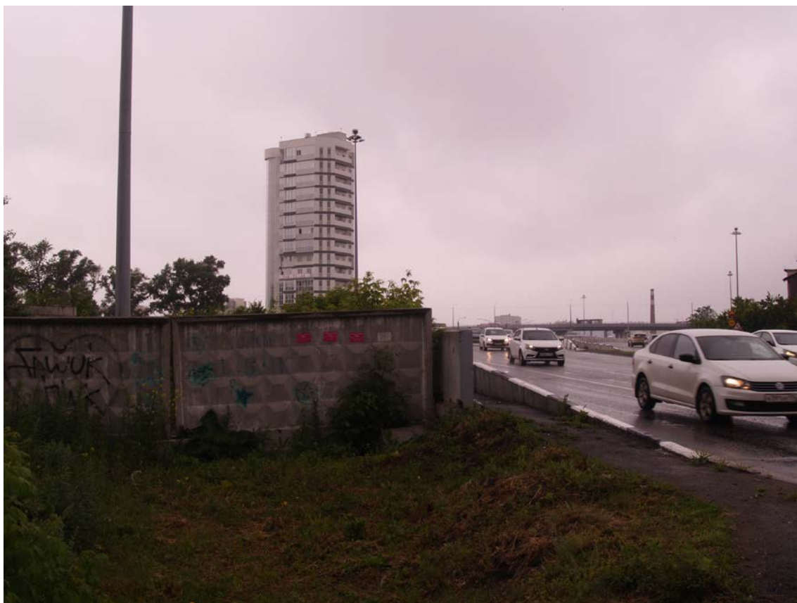
Фото 20. Градостроительная ситуация на территории исследования.
