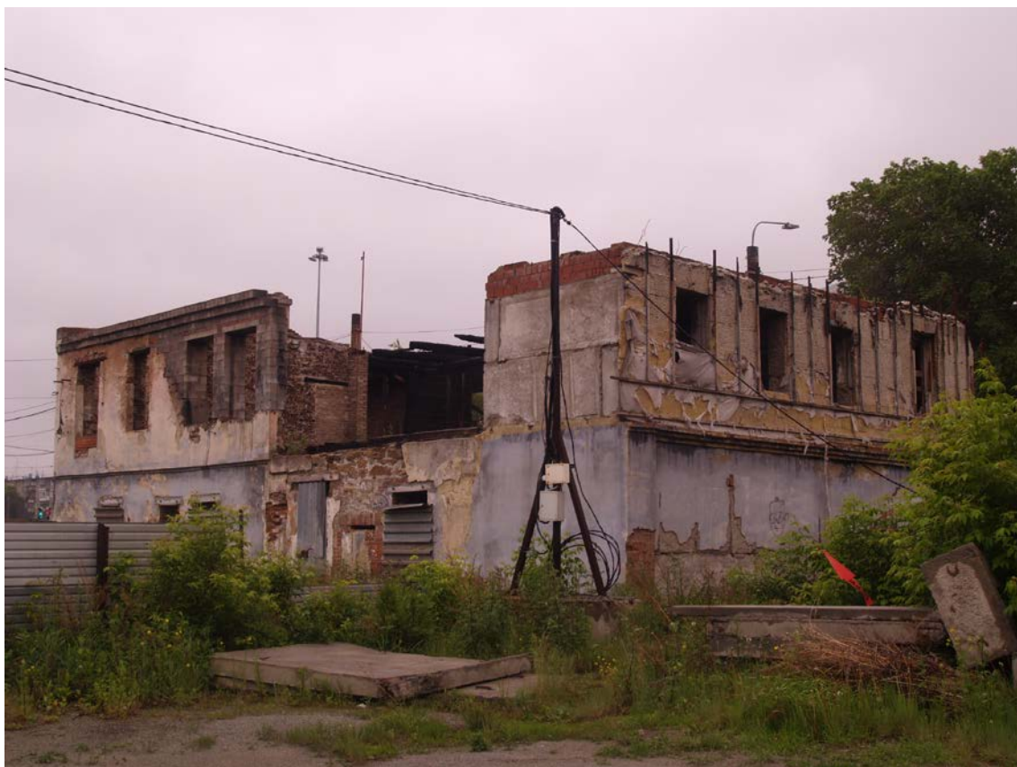
Фото 5. Объект культурного наследия. Общий вид с СЗ.
