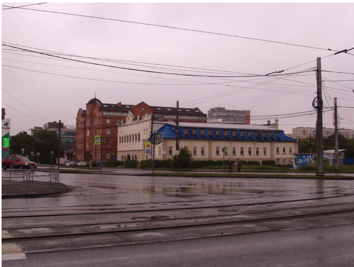
Фото 19. Градостроительная ситуация на территории исследования.
