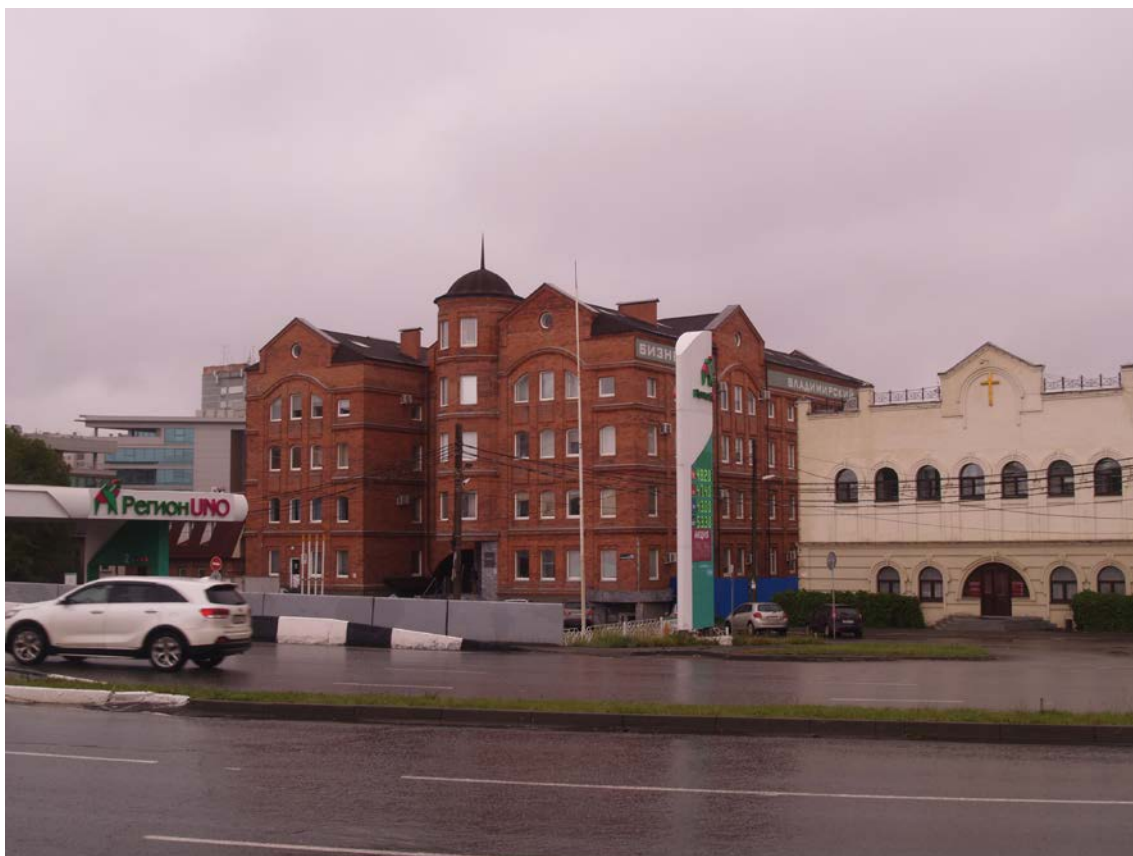
Фото 23. Градостроительная ситуация на территории исследования.
