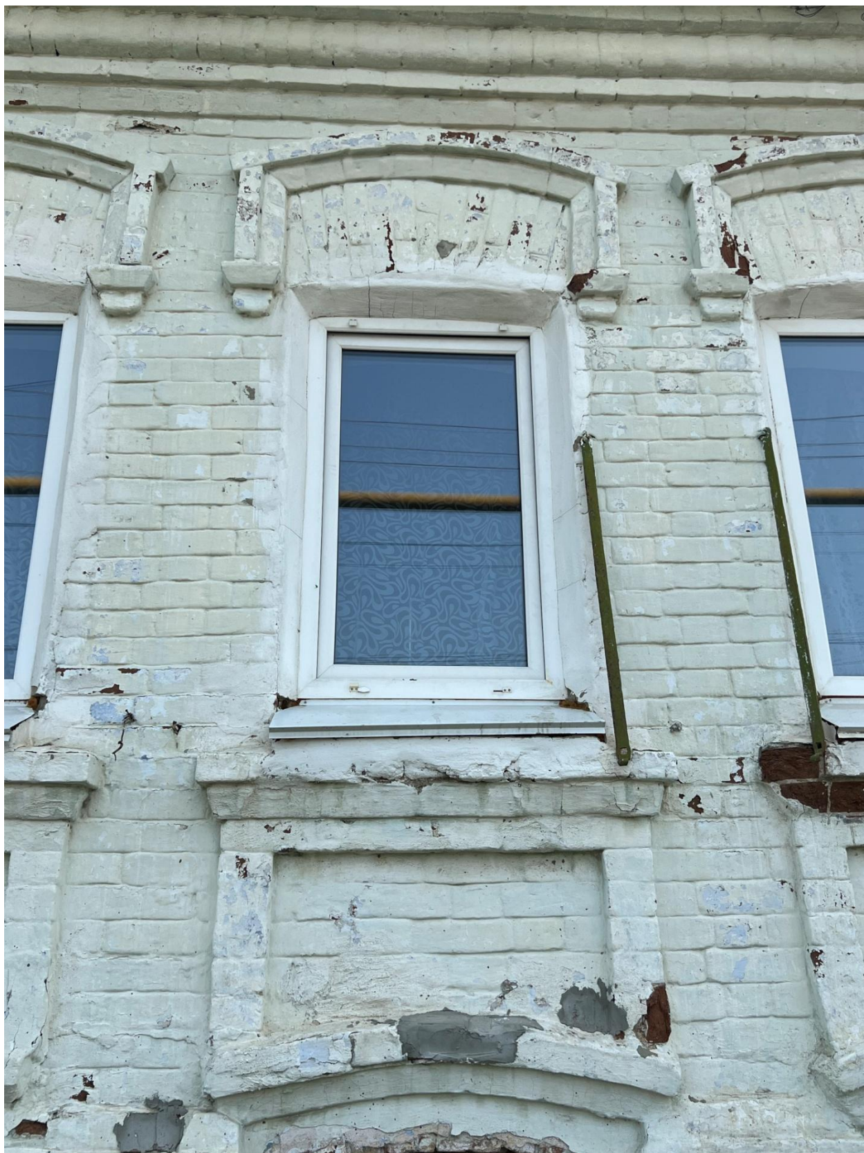
Рис. 6. Фрагмент главного, западного фасада. Декоративное оформление оконного проема первого этажа
