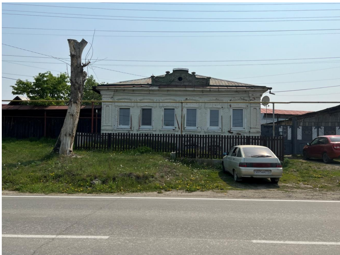
Рис. 2. Вид на объект со стороны ул. Энгельса
