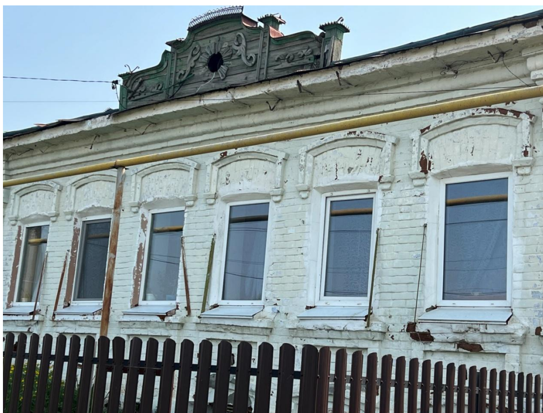
Рис. 5. Фрагмент главного, западного фасада. Декор оконных проемов первого этажа
