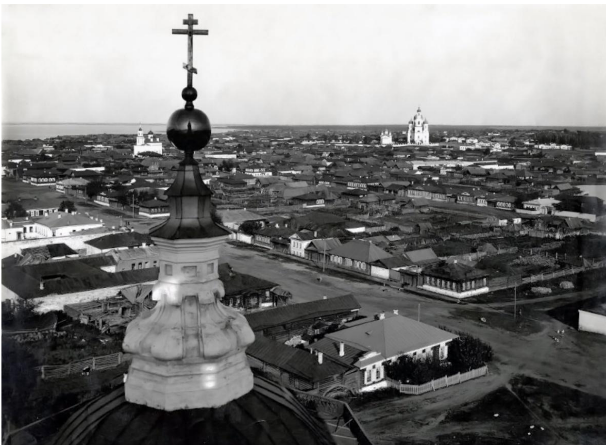
Рис. 12. Каслинский завод. Вид со стороны предзаводской площади. На дальнем плане – Вознесенская церковь. Фото начала 20в. Источник: фонды Пермского краеведческого музея
