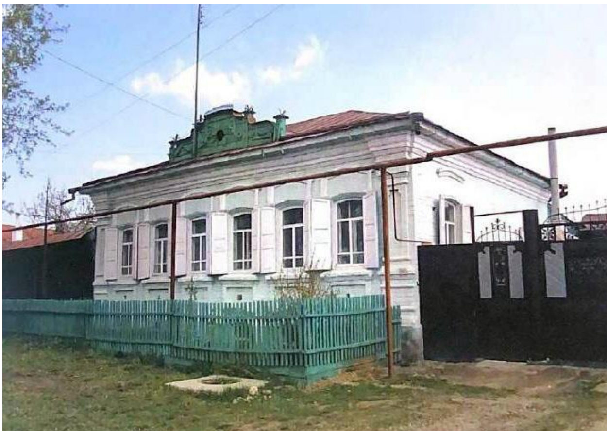
Рис. 14. Выявленный ОКН. Фото 2006 г. Источник: историко-культурный опорный план и проект охранных зон города Касли Челябинской области. Челябинск, 2006.
