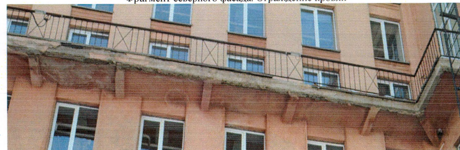
Вид на переходной пожарной балкон
