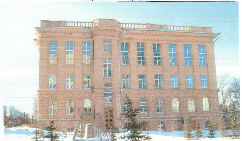
Вид на восточный фасад здания
