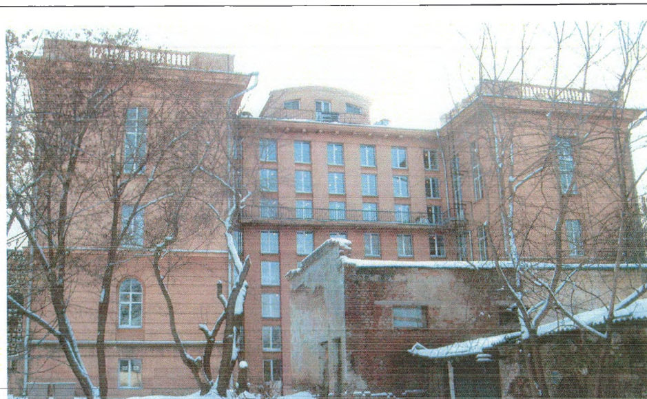
Вид на северный фасад здания
