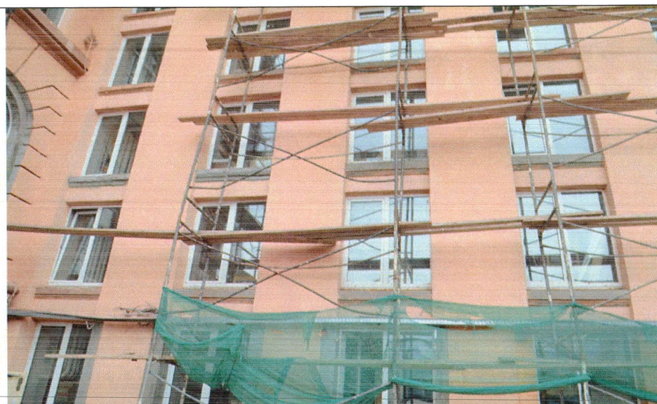
Фрагмент центральной части фасада книгохранилища
