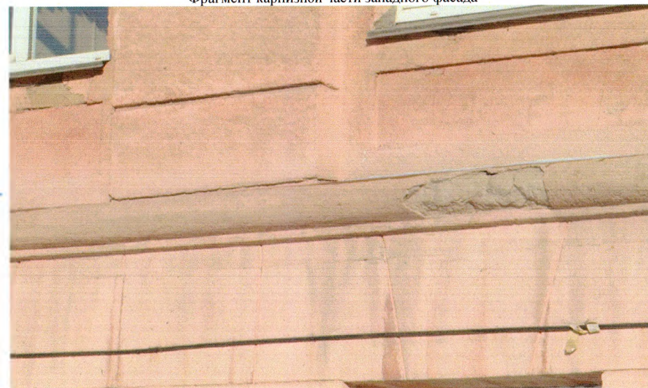
Вид на междуэтажный карниз
