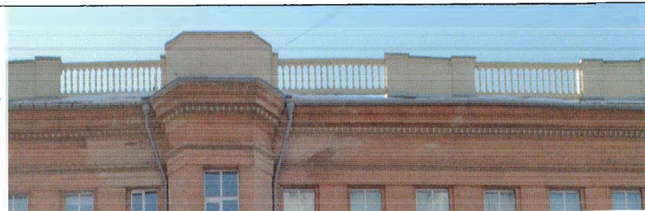
Ограждение кровли из участков парапета с балюстрадой
