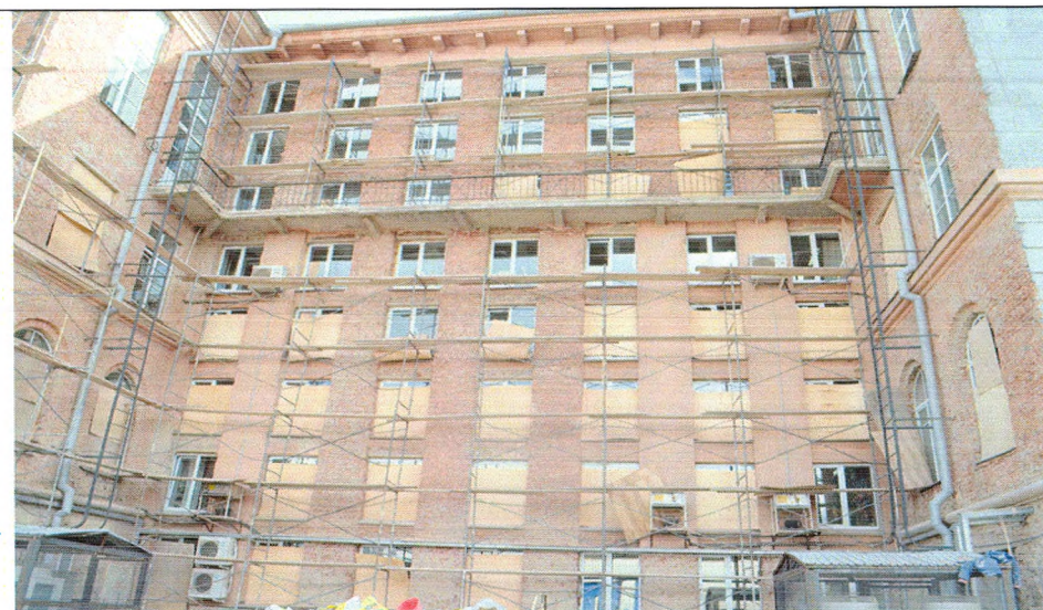
Вид на центральную часть северного фасада
