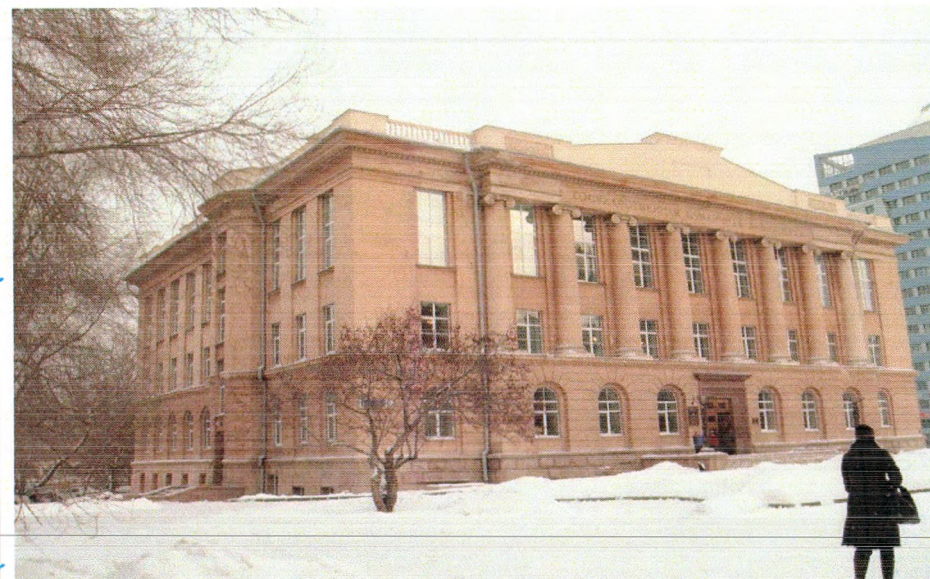
Вид на здание библиотеки с юго-запада
