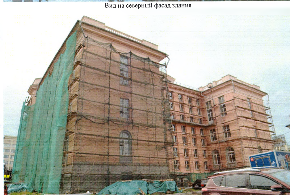
Вид на северный фасад с северо-восточной стороны
