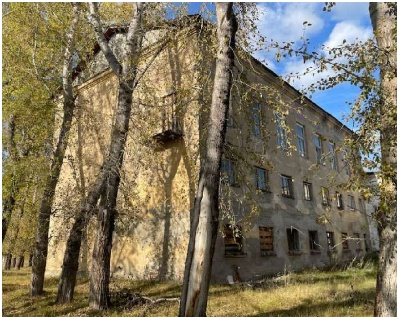
Фото 20. Выявленный объект культурного наследия «Здание железнодорожного депо» по адресу: Челябинская обл., г. Нязепетровск, Кутасова ул. Общий вид юго-западной пристройки выявленного объекта культурного наследия.
