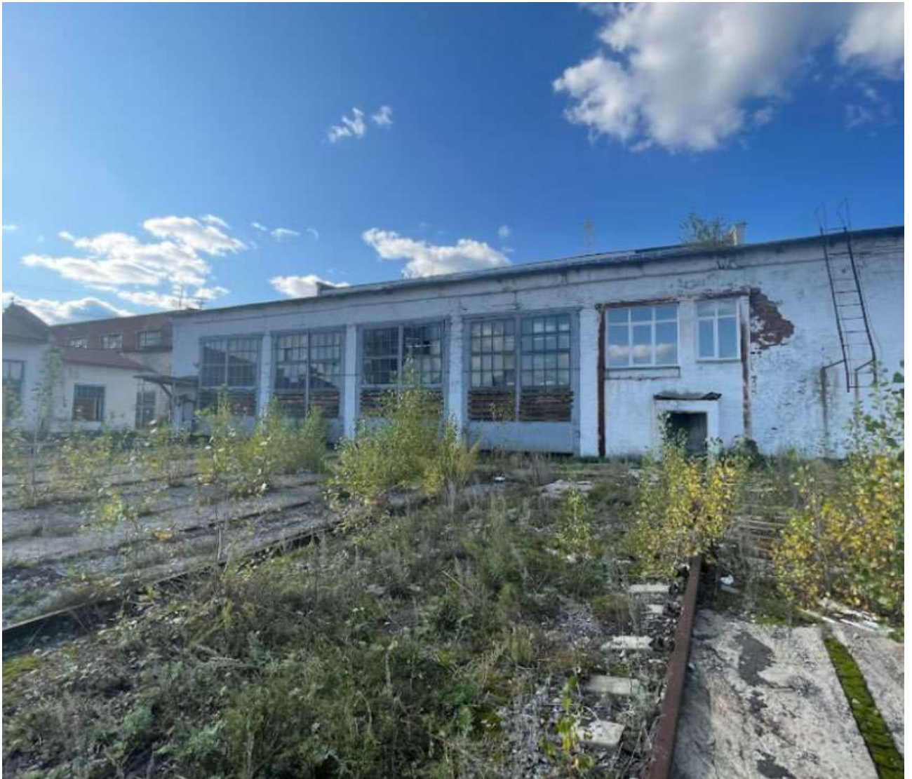
Фото 11. Выявленный объект культурного наследия «Здание железнодорожного депо» по адресу: Челябинская обл., г. Нязепетровск, Кутасова ул. Фрагмент восточного фасада восточной части выявленного объекта культурного наследия.
