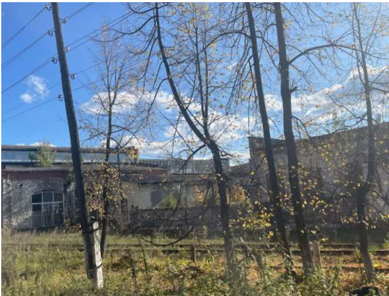
Фото 4. Выявленный объект культурного наследия «Здание железнодорожного депо» по адресу: Челябинская обл., г. Нязепетровск, Кутасова ул. Общий вид северной, западной и восточной части выявленного объекта культурного наследия.
