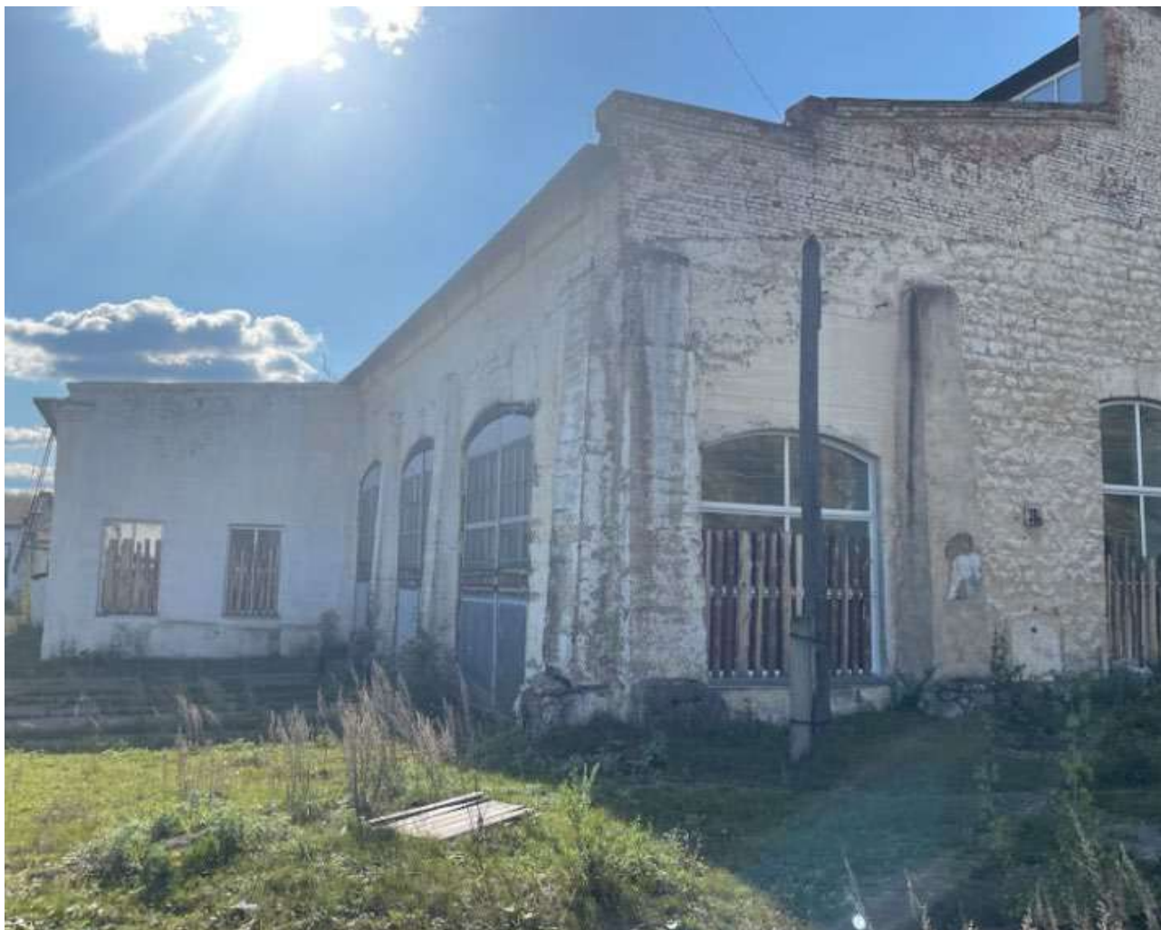
Фото 7. Выявленный объект культурного наследия «Здание железнодорожного депо» по адресу: Челябинская обл., г. Нязепетровск, Кутасова ул. Фрагмент северного фасада восточной части выявленного объекта культурного наследия.
