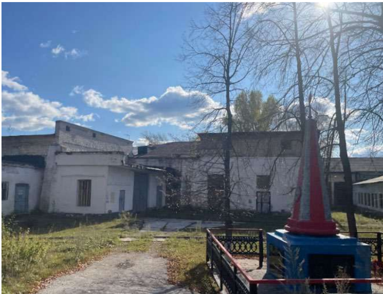
Фото 3. Выявленный объект культурного наследия «Здание железнодорожного депо» по адресу: Челябинская обл., г. Нязепетровск, Кутасова ул. Общий вид северной и западной части выявленного объекта культурного наследия.
