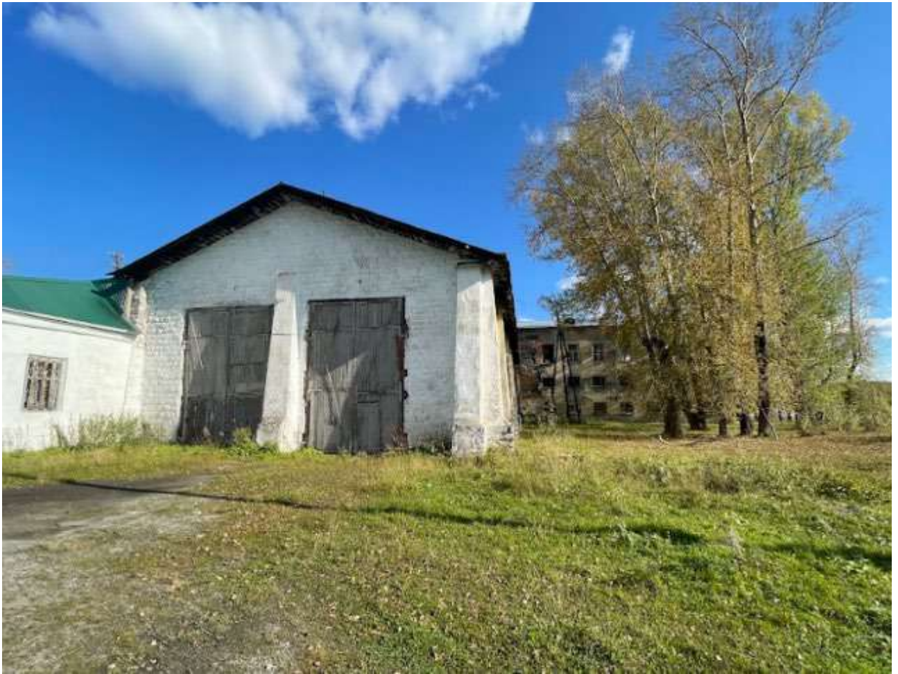
Фото 24. Выявленный объект культурного наследия «Здание железнодорожного депо» по адресу: Челябинская обл., г. Нязепетровск, Кутасова ул. Западный фасад западной части объекта культурного наследия.
