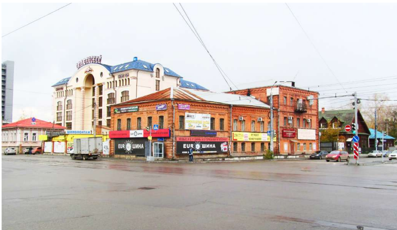
Рис. 2 Вид на здание-памятник с юго-востока со стороны перекрестка улиц Труда и Свободы
