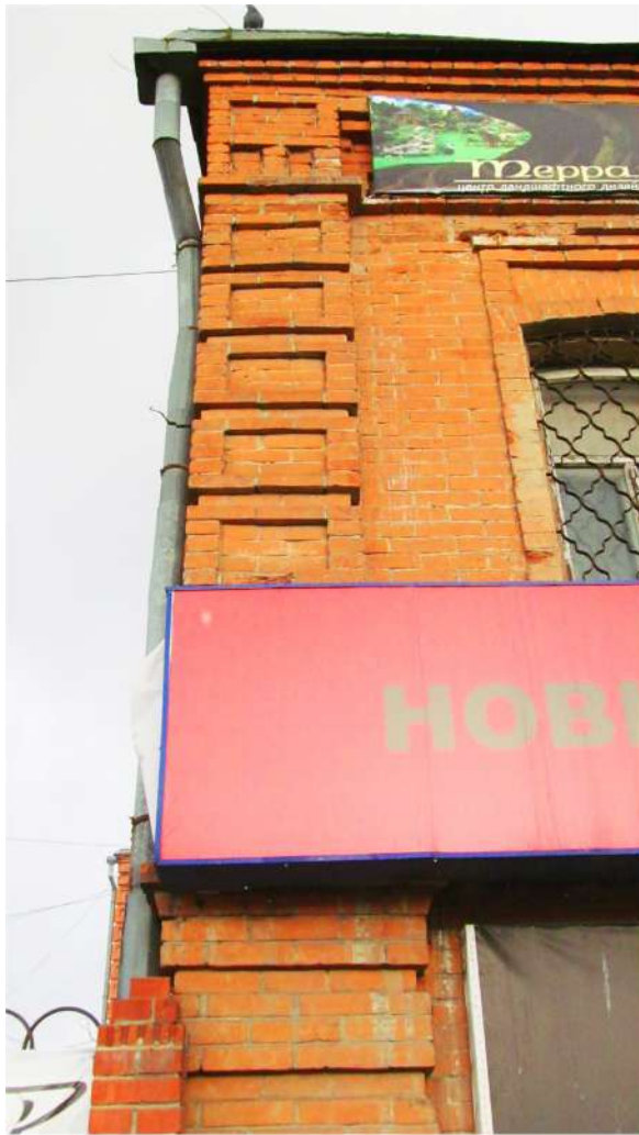
Рис. 31 Вид на лопатку с рамочным и обычным рустом главного фасада здания
