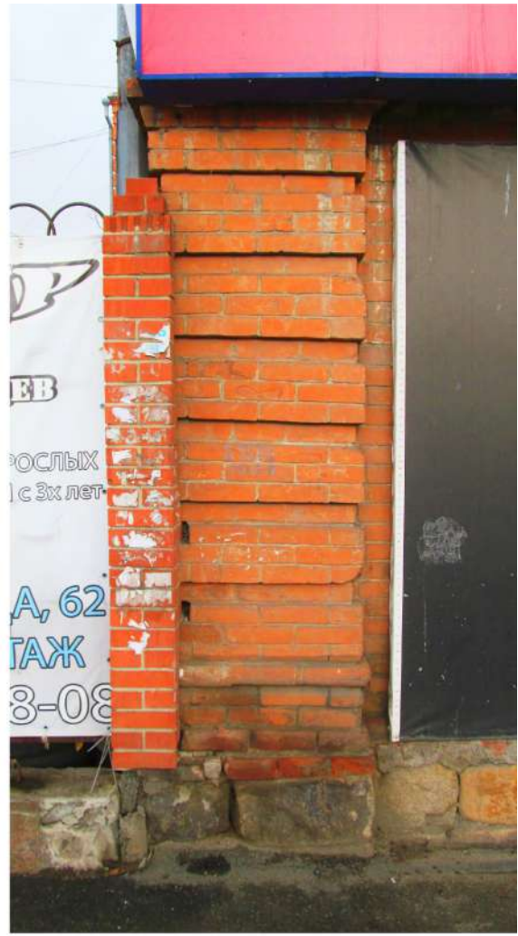
Рис. 31 Вид на лопатку с рамочным и обычным рустом главного фасада здания
