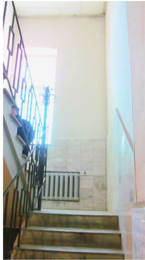
Рис. 43 Вид на интерьер лестничной клетки с 1-го этажа здания
