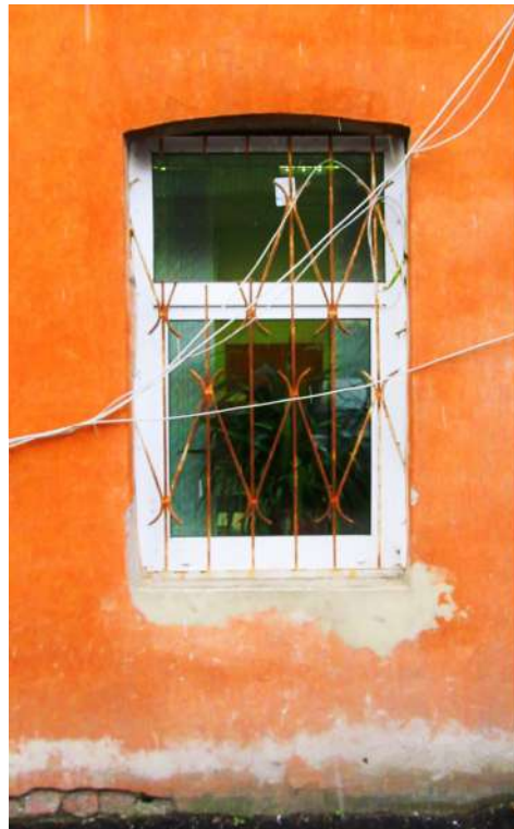
Рис. 25 Вид на окно 1го этажа западного фасада здания
