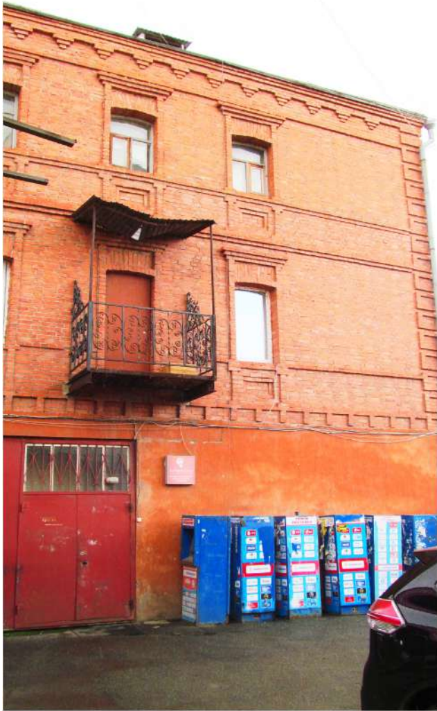
Рис. 12 Вид на западный фасад северного крыла здания со стороны дворовой территории
