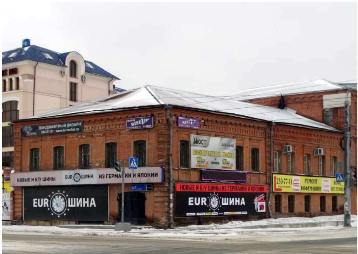
Рис. 74 Восточный и южный фасады дома по ул. Труда, 62/ ул.Свободы,14 (Фото - март 2016 г., автор – Ю.В. Латышев). Ссылка: https://img-fotki.yandex.ru/get/66745/5661614.111/0_ba385_5a7df016_XL.jpg
