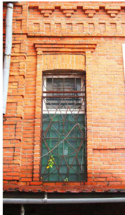
Рис. 22 Вид на окно 2го этажа западного фасада здания
