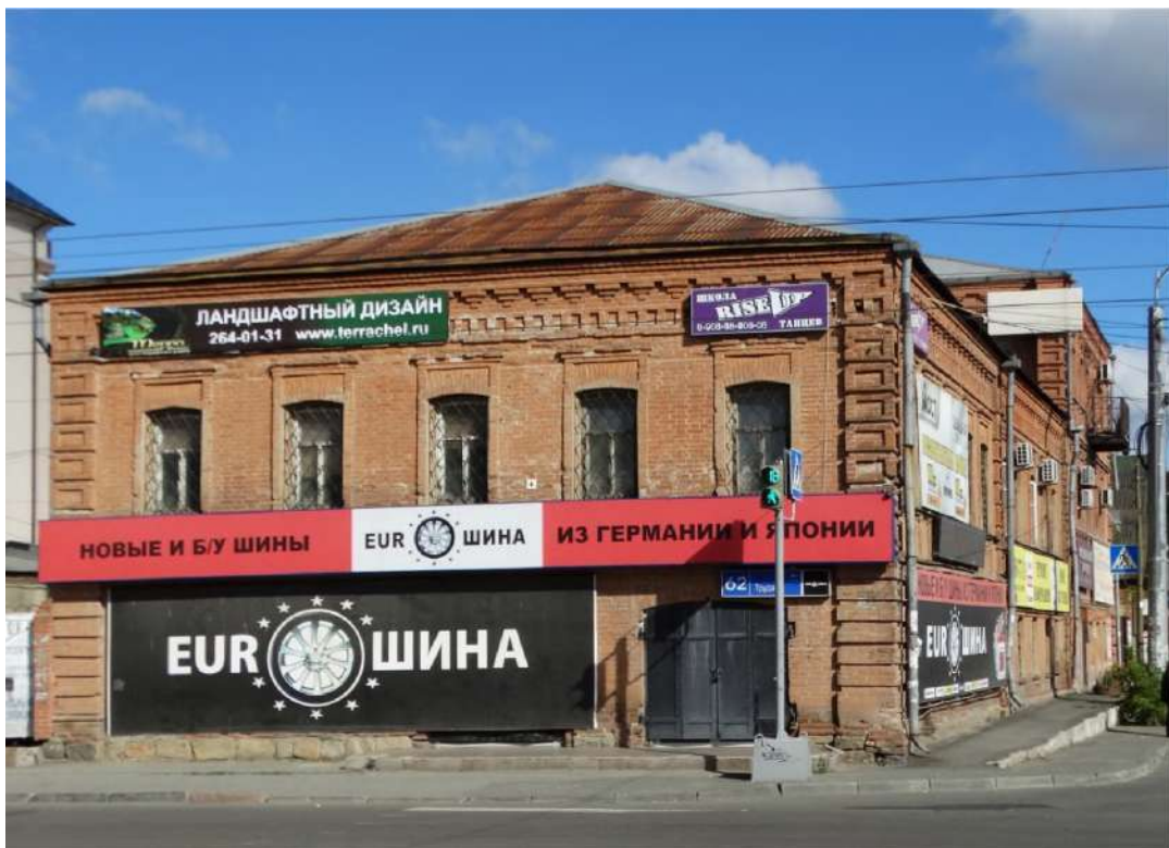
Рис. 75 Южный фасад дома по ул. Труда, 62/ ул.Свободы,14 (Фото - 2016 г., автор – Ю.В. Латышев). Ссылка: https://img-fotki.yandex.ru/get/61266/5661614.138/0_bfdb1_afd86674_orig
