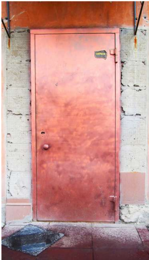
Рис. 19 Вид на вход восточного фасада северного крыла здания
