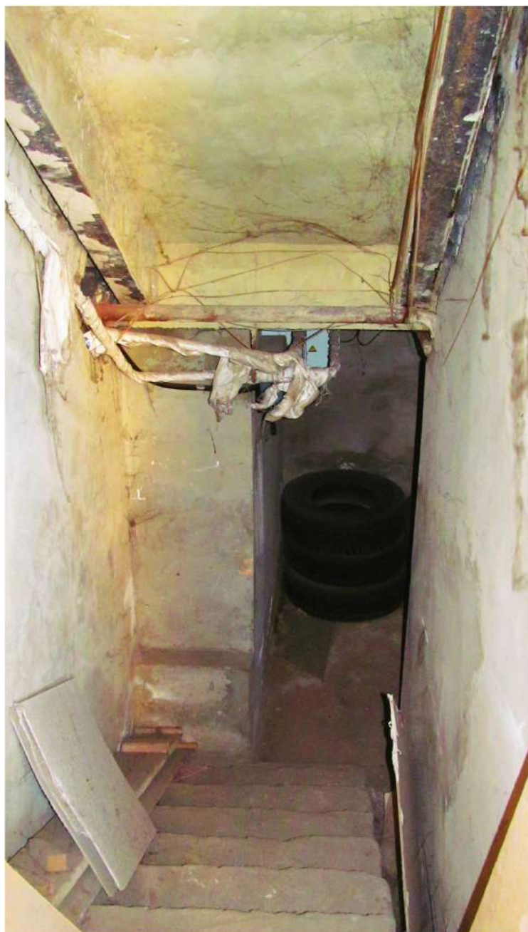
Рис. 49 Вид на спуск в подвал здания
