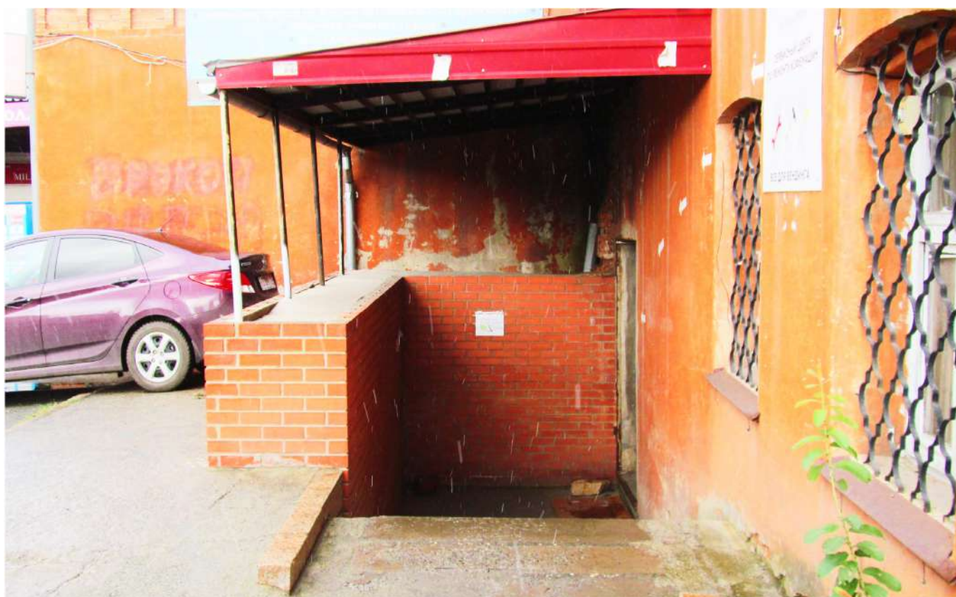
Рис. 16 Вид на спуск в цокольный этаж с юга со стороны дворовой территории
