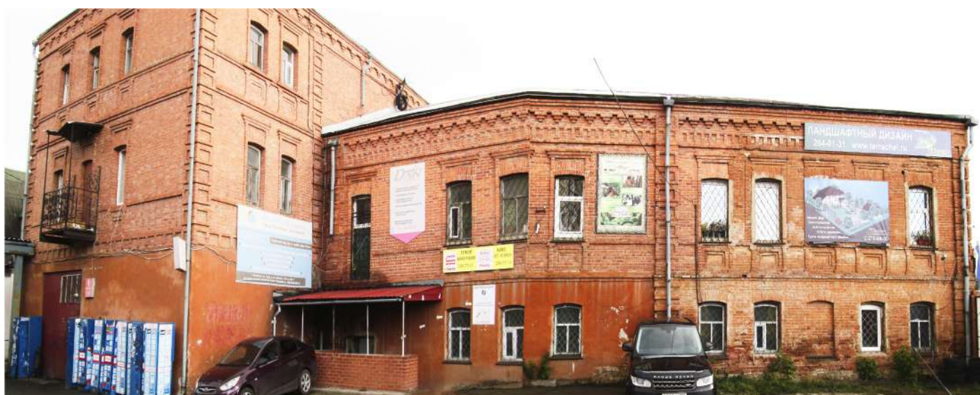
Рис. 11 Вид на западный фасад здания со стороны дворовой территории
