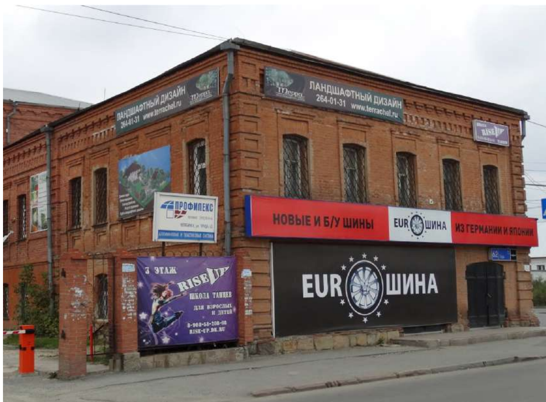
Рис. 70 Западный и южный фасады дома по ул. Труда, 62/ ул.Свободы,14 (Фото - сентябрь 2014 г., автор – Ю.В. Латышев). Ссылка: https://img-fotki.yandex.ru/get/5110/5661614.86/0_a76ad_9443c554_orig .
