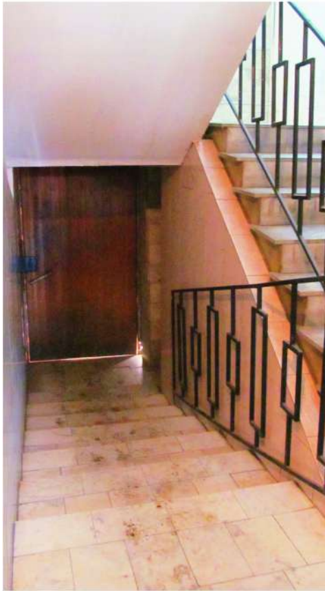
Рис. 42 Вид на интерьер лестничной клетки с 1-го этажа здания
