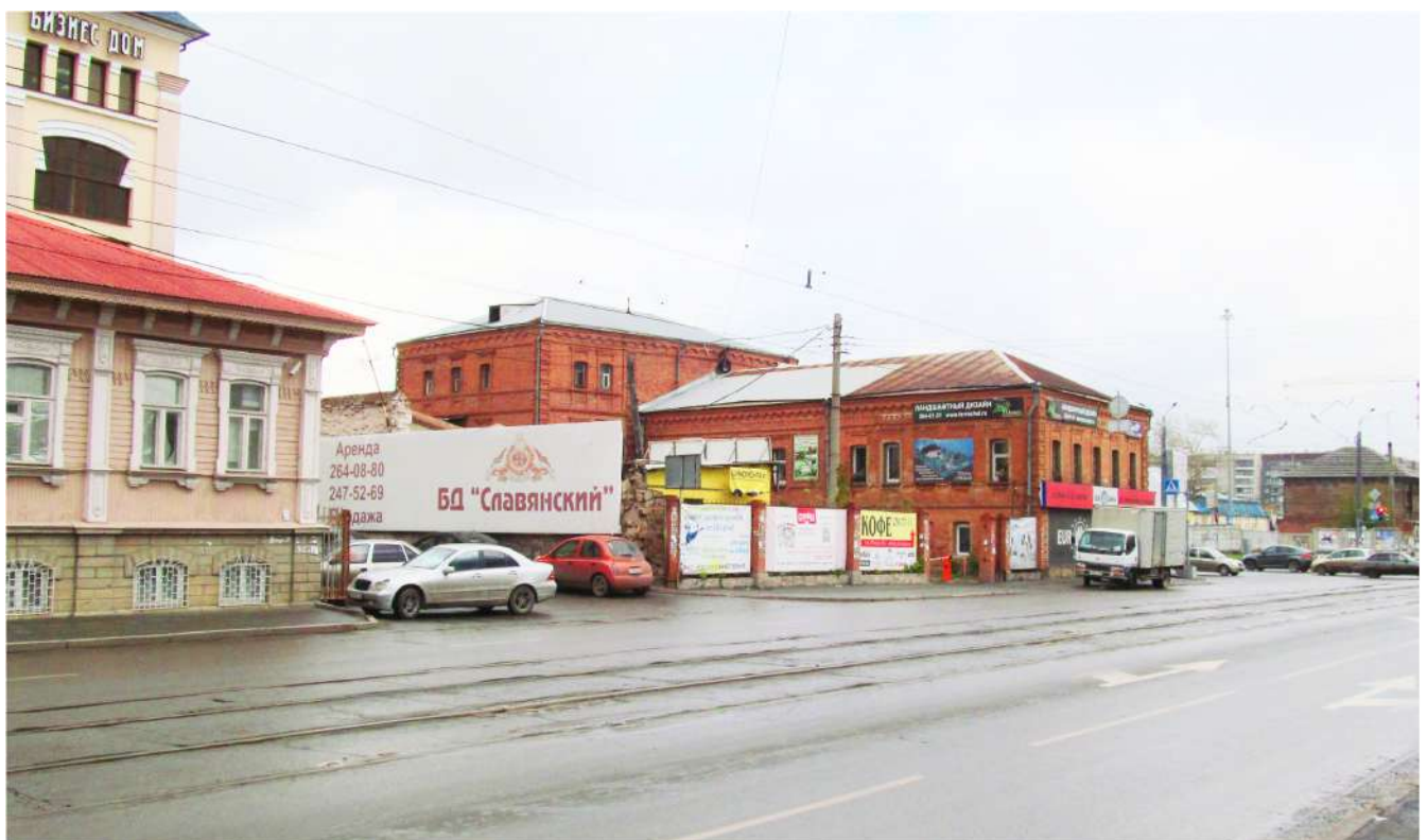
Рис. 5 Вид на здание-памятник с юго-запада со стороны ул. Труда
