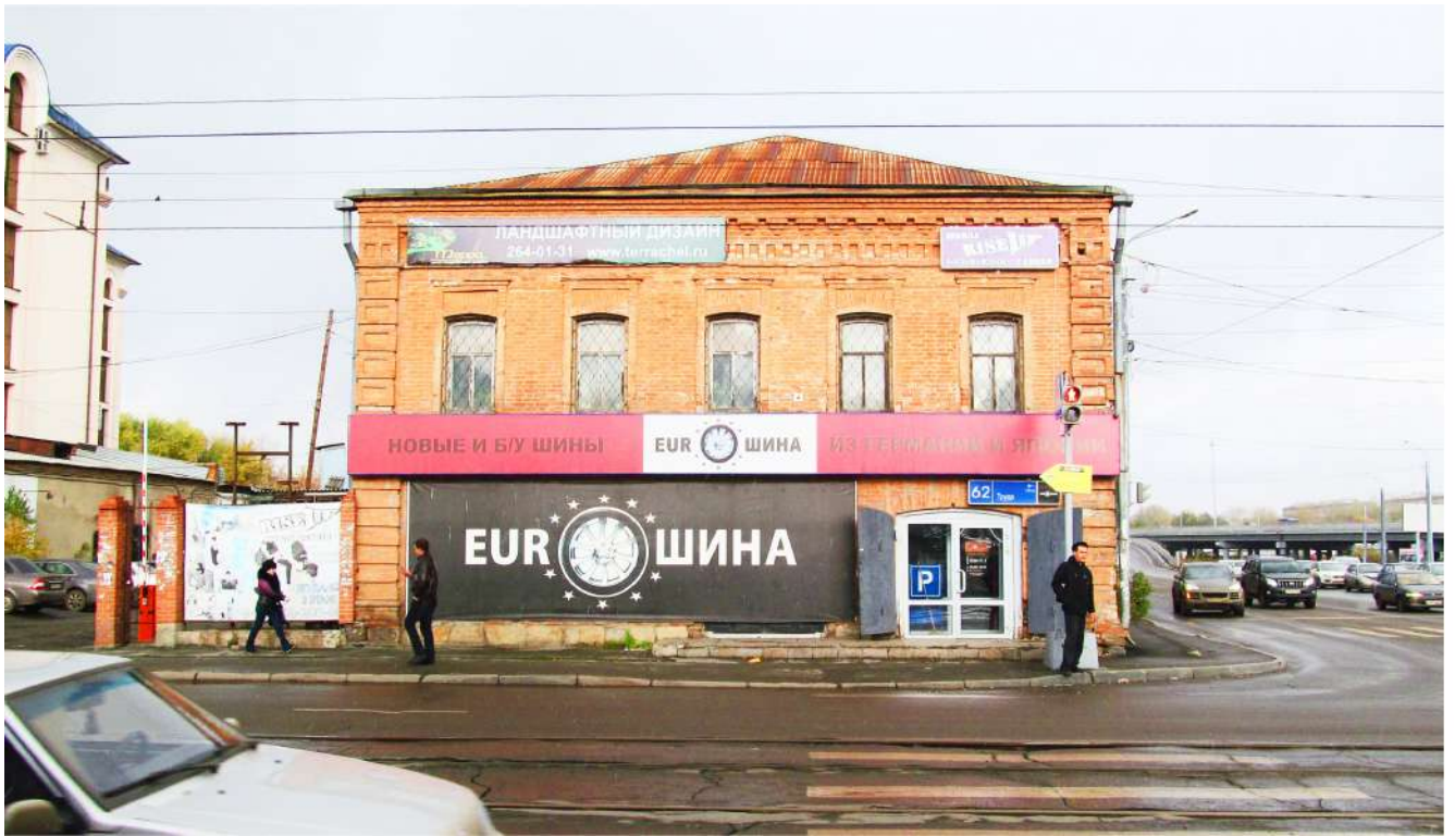
Рис. 8 Вид на главный южный фасад здания со стороны ул. Труда
