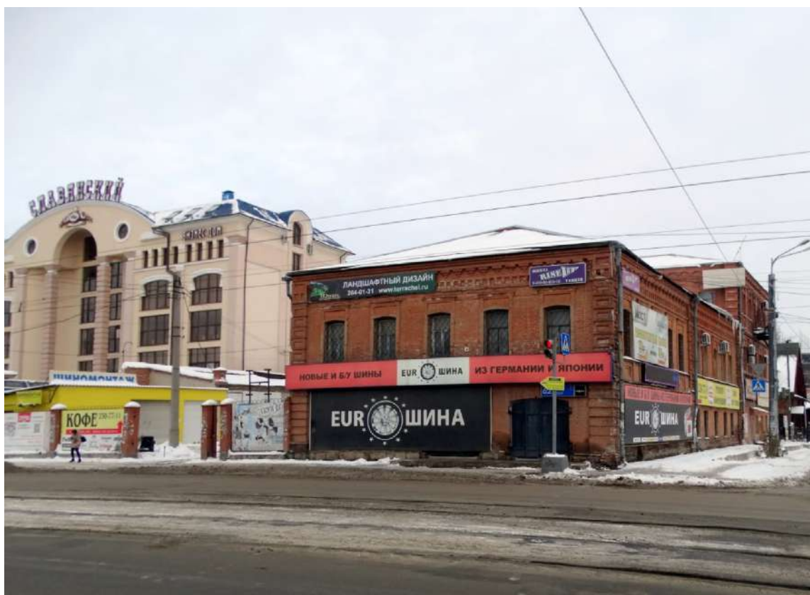
Рис. 56 Улиц Труда, дома 62 и 64а (Фото – ноябрь 2016 г.)// arhistrzh.livejournal.com. Ссылка: https://img-fotki.yandex.ru/get/98645/5661614.155/0_c2004_46f49621_XL.jpg .
