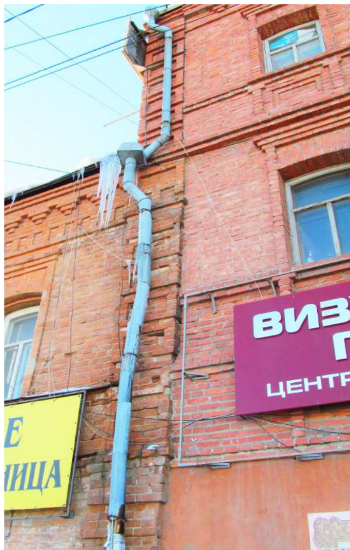
Рис. 29 Вид на место стыка старого здания с пристроем на восточном фасаде здания
