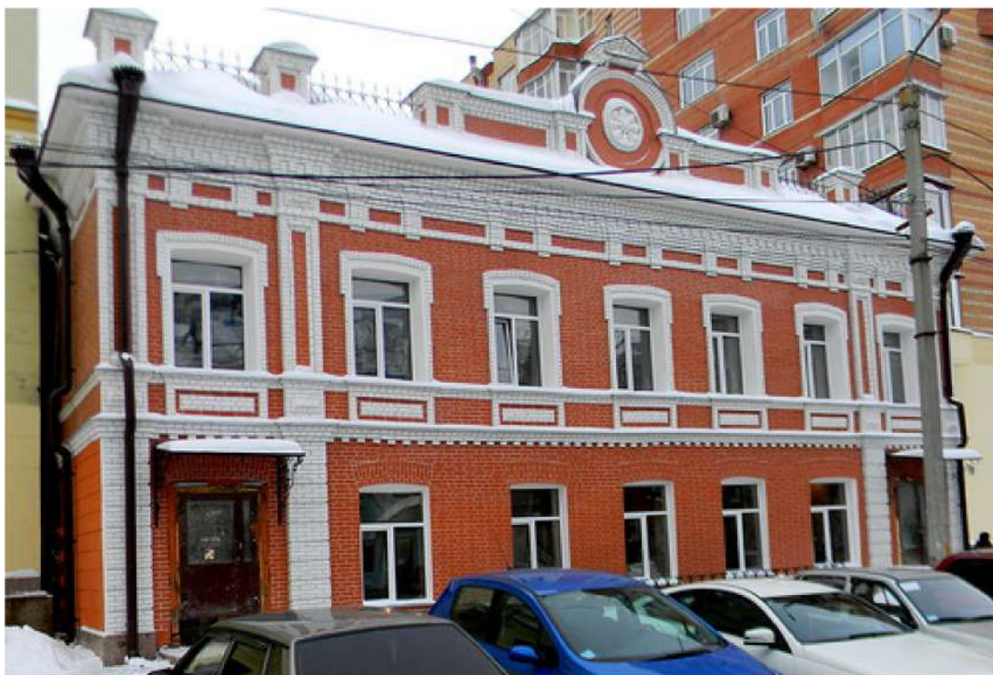
Рис. 79 «Дом жилой» (по «Списку №13») по ул. Коммуны, 81 (кон. XIX в.). Аналогичное композиционное построение фасадов, русты лопаток 1-го этажа, лучковые окна 1-го этажа без декоративного оформления, ширинки под окнами 2-го этажа. В общих чертах совпадает решение прикарнизной зоны.
