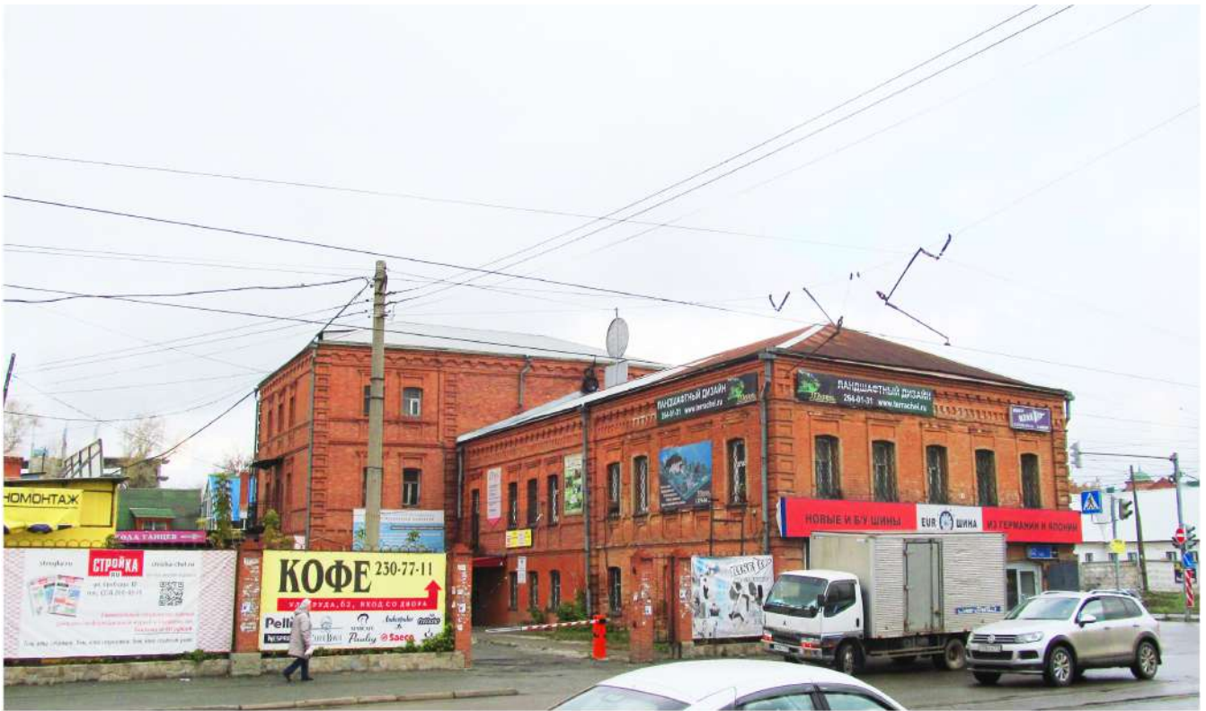
Рис. 6 Вид на здание-памятник с юго-запада со стороны ул. Труда
