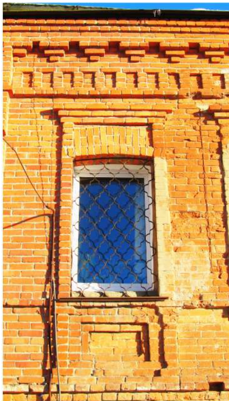
Рис. 21 Вид на окно 2го этажа западного фасада здания
