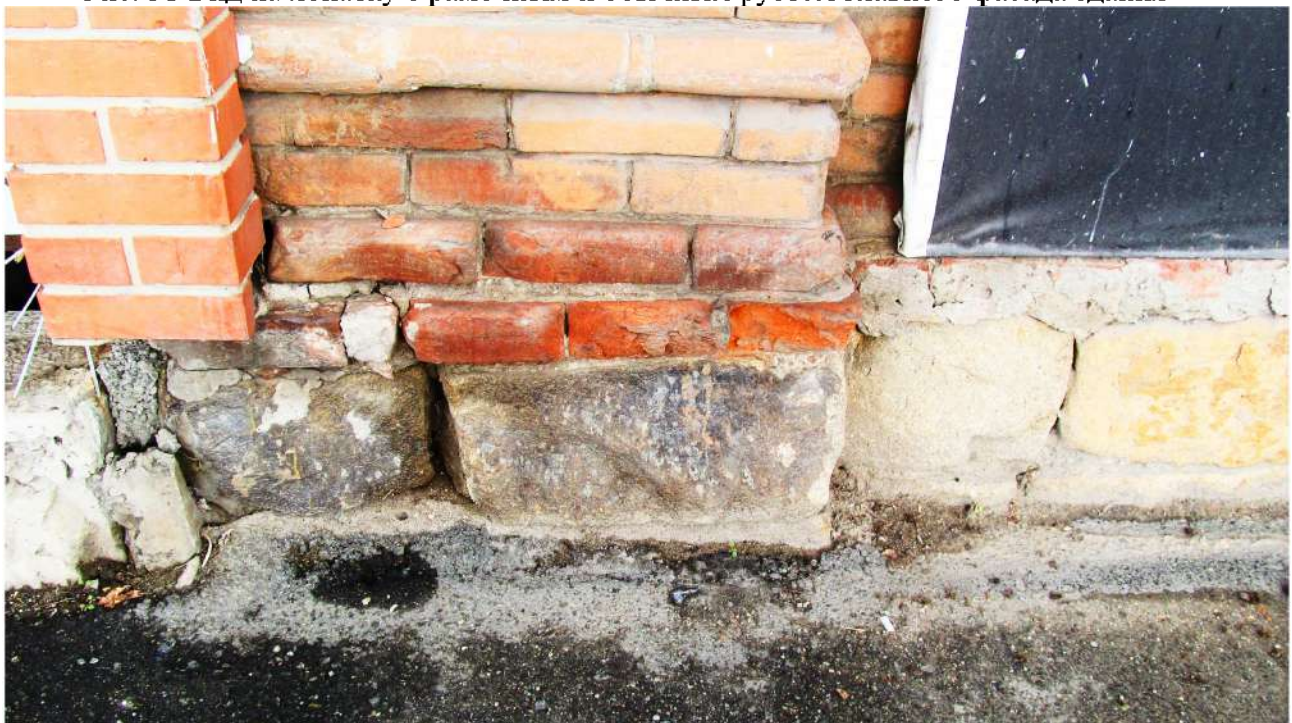
Рис. 32 Вид на цоколь главного фасада здания
