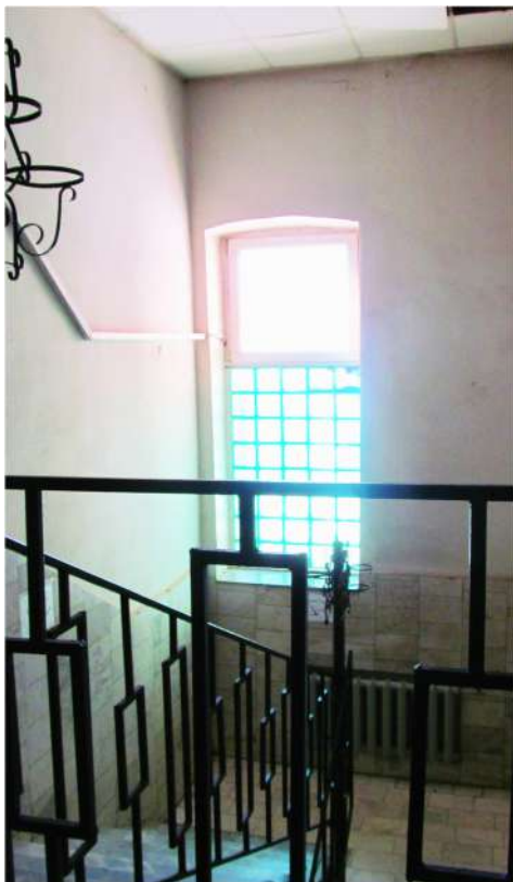
Рис. 44 Вид на интерьер лестничной клетки со 2-го этажа здания
