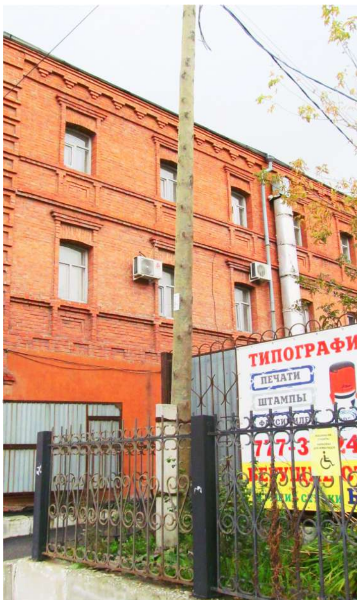
Рис. 10 Вид на северный фасад здания со стороны ул. Свободы
