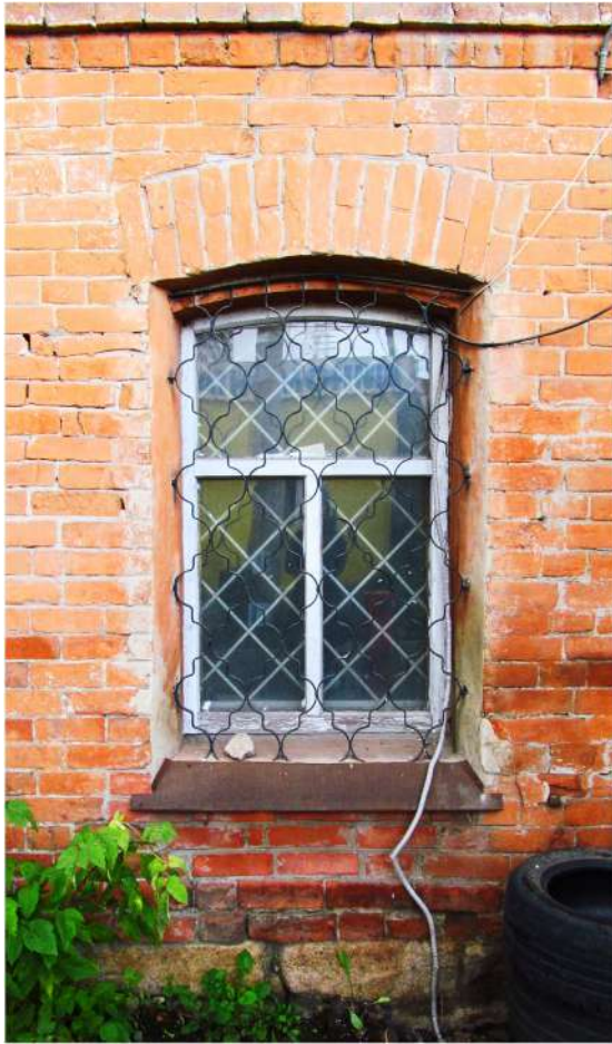
Рис. 23 Вид на окно 1го этажа западного фасада здания
