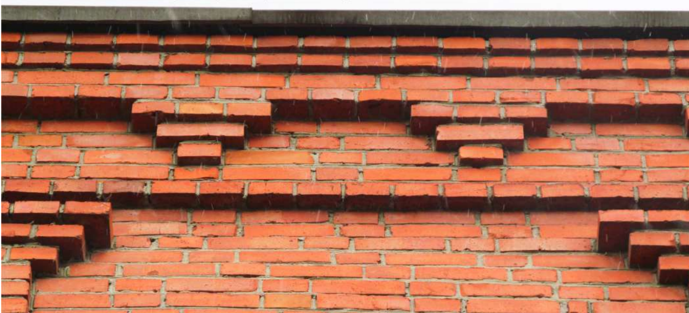
Рис. 28 Вид на карнизную зону северного фасада здания
