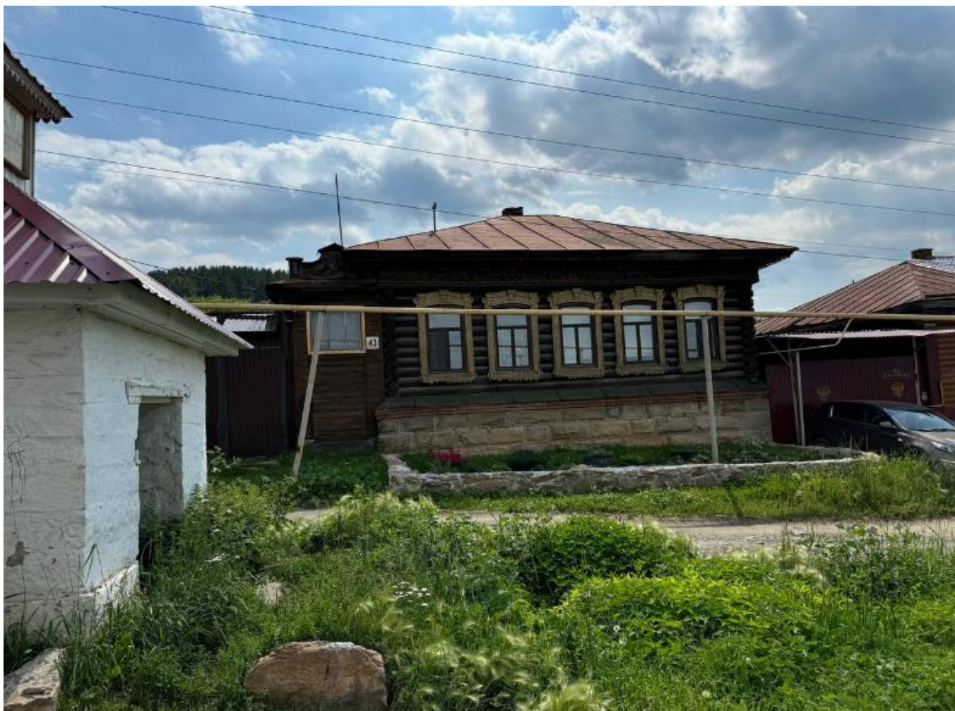
Фото 1. Вид на выявленный объект культурного наследия «Усадьба 1-этажная деревянная на высоком цоколе», расположенный по адресу: Челябинская область, Миасский городской округ, г. Миасс, ул. Мельничная, 43.
