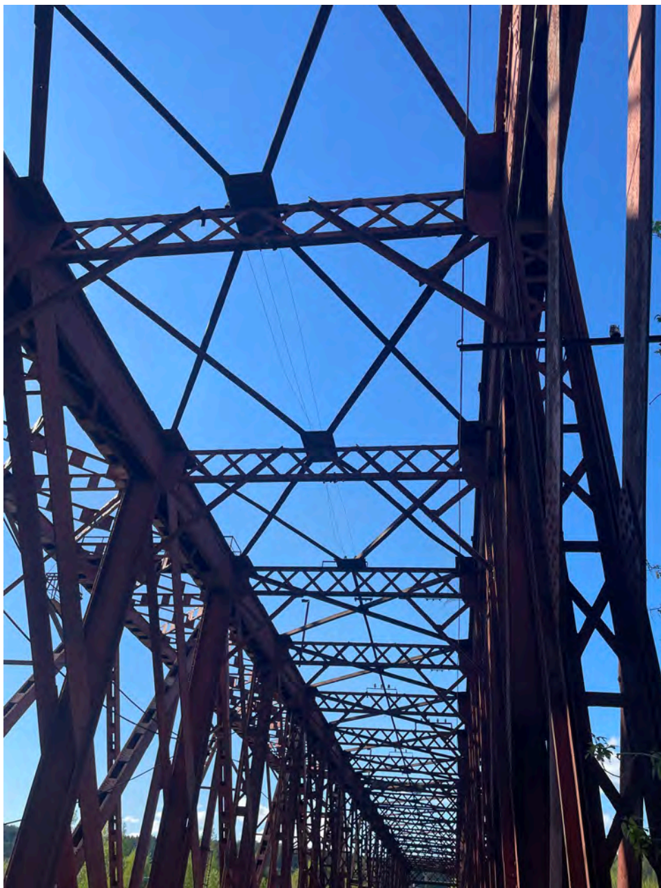
Фото.13. Вид на «Французский мост» расположенный по адресу: Усть-Катавский городской округ, г. Усть-Катав, р. Юрюзань, между УКВЗ и Пост-заводом.
