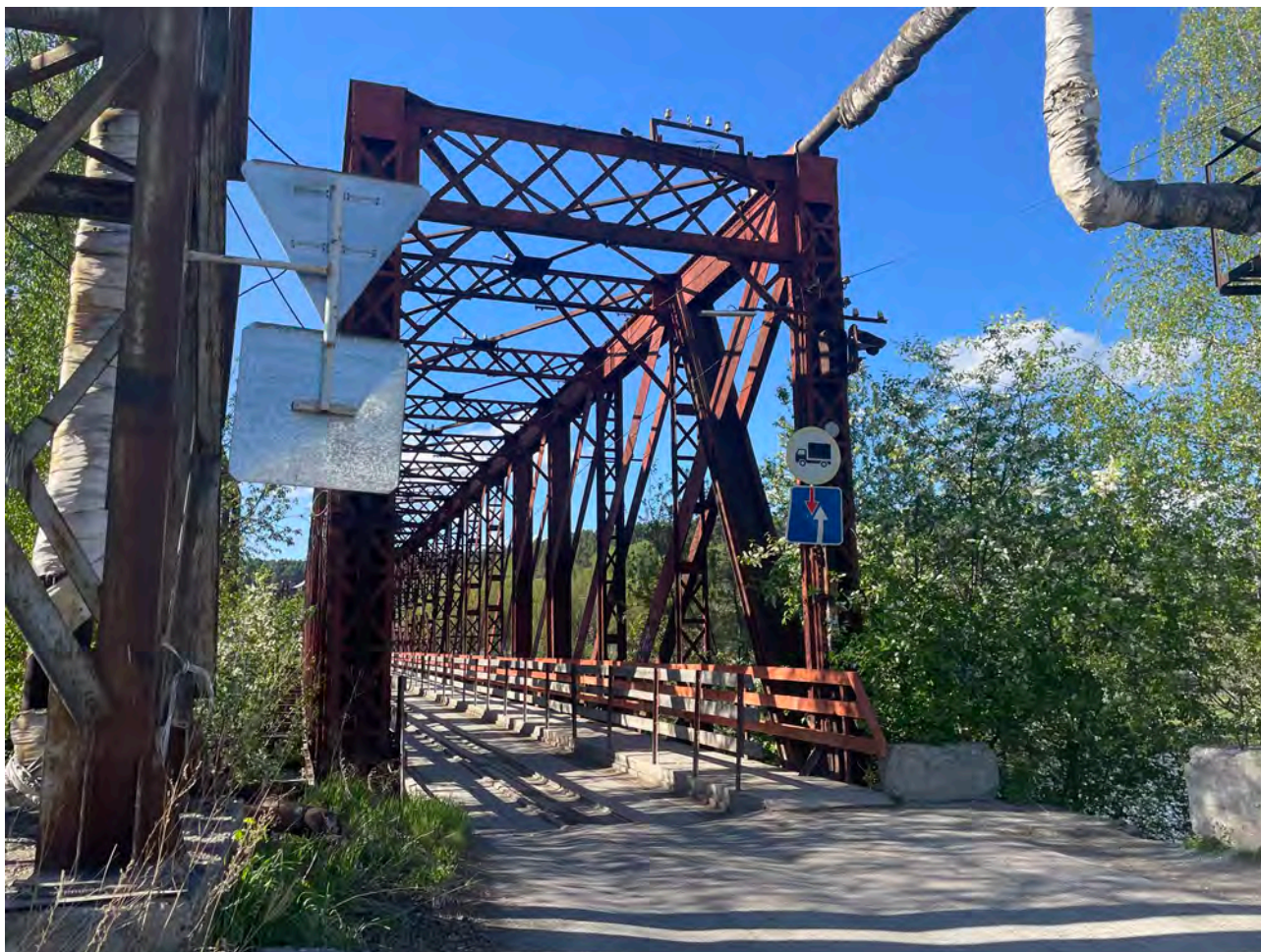
Фото.17. Вид на «Французский мост» расположенный по адресу: Усть-Катавский городской округ, г. Усть-Катав, р. Юрюзань, между УКВЗ и Пост-заводом.
