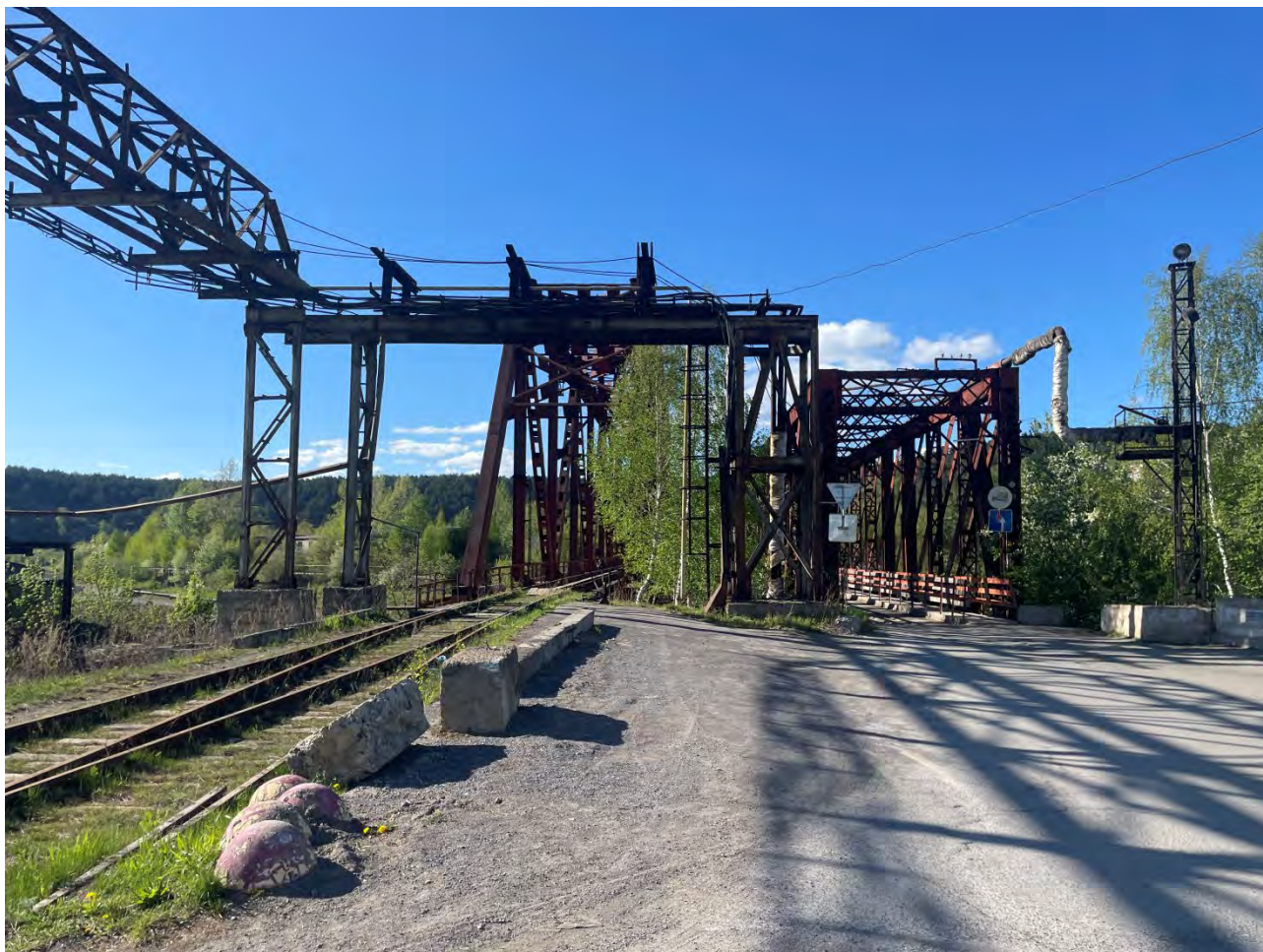
Фото.18. Вид на «Французский мост» расположенный по адресу: Усть-Катавский городской округ, г. Усть-Катав, р. Юрюзань, между УКВЗ и Пост-заводом.
