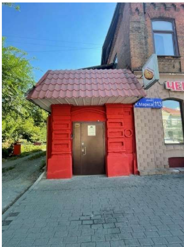
Рис. 8. Исторический вход на лестницу на второй этаж
