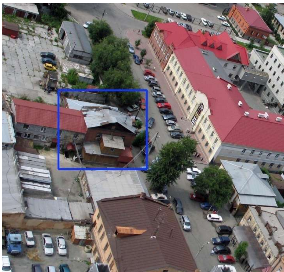
Рис. 4. Местоположение объекта на ул. Маркса (синий контур)
