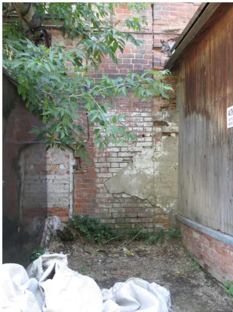
Рис. 10. Боковой восточный фасад. Стык с историческим пристроем (литера АЗ)
