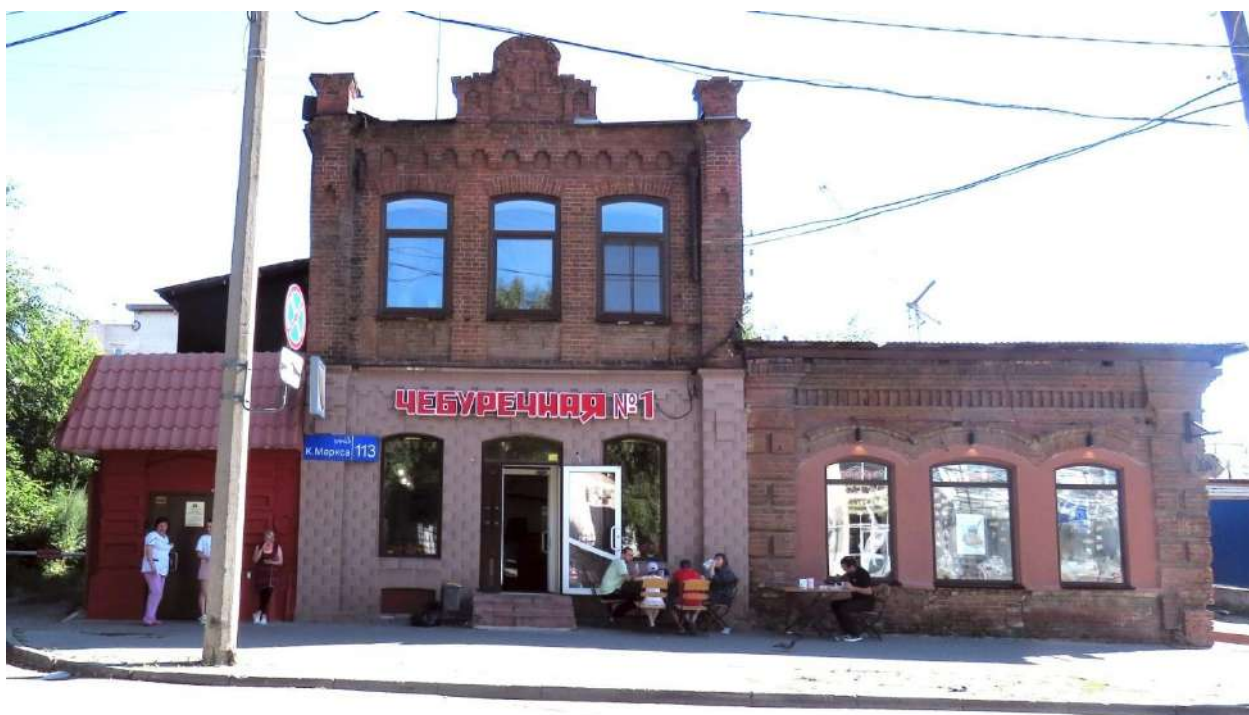
Рис. 2. Главный, северный фасад
