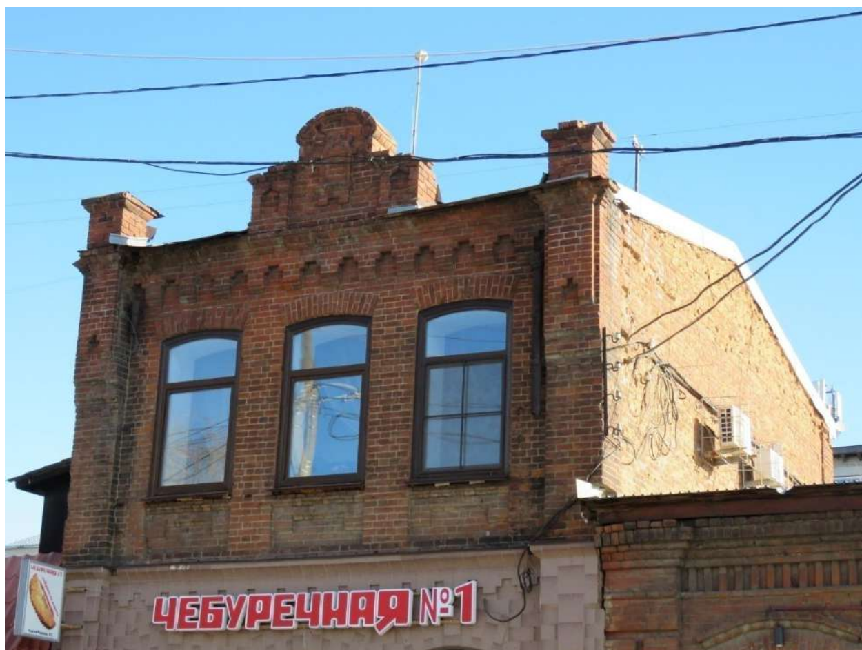
Рис. 4 а, б. Фрагмент главного фасада. Второй этаж
