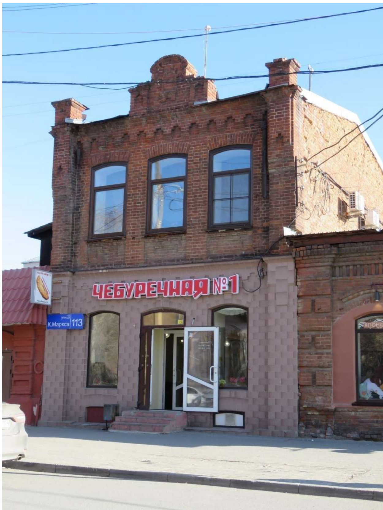
Рис. 3. Главный северный фасад основного объема
