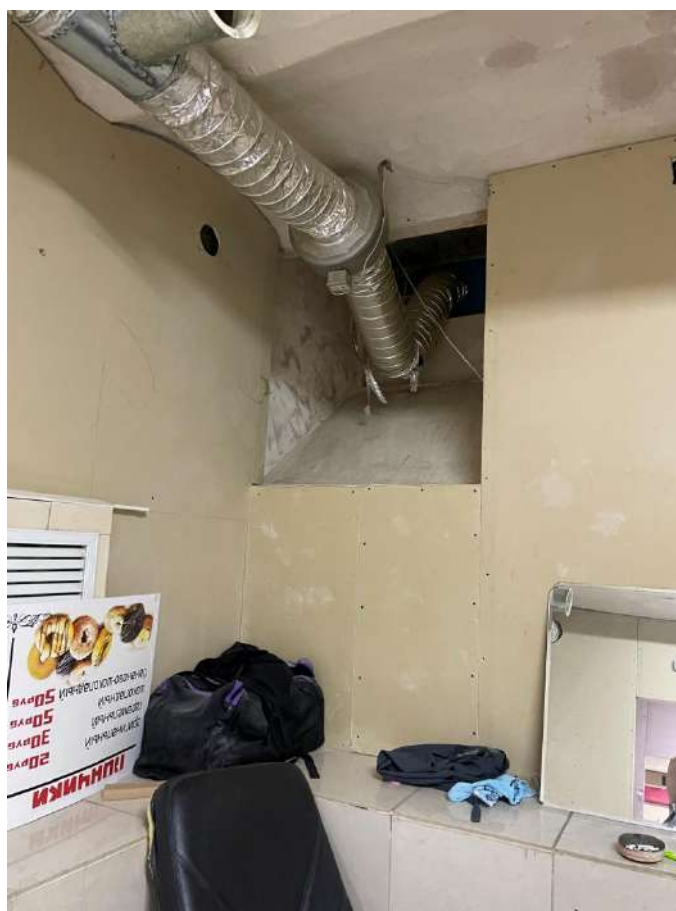
Рис. 13 а, б. Оконные проемы подвального этажа
