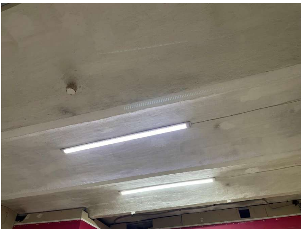
Рис. 14 а, б. Сводчатое перекрытие подвала
