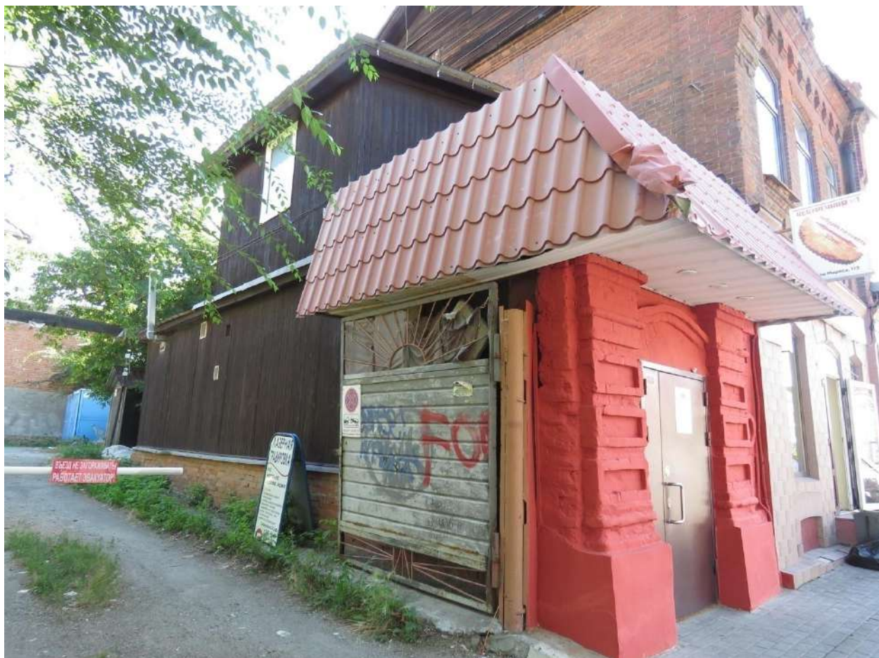
Рис. 7. Боковой, восточный фасад. Вид с северо-востока
