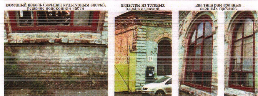
— фасады, элементы фасадов, подлежащие обязательному сохранению
