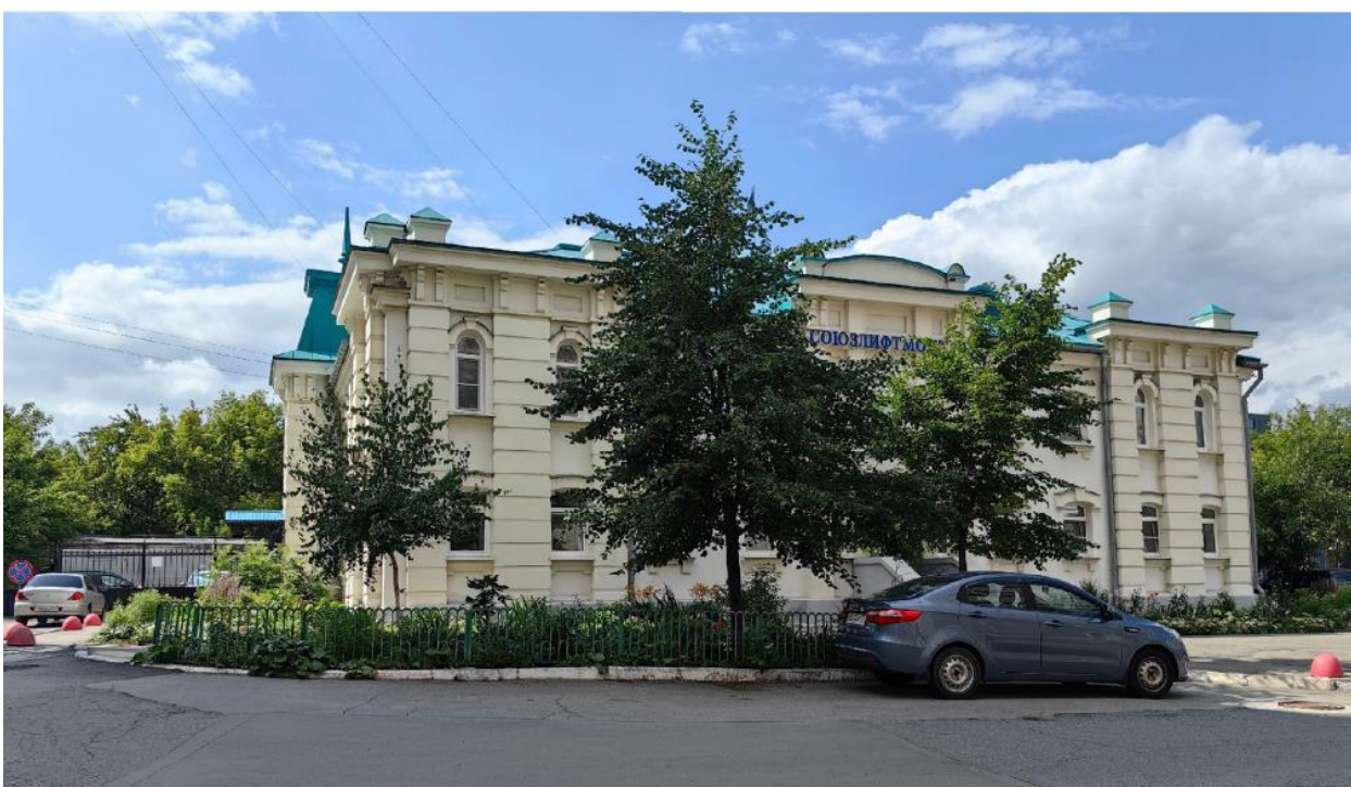
Фото 12. Видовая точка №12. Вид с востока с территории проезда
