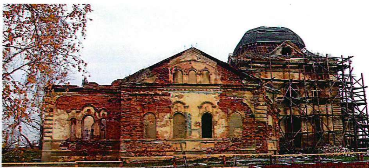
Рис. 5. Южный фасад Объекта по состоянию на 2017 г.
