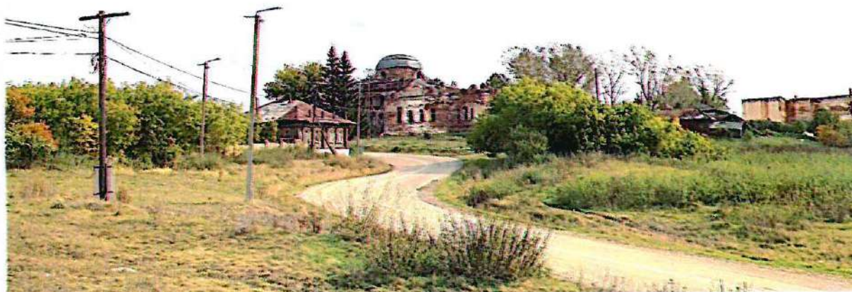
Рис. 2. Общий вид Объекта в окружающей застройке.
