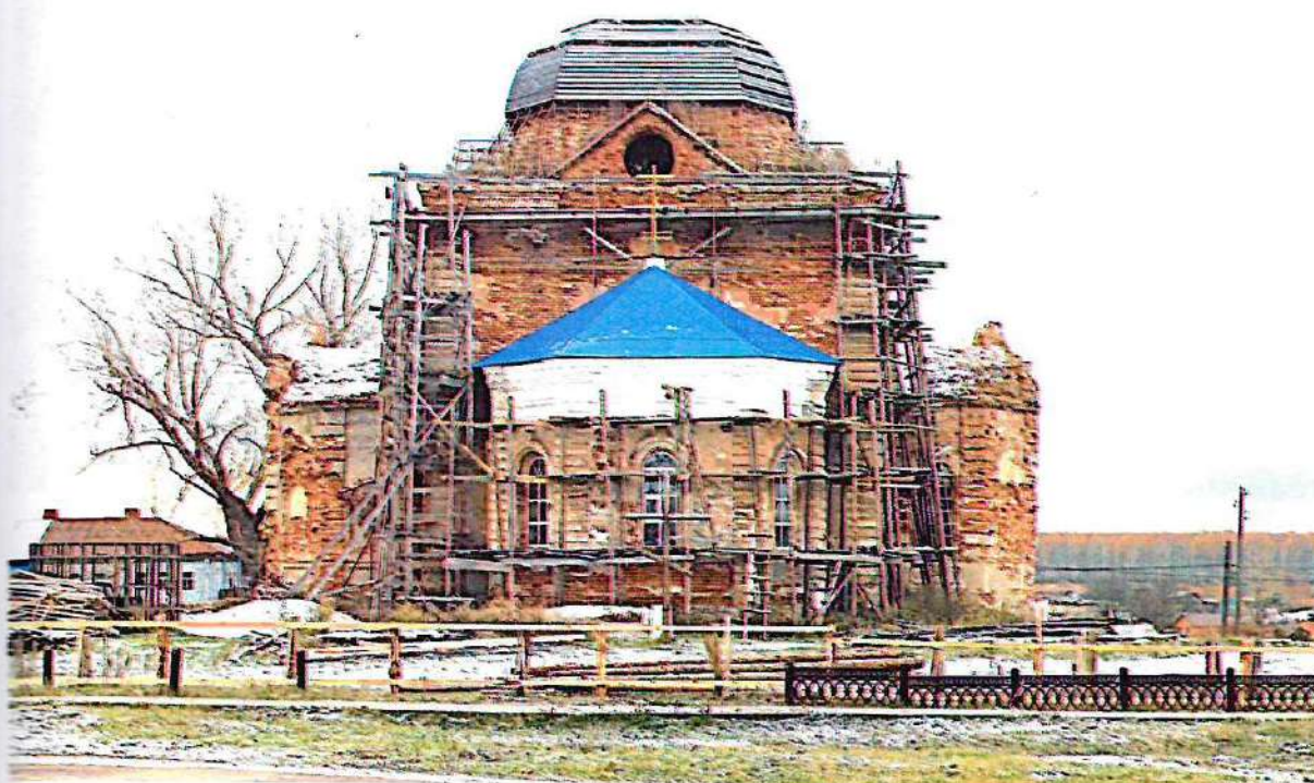
Рис. 6. Восточный фасад Объекта по состоянию на 2017 г.
