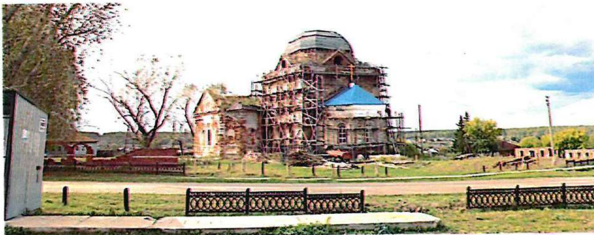
Рис. 1. Общий вид Объекта в окружающей застройке.
