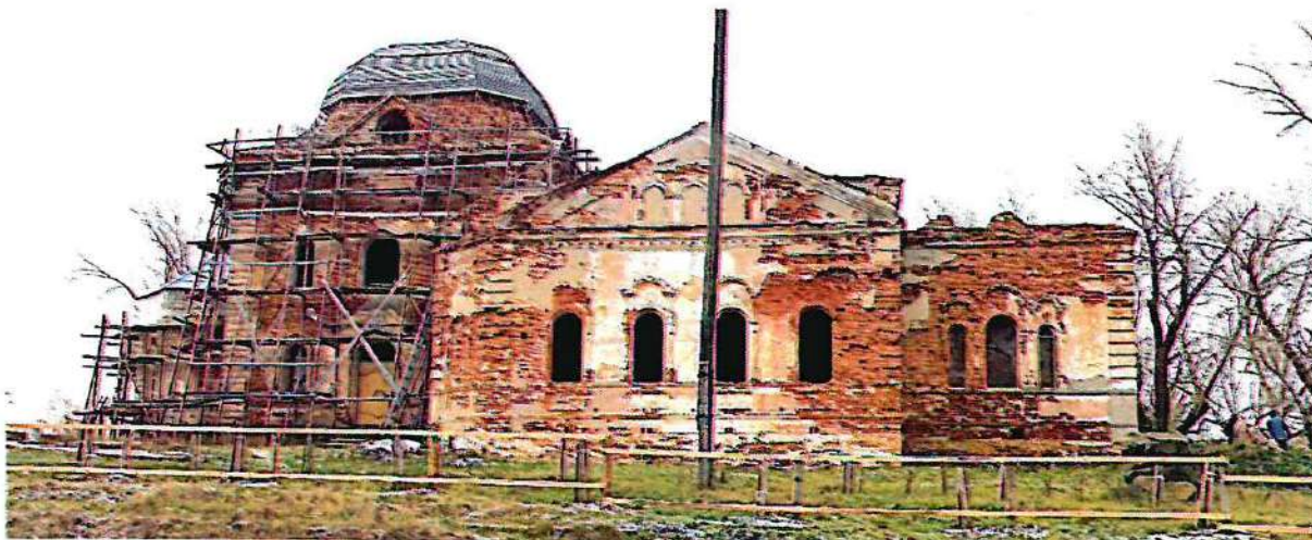
Рис. 4. Северный фасад Объекта по состоянию на 2017 г.
