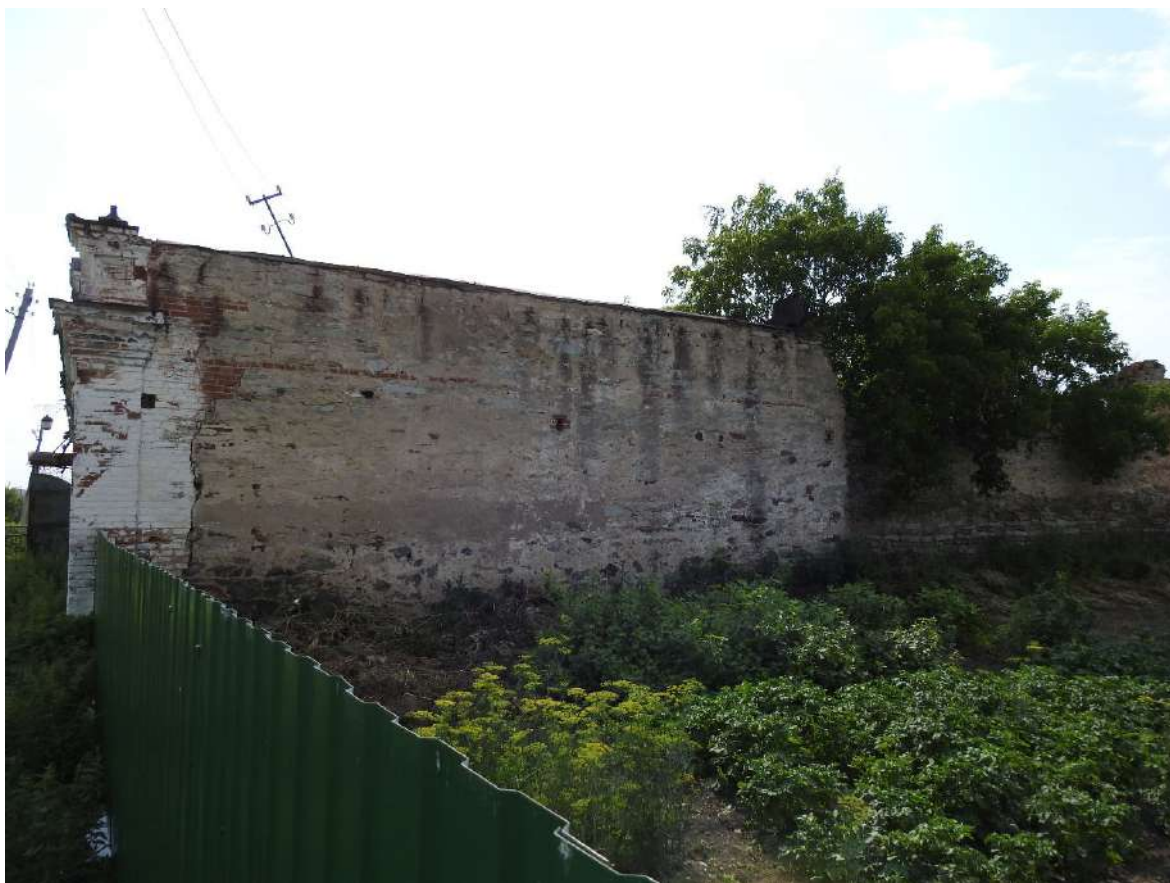
Фото 16. Вид на западный фасад Объекта.
