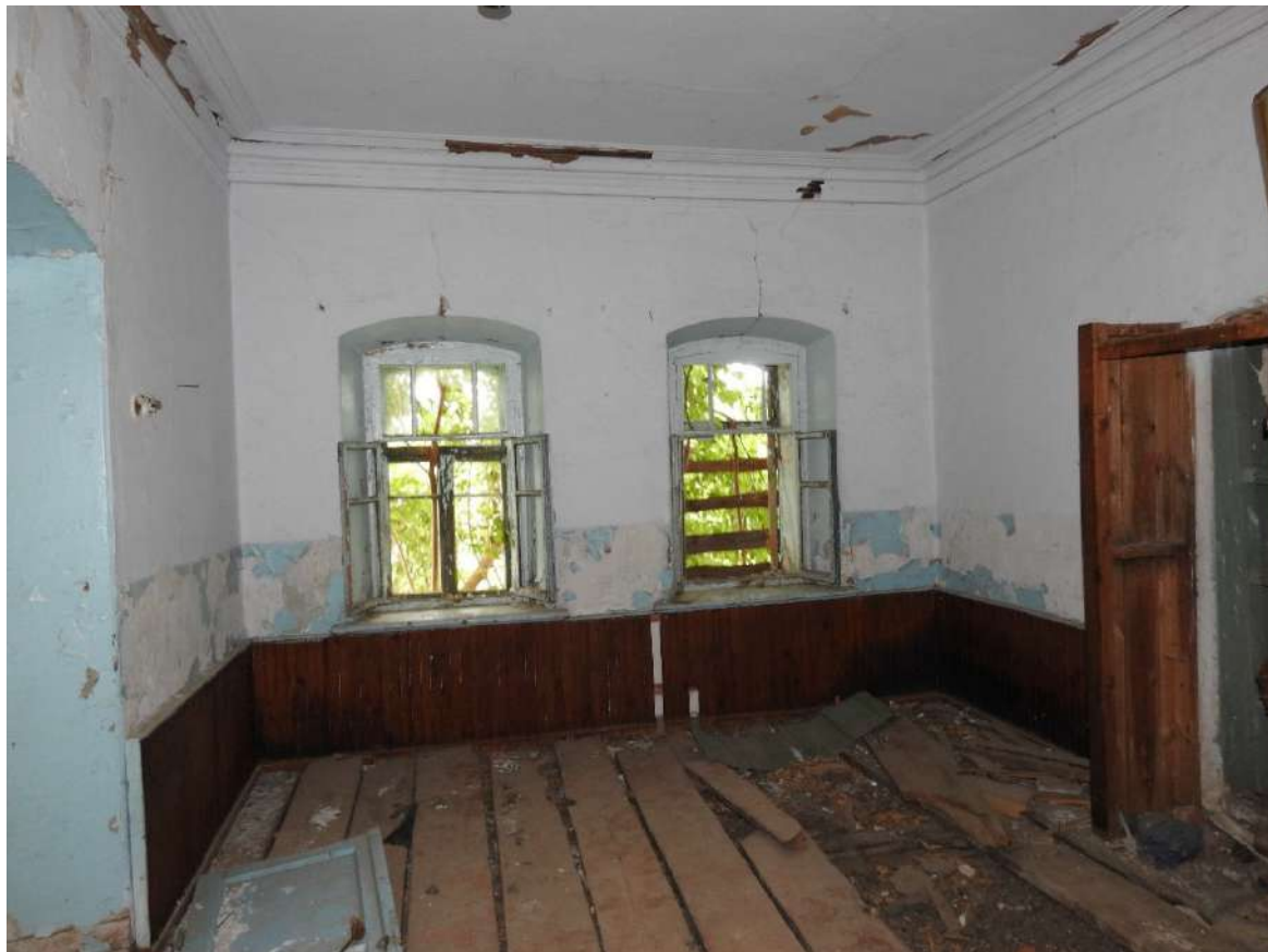
Фото 33. Фрагмент внутреннего интерьера первого этажа Объекта (дом Панковых)
