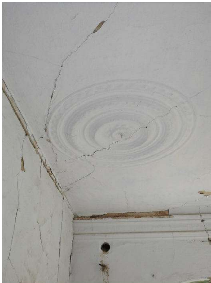
Фото 34. Потолочная розетка на первом этаже Объекта (дом Панковых).
