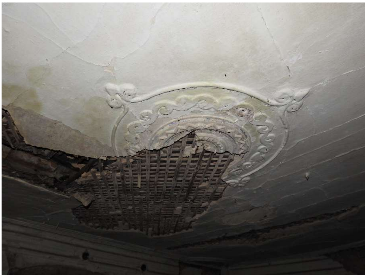
Фото 30. Фрагмент потолочной розетки в помещении цокольного этажа Объекта.
