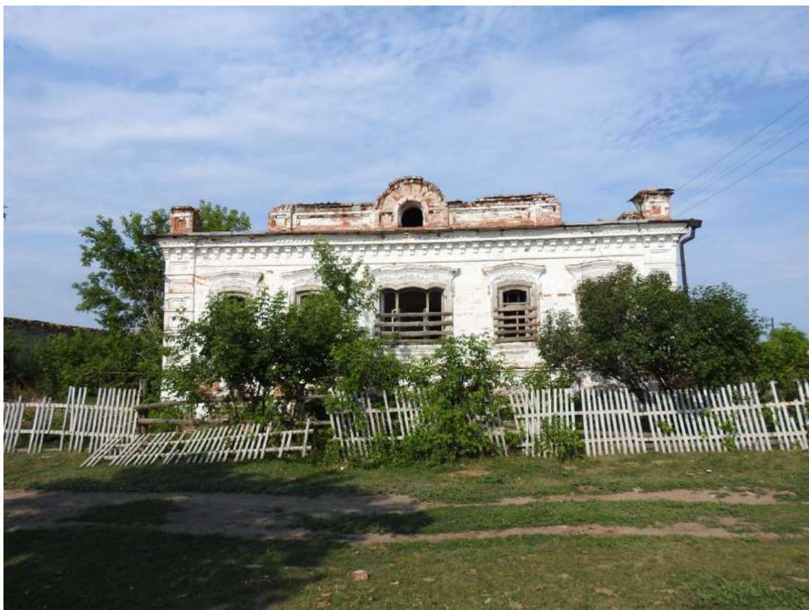
Фото 10. Вид на восточный фасад Объекта.
