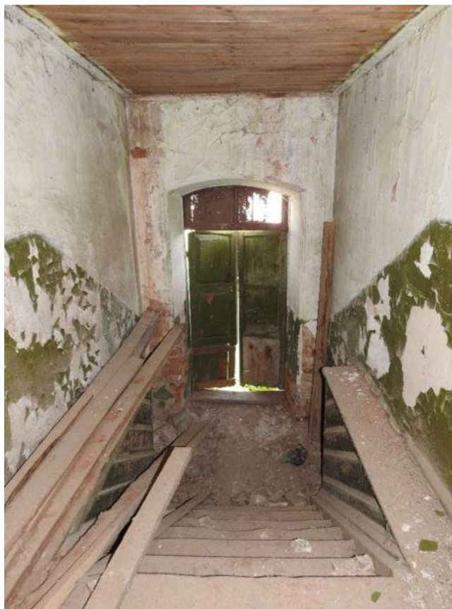
Фото 40. Лестничный марш со стороны центрального входа в Объект (дом Панковых).
