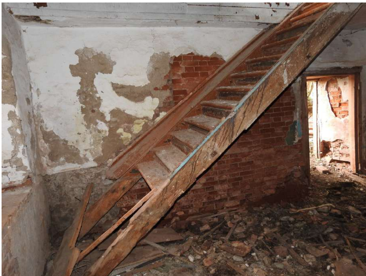
Фото 31. Вид на деревянную лестницу в цокольном этаже Объекта.
