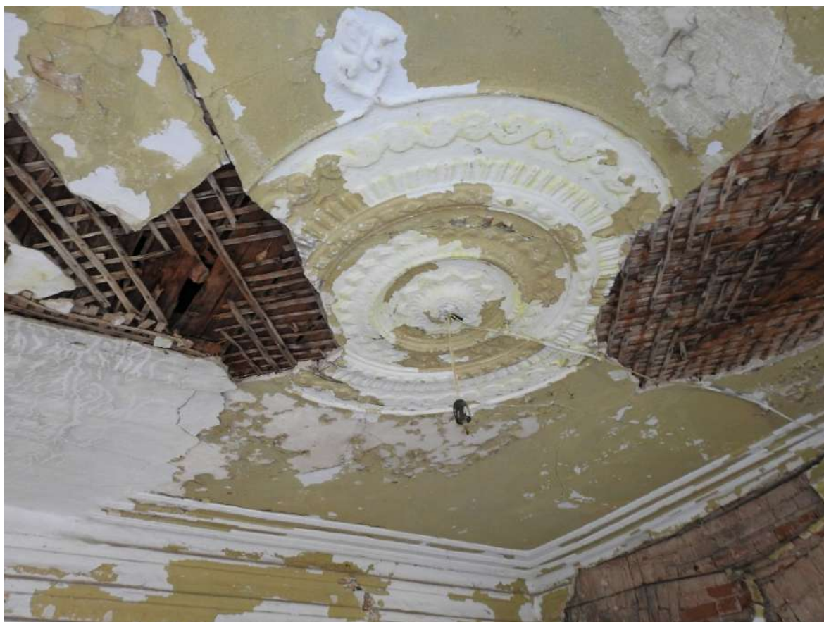
Фото 38. Потолочная розетка на первом этаже Объекта (дом Панковых).
