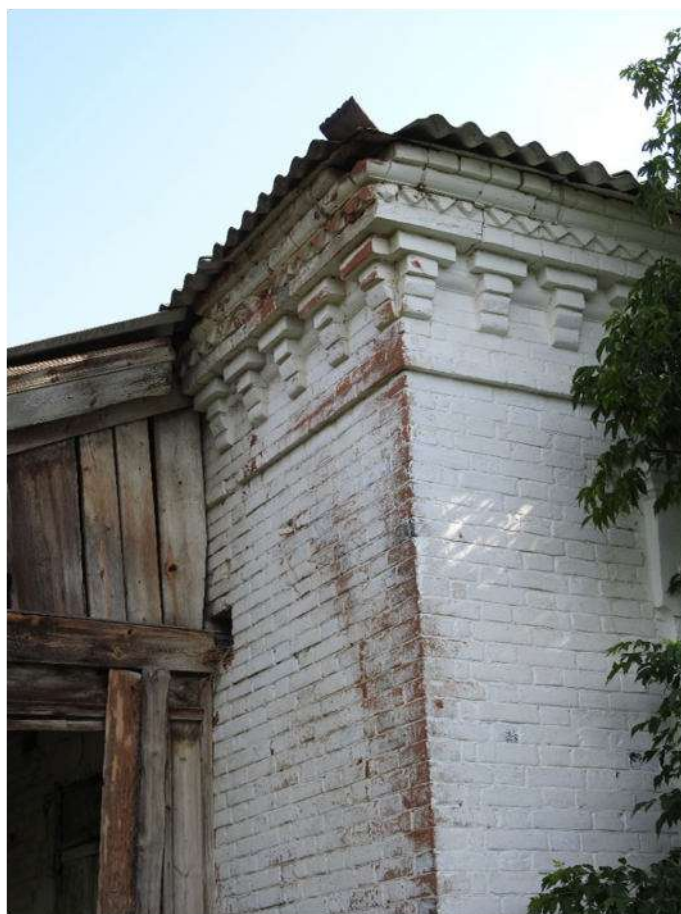
Фото 15. Фрагмент карниза южного и западного фасадов Объекта со стороны двора.
