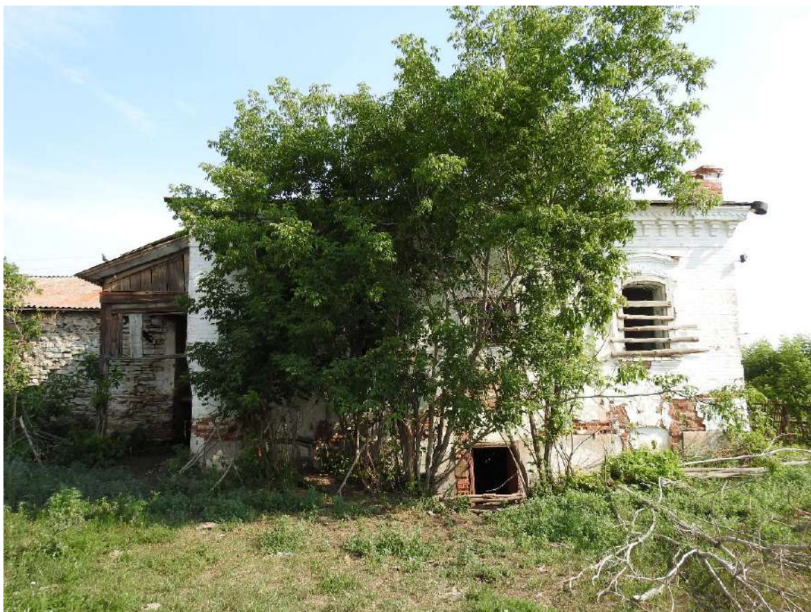
Фото 14. Вид на южный фасад Объекта.
