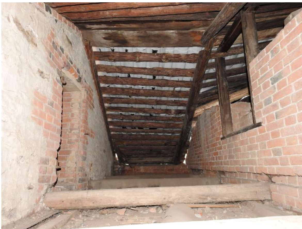
Фото 45. Вид на фрагмент конструкции крыши Объекта (дом Панковых).
