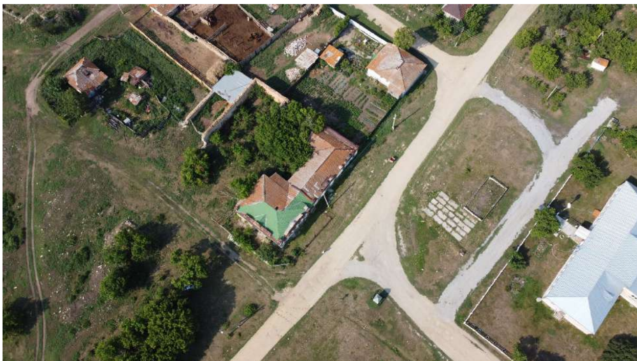
Фото 4. Вид на Объект, расположенный по красной линии ул. Красногвардейской. Фото сделано с квадрокоптера.
