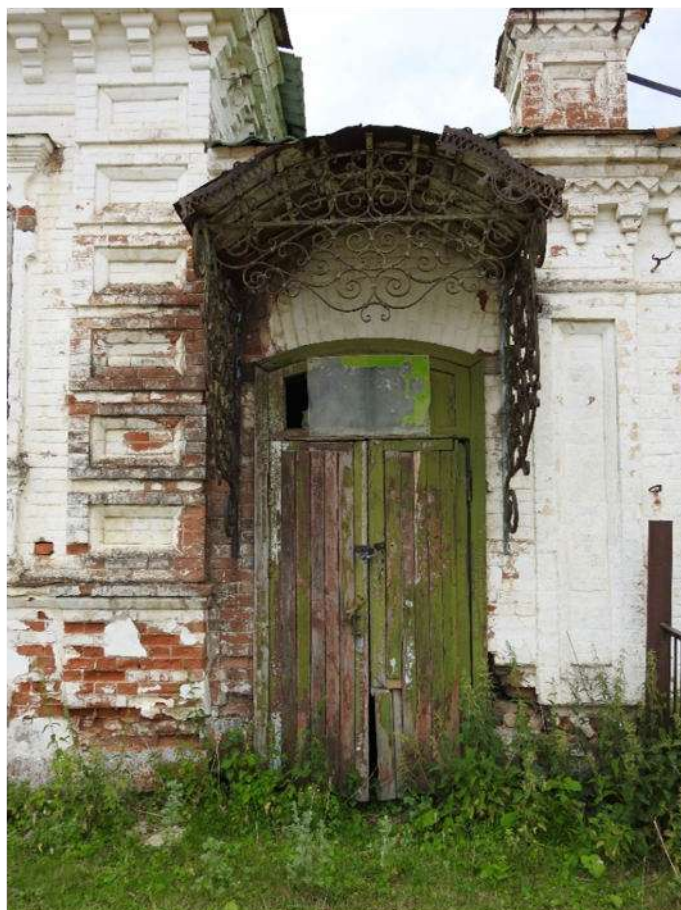
Фото 21. Входная группа северного парадного фасада в дом Панковых.
