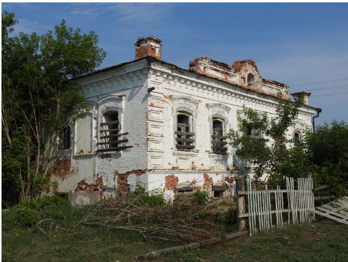
Фото 12. Вид на восточный и южный фасады Объекта.
