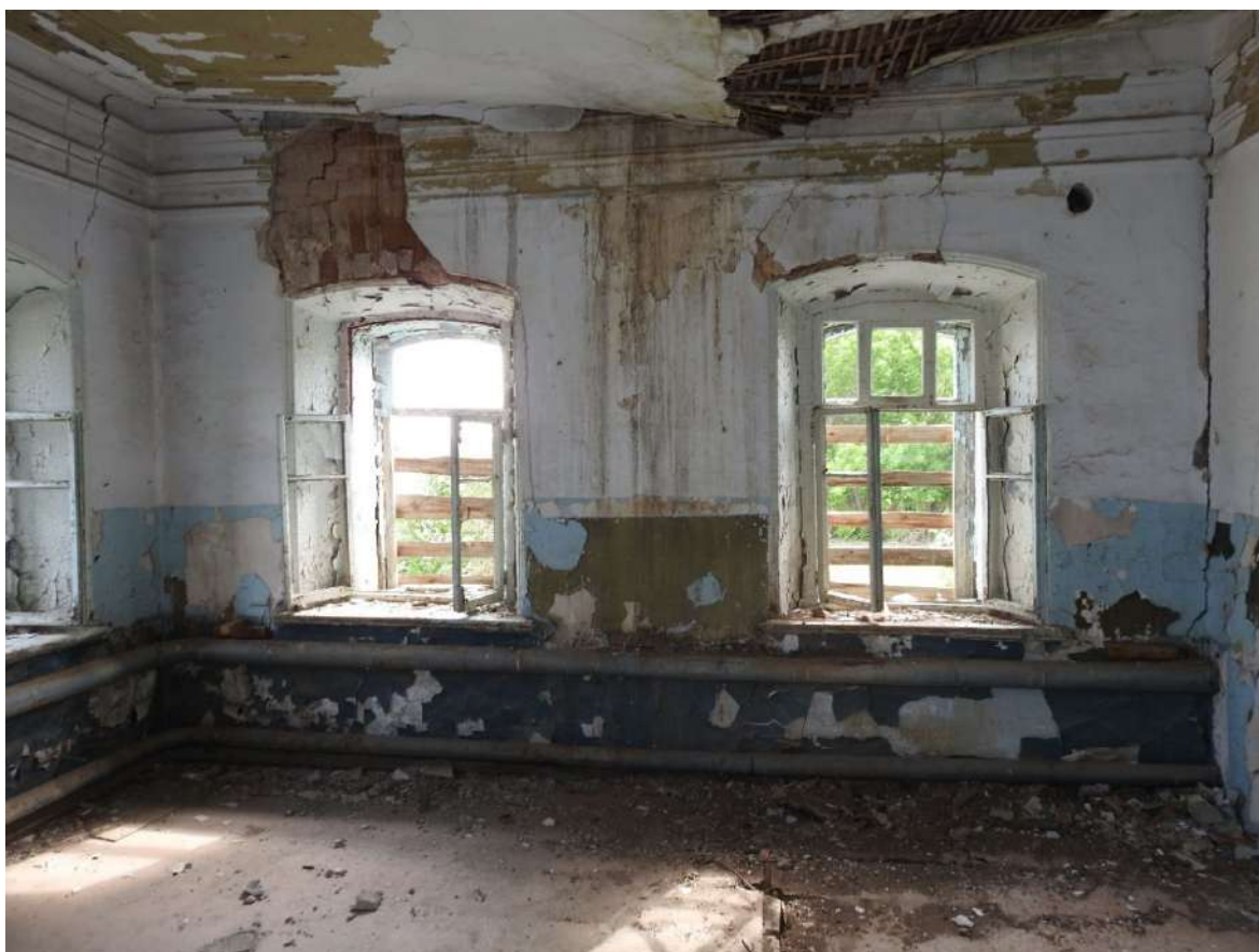
Фото 37. Фрагмент внутреннего интерьера первого этажа Объекта (дом Панковых).
