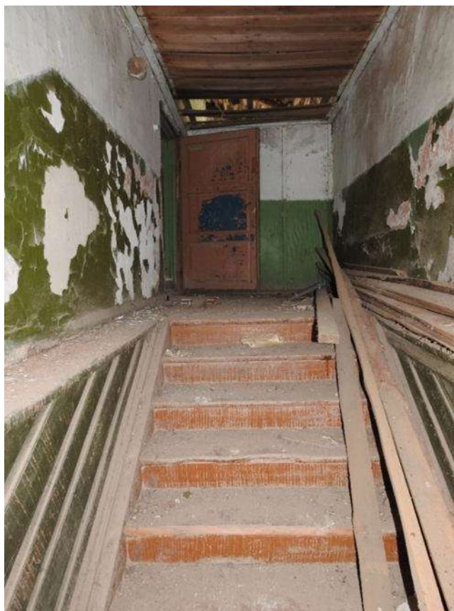
Фото 41. Лестничный марш со стороны центрального входа в Объект (дом Панковых).
