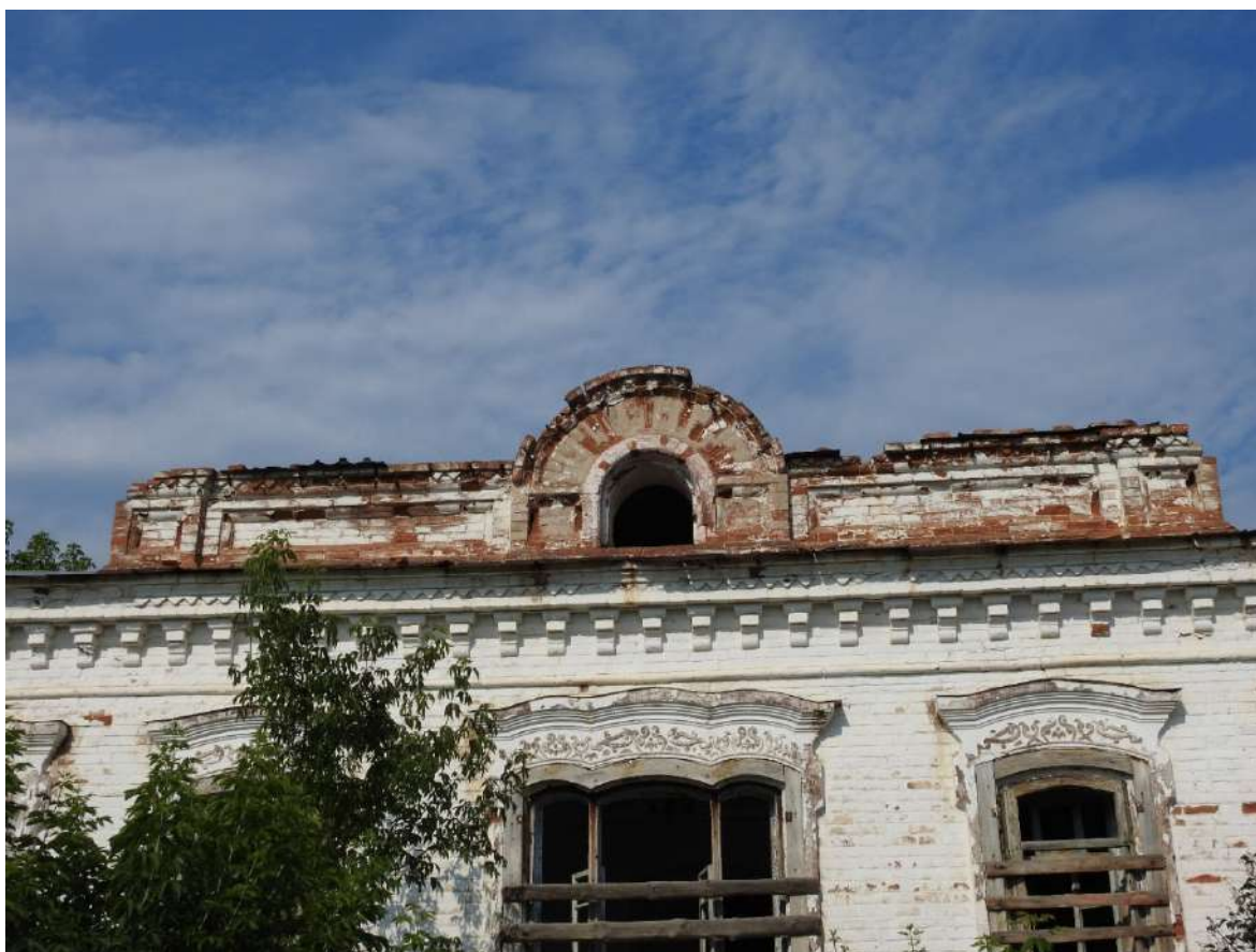
Фото 11. Фрагмент восточного фасада Объекта.
