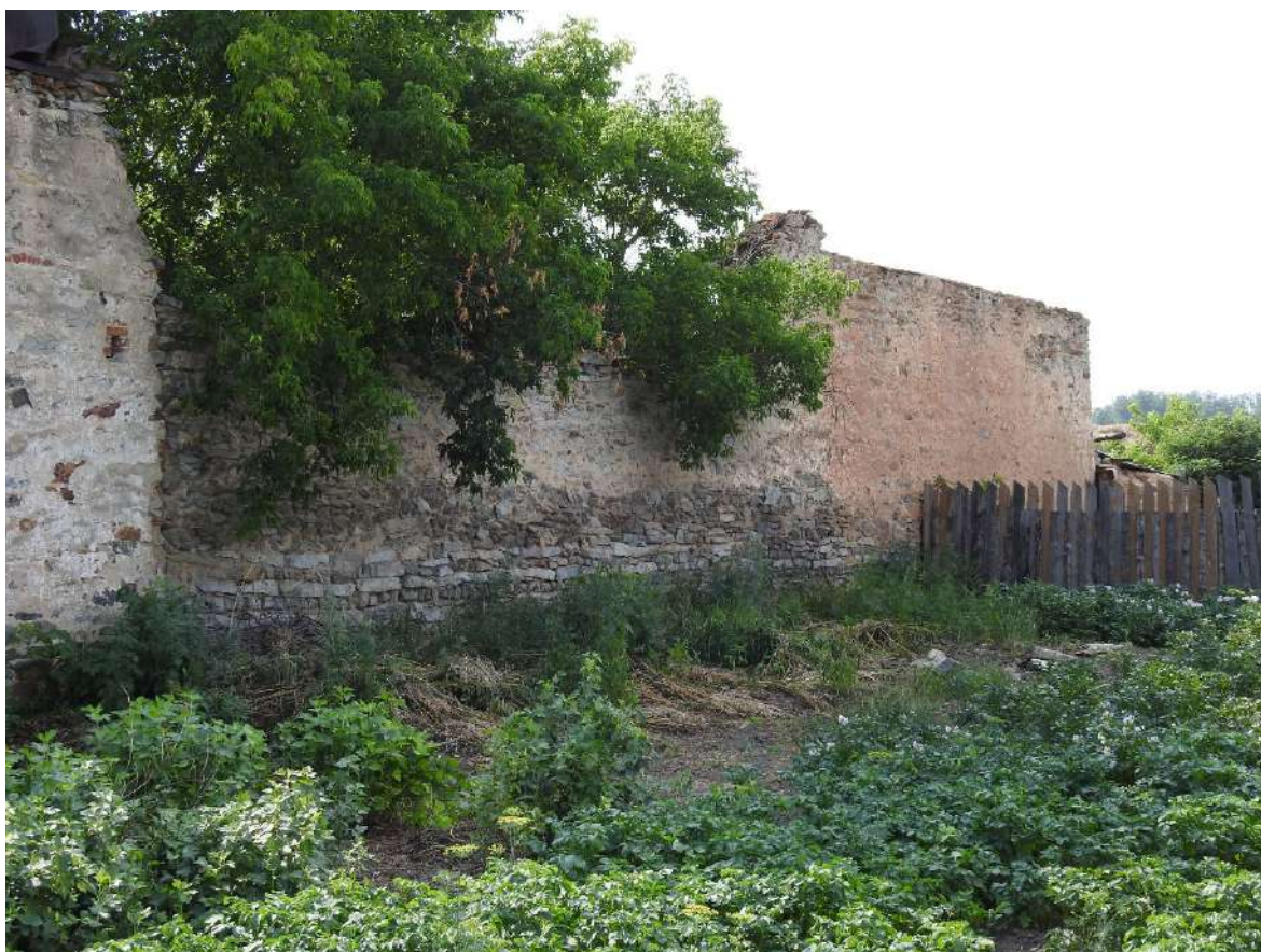
Фото 17. Фрагмент западного фасада Объекта.
