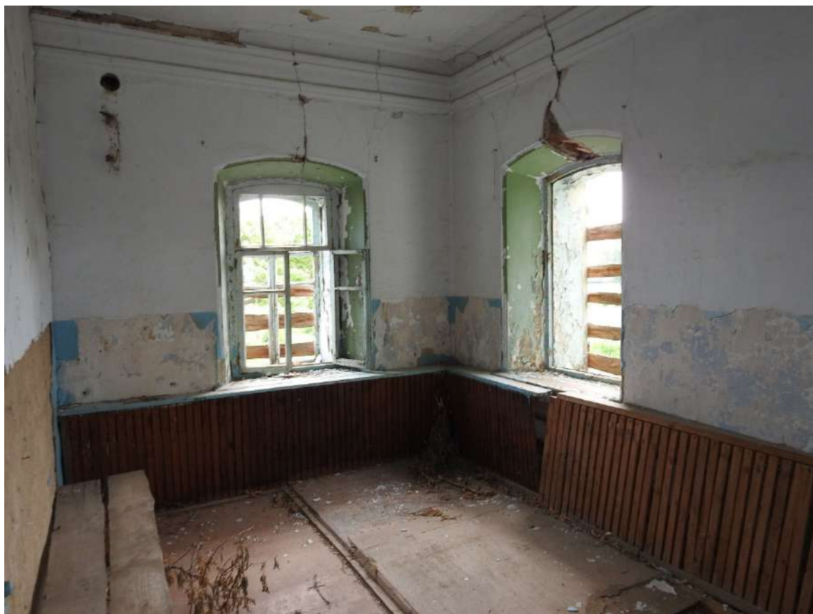
Фото 32. Фрагмент внутреннего интерьера первого этажа Объекта (дом Панковых).
