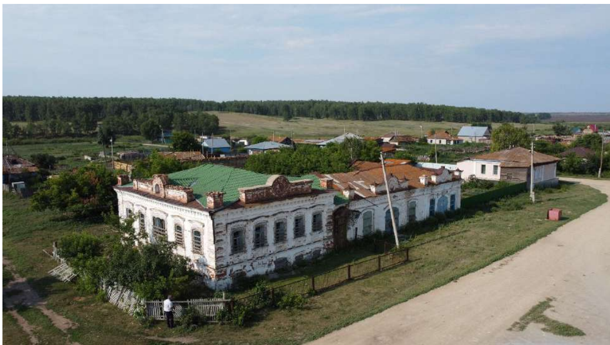
Фото 1. Вид на Объект, расположенный по красной линии ул. Красногвардейской. Фото сделано с квадрокоптера.
