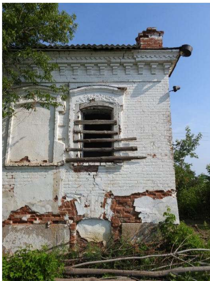
Фото 13. Фрагмент южного фасада Объекта.
