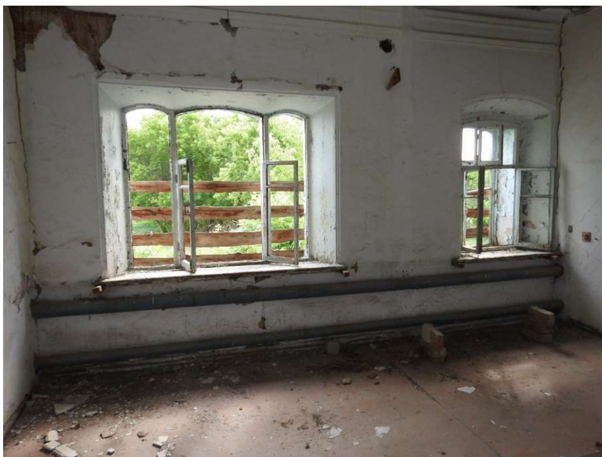
Фото 35. Фрагмент внутреннего интерьера первого этажа Объекта (дом Панковых).
