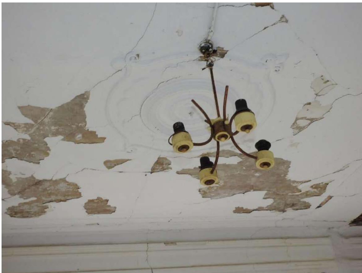
Фото 36. Потолочная розетка на первом этаже Объекта (дом Панковых).
