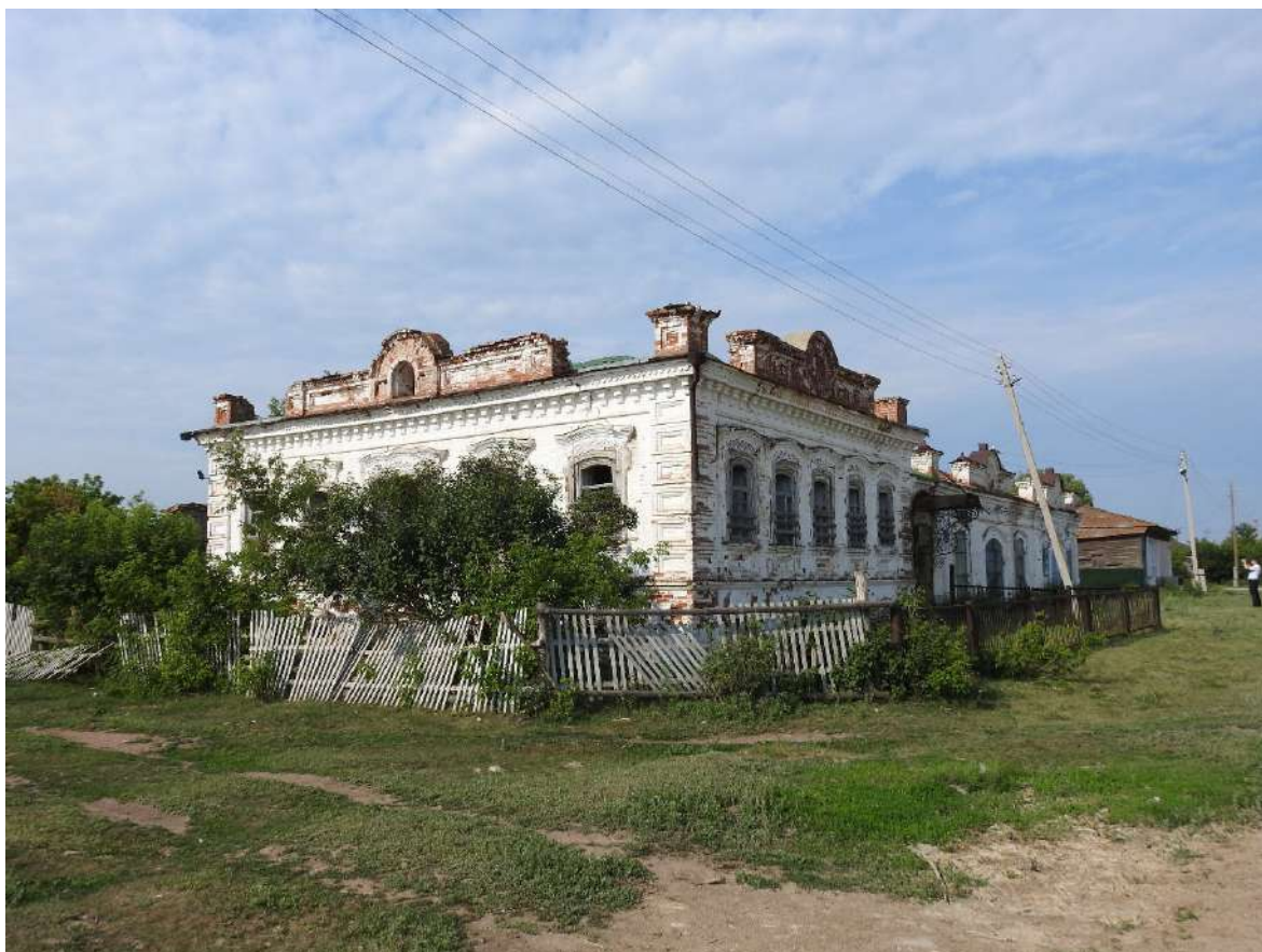
Фото 9. Вид на северный и восточный фасады Объекта.
