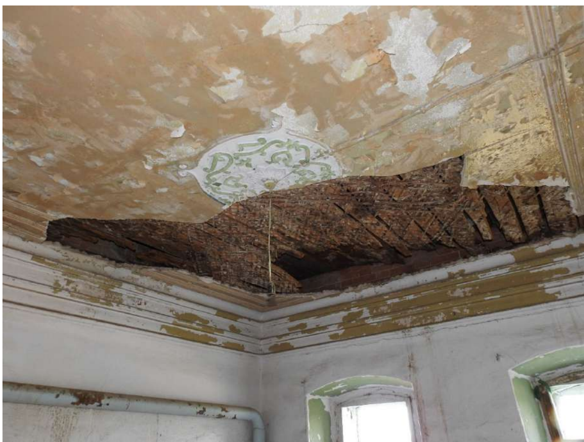
Фото 39. Потолочная розетка на первом этаже Объекта (дом Панковых).
