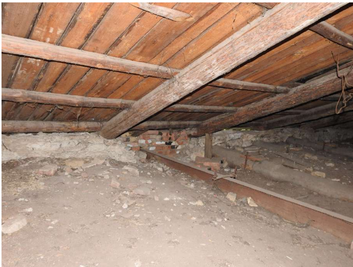
Фото 44. Вид на фрагмент конструкции крыши Объекта (дом Панковых).
