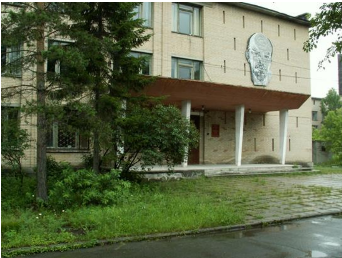
Фото 7. Вид на выявленный объект культурного наследия «Здание филиала института биофизики (ФИБ-1)», расположенный по адресу: Челябинская область, Озерский городской округ, г. Озерск, Восточная ул., 9. Дата фотофиксации: 2018 год. Фотограф: А. Наумов. https://arhistrzh.livejournal.com/334647.html
