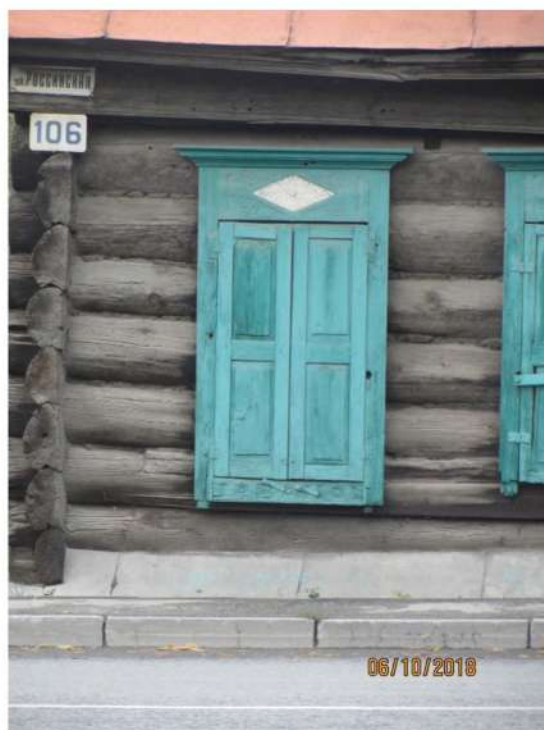
Фрагмент главного фасада
