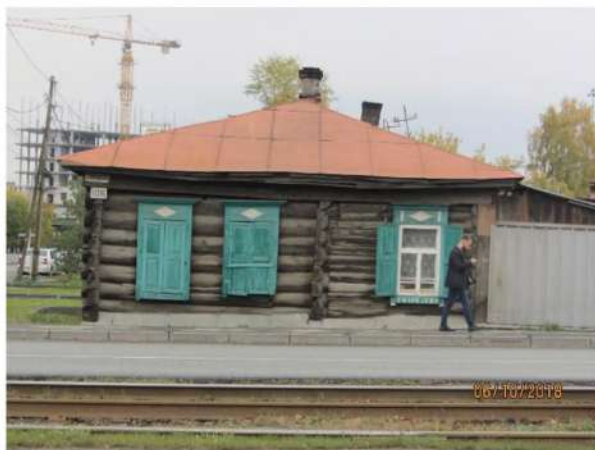
Общий вид выявленного объекта культурного наследия с улицы Миасской
