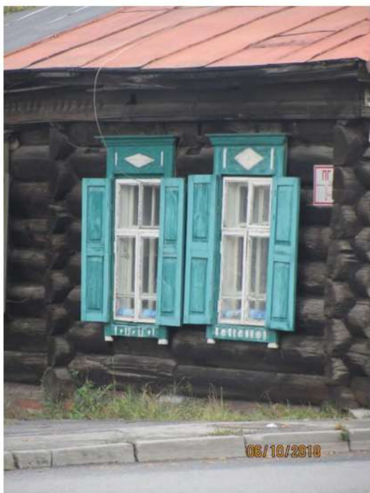
Фрагмент главного фасада
