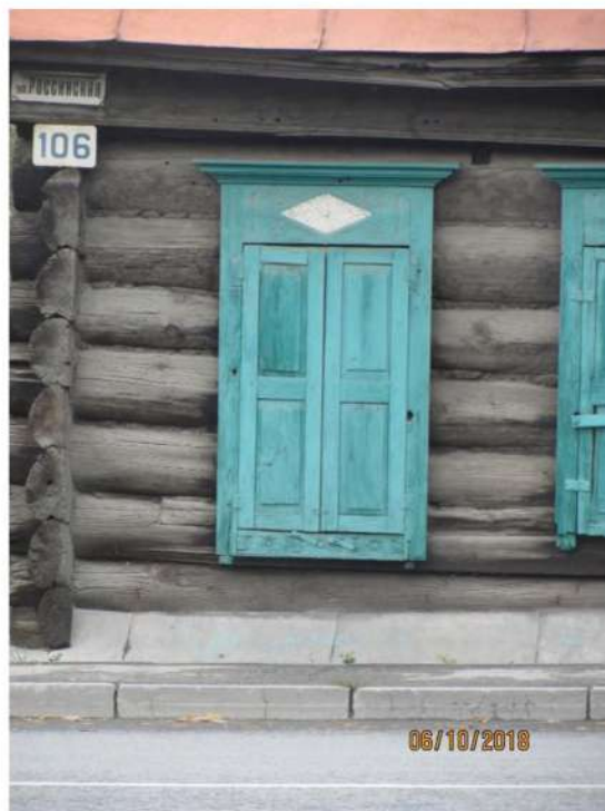
Фрагмент главного фасада
