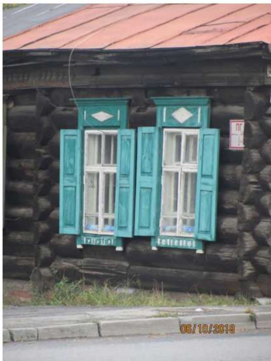
Фрагмент главного фасада
