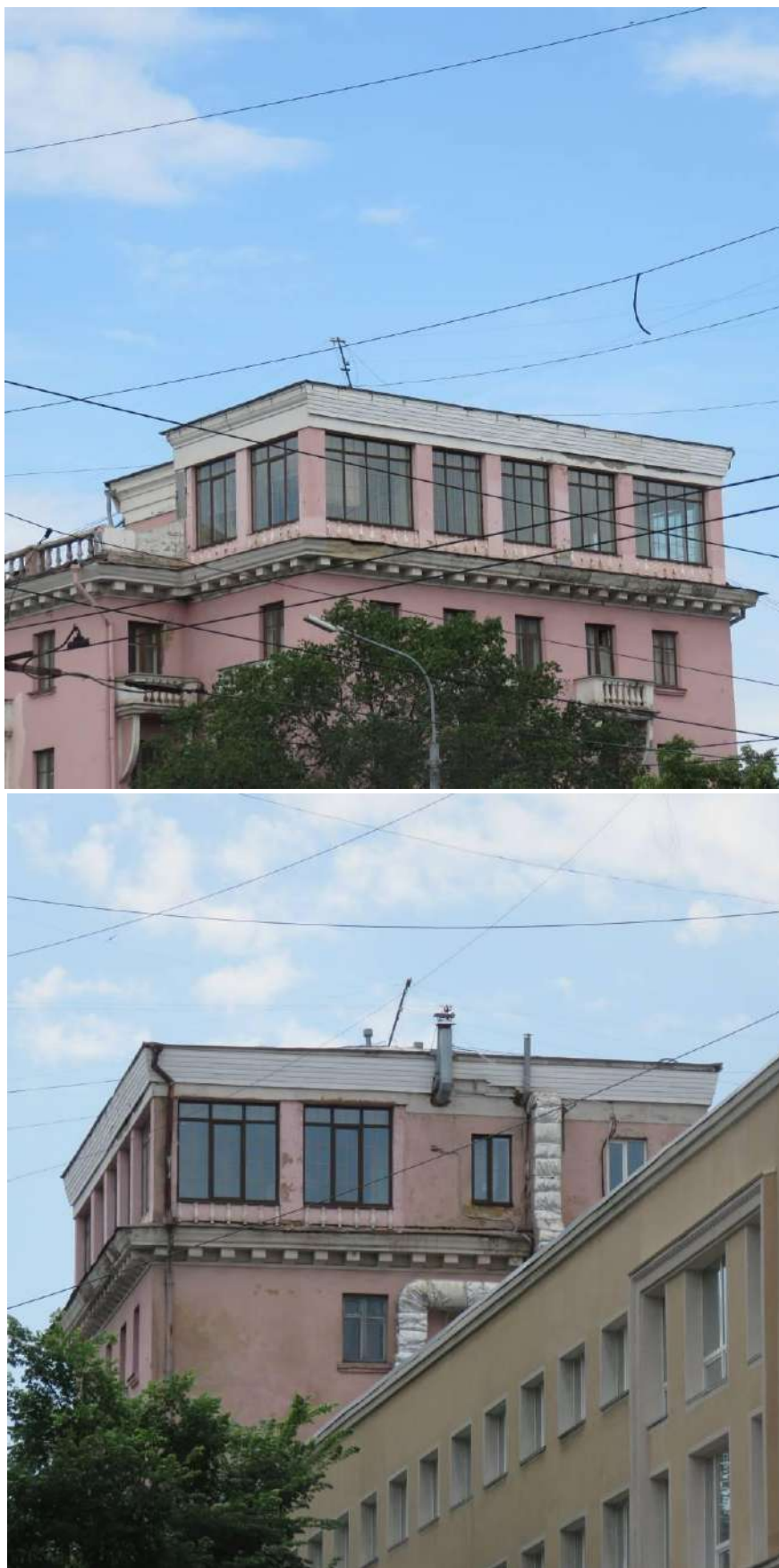
Рис. 17 а, б. Открытая галерея аттикового этажа углового 6-этажного корпуса (в настоящее время застеклена) (вид с юго-востока (вверху) и севера (внизу))
