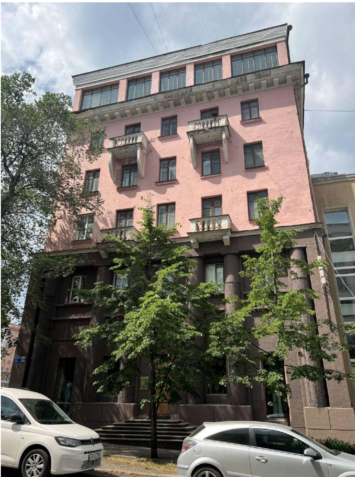
Рис. 16. Лицевой, восточный фасад. Вид с востока
