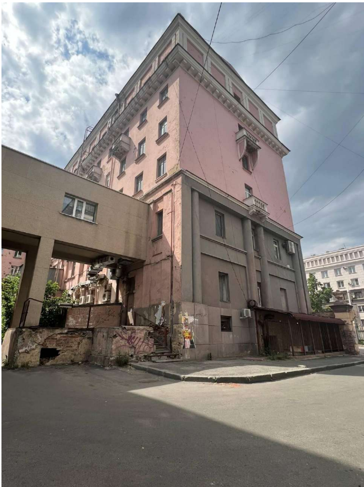
Рис. 11. Торцевой, северный фасад. Вид с северо-востока
