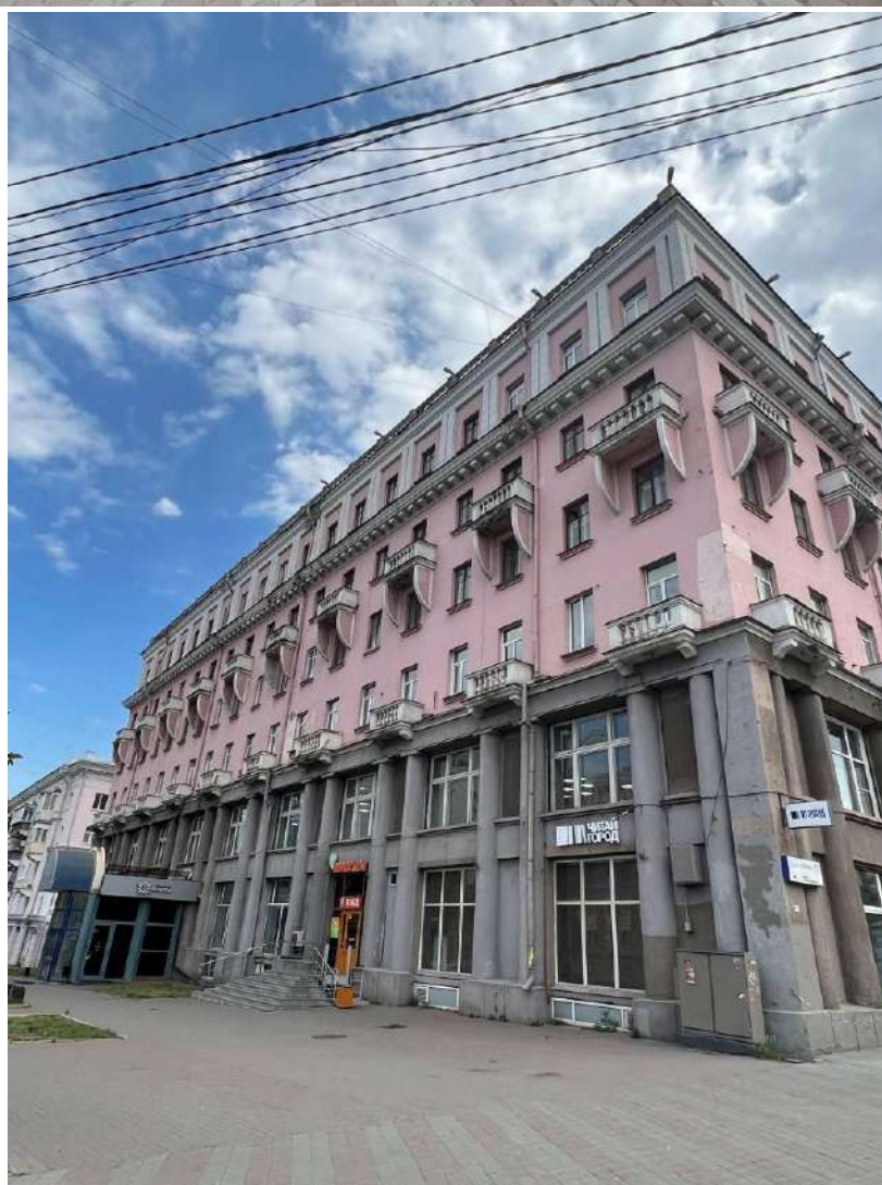
Рис. 4 а, б. Лицевой, западный фасад. Вид с юго-запада
