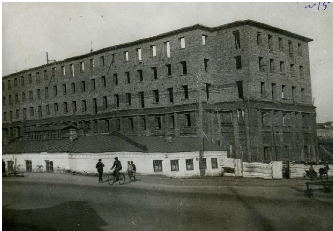
Рис. 34. Строительство гостиницы. Фото 1936 г. Источник: фонды ОГАЧО
