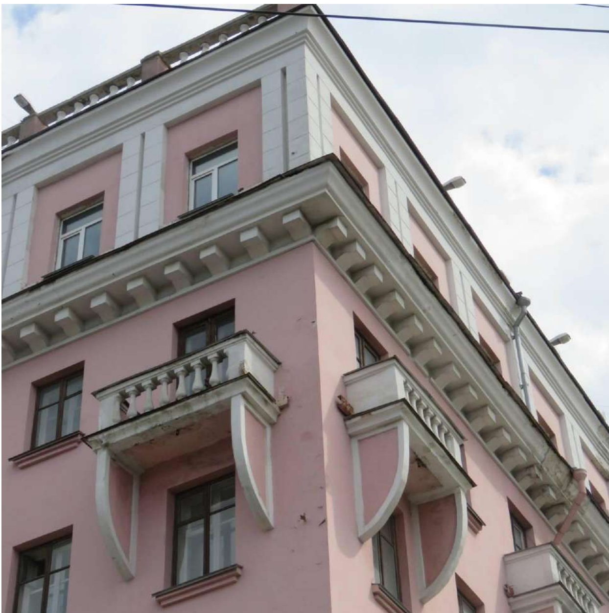
Рис. 9. Фрагмент лицевых, южного и западного фасадов Г-образного 6-этажного корпуса. Решение венчающего карниза 5 этажа и аттикового 6 этажа
