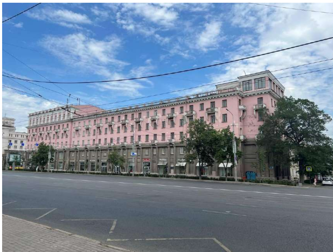
Рис. 3. Лицевой, южный фасад. Вид с юго-востока
