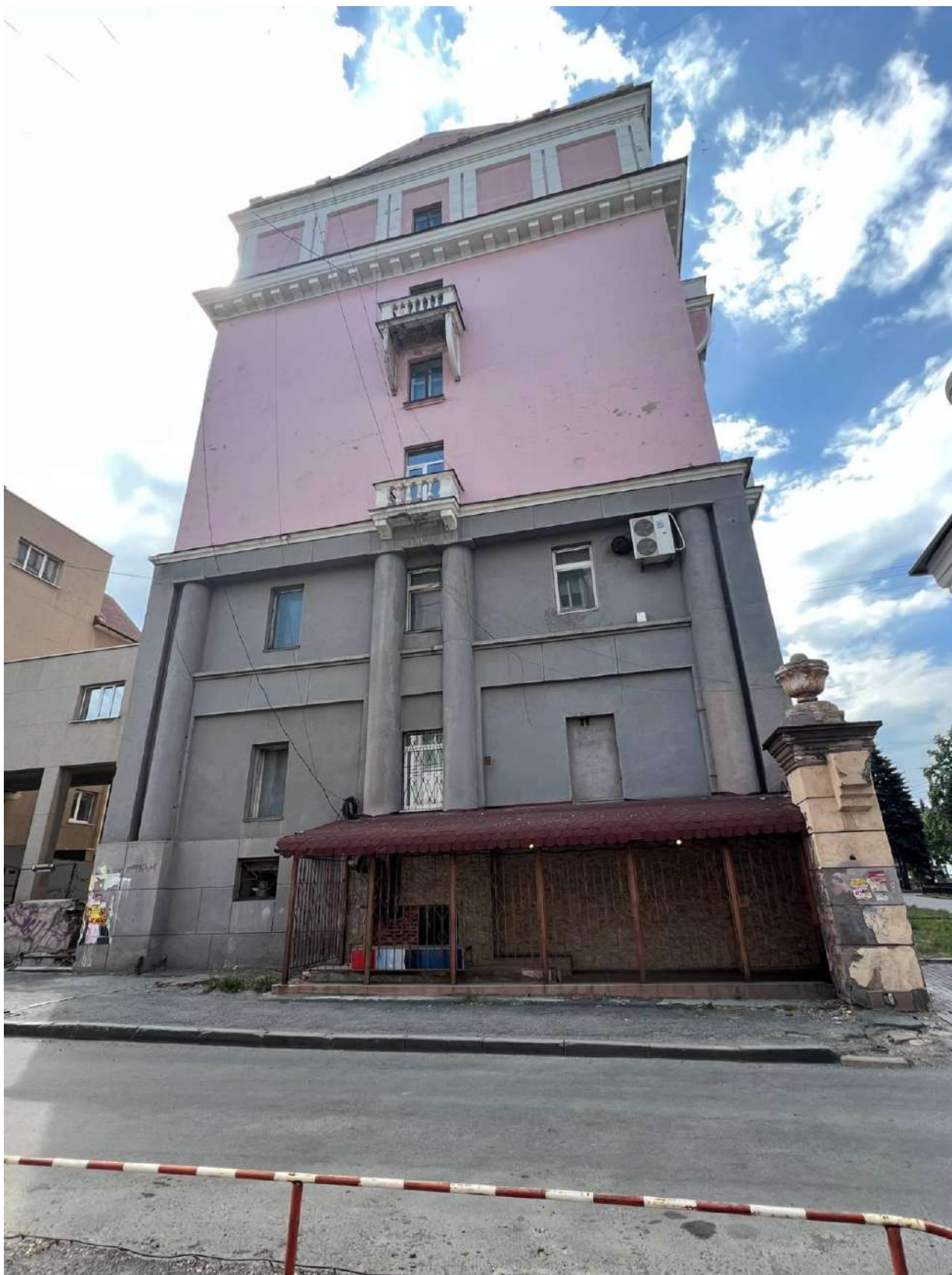
Рис. 10. Торцевой, северный фасад. Вид с севера
