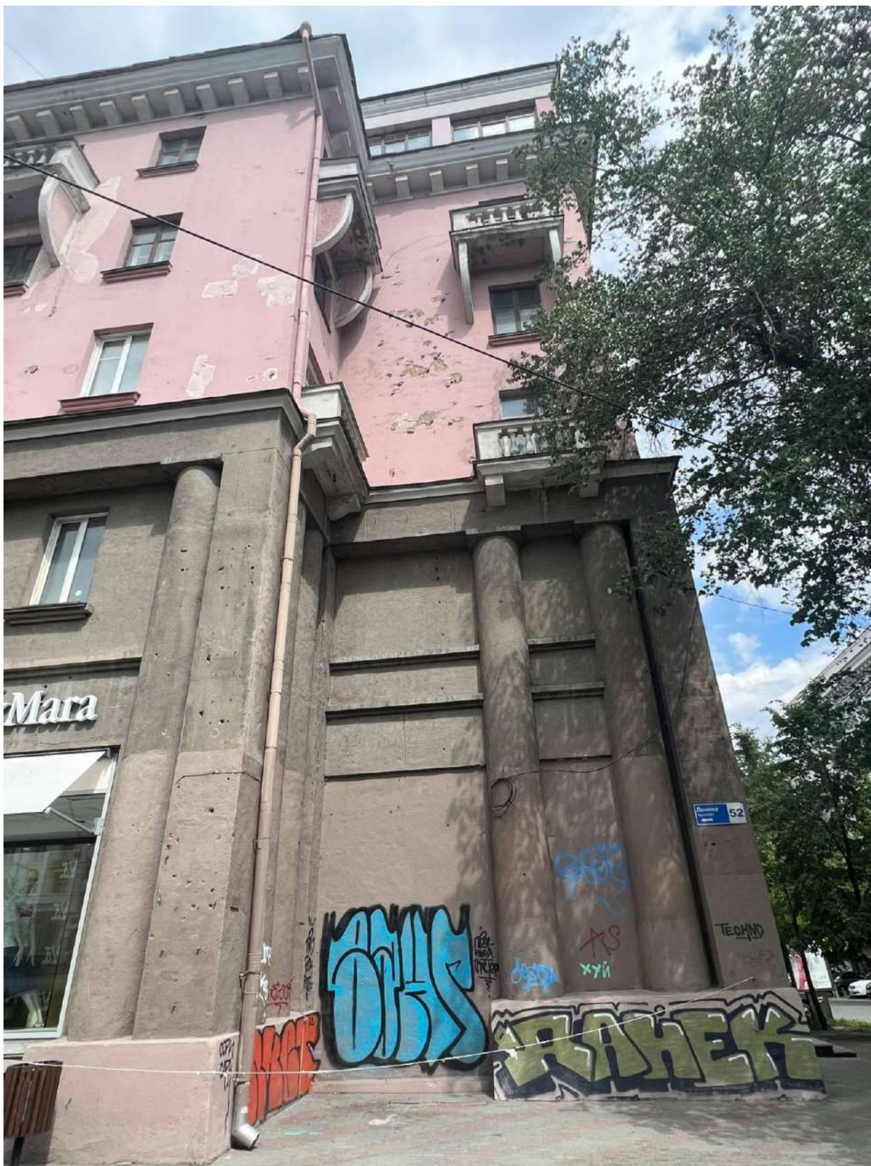
Рис. 13. Стык 5-этажного прямоугольного в плане корпуса, вытянутого лицевым, южным фасадом вдоль пр. Ленина с 6-этажным угловым объемом, лицевым восточным фасадом обращенным к ул. Советской. Вид с юга.
