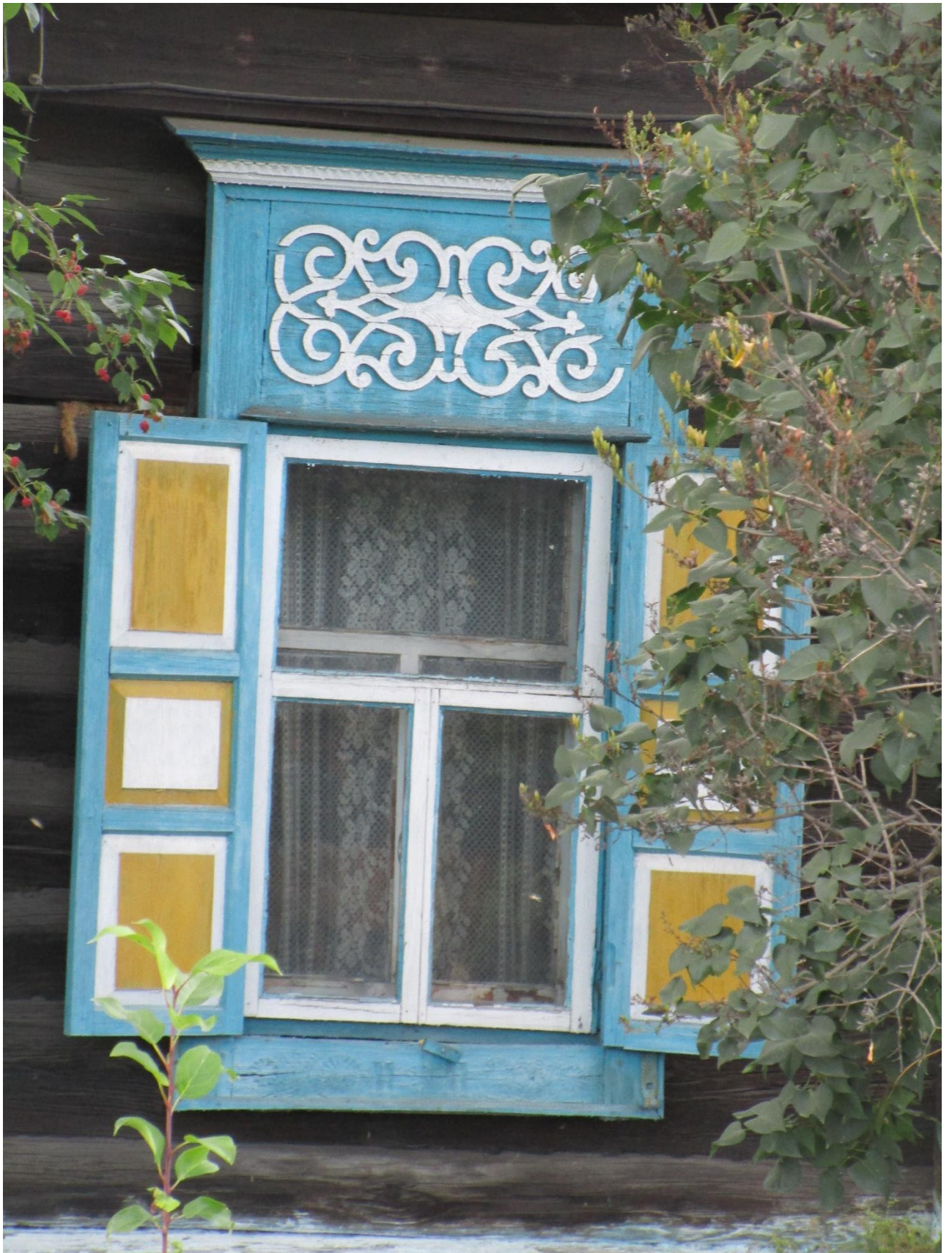
5. Фрагмент главного фасада. Оконный проем, оконный наличник, 2023 г.
