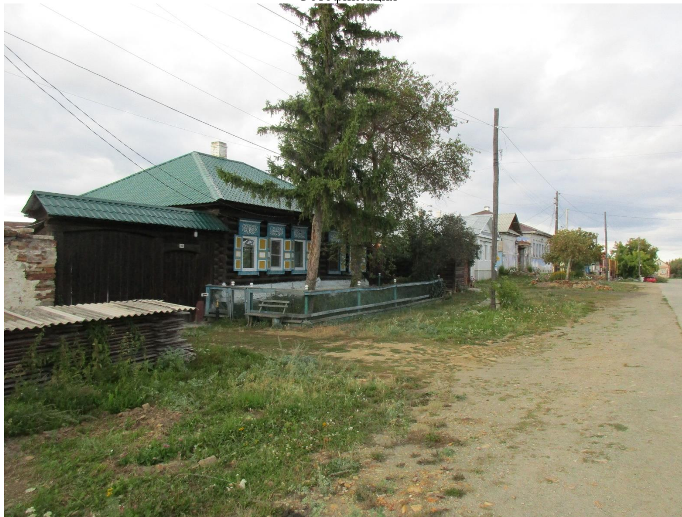
1. Общий вид с юга. Август 2023 г.
