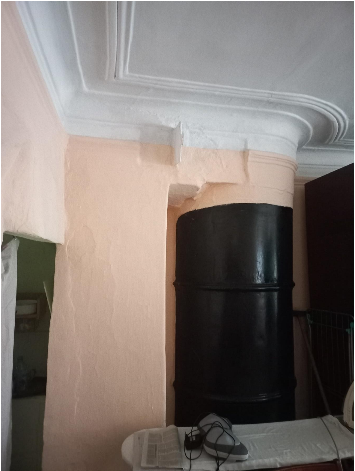
15. Печь, потолочные карнизы.
