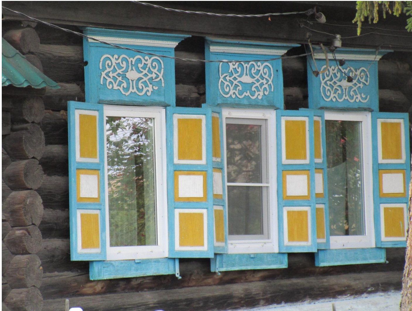
4. Левая часть главного фасада дома. Август 2023 г.
