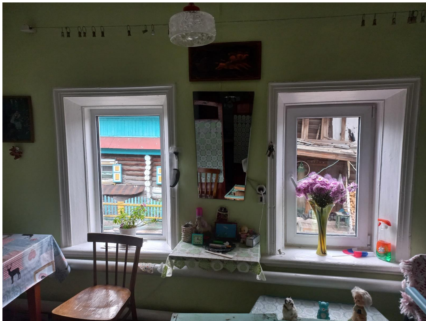
14. Внутренние оконные наличники, откосы, подоконники. Октябрь, 2023 г.
