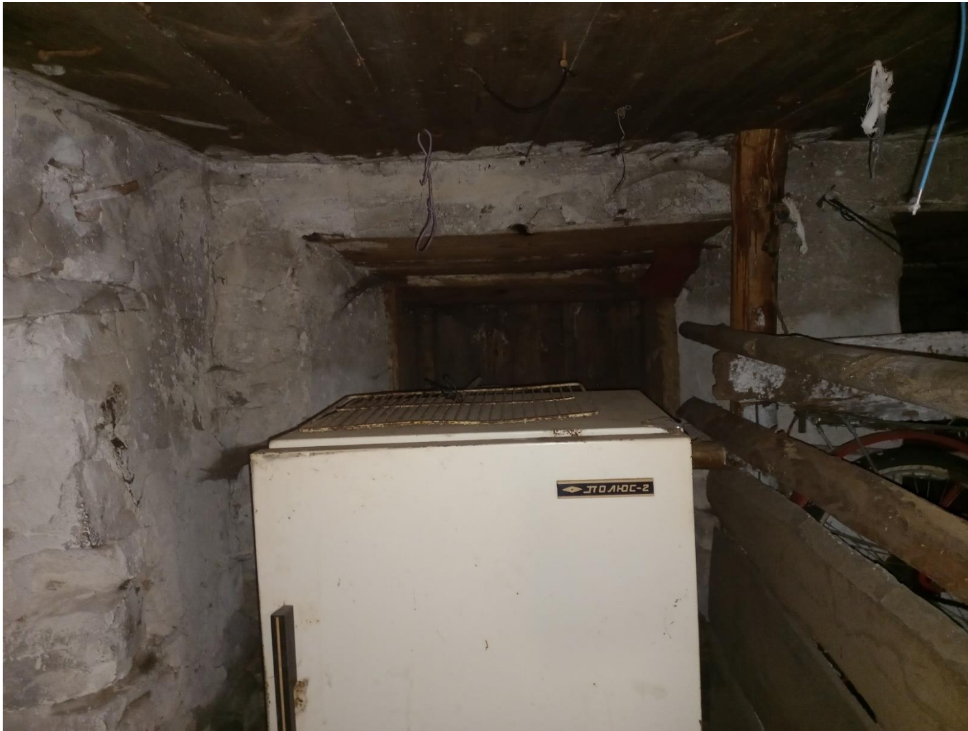
16. Интерьер. Оконные проемы в цокольной части. Октябрь 2023 г.
