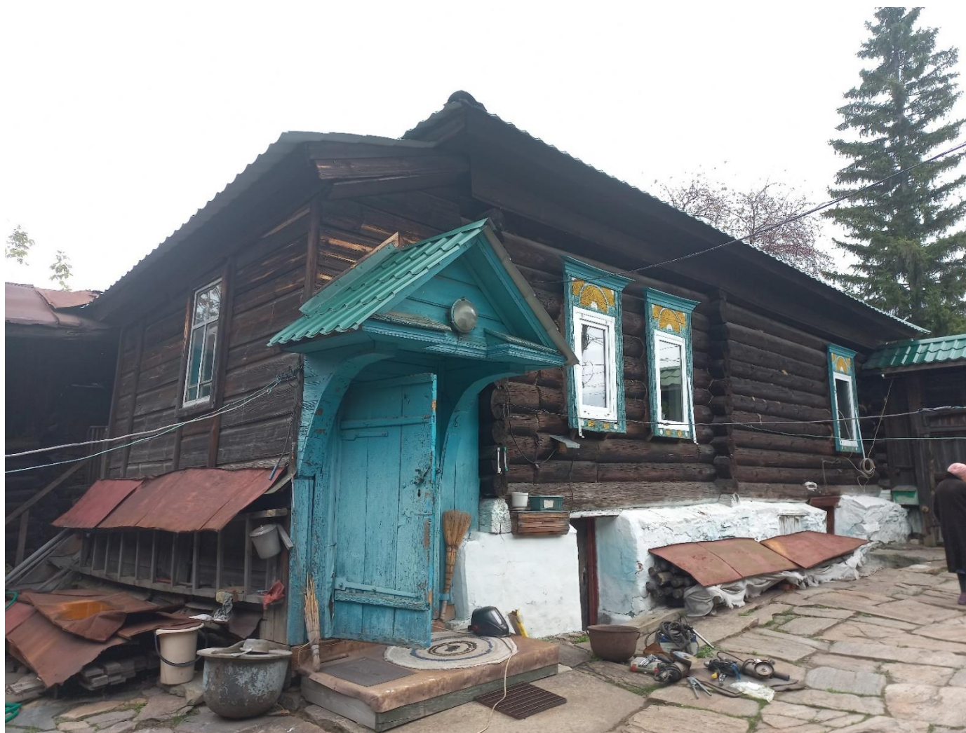
13. Дворовые фасады. Тамбур. Козырек. Октябрь, 2023 г.
