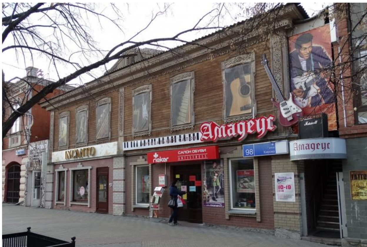
Приложение №8. «Дом купеческий». Вид с востока. Фото май 2022 года.
