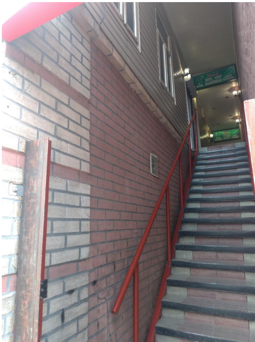
Приложение №9. «Дом купеческий». Вид с востока. Фото май 2022 года.
