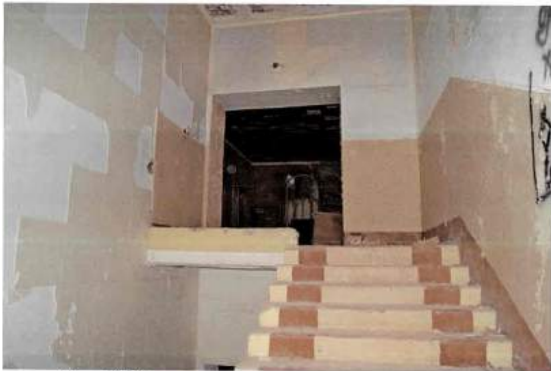
Фото 27. Вид на лестничную клетку здания с площадки
