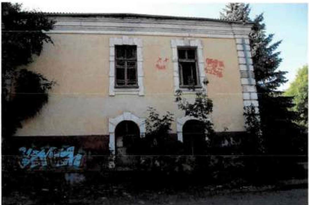
Фото 4. Вид на северный фасад здания
