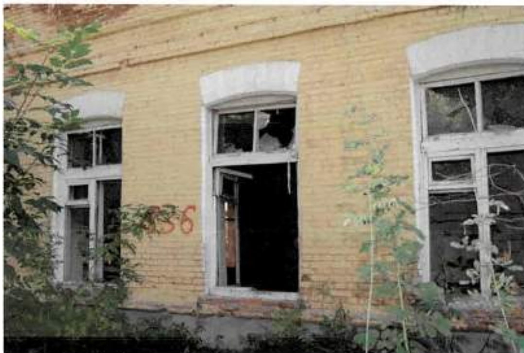
Фото 11. Вид на окна 1-го этажа восточного фасада здания
