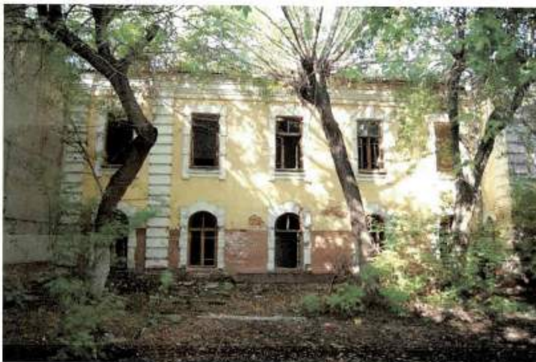
Фото 5. Фрагмент западного фасада здания. Вид на левое крыло
