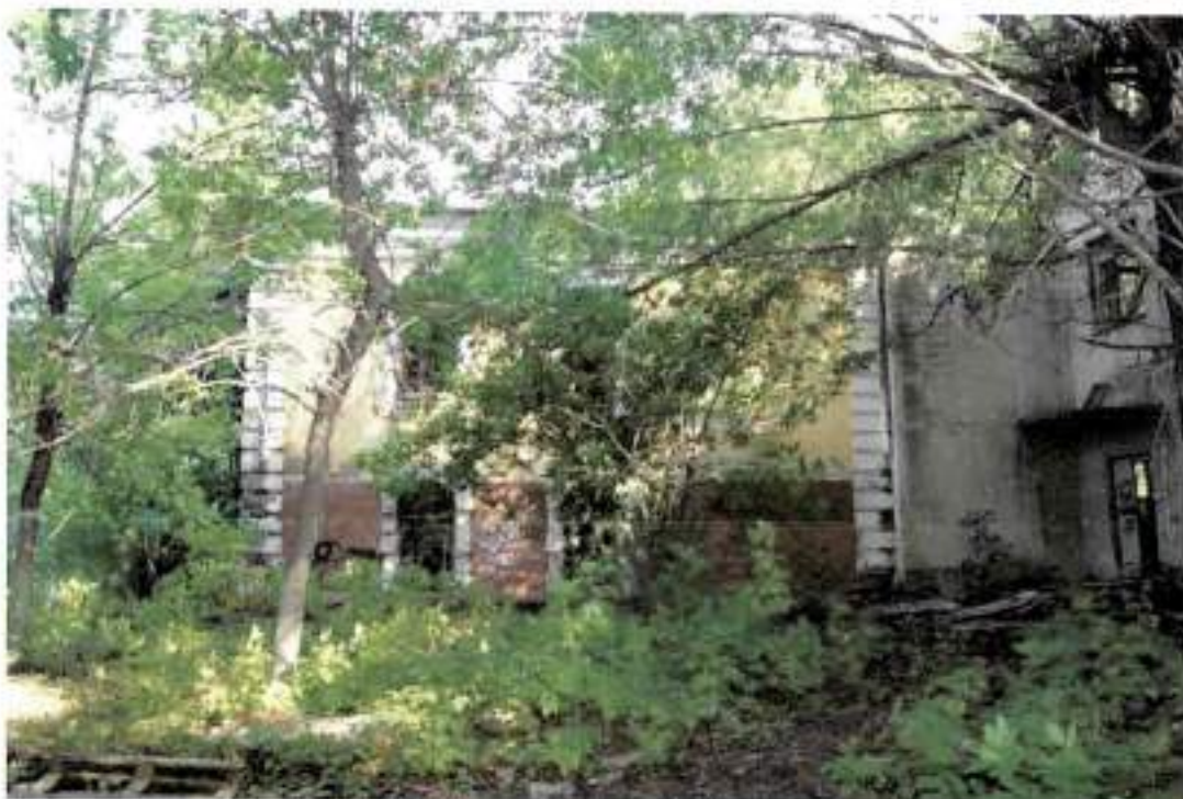
Фото 13. Вид на южный фасад здания
