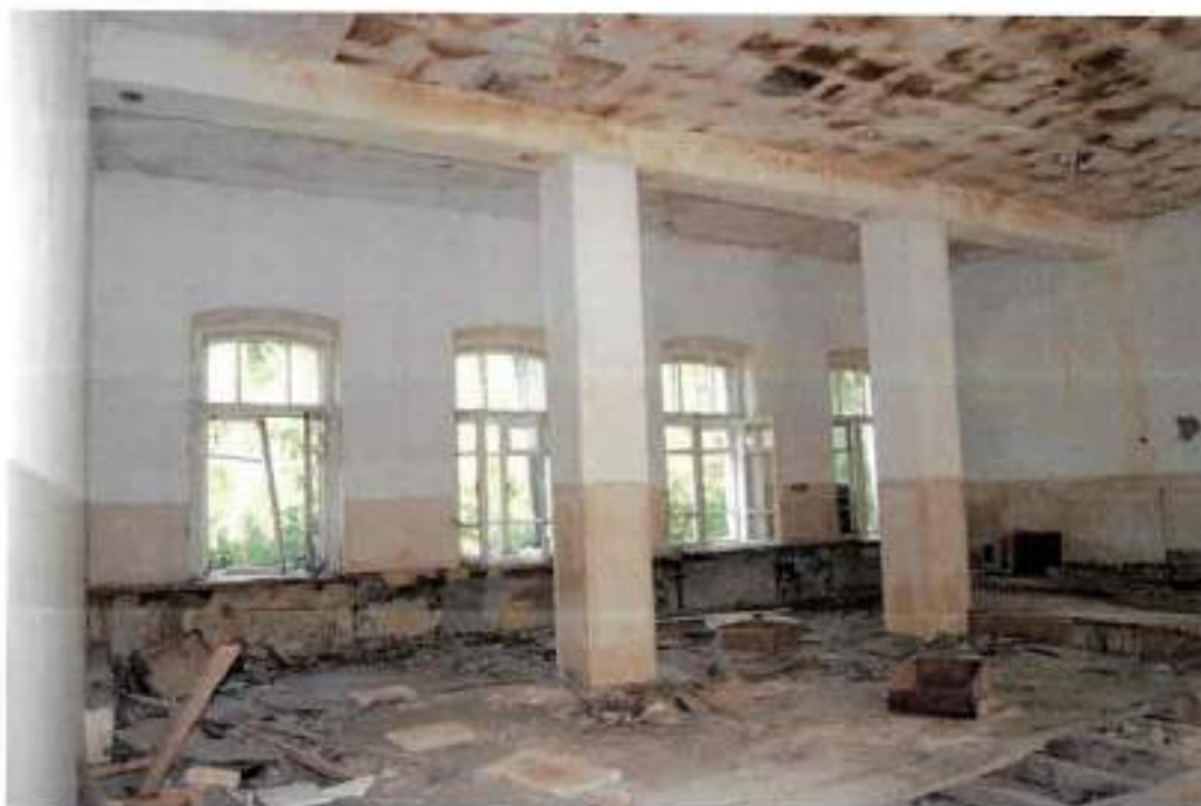
Фото 20. Вид на интерьер помещения 1-го этажа с южной стороны
