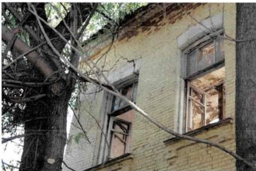
Фото 10. Вид на окна 2-го этажа восточного фасада здания
