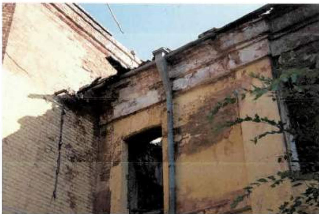
Фото 14. Вид на карнизную зону южного пристроя здания
