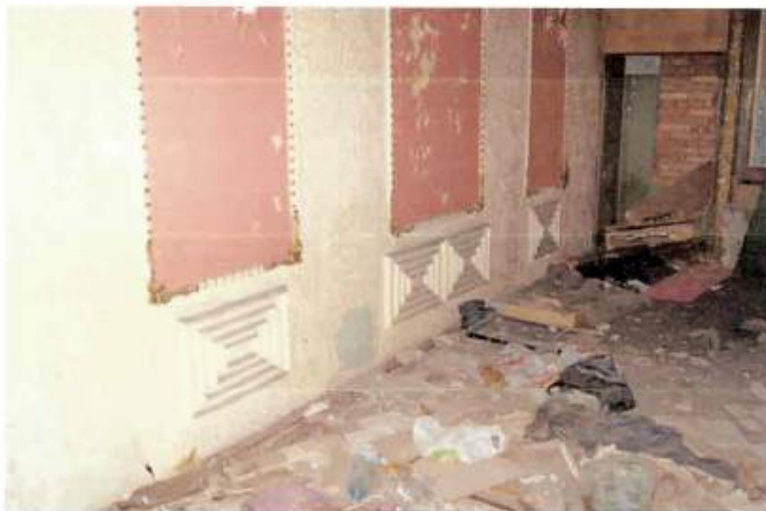
Фото 28. Вид на холл 2-го этажа здания с юго-востока
