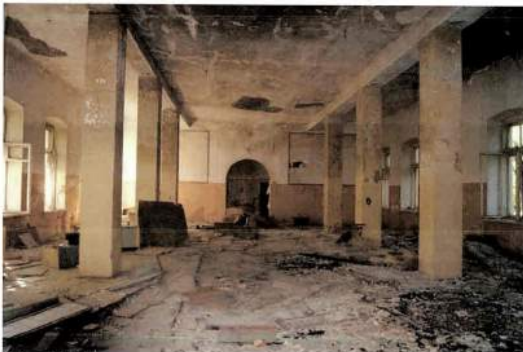
Фото 23. Вид на интерьер помещения 1-го этажа с северной стороны
