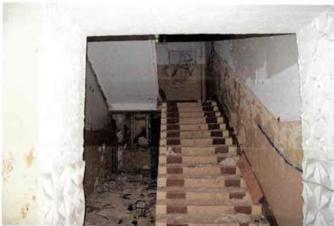
Фото 25. Вид на лестничную клетку здания с 1-го этажа
