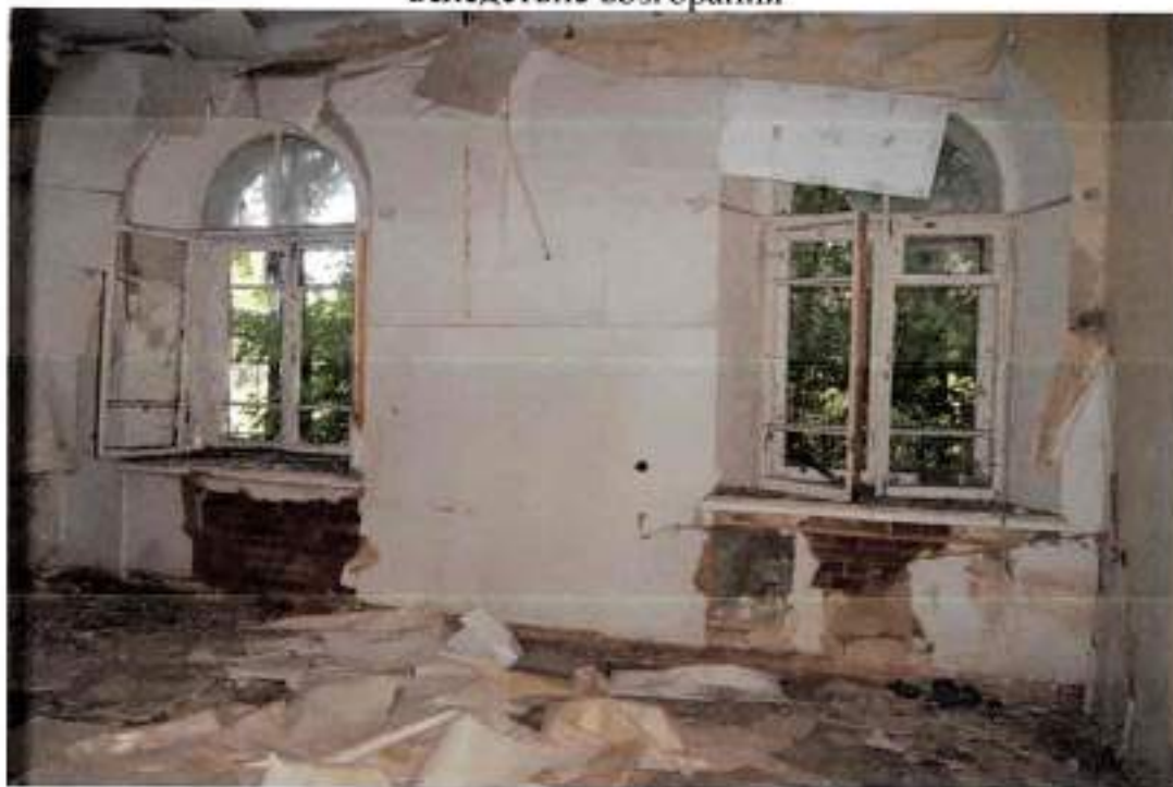
Фото 32. Вид на помещение 2-го этажа здания с юго-востока
