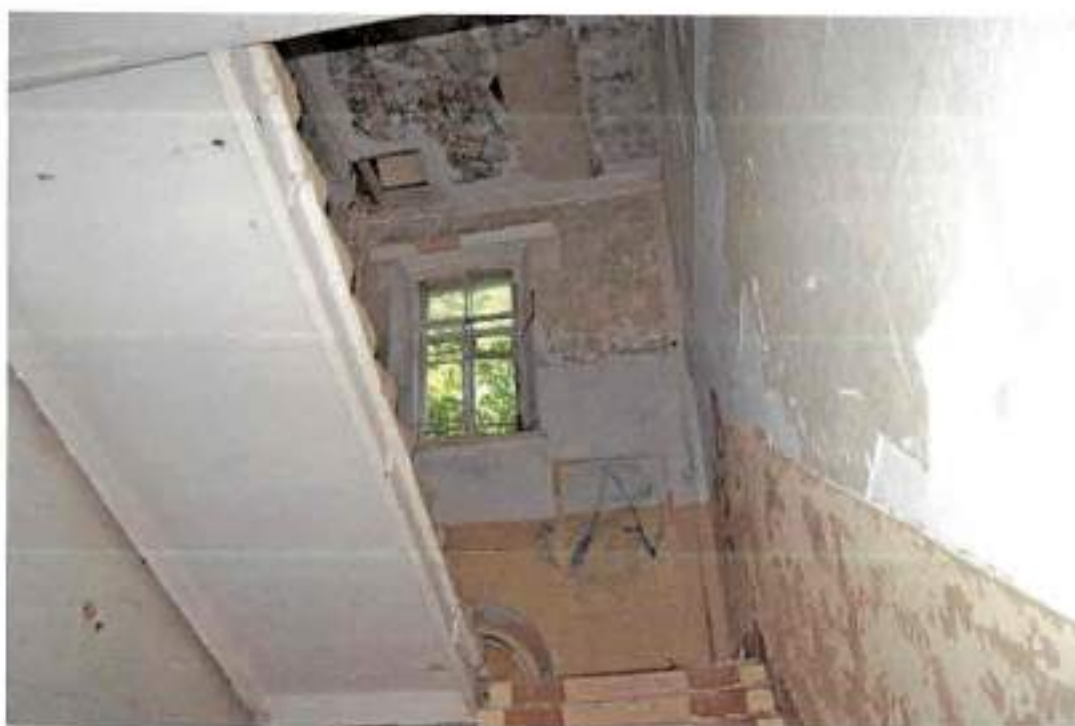
Фото 26. Вид на лестничную клетку здания с 1-го этажа
