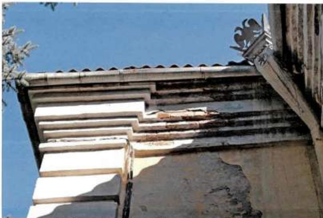
Фото 19. Фрагмент карнизной зоны главного фасада здания
