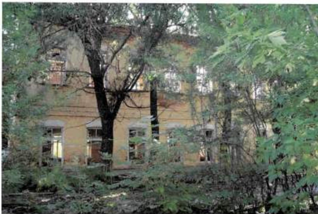
Фото 7. Фрагмент восточного фасада здания
