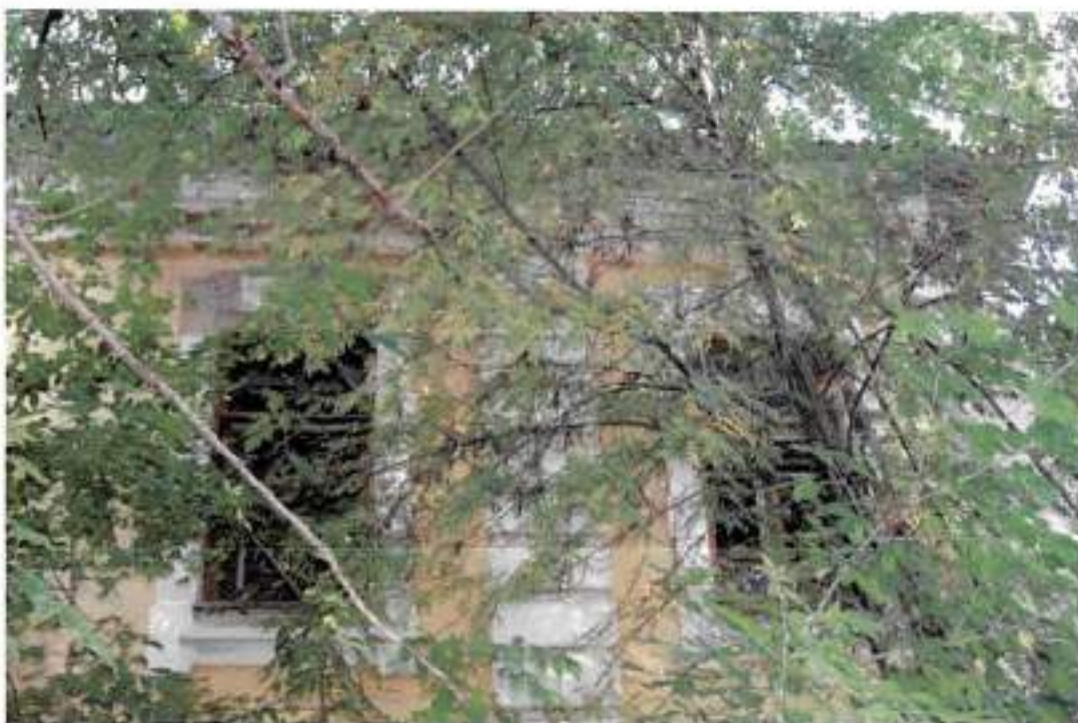
Фото 10. Вид на окна 2-го этажа правого крыла западного фасада здания
