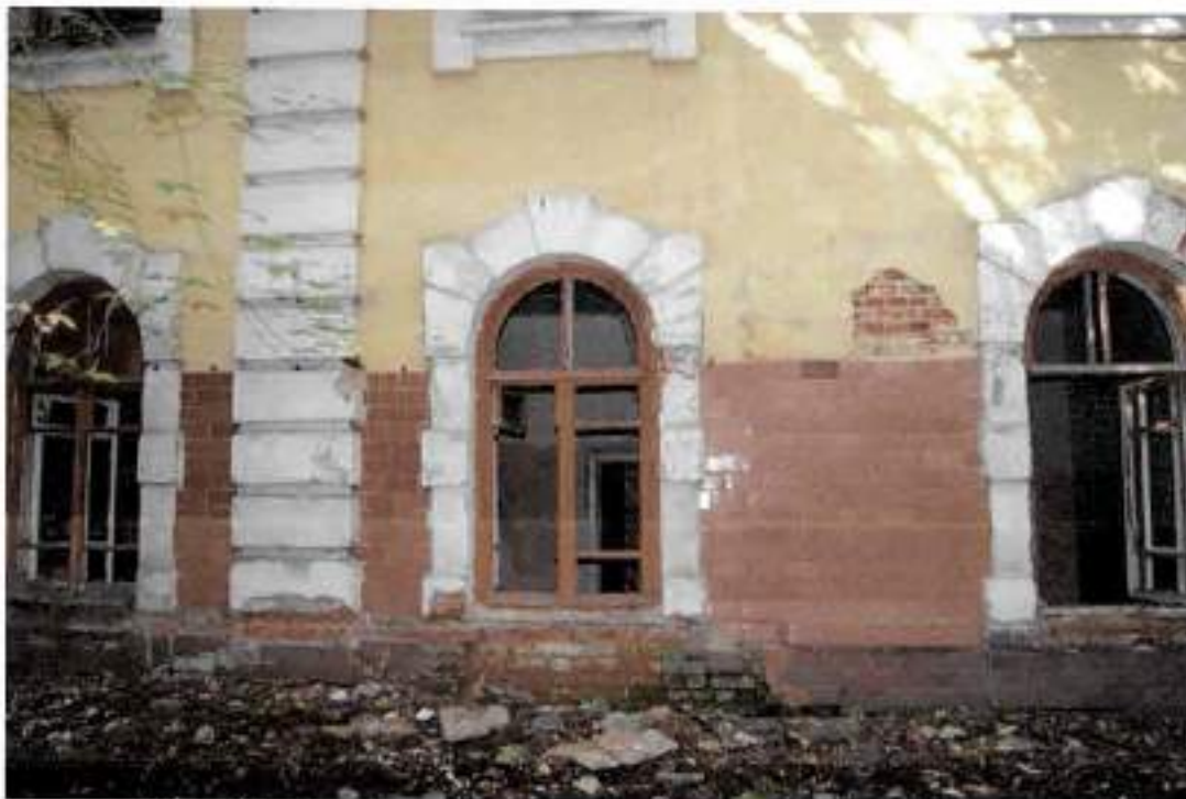
Фото 11. Вид на арочные окна 1-го этажа левого крыла западного фасада здания
