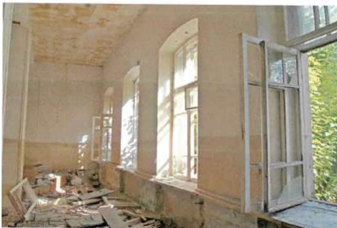
Фото 19. Вид на интерьер помещения 1-го этажа с южной стороны
