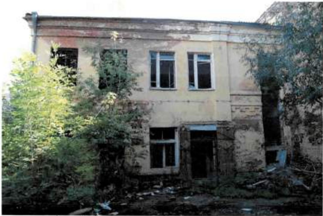
Фото 3. Вид на северо-восточный фасад здания
