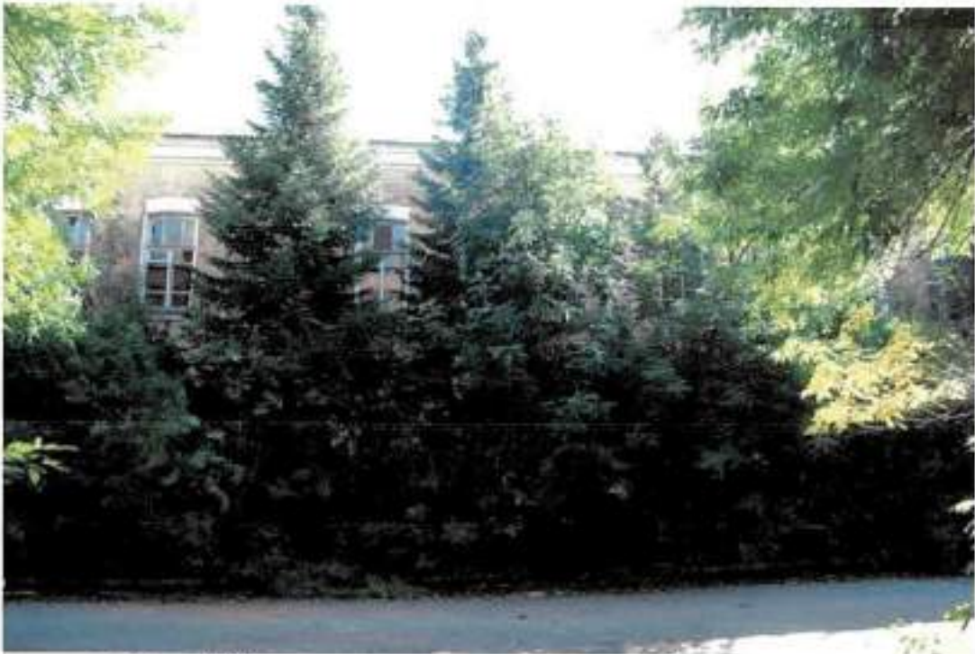
Фото 5. Фрагмент главного восточного фасада здания
