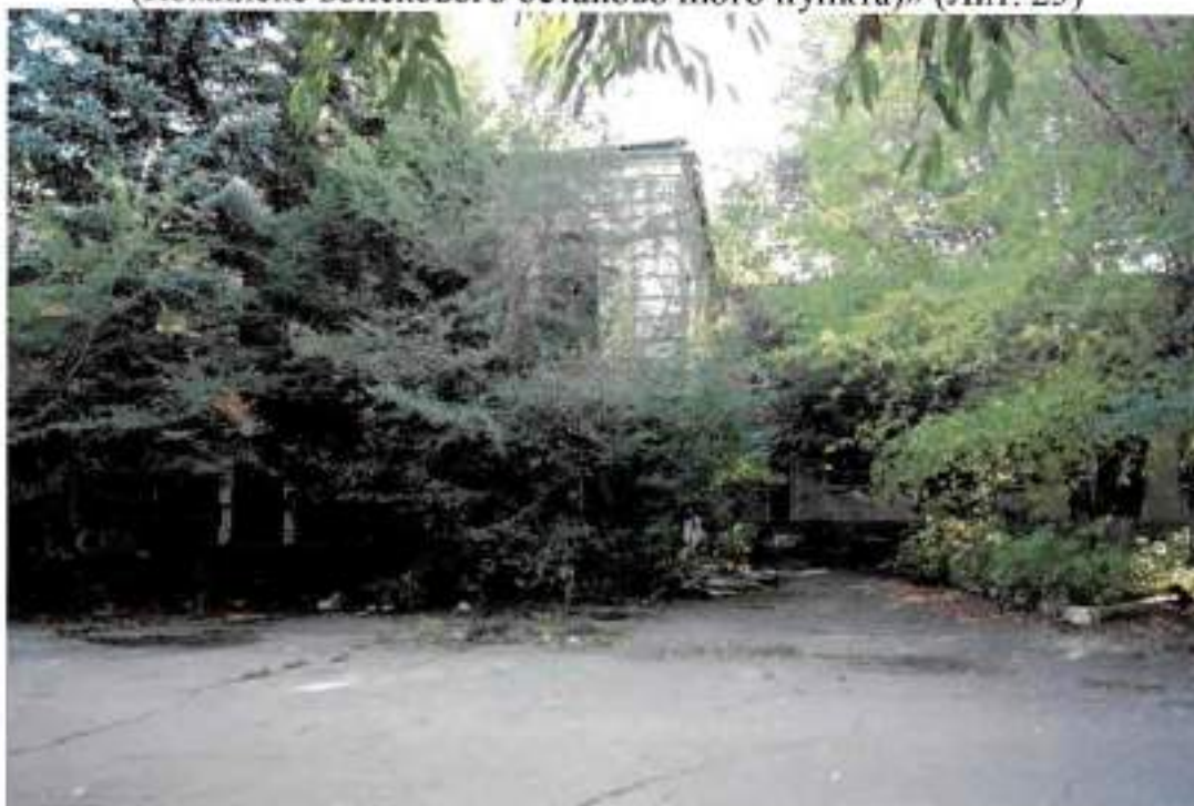
Фото 1. Вид на здание с юго-восточной стороны
