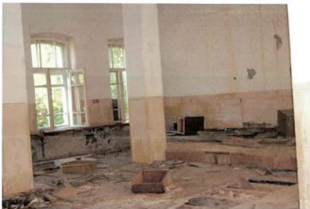
Фото 17. Вид на интерьер помещения 1-го этажа с южной стороны
