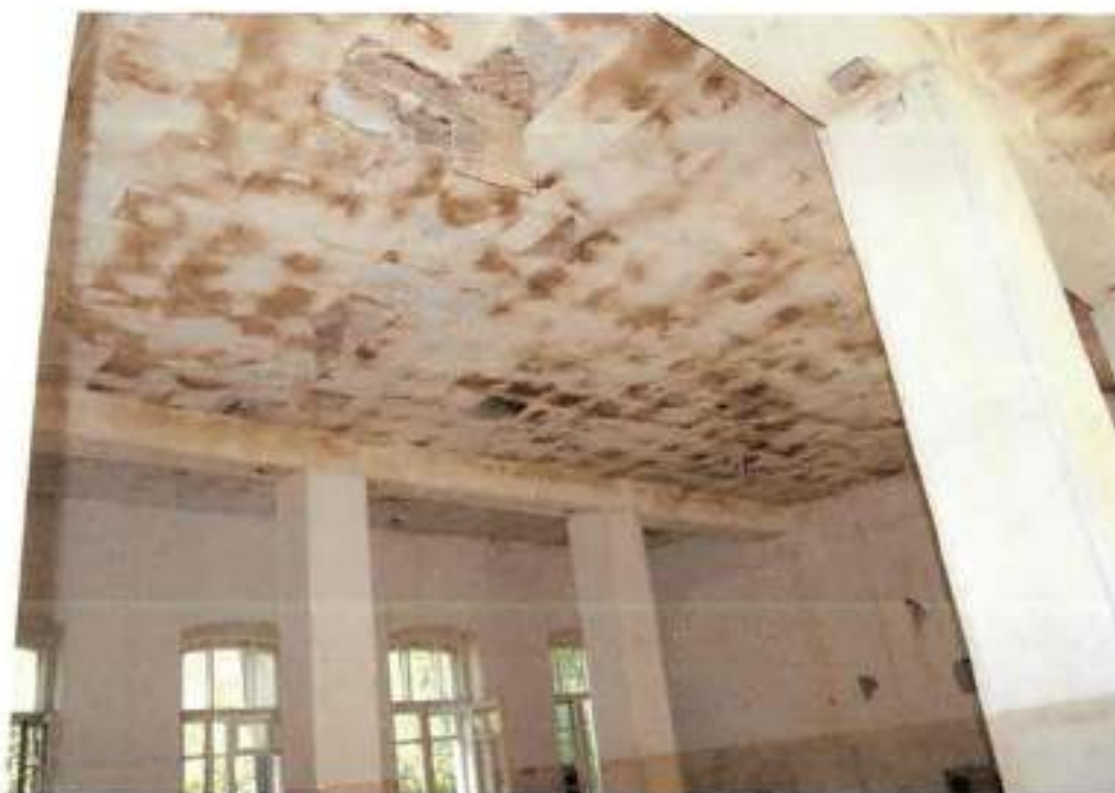
Фото 18. Вид на интерьер помещения 1-го этажа с южной стороны
