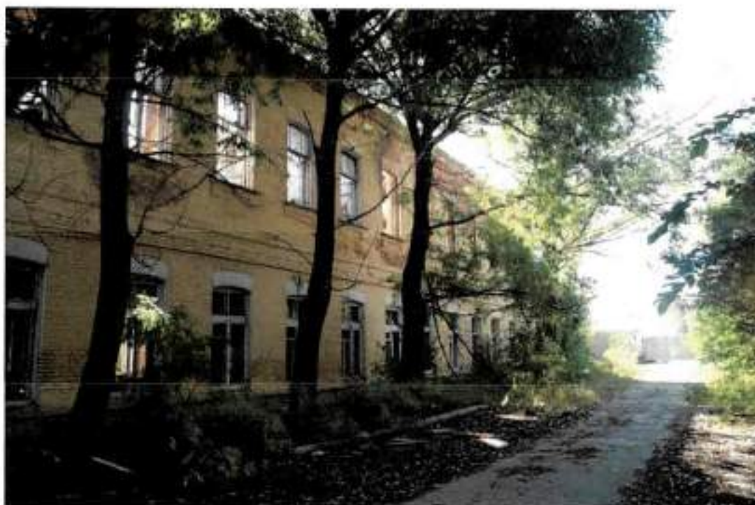
Фото 8. Фрагмент восточного фасада здания
