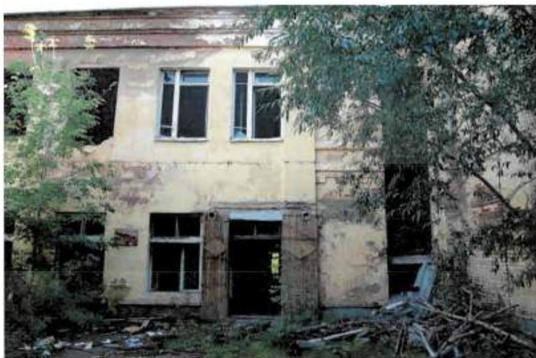
Фото 12. Вид на северный вход в здание
