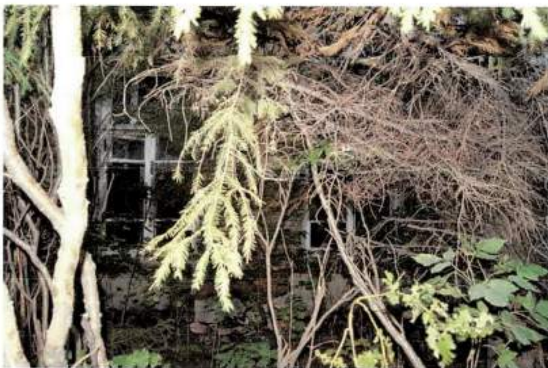
Фото 10. Вид на окна 1-го этажа главного восточного фасада здания
