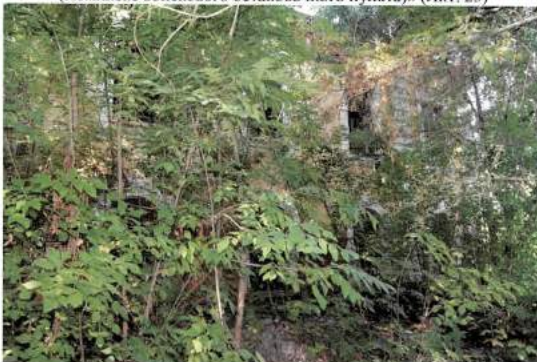
Фото 7. Фрагмент западного фасада здания. Вид на правое крыло
