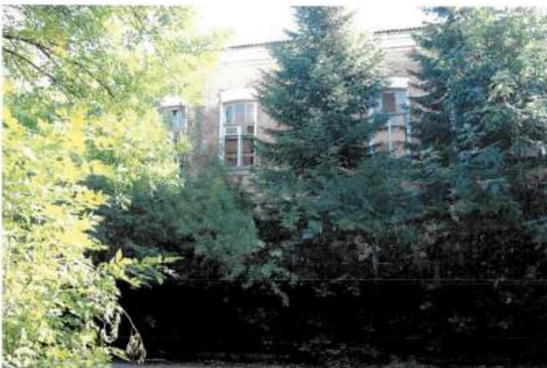
Фото 4. Фрагмент главного восточного фасада здания
