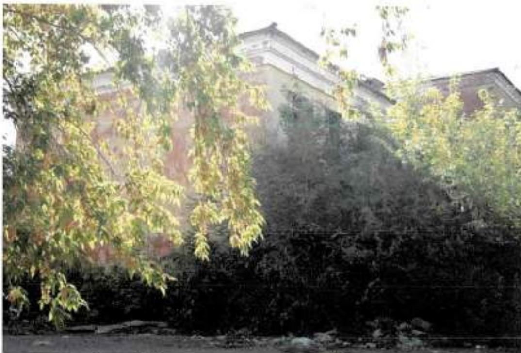
Фото 3. Вид на северо-восточный фасад здания
