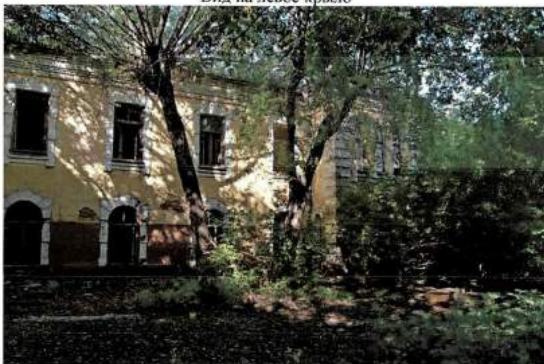
Фото 6. Фрагмент западного фасада здания
