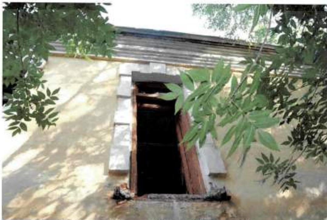
Фото 15. Вид на балконный дверной проем на 2-ом этаже южного фасада здания
