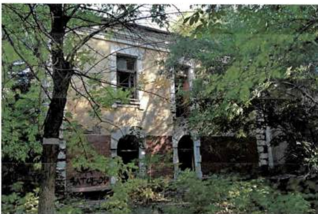
Фото 14. Вид на южный фасад здания
