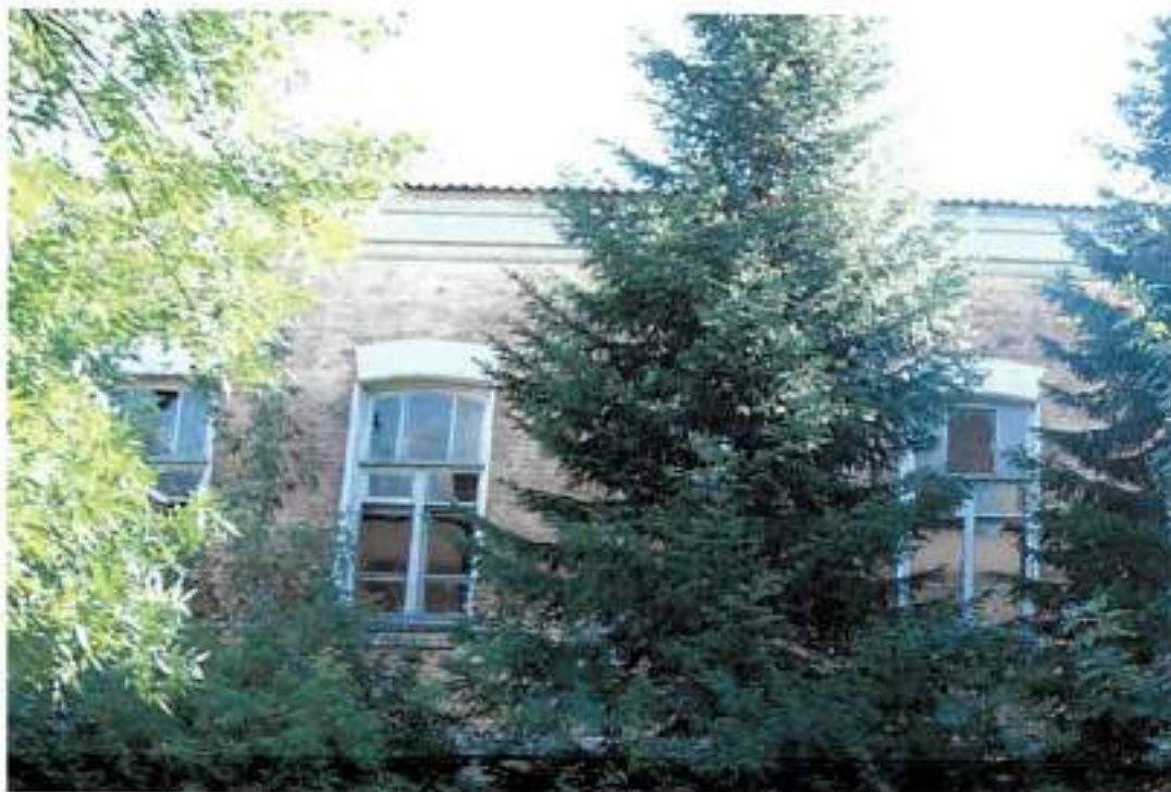
Фото 11. Вид на окна 2-го этажа главного восточного фасада здания
