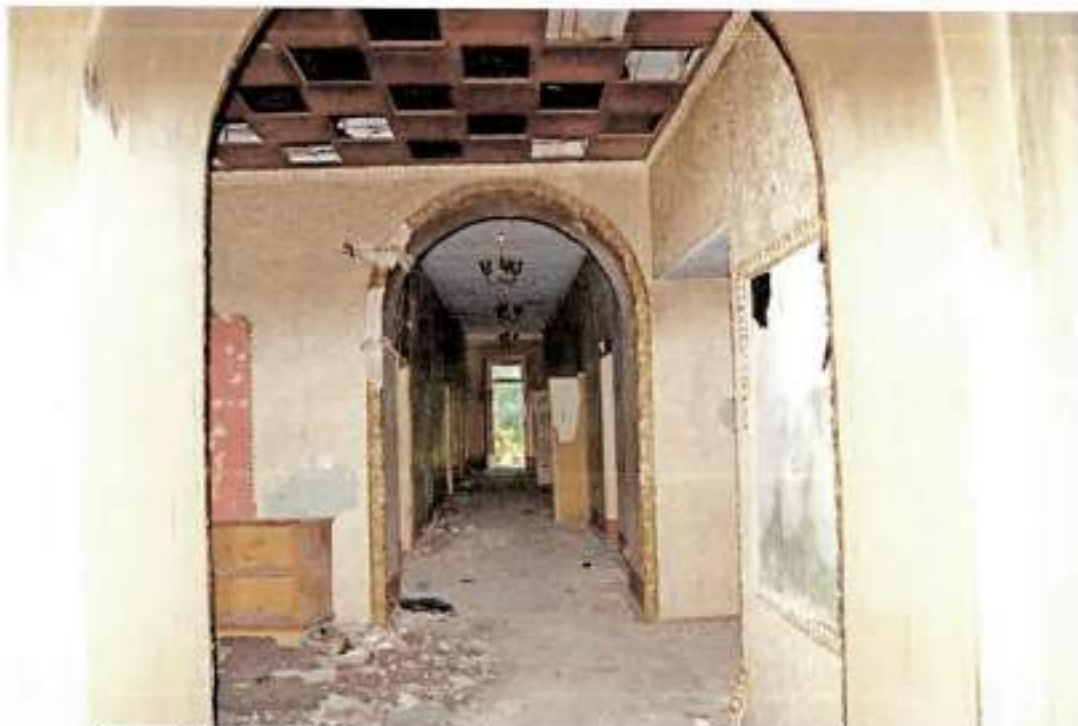
Фото 29. Вид на коридор 2-го этажа здания с северо-востока
