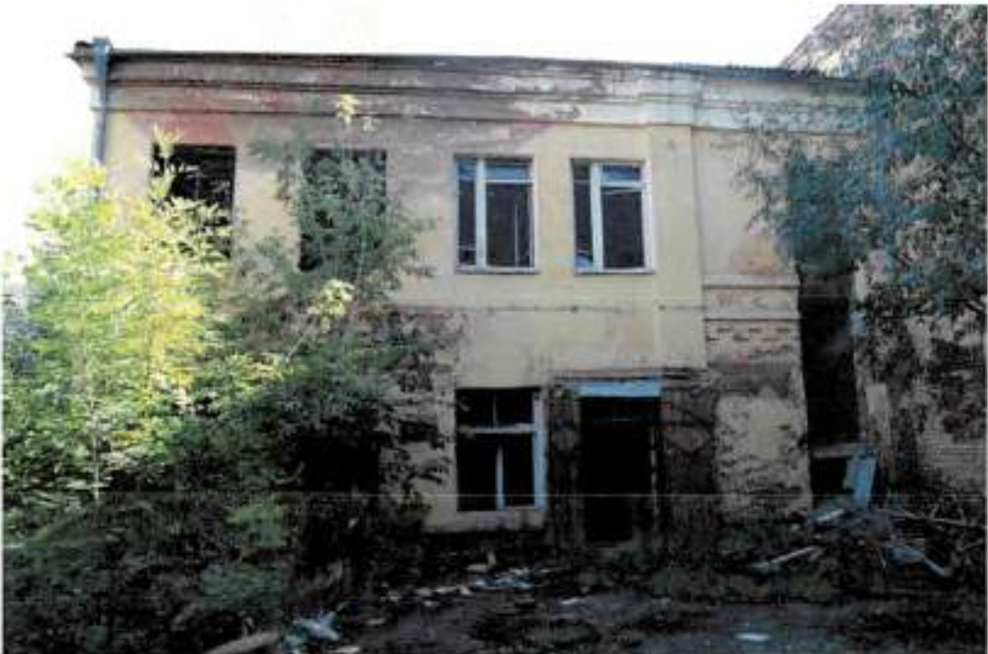
Фото 6. Вид на северный вход в здание
