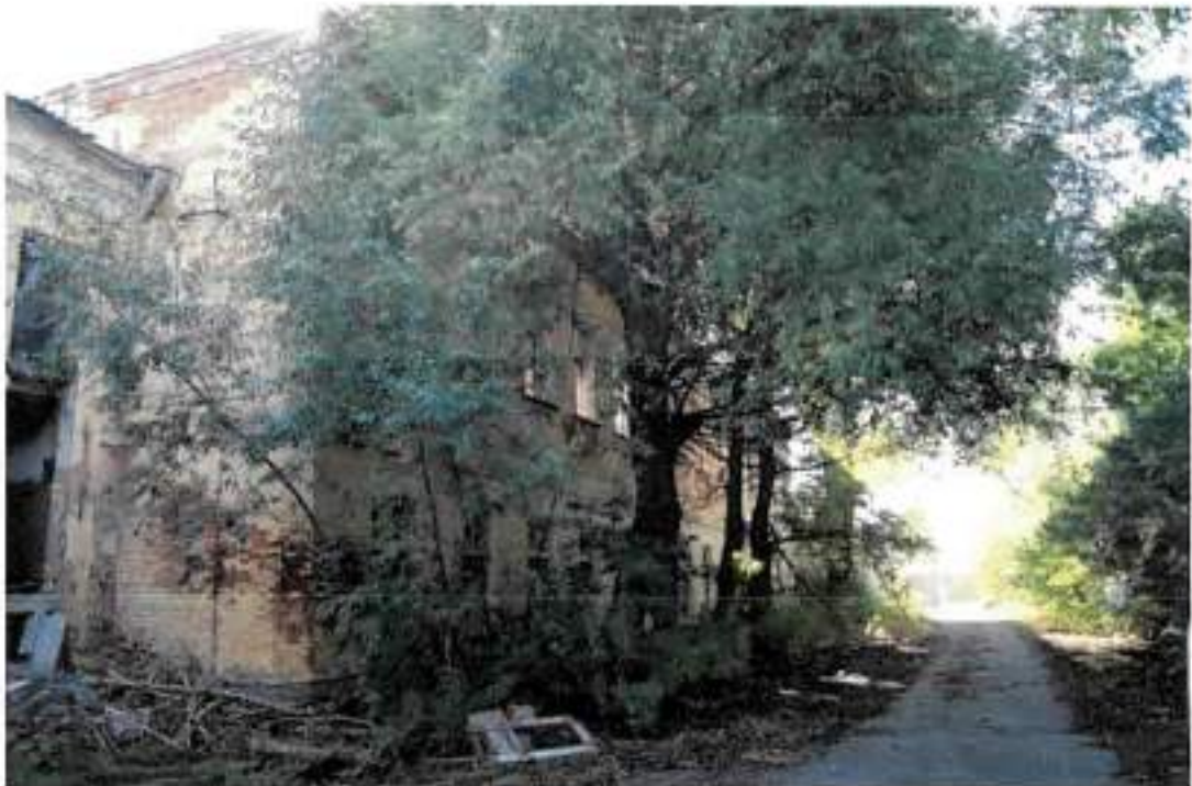
Фото 4. Вид на северо-восточный фасад основной части здания
