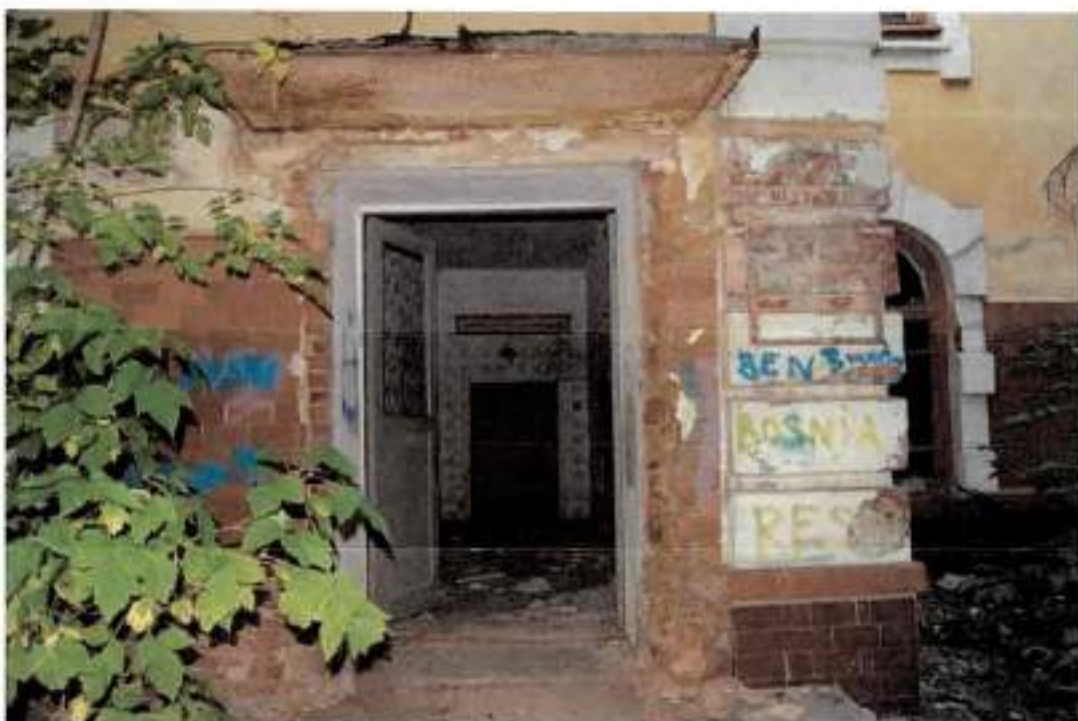
Фото 20. Вид на вход главного фасада здания
