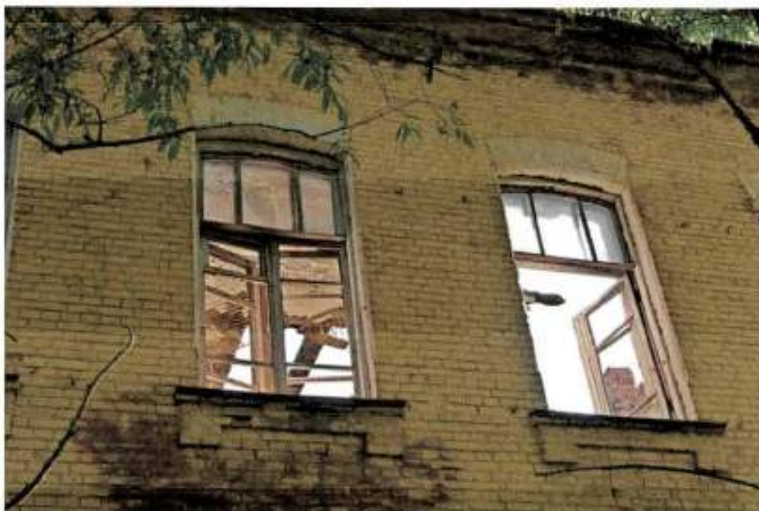
Фото 9. Вид на окна 2-го этажа восточного фасада здания
