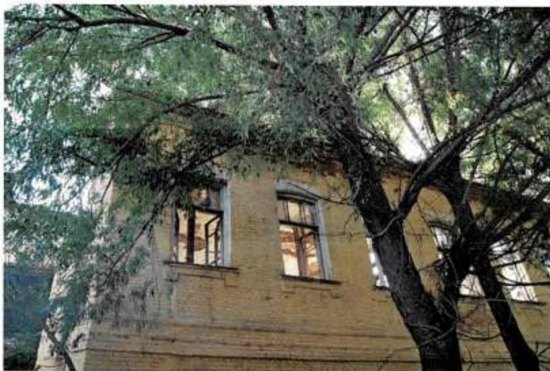
Фото 5. Вид на окна 2-го этажа восточного фасада здания
