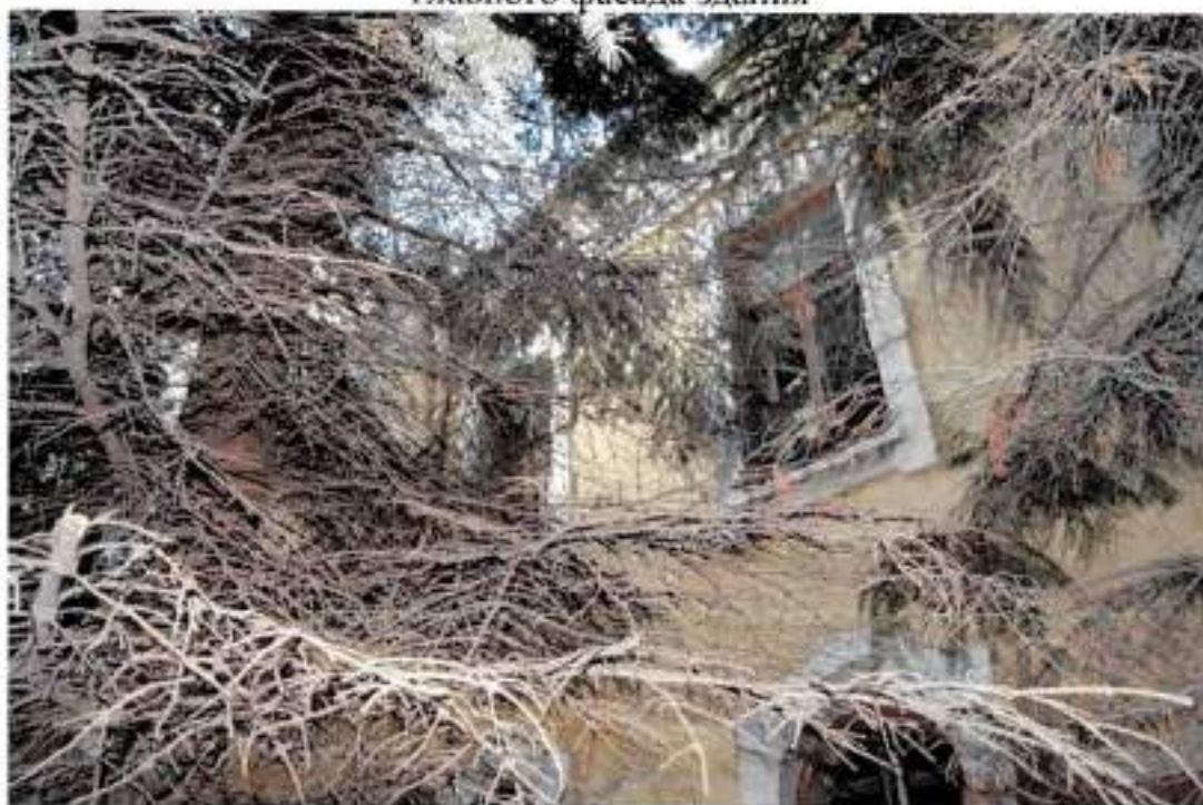
Фото 18. Вид на окна 2-го этажа правого крыла главного фасада здания
