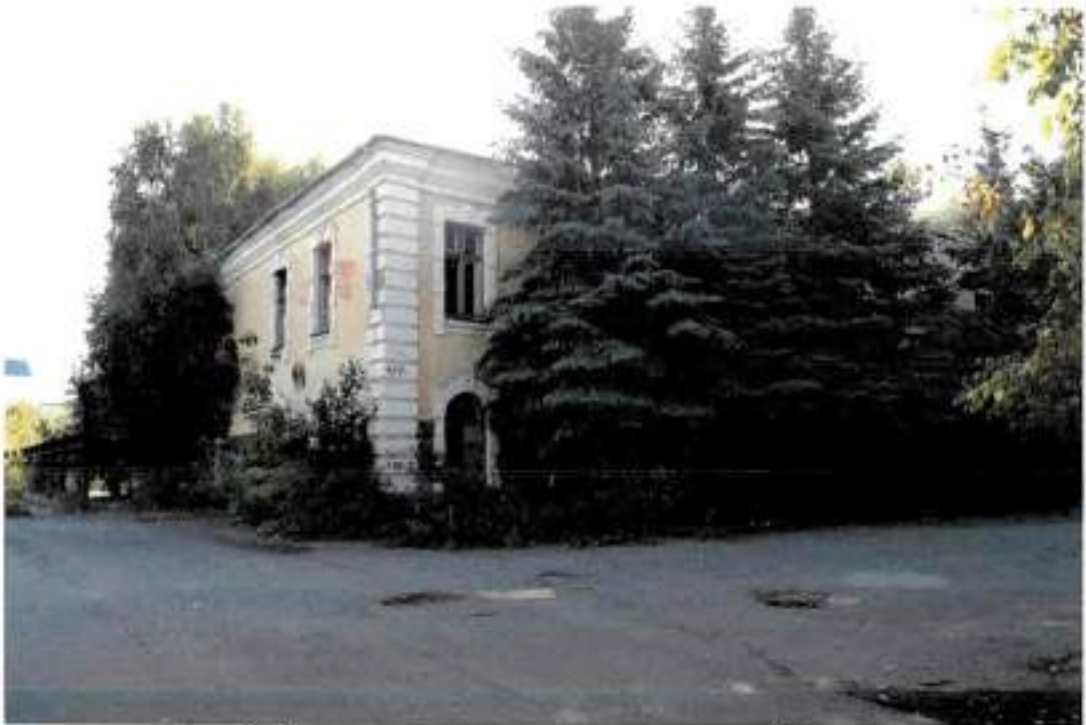
Фото 3. Вид на здание с северо-восточной стороны
