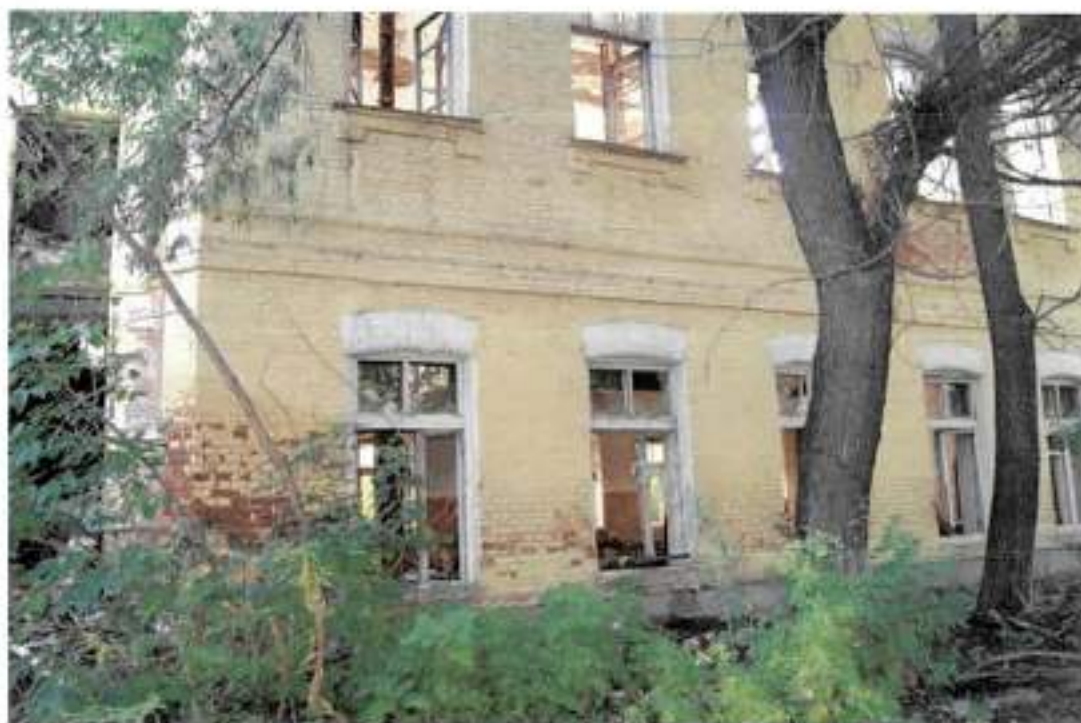
Фото 6. Вид на окна 1-го этажа восточного фасада здания
