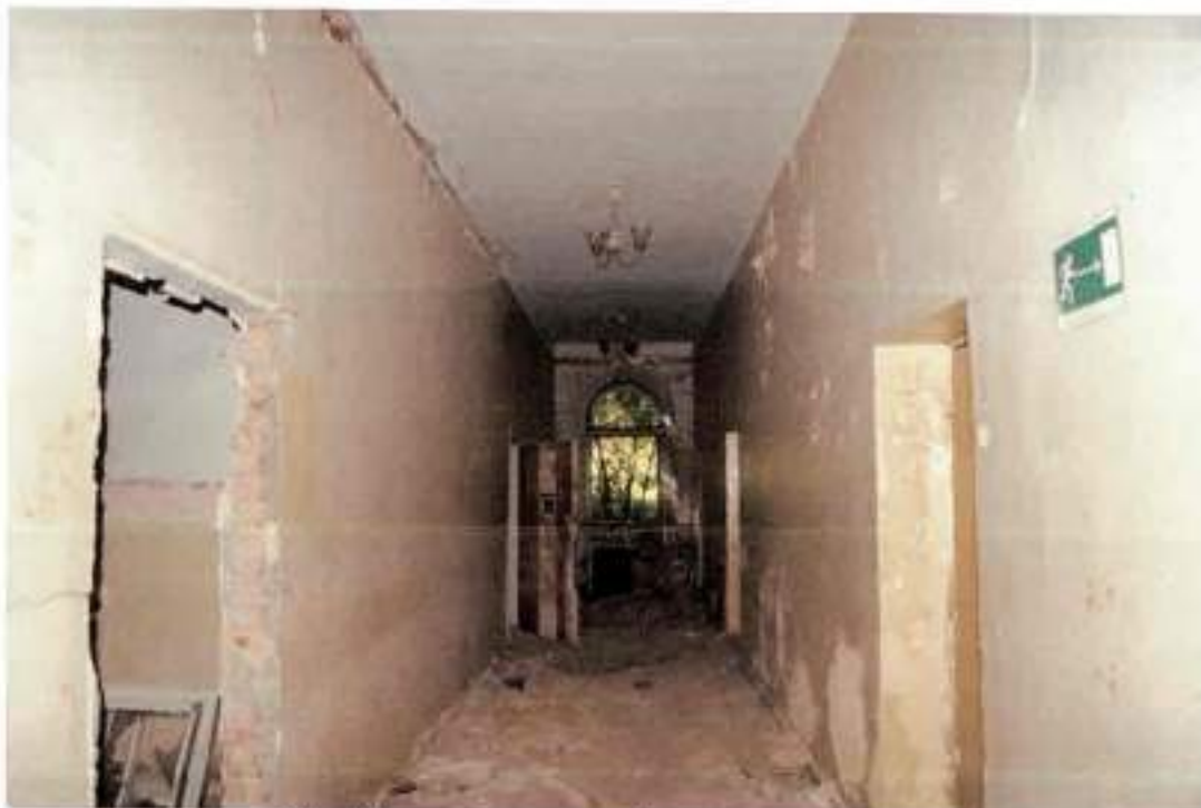
Фото 21. Вид на коридор 1-го этажа здания с юга
