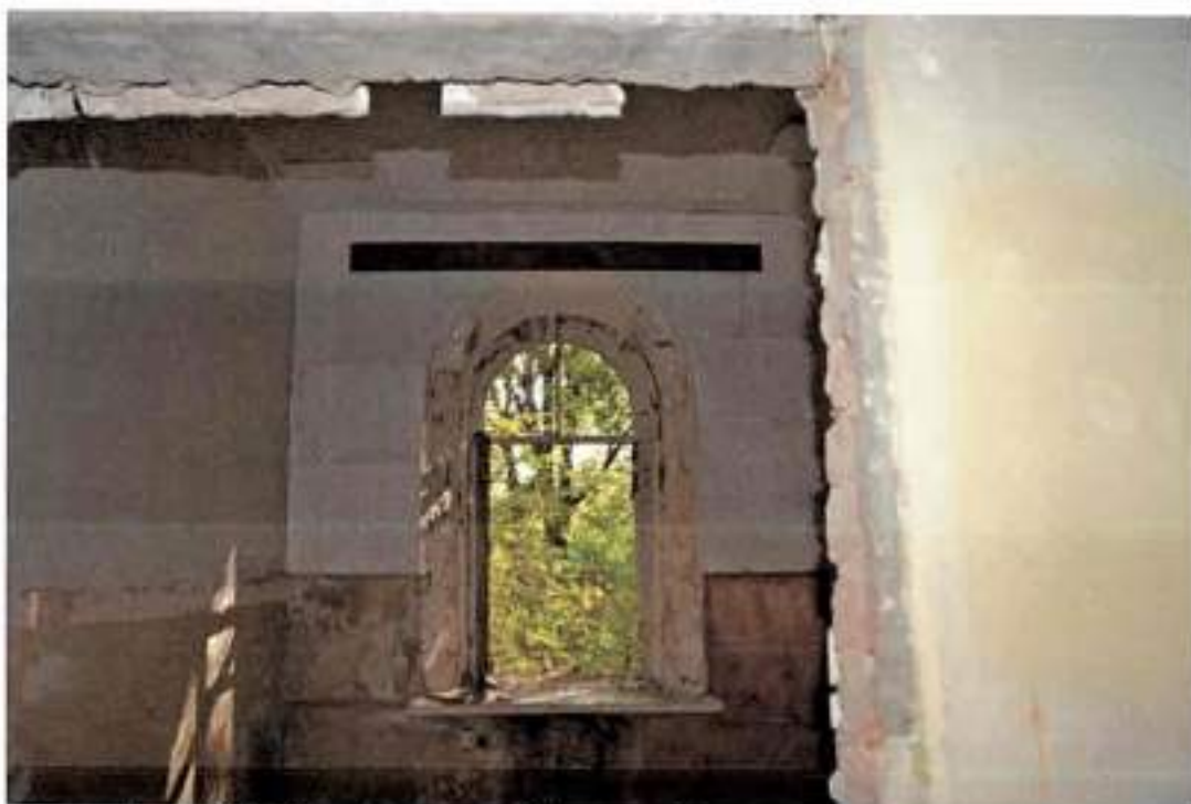
Фото 23. Вид на оконный проем 1-го этажа в помещении с западной стороны здания
