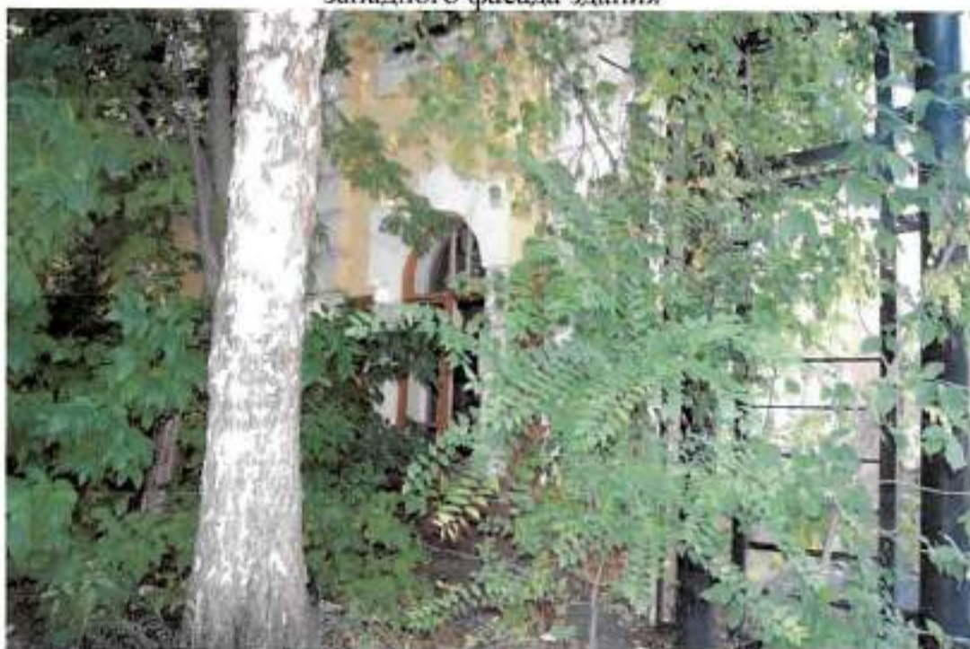
Фото 12. Вид на арочное окно 1-го этажа правого крыла западного фасада здания
