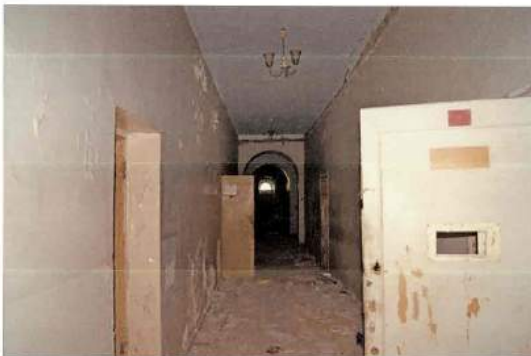
Фото 22. Вид на коридор 1-го этажа здания с юга
