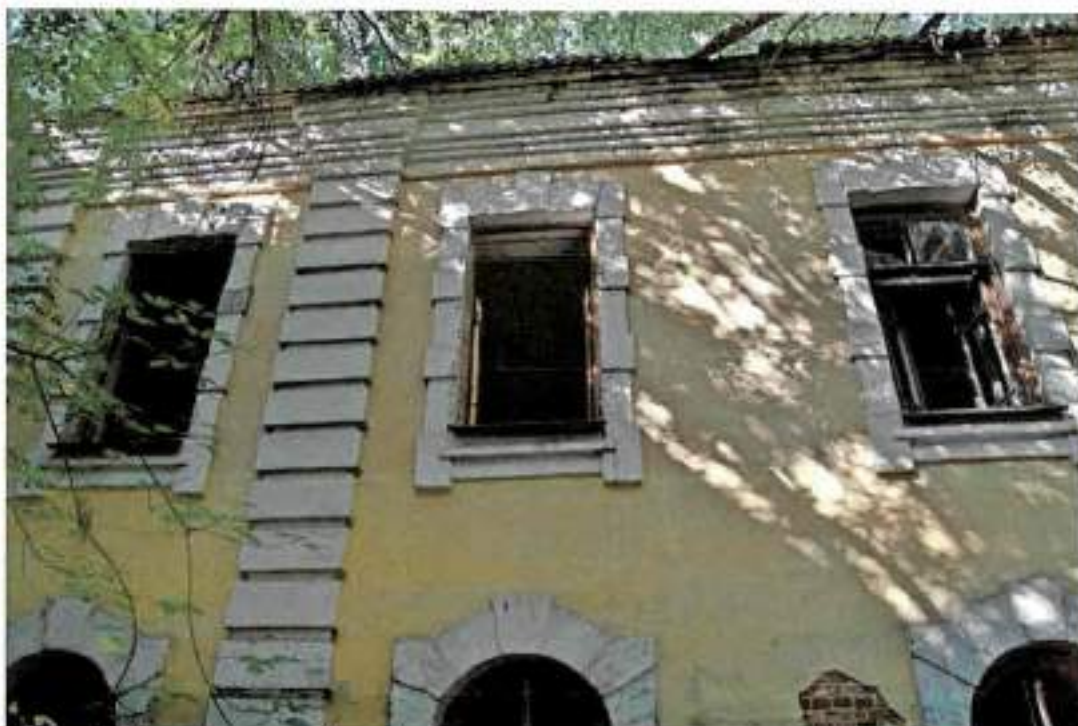
Фото 9. Вид на окна 2-го этажа левого крыла западного фасада здания
