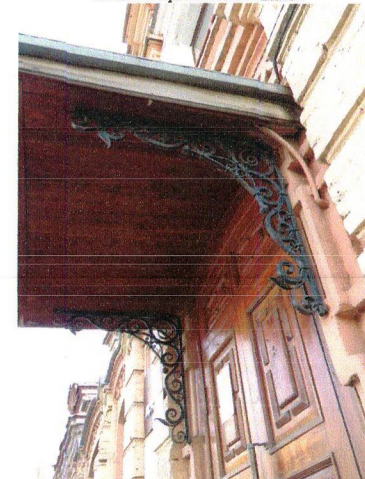
Кованые кронштейны козырька входа со стороны главного фасада
