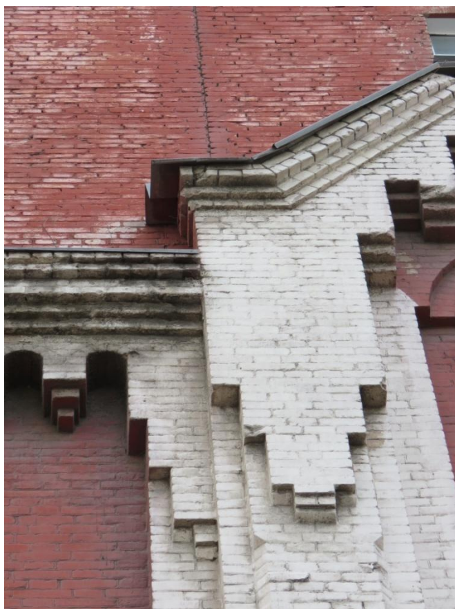
Рис. 13. Фрагмент декора северного фасада
