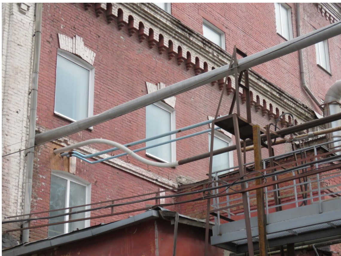
Рис. 18. Фрагмент южного фасада
