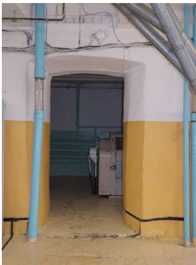
Рис. 21. Исторический проем первого этажа южного фасада
