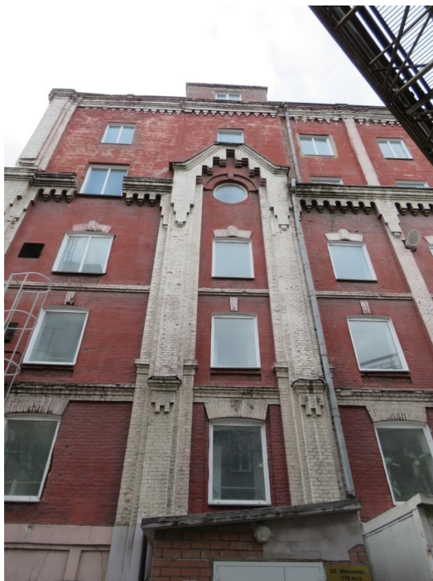
Рис. 10. Фрагмент северного фасада
