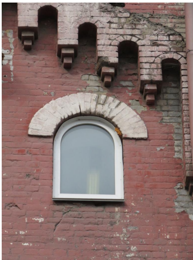
Рис. 6. Фрагмент восточного фасада исторического здания
