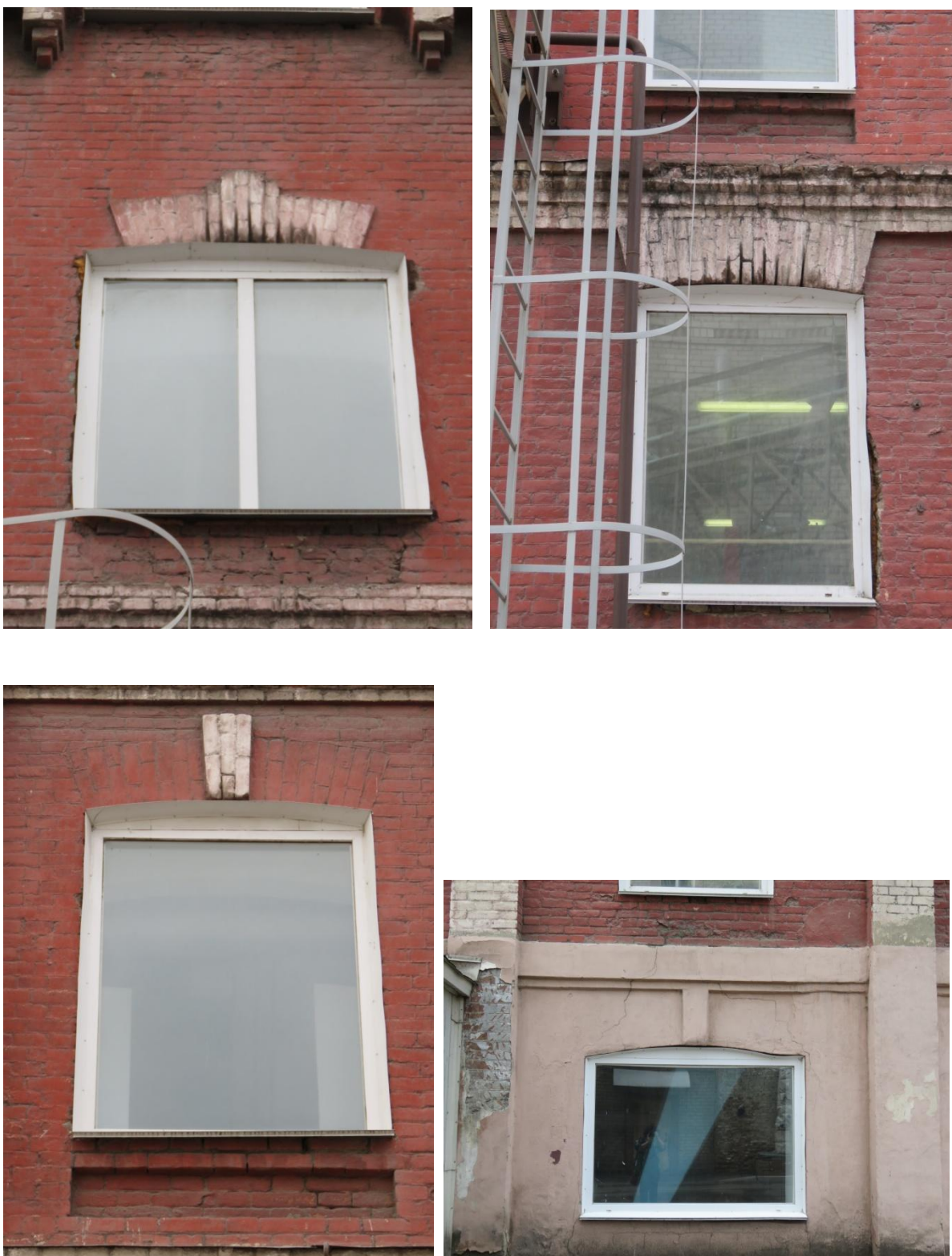
Рис. 11. Оконные проемы северного фасада
