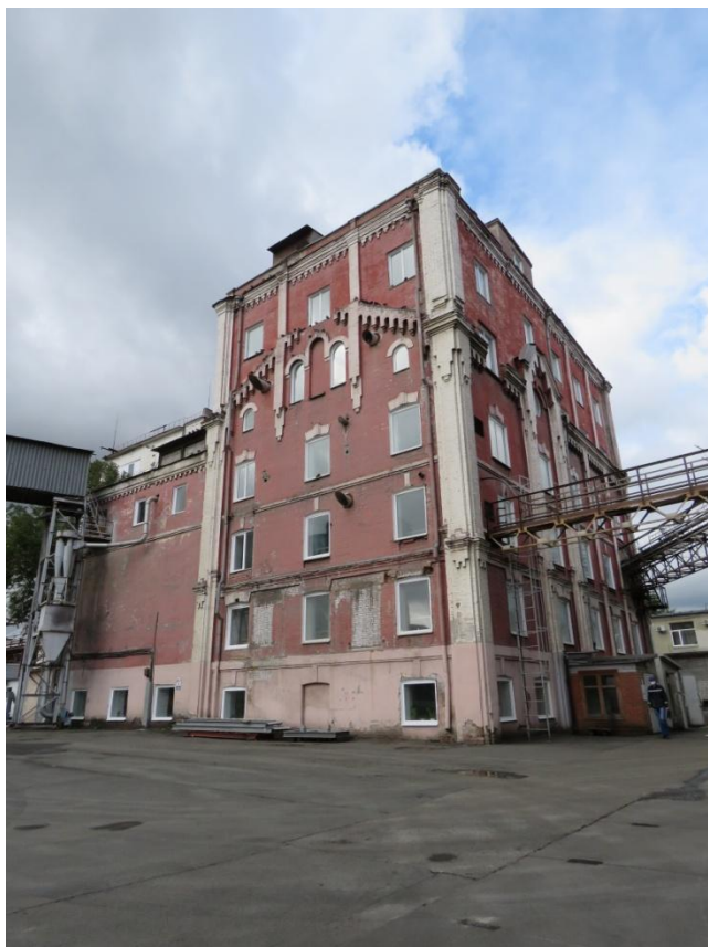
Рис. 7. Восточный и северный фасады. Вид с северо-востока
