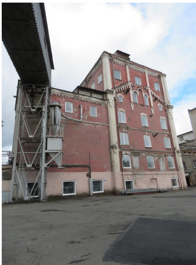
Рис. 2. Восточный фасад. Вид с юго-востока
