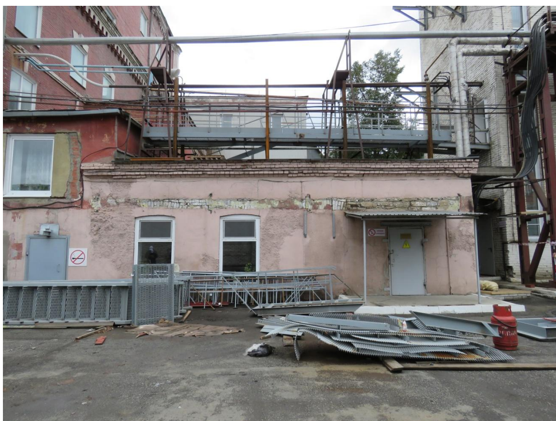
Рис. 19. Здание котельного и машинного отделений. Западный фасад
