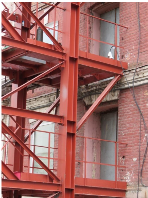
Рис. 16. Исторические дверные проемы выхода на внешнюю лестницу западного фасада
