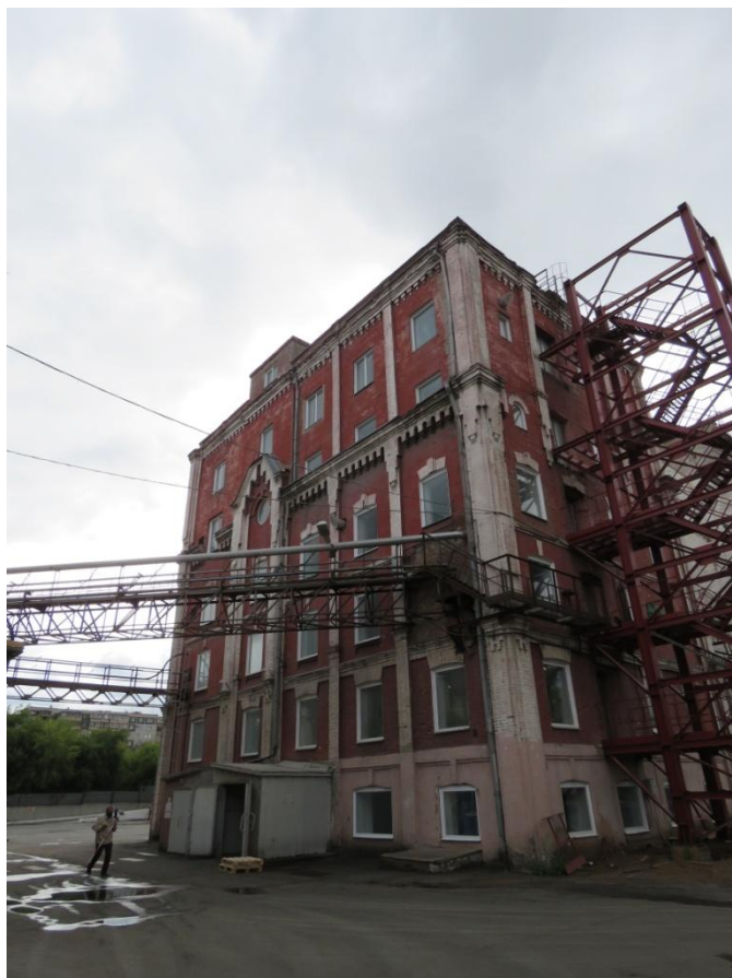
Рис. 9. Северный фасад. Вид с северо-запада
