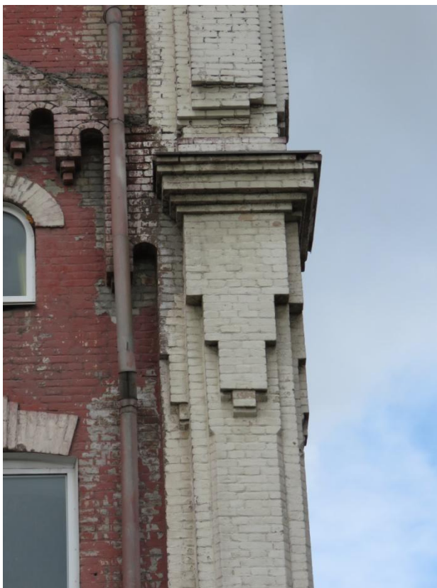
Рис. 5. Фрагмент восточного фасада исторического здания
