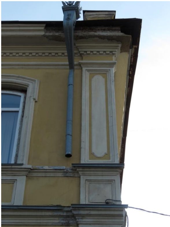
Рис. 19 Дом Злоказовых. Фрагменты декора: а. подкарнизный пояс с сухариками и венчающий карниз; б. пилястра второго этажа; в. фрагмент карниза объема лестничной клетки. Фото 2017 г.
