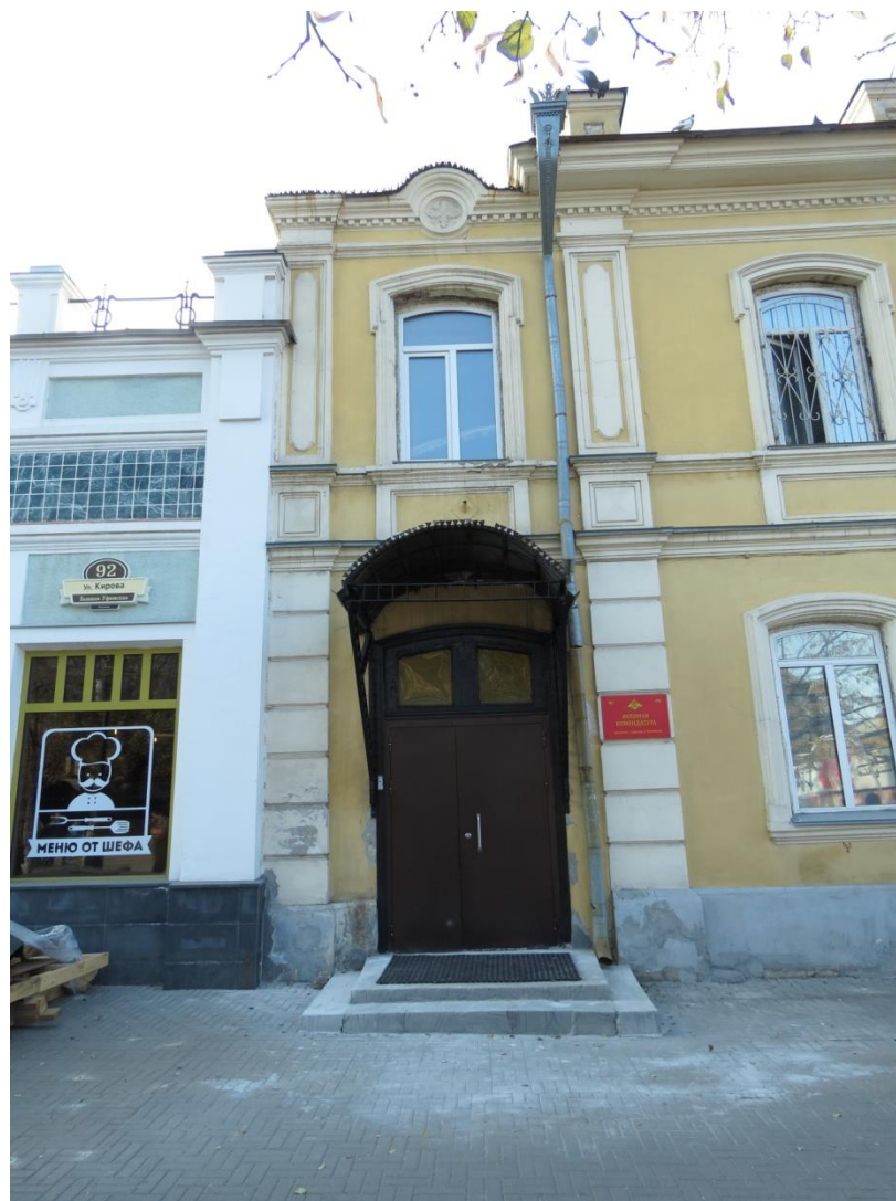
Рис. 18 а. Дом Злоказовых. Левый, южный фланг восточного фасада с объемом лестничной клетки внутри. Фото 2017 г.
