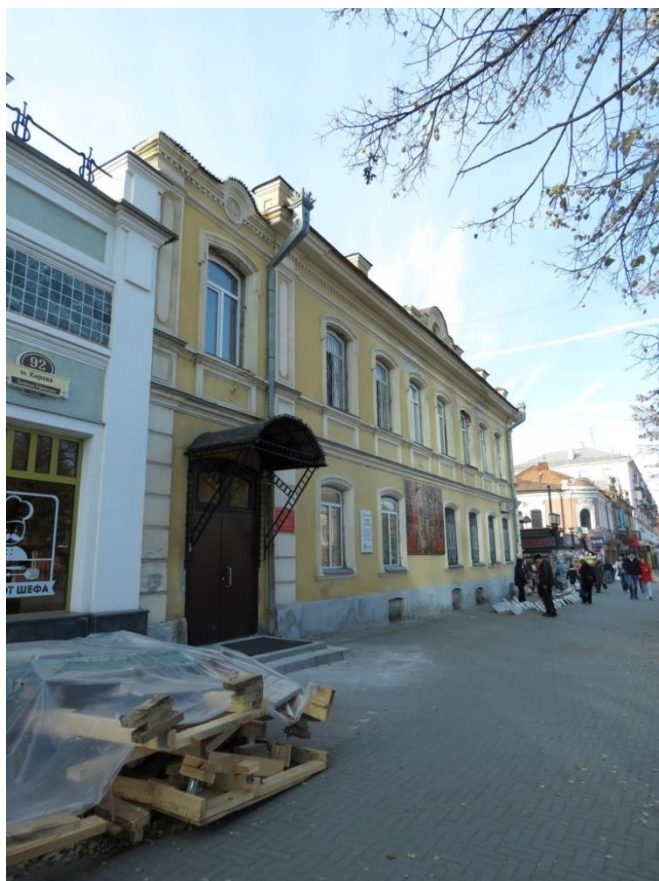
Рис. 16. Дом Злоказовых. Лицевой фасад со стороны ул. Кирова
