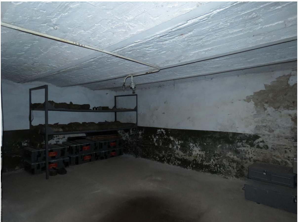
Рис. 27. Дом Злоказовых. Подвал. Кирпичные сводики на металлических балках. Фото 2017 г.
