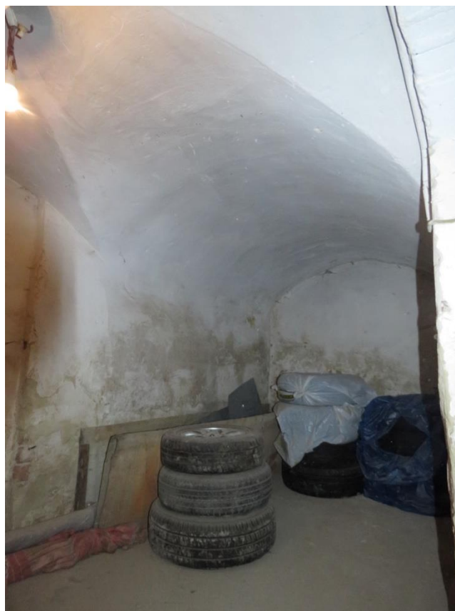
Рис. 28. Дом Злоказовых. Подвал. Коробовый свод с распалубками. Фото 2017 г.
