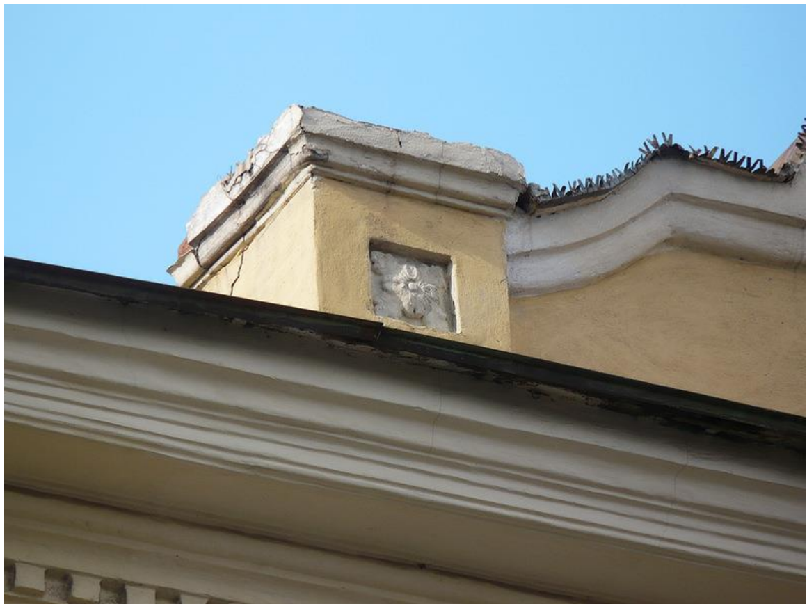
Рис. 24 а,б. Дом Злоказовых. Надкровельные элементы: а. фигурная аттиковая стенка, б. архитектурное решение парапетных столбиков, фланкирующих аттик. Фото 2017 г.
