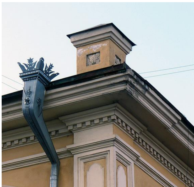
Рис. 23. Дом Злоказовых. Надкровельные элементы: архитектурное решение парпетного столбика. Фото 2017 г.
