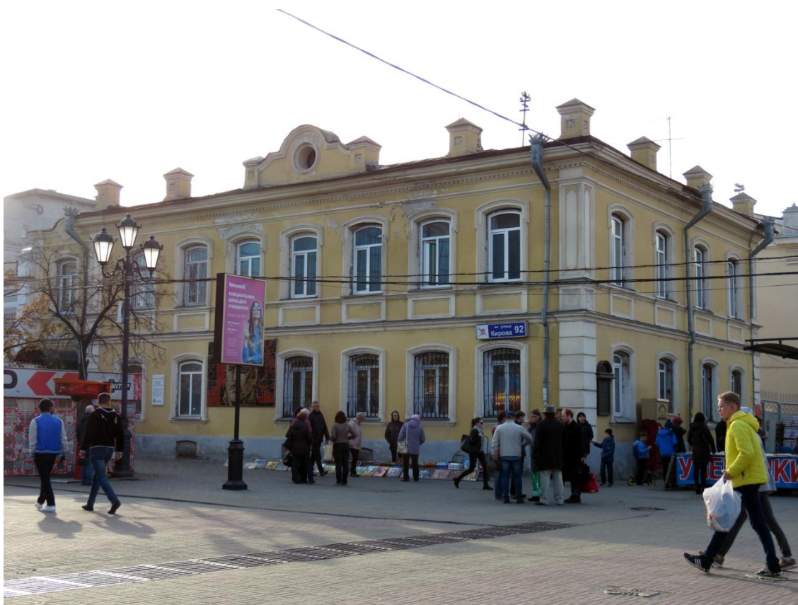
Рис. 22. Дом Злоказовых. Надкровельные элементы: фигурная аттиковая стенка и парпетные столбики. Фото 2017 г.
