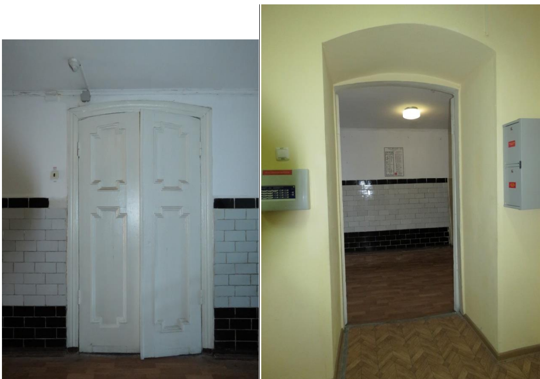
Рис. 26. Дом Злоказовых. а,б,в. Сохранившиеся распашные филенчатые двери (3); г. пример сохранившегося лучкового проема . Фото 2017 г.
