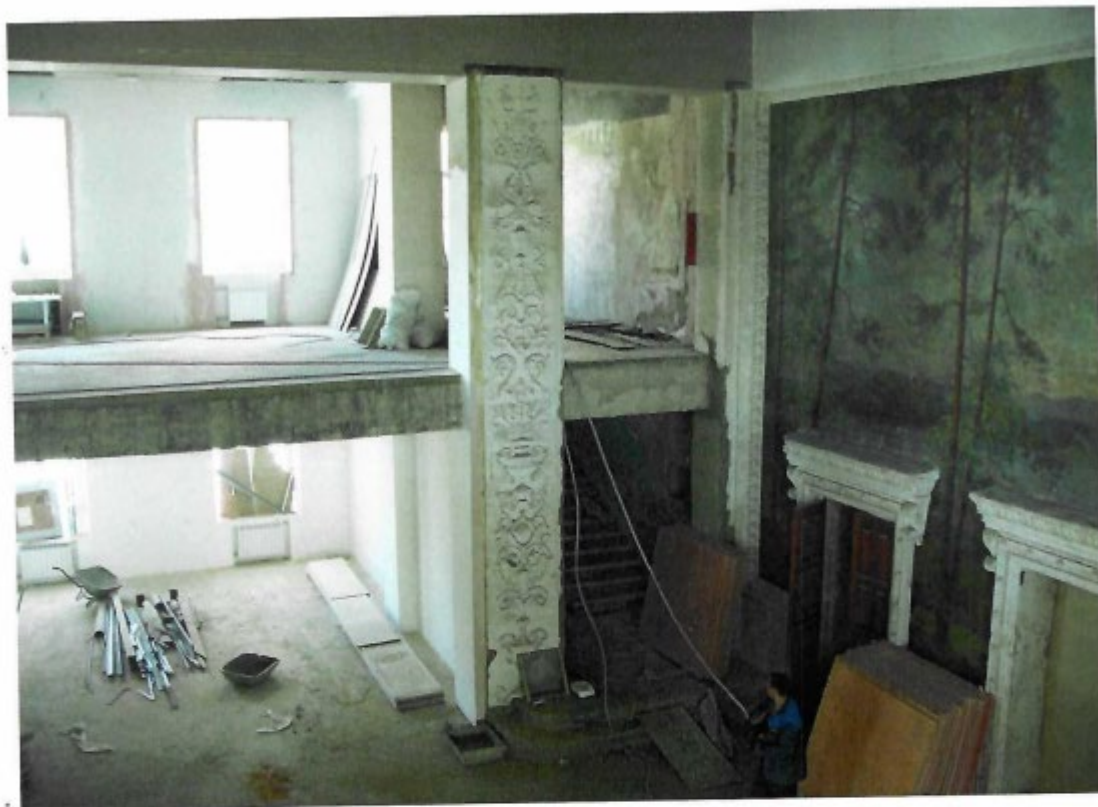
Фото 10. г. Челябинск, ул. Цвиллинга, 81 Выявленный объект культурного наследия «Кинотеатр имени 30-летия ВЛКСМ» Фрагмент интерьера фойе кинотеатра во время проведения ремонтных работ
