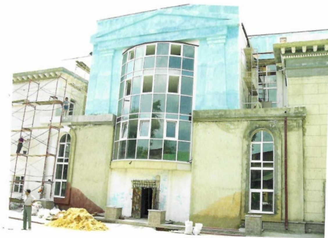
Фото 3. г. Челябинск, ул. Цвиллинга, 81 Выявленный объект культурного наследия «Кинотеатр имени 30-летия ВЛКСМ» Центральная часть восточного фасада здания
