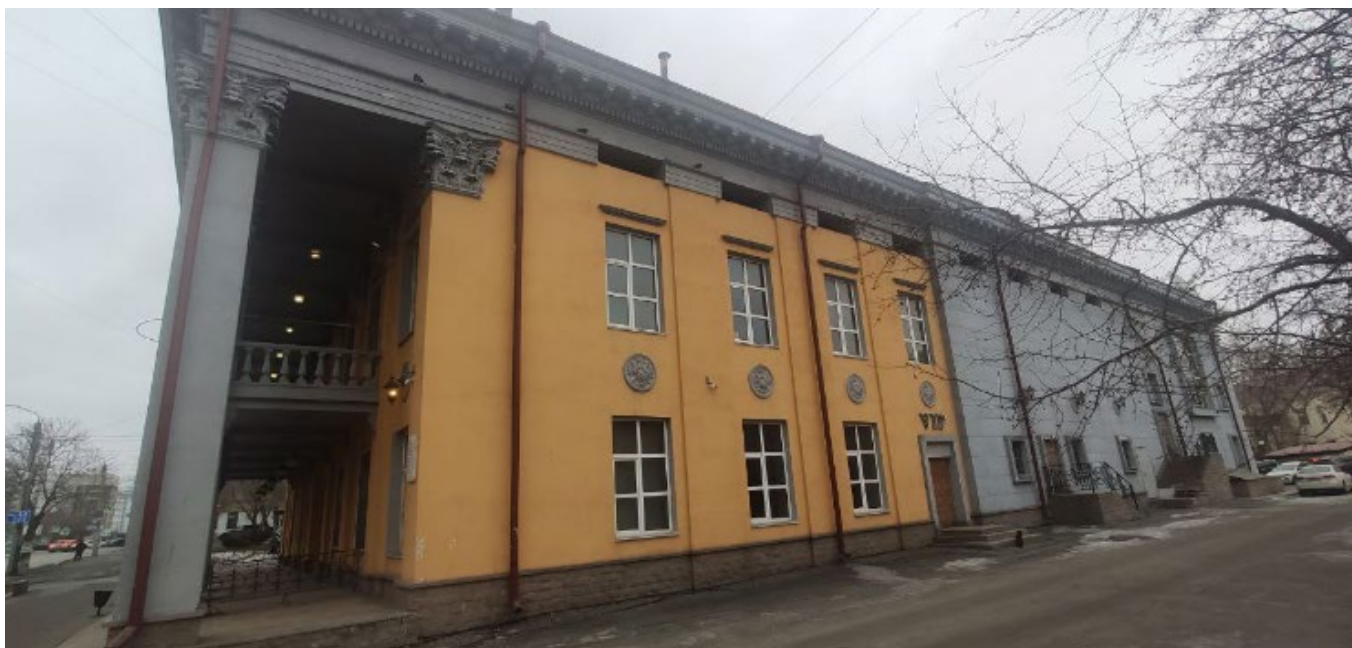
Фото 6. Вид на выявленный объект культурного наследия «Кинотеатр имени 30-летия ВЛКСМ», расположенный по адресу: Челябинская область, г. Челябинск, ул. Цвиллинга, 81.
