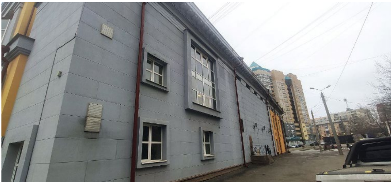
Фото 15. Вид на выявленный объект культурного наследия «Кинотеатр имени 30-летия ВЛКСМ», расположенный по адресу: Челябинская область, г. Челябинск, ул. Цвиллинга, 81.
