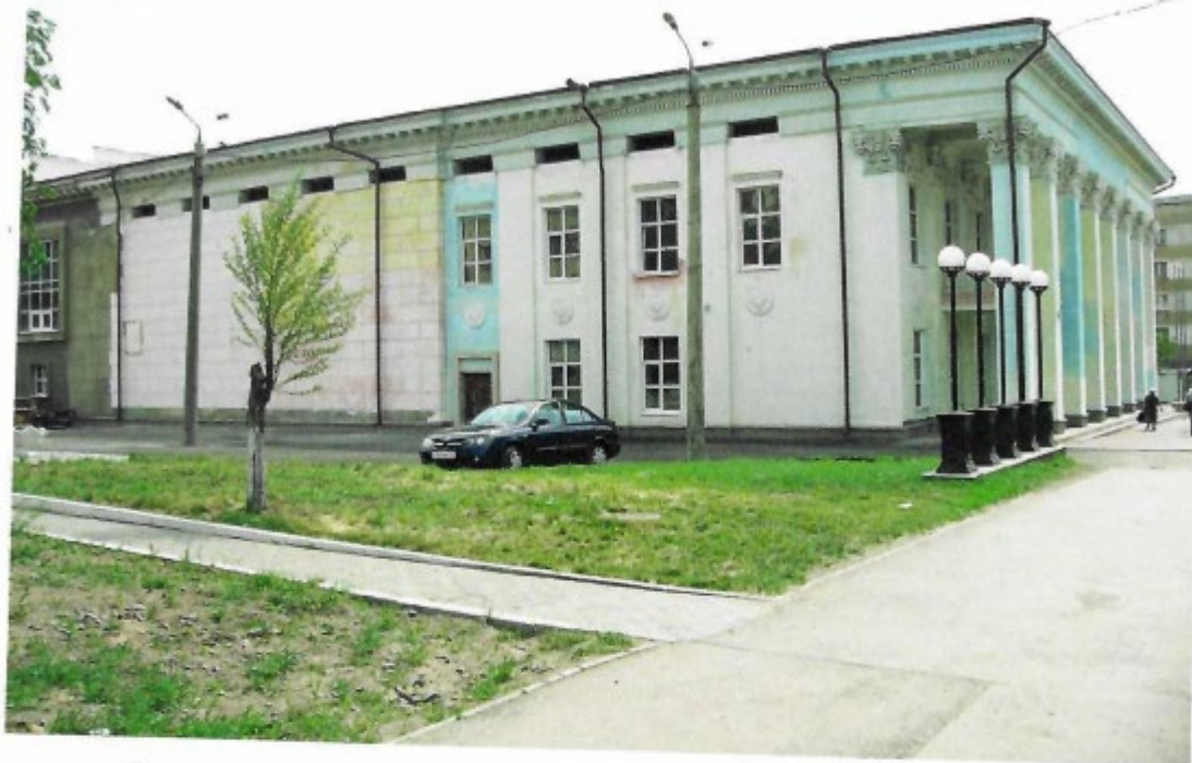
Фото 2. г. Челябинск, ул. Цвиллинга, 81 Выявленный объект культурного наследия «Кинотеатр имени 30-летия ВЛКСМ» Северный фасад здания
