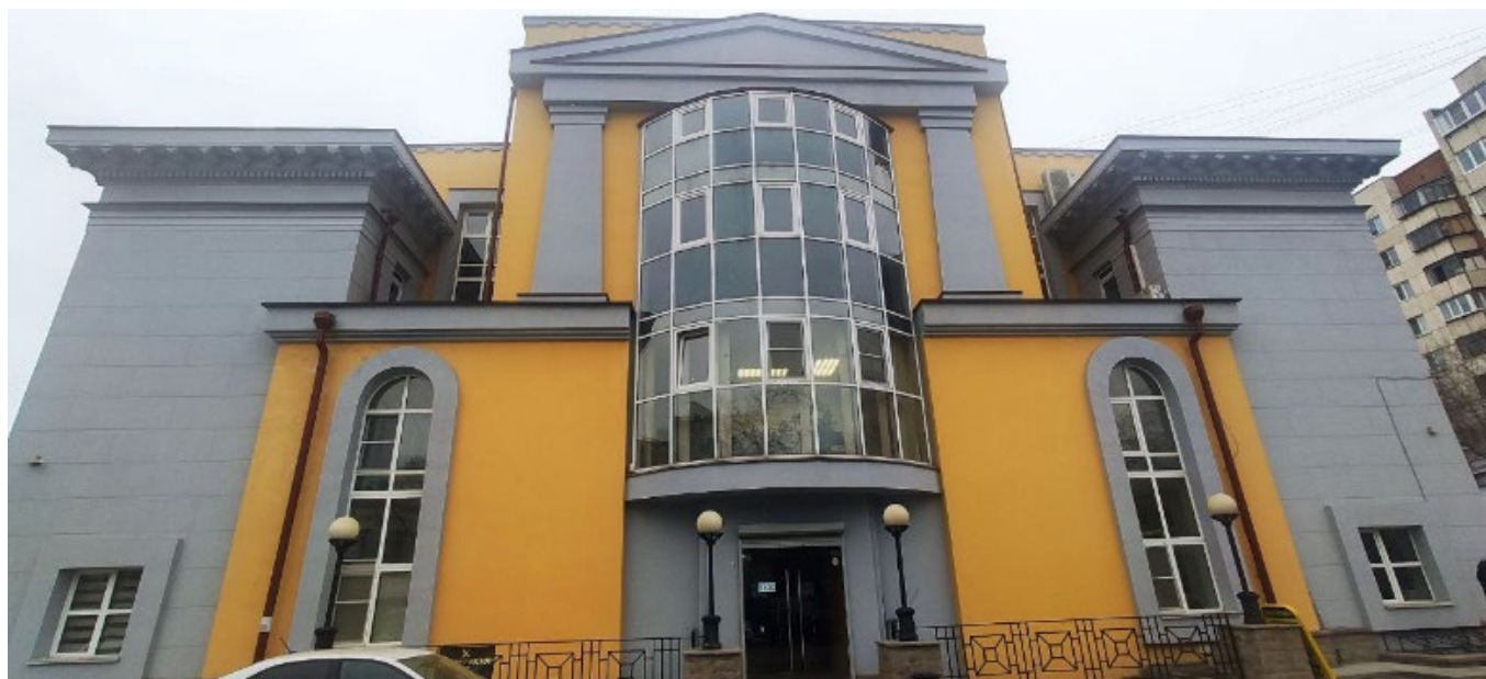
Фото 12. Вид на выявленный объект культурного наследия «Кинотеатр имени 30-летия ВЛКСМ», расположенный по адресу: Челябинская область, г. Челябинск, ул. Цвиллинга, 81.
