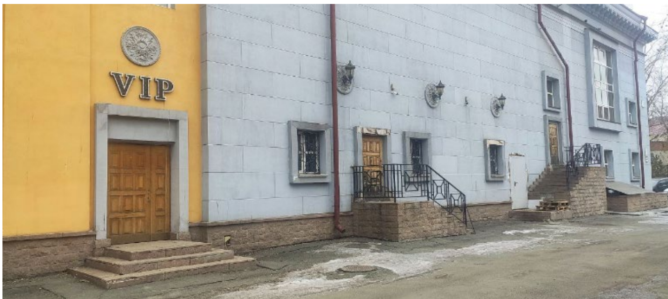
Фото 8. Вид на выявленный объект культурного наследия «Кинотеатр имени 30-летия ВЛКСМ», расположенный по адресу: Челябинская область, г. Челябинск, ул. Цвиллинга, 81.
