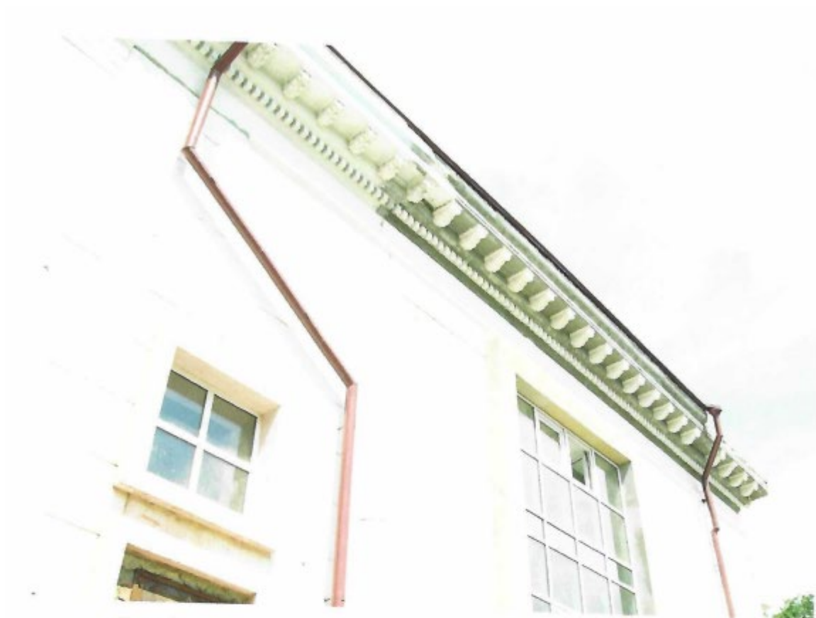
Фото 6. г. Челябинск, ул. Цвиллинга, 81 Выявленный объект культурного наследия «Кинотеатр имени 30-летия ВЛКСМ» Фрагмент декоративного карниза со стороны южный фасад здания
