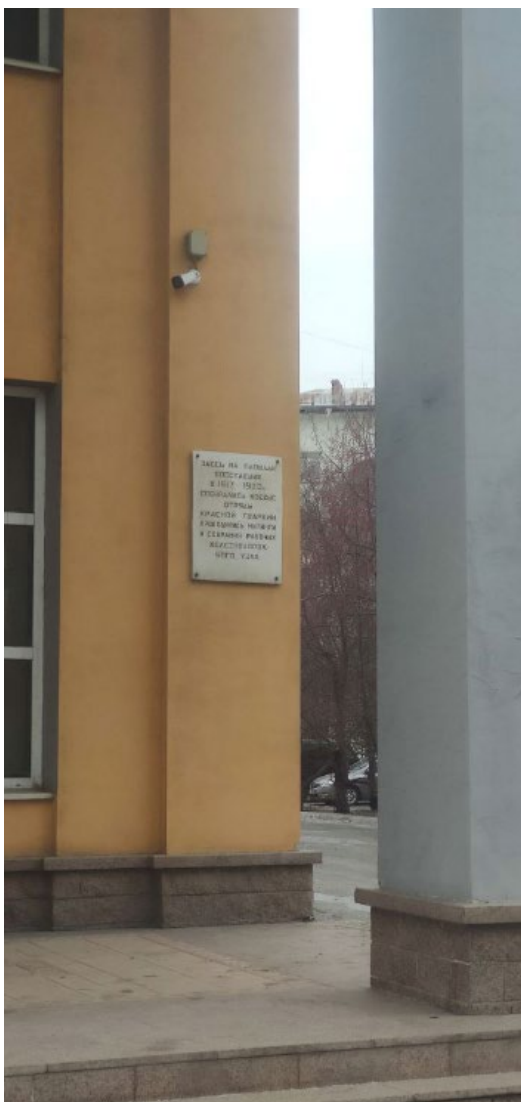
Фото 5. Вид на выявленный объект культурного наследия «Кинотеатр имени 30-летия ВЛКСМ», расположенный по адресу: Челябинская область, г. Челябинск, ул. Цвиллинга, 81.
