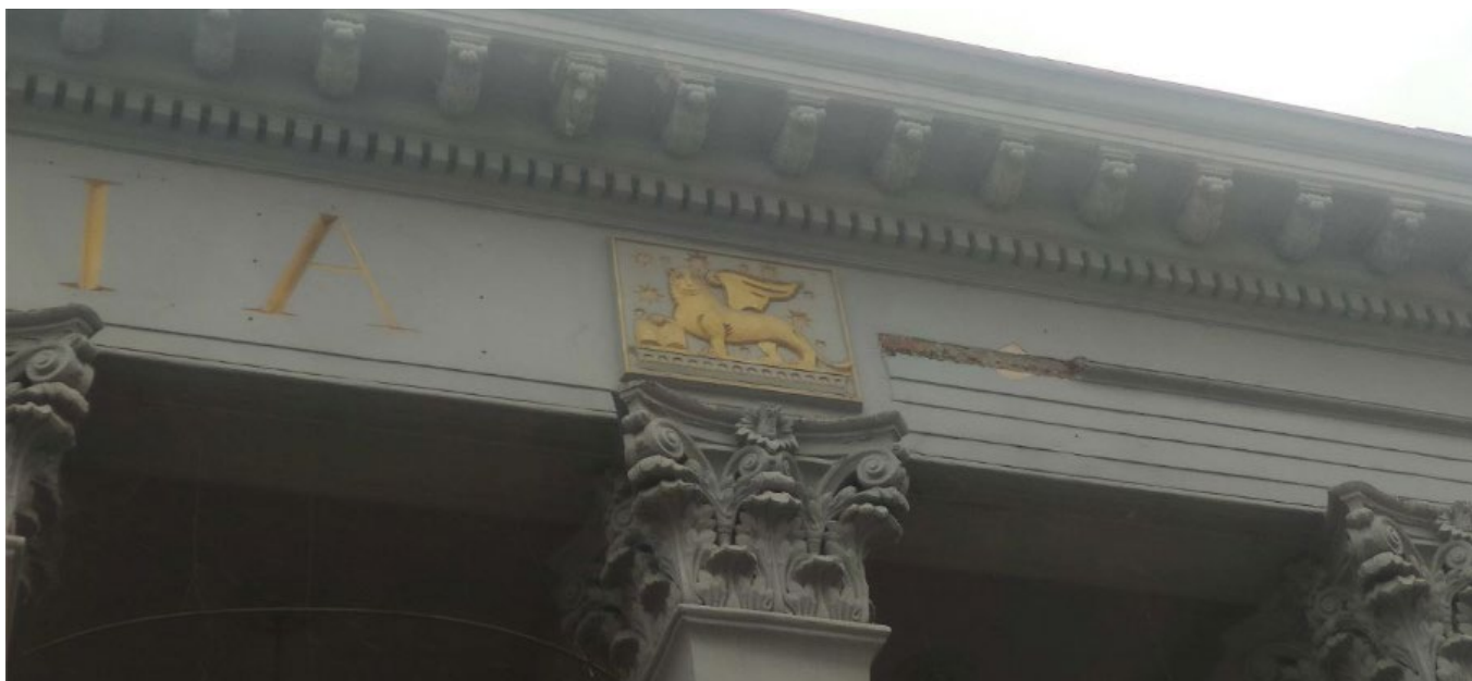
Фото 2. Вид на выявленный объект культурного наследия «Кинотеатр имени 30-летия ВЛКСМ», расположенный по адресу: Челябинская область, г. Челябинск, ул. Цвиллинга, 81.
