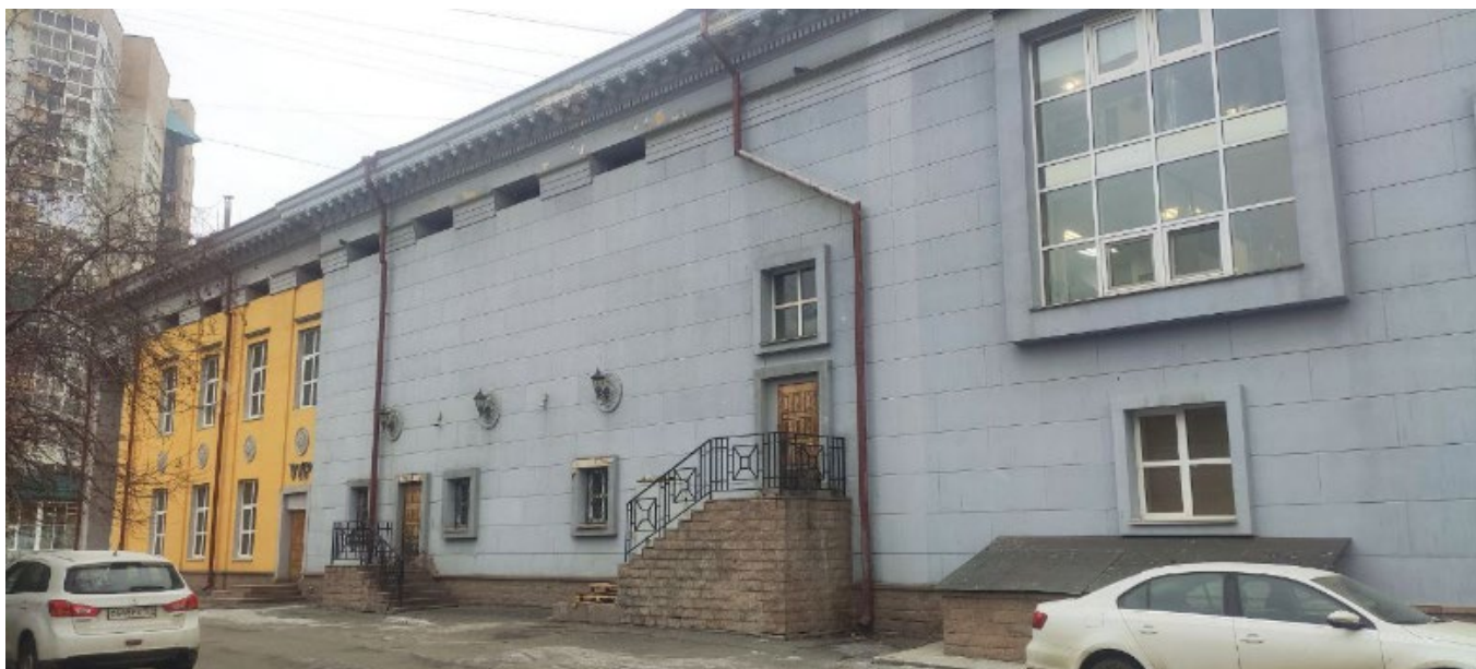
Фото 9. Вид на выявленный объект культурного наследия «Кинотеатр имени 30-летия ВЛКСМ», расположенный по адресу: Челябинская область, г. Челябинск, ул. Цвиллинга, 81.
