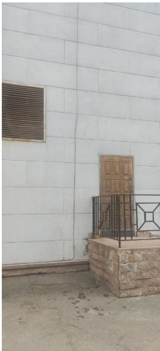
Фото 17. Вид на выявленный объект культурного наследия «Кинотеатр имени 30-летия ВЛКСМ», расположенный по адресу: Челябинская область, г. Челябинск, ул. Цвиллинга, 81.
