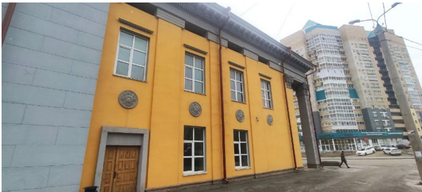
Фото 16. Вид на выявленный объект культурного наследия «Кинотеатр имени 30-летия ВЛКСМ», расположенный по адресу: Челябинская область, г. Челябинск, ул. Цвиллинга, 81.
