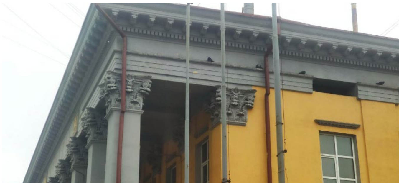
Фото 7. Вид на выявленный объект культурного наследия «Кинотеатр имени 30-летия ВЛКСМ», расположенный по адресу: Челябинская область, г. Челябинск, ул. Цвиллинга, 81.
