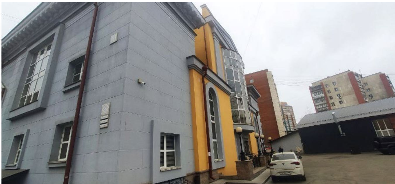
Фото 11. Вид на выявленный объект культурного наследия «Кинотеатр имени 30-летия ВЛКСМ», расположенный по адресу: Челябинская область, г. Челябинск, ул. Цвиллинга, 81.
