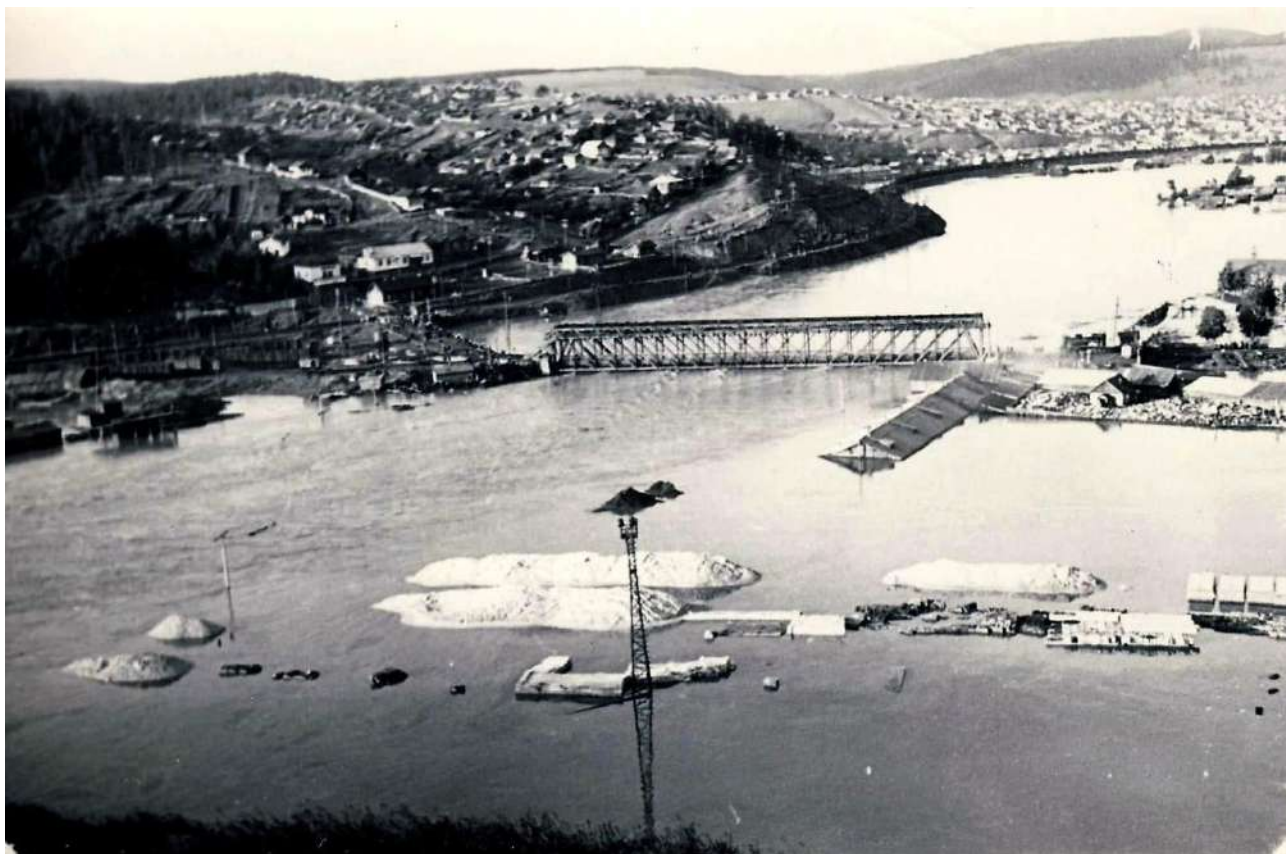
Рис.1. Вид на мост. 1964 г.
