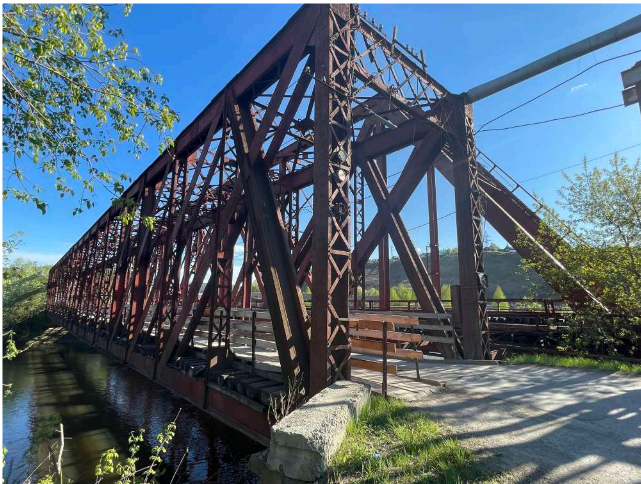
Фото.5. Вид на «Французский мост» расположенный по адресу: Челябинская область, г. Усть-Катав, Речной проезд, сооружение №1.
